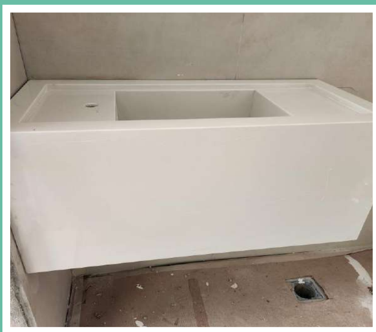
Bancadas internas do 1º pavimento – Abril 2024
