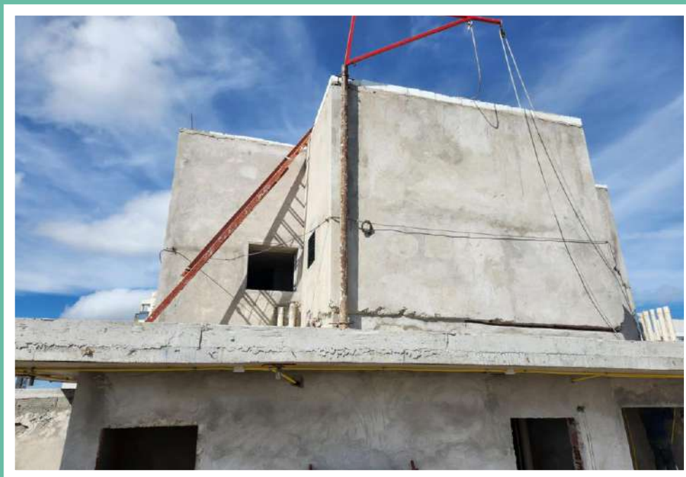
Execução do reboco externo do reservatório superior – Abril 2024
