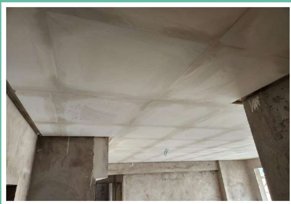
Forro de gesso do 9º pavimento - Fevereiro 2024
