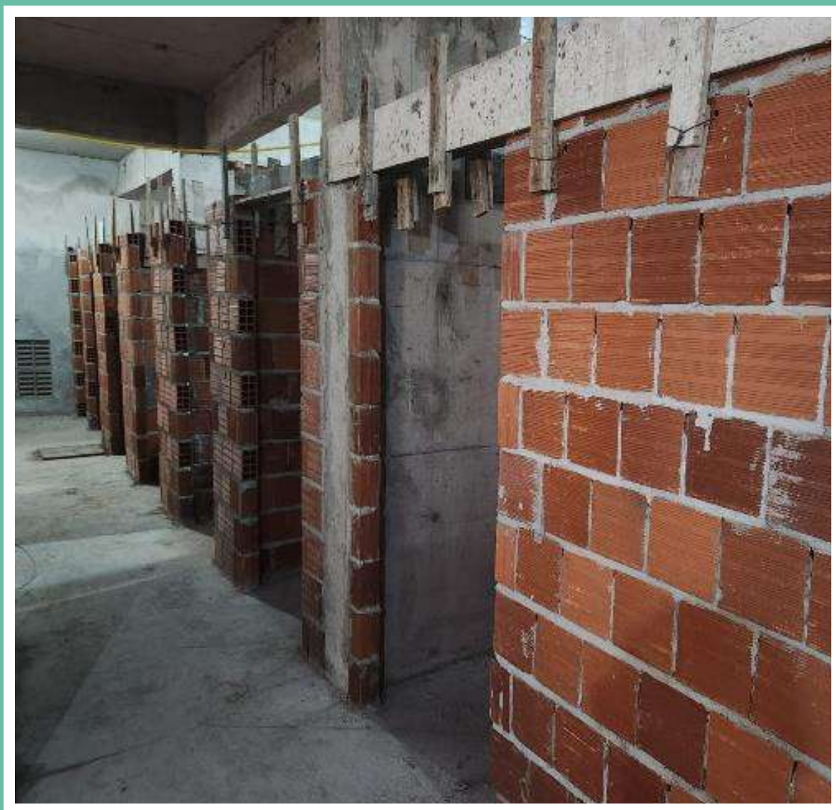
Alvenaria dos bicicletários, depósitos e escaninhos individuais do subsolo - Março 2024
