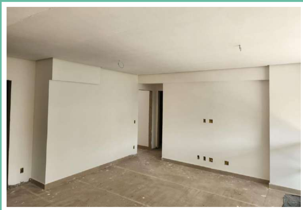
Emassamento do teto e parede do 6º pavimento – Abril 2024
