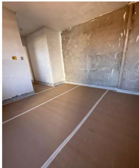
Rejuntamento, limpeza e proteção dos revestimentos cerâmicos do 10º pavimento – Junho 2025
