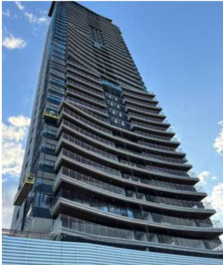
Montagem de estrutura e instalação de quadros da pele de vidro – Julho 2024
