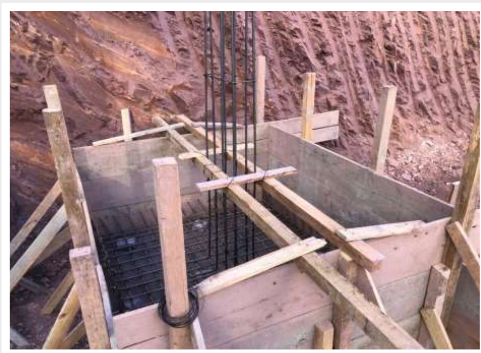
Execução das sapatas de fundação – Junho 2024
