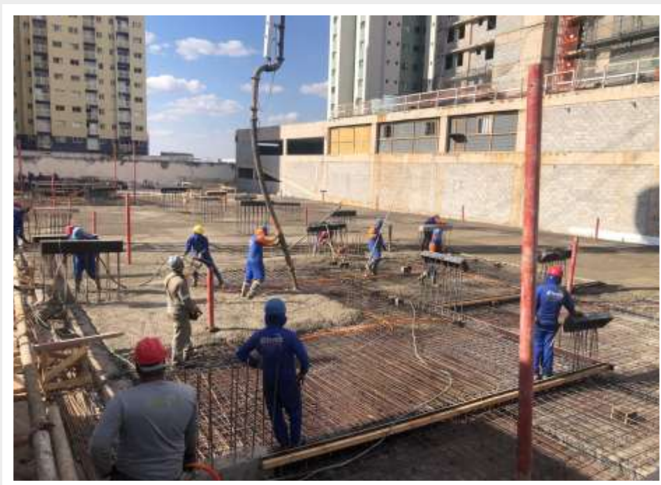
Execução da concretagem da laje do térreo – Julho 2024
