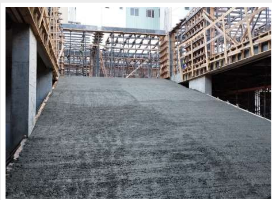
Execução da concretagem da rampa do 1º subsolo – Junho 2024
