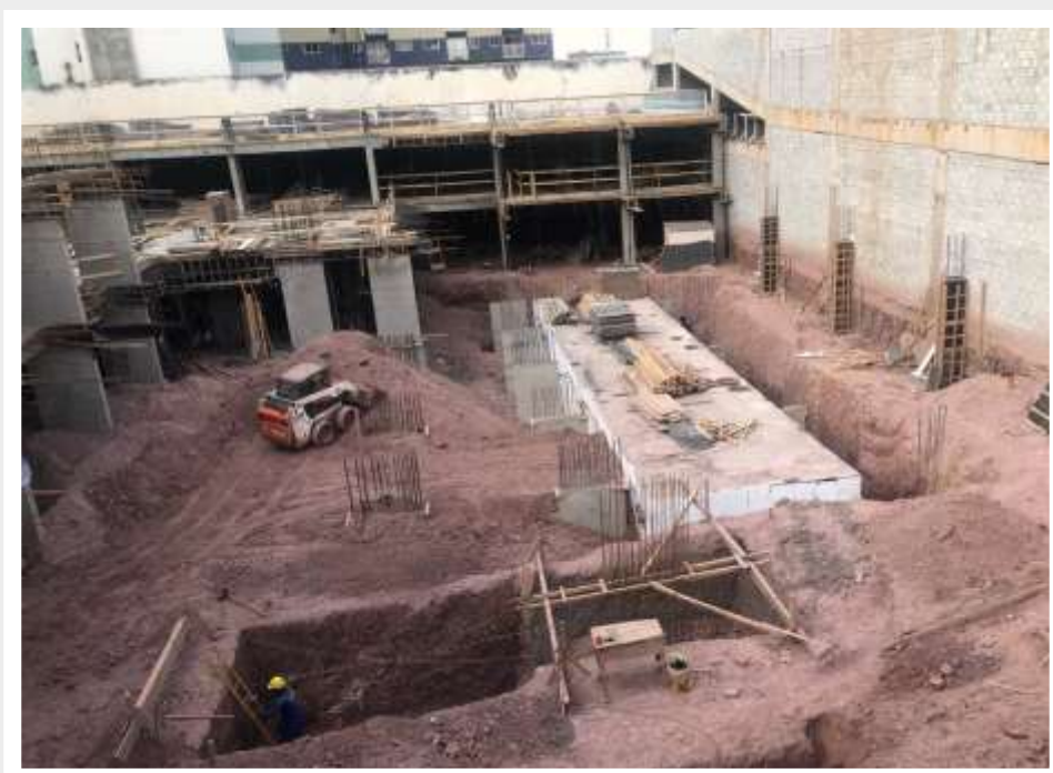
Execução de impermeabilização e reaterro do reservatório de retardo – Junho 2024
