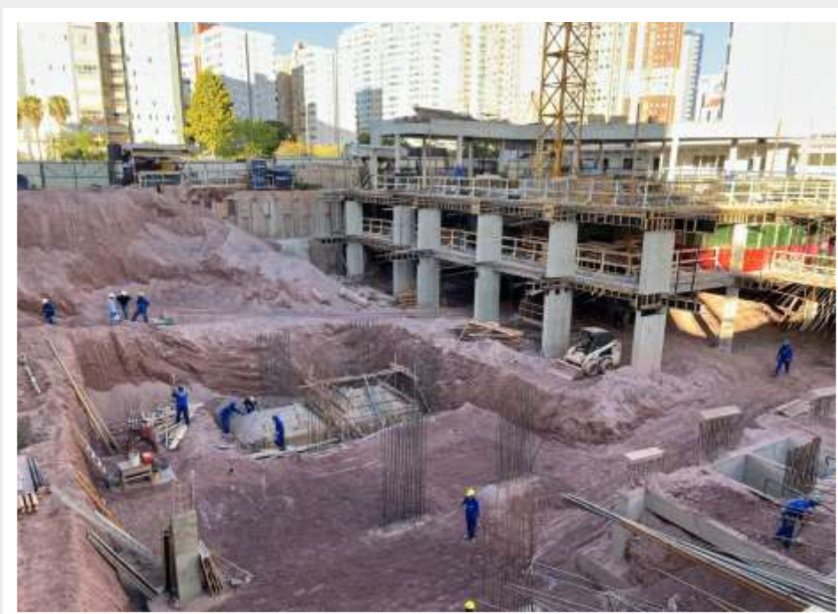
Escavação das sapatas de fundação e reservatório – Maio 2024
