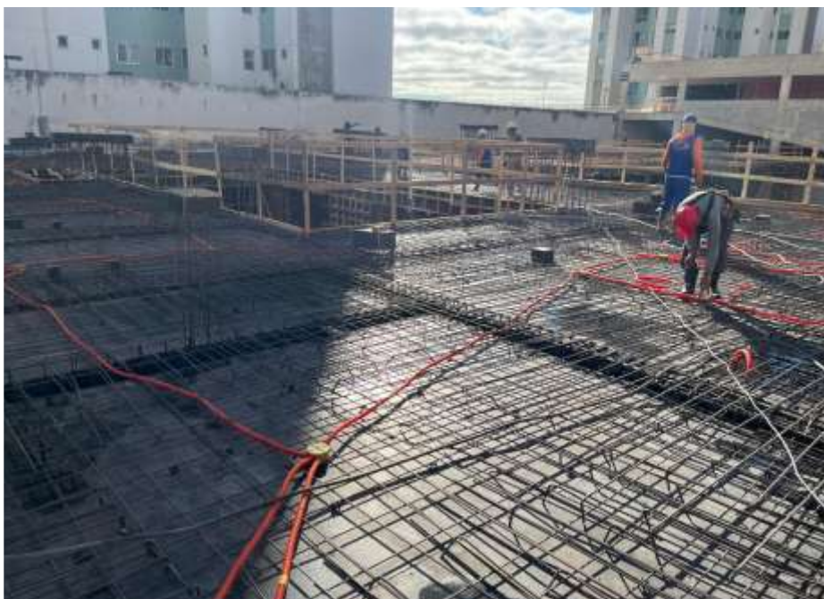
Execução da armação da laje do térreo – Junho 2024
