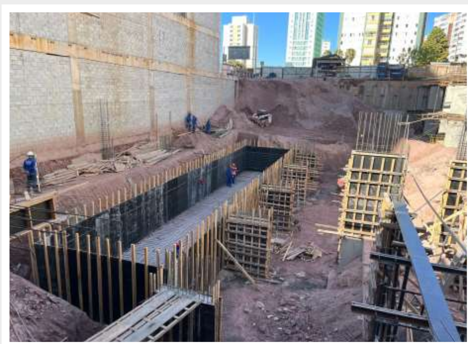
Forma e armação do reservatório de retardo – Junho 2024
