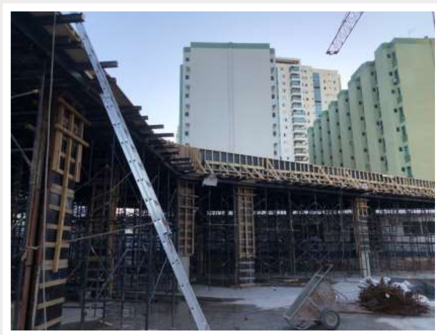
Execução da estrutura das lojas 1, 2 e 3 – Maio 2024
