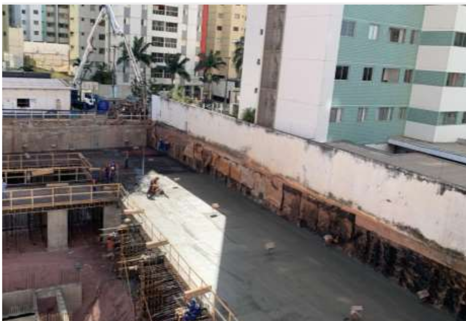
Execução da concretagem da laje do 1º Subsolo – Maio 2024
