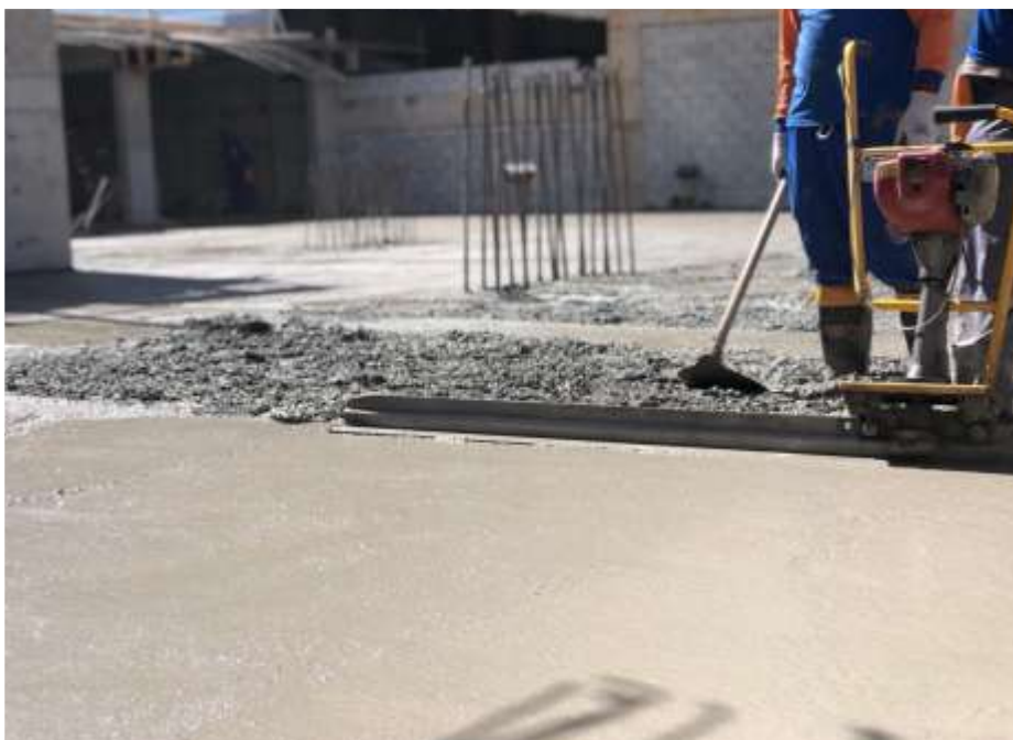
Execução de concretagem da laje do 1º subsolo – Junho 2024
