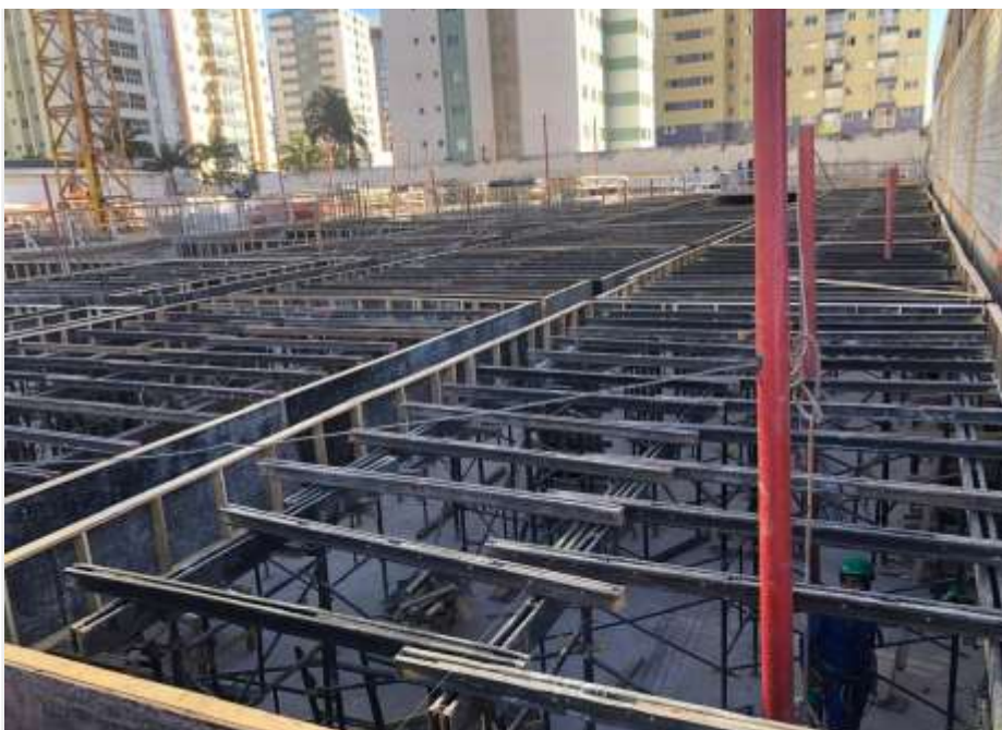
Execução da montagem do escoramento e forma da laje do térreo – Julho 2024
