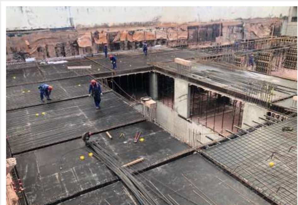
Execução da forma da laje do 1º subsolo – Maio 2024
