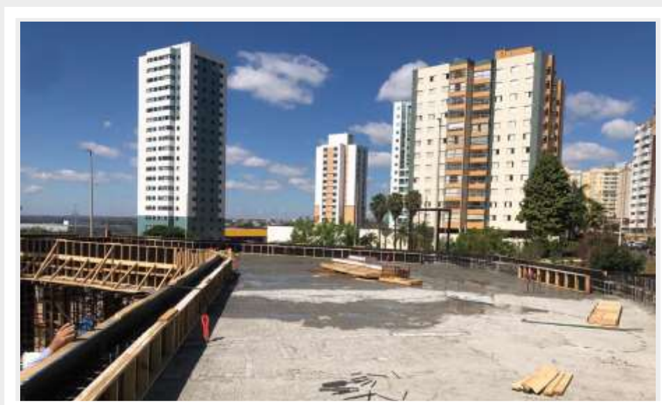
Execução da estrutura das lojas 1, 2 e 3 – Maio 2024
