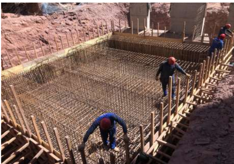
Execução das sapatas de fundação – Maio 2024
