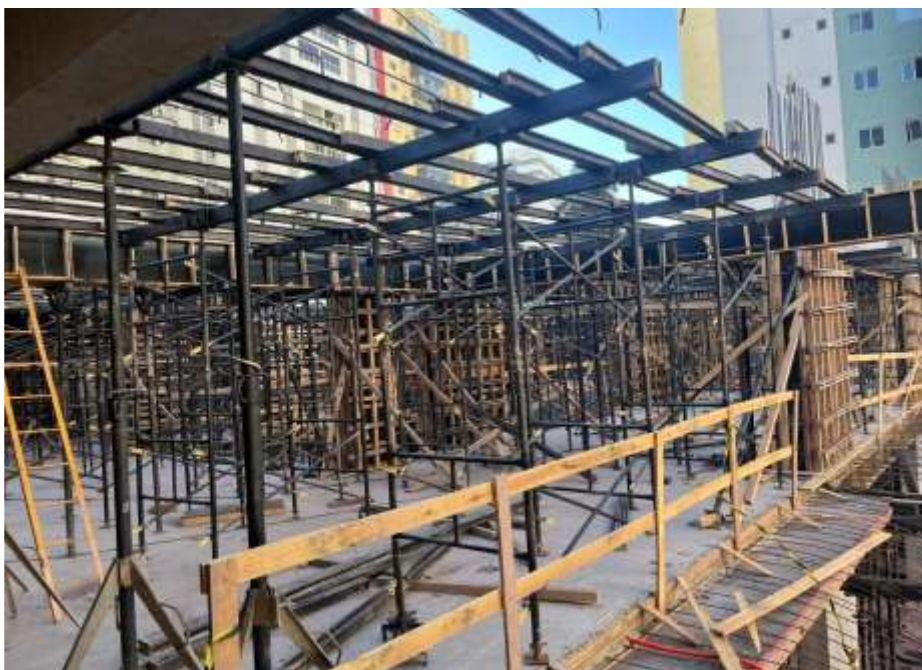
Execução de montagem do escoramento da laje do térreo – Junho 2024
