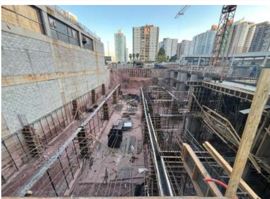
Execução da montagem do escoramento e forma da laje do 1º Subsolo – Julho 2024
