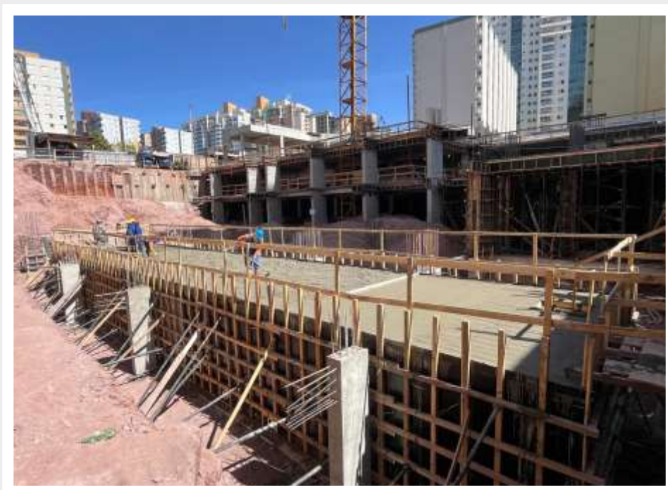
Execução da concretagem do reservatório de retardo – Junho 2024
