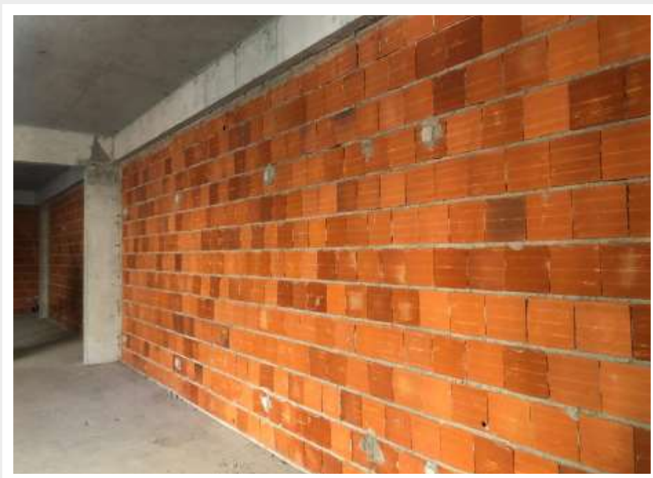
Execução de alvenaria do 1º subsolo – Julho 2024
