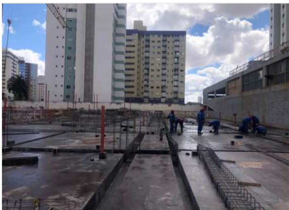
Execução do assoalho e armação da laje do térreo – Julho 2024
