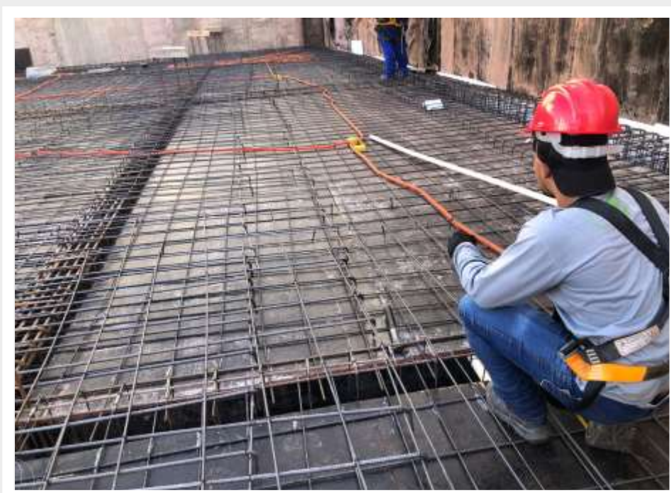
Execução das instalações elétricas/sistemas da laje do 1º subsolo – Maio 2024
