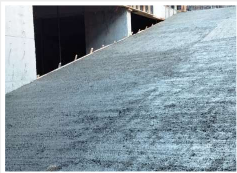
Execução da concretagem da rampa do térreo – Junho 2024
