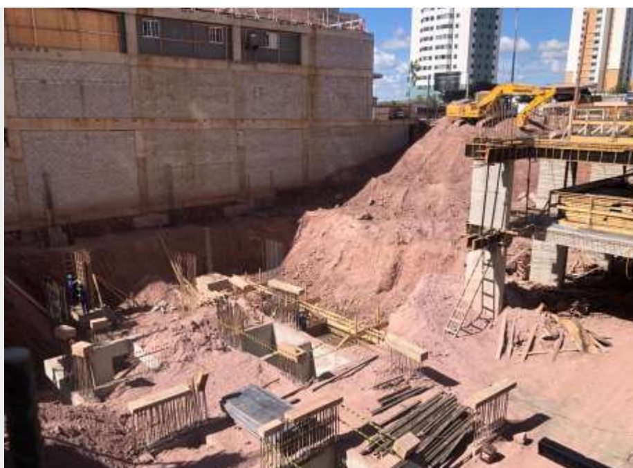
Escavação do terreno – Junho 2024
