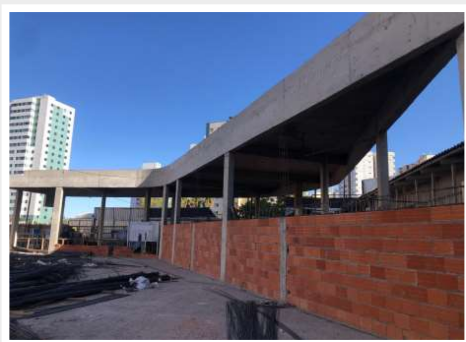
Execução da alvenaria para fechamento das lojas – Julho 2024
