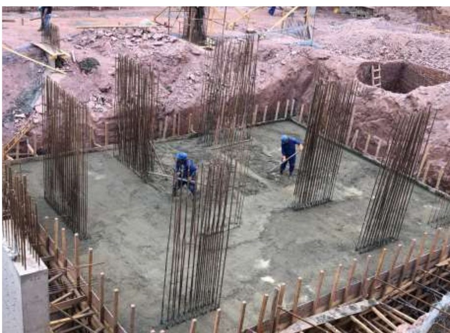
Execução das sapatas de fundação – Maio 2024
