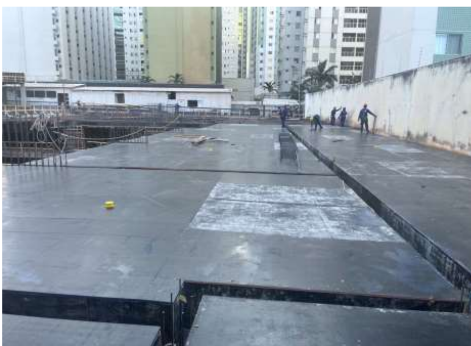
Execução do assoalho da laje do térreo – Junho 2024
