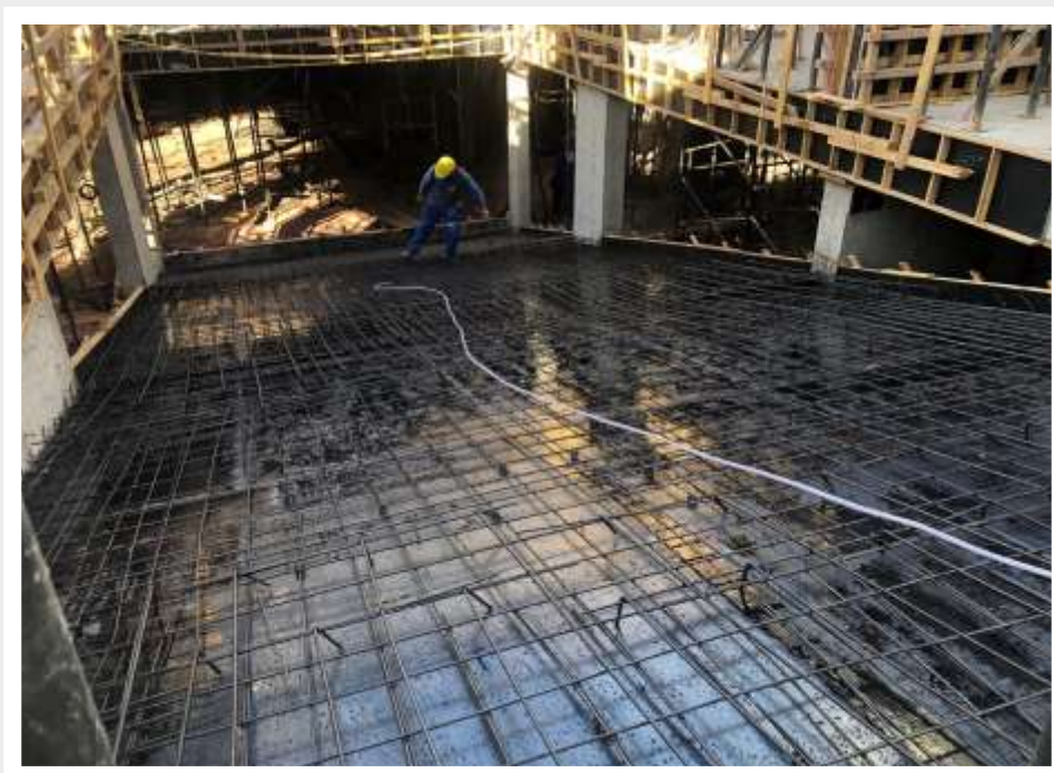
Execução da montagem da armação da rampa do 1º subsolo – Junho 2024
