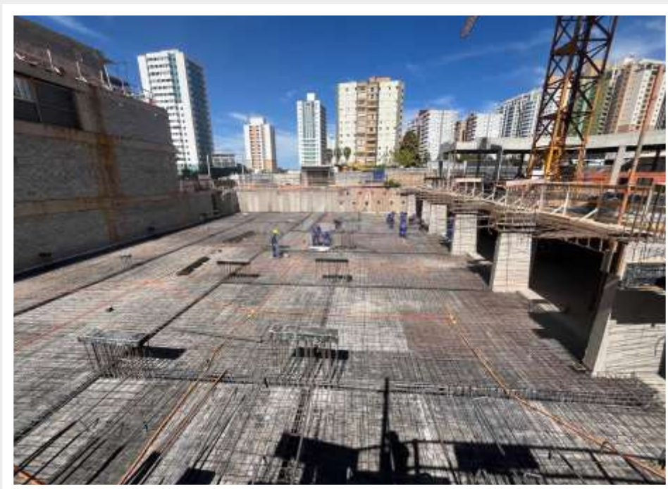
Execução da armação da laje do 1º subsolo – Julho 2024
