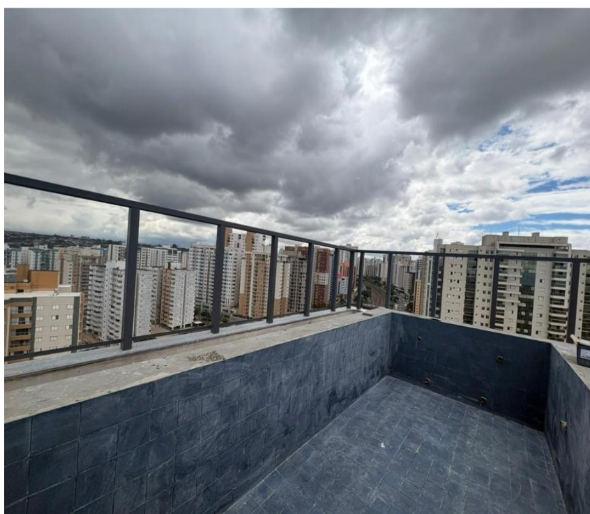
Instalações dos guarda-corpos e revestimento das piscinas – Janeiro 2026
