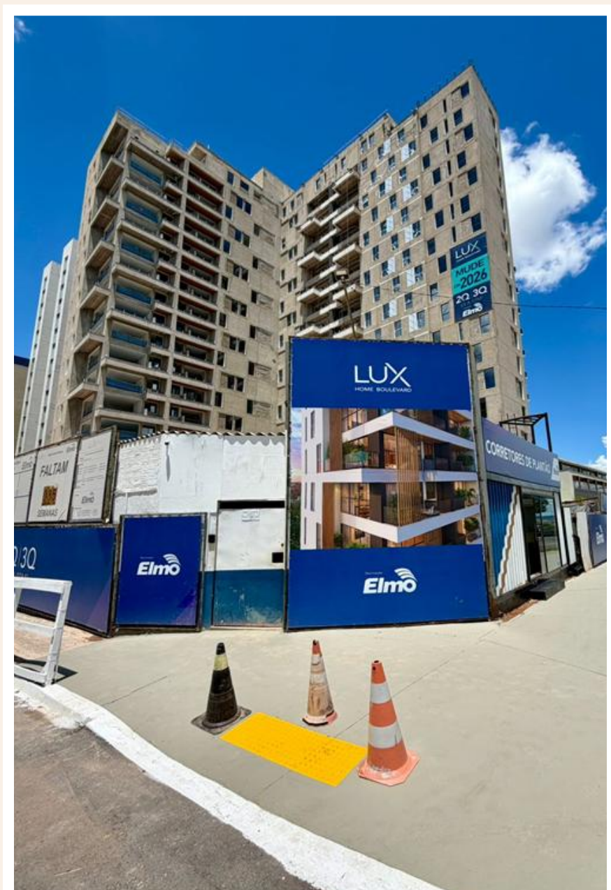
Situação área externa – Janeiro 2026
