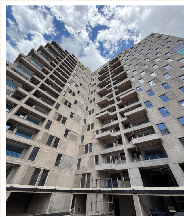
Instalações das esquadrias – Dezembro 2025
