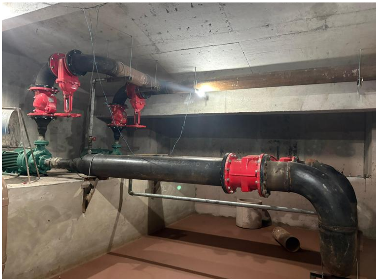
Instalação das bombas de incêndio – Novembro 2025
