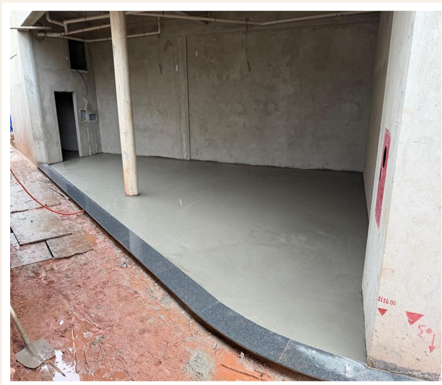
Concretagem do piso das lojas – Dezembro 2025
