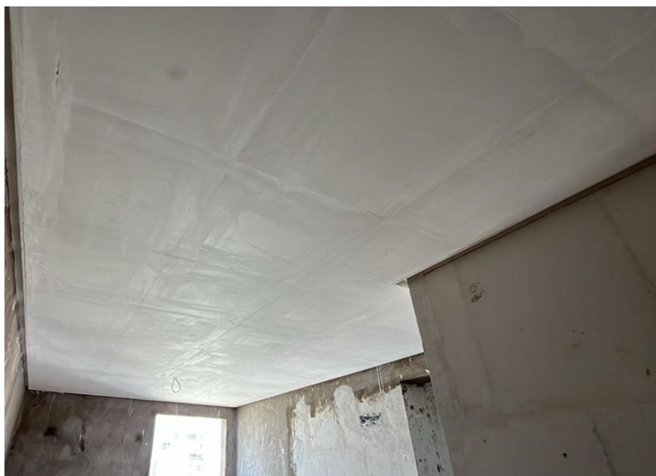
Execução do forro no 17º pavimento – Novembro 2025
