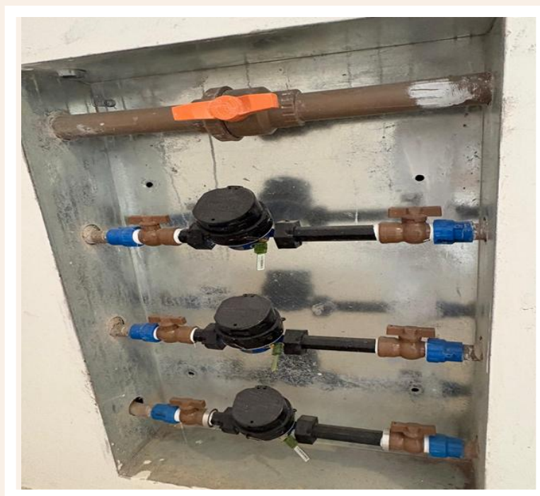
Instalação dos hidrômetros dos apartamentos – Novembro 2025
