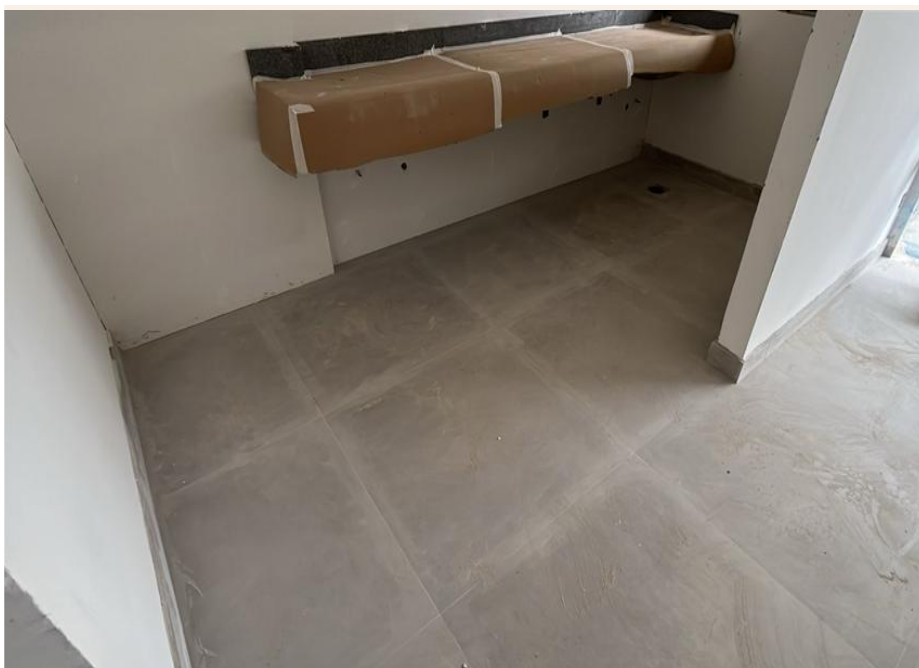
Execução de rejuntamento e proteção no 12º pavimento – Novembro 2025
