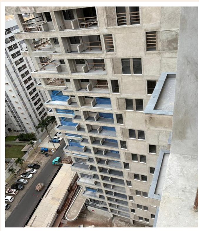
Instalações dos peitoris e conclusão do reboco na fachada frontal – Novembro 2025
