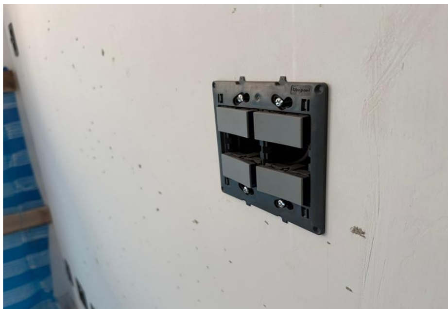
Execução de instalação das tomadas e interruptores do 2º pavimento – Novembro 2025
