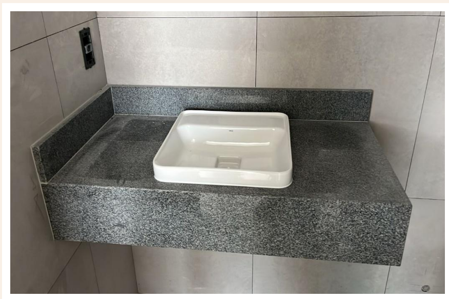
Execução da instalação das cubas do 16º pavimento – Janeiro 2026
