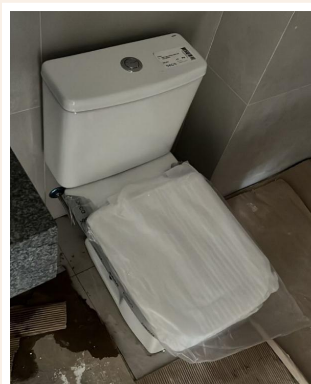
Instalações das louças – Janeiro 2026
