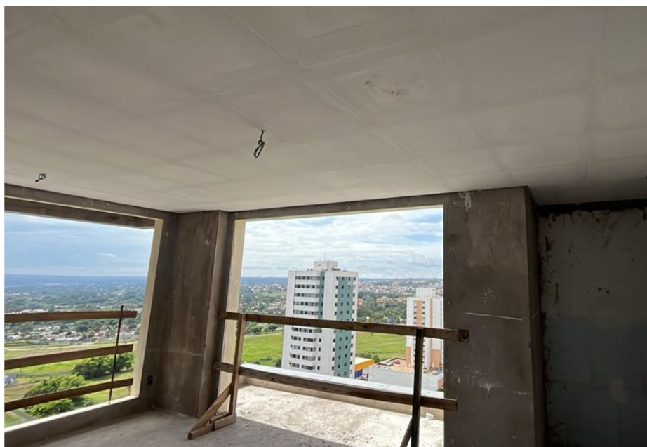
Execução do forro no 17º pavimento – Novembro 2025
