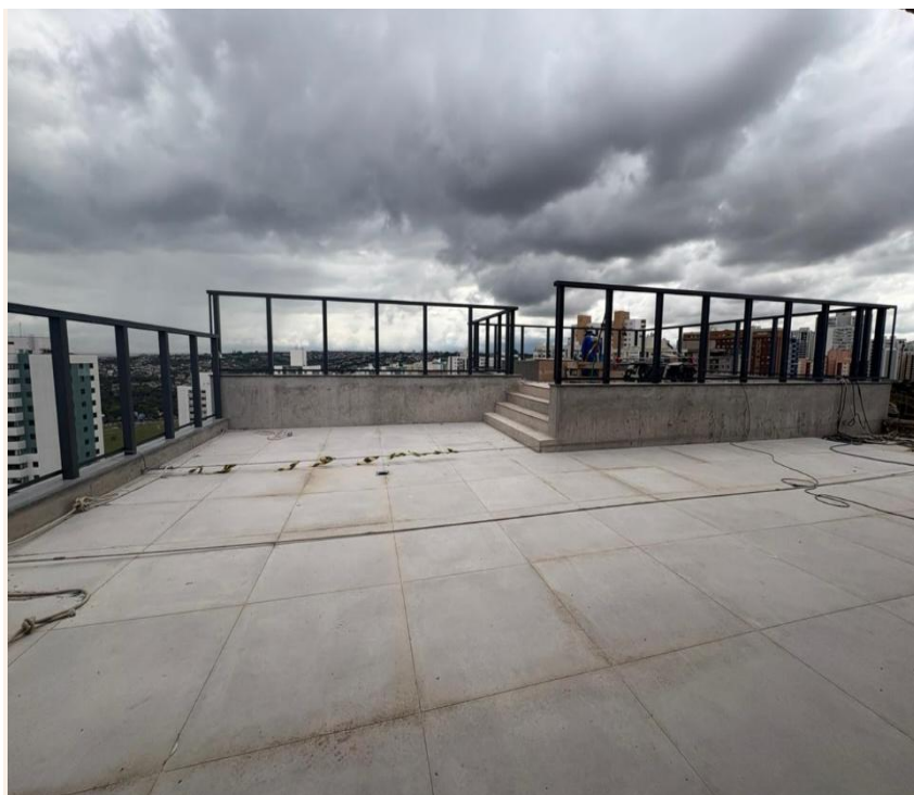
Instalações dos guarda-corpos – Janeiro 2026
