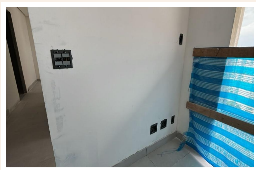
Execução de instalação dos das tomadas e interruptores do 16º pavimento – Janeiro 2026
