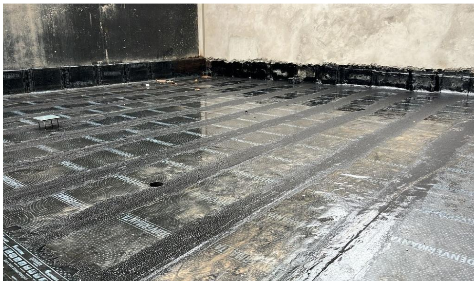
Impermeabilização dos pisos das garagens do térreo – Janeiro 2026
