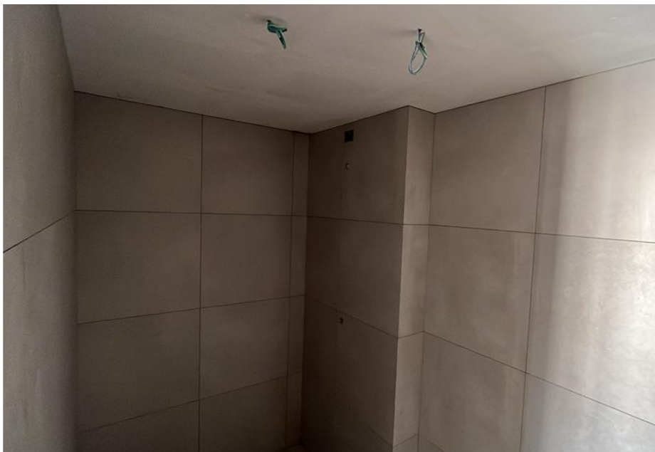
Execução de porcelanato do 15º pavimento – Novembro 2025
