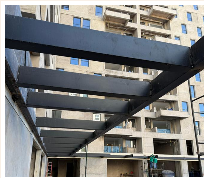
Execução do pergolado – Dezembro 2025
