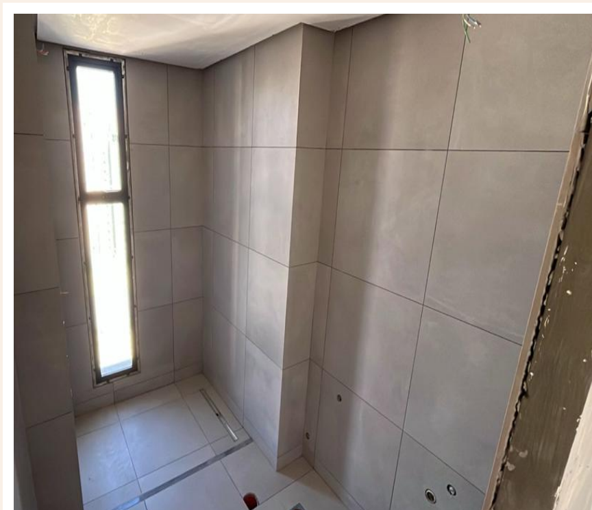
Execução de porcelanato do 18º pavimento – Dezembro 2025
