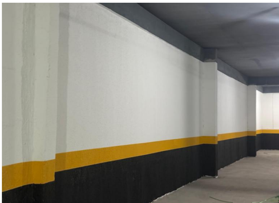
Pintura da primeira demão das garagens do 2º subsolo – Novembro 2025
