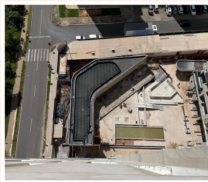
Execução de manta e teste de estanqueidade no Deck Solarium – Dezembro 2025
