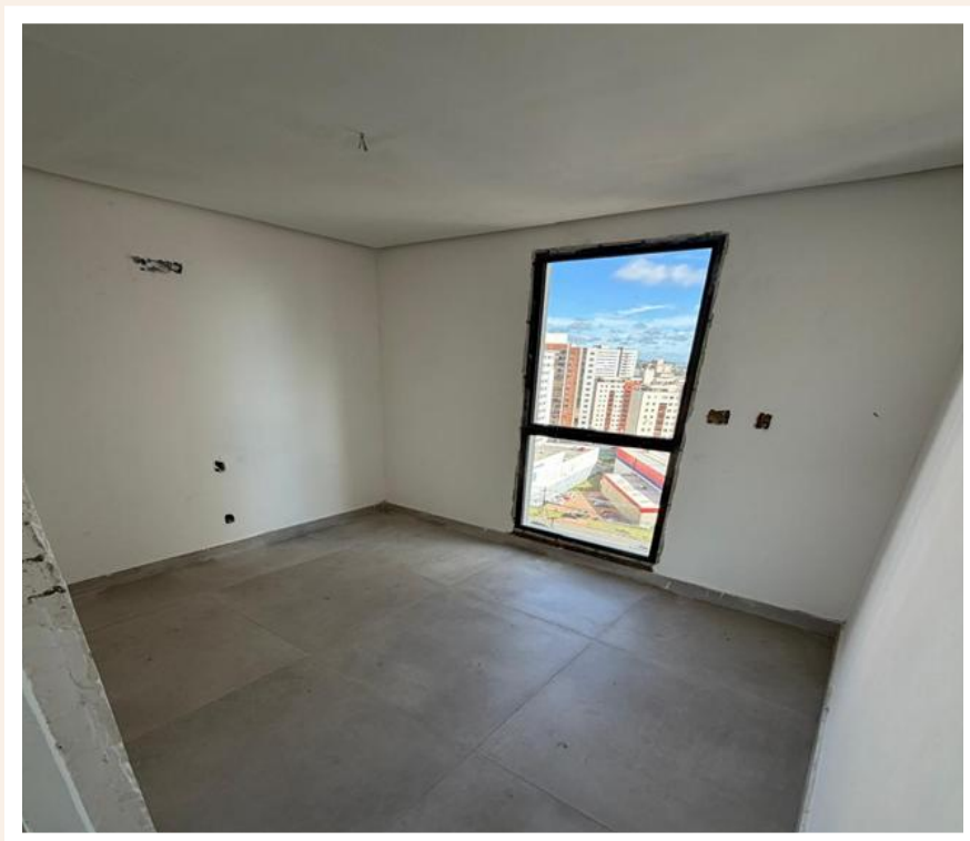
Execução de pintura 1º demão do 16º pavimento – Dezembro 2025
