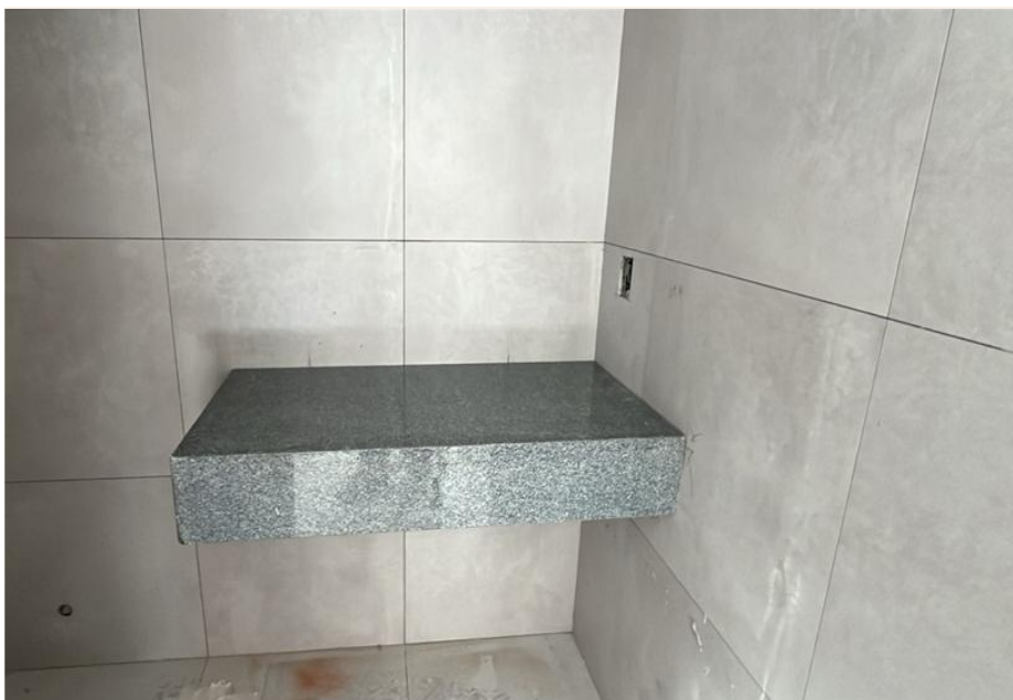
Execução de instalação das bancadas do 13º pavimento – Novembro 2025
