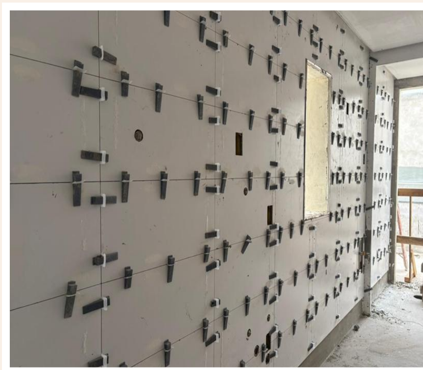
Execução de porcelanato do 18º pavimento – Dezembro 2025
