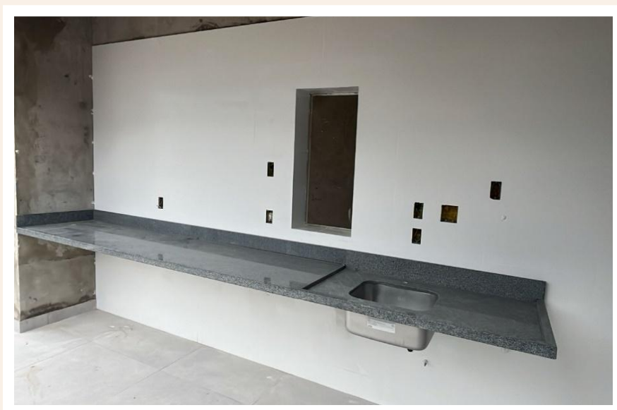
Instalações das bancadas do 18º pavimento – Janeiro 2026
