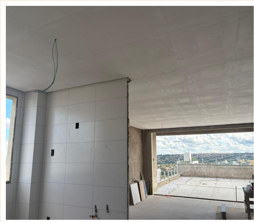
Execução do forro no 18º pavimento – Dezembro 2025
