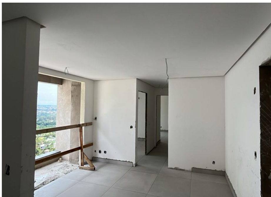
Execução de emassamento do 16º pavimento – Novembro 2025
