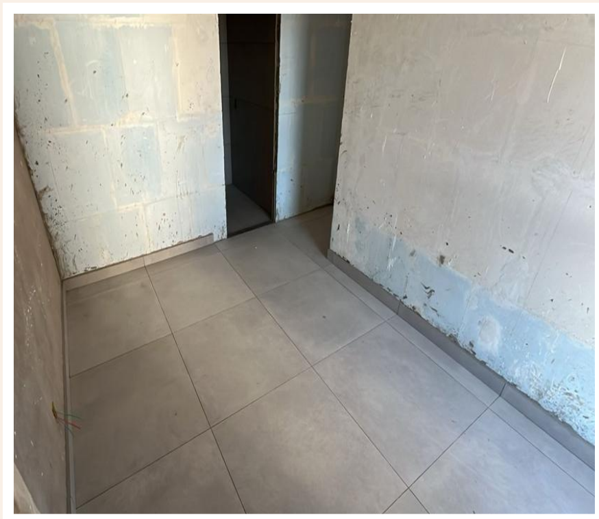
Execução de revestimento cerâmico do 16º e 17º pavimento – Dezembro 2025
