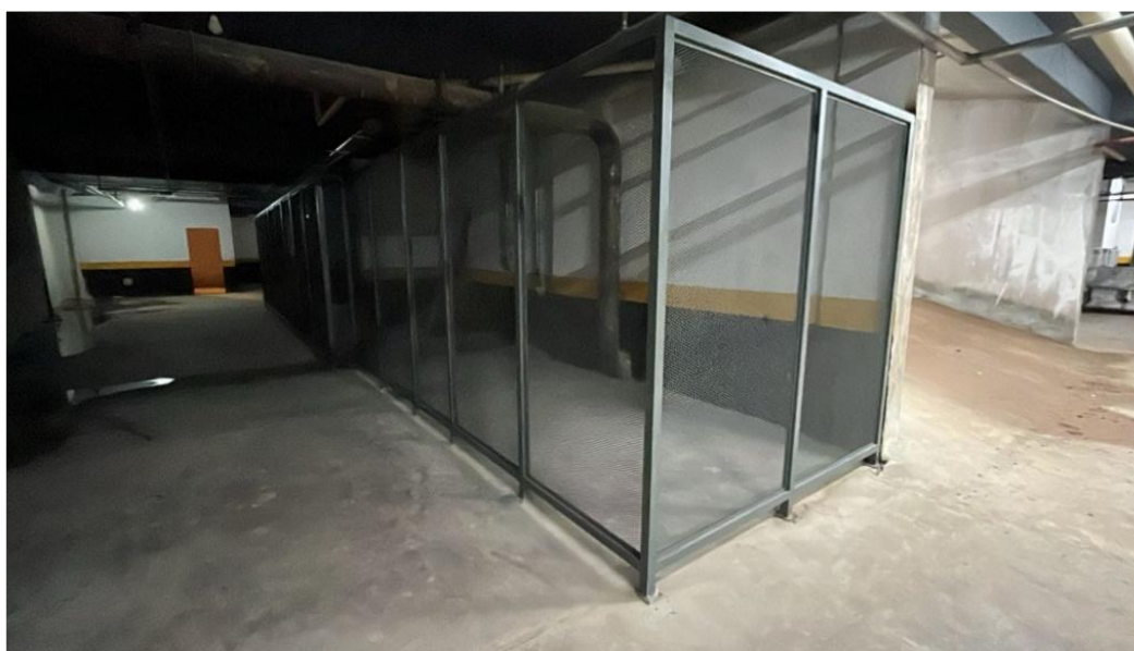
Execução dos bicicletários – Janeiro 2026
