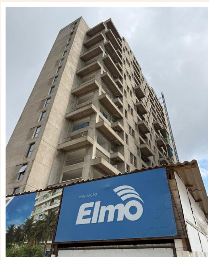
Instalações das esquadrias – Novembro 2025
