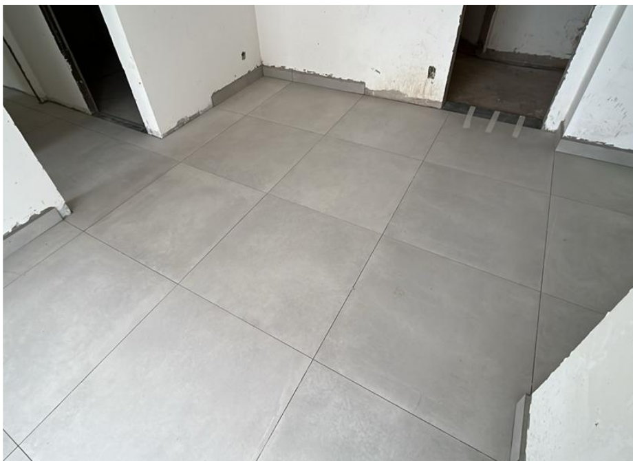
Execução de porcelanato do 15º pavimento – Novembro 2025
