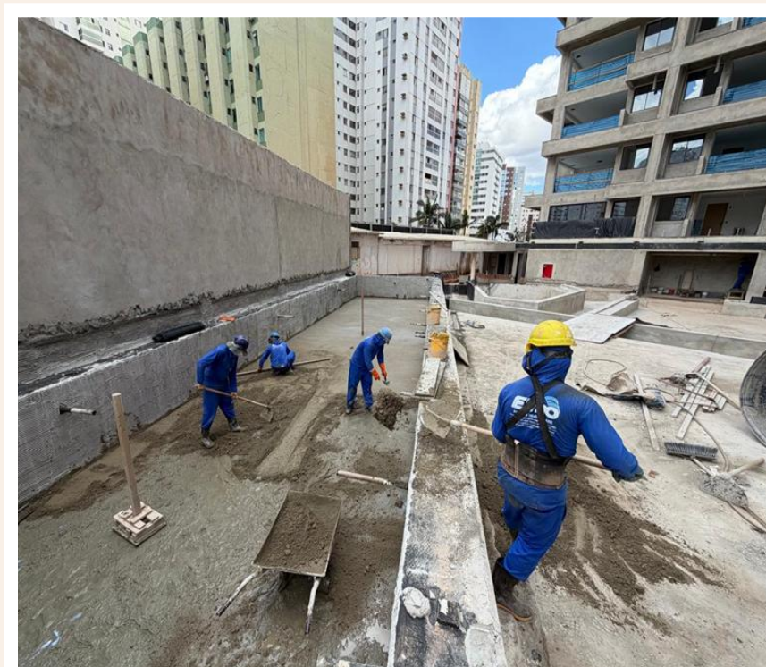
Execução da piscina do térreo – Dezembro 2025
