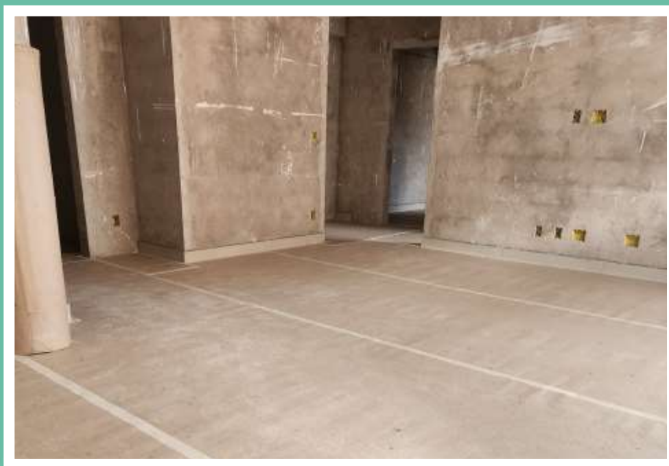
Proteção dos revestimentos no 12º pavimento – Maio 2024
