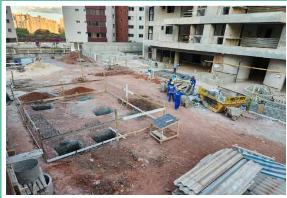
Fundações da guarita e desmobilização do canteiro – Pavimento térreo – Julho 2024
