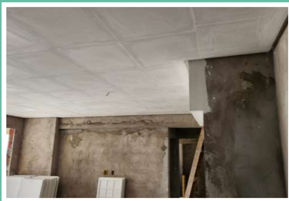
Revestimento em forro de gesso no teto no 16º pavimento – Junho 2024
