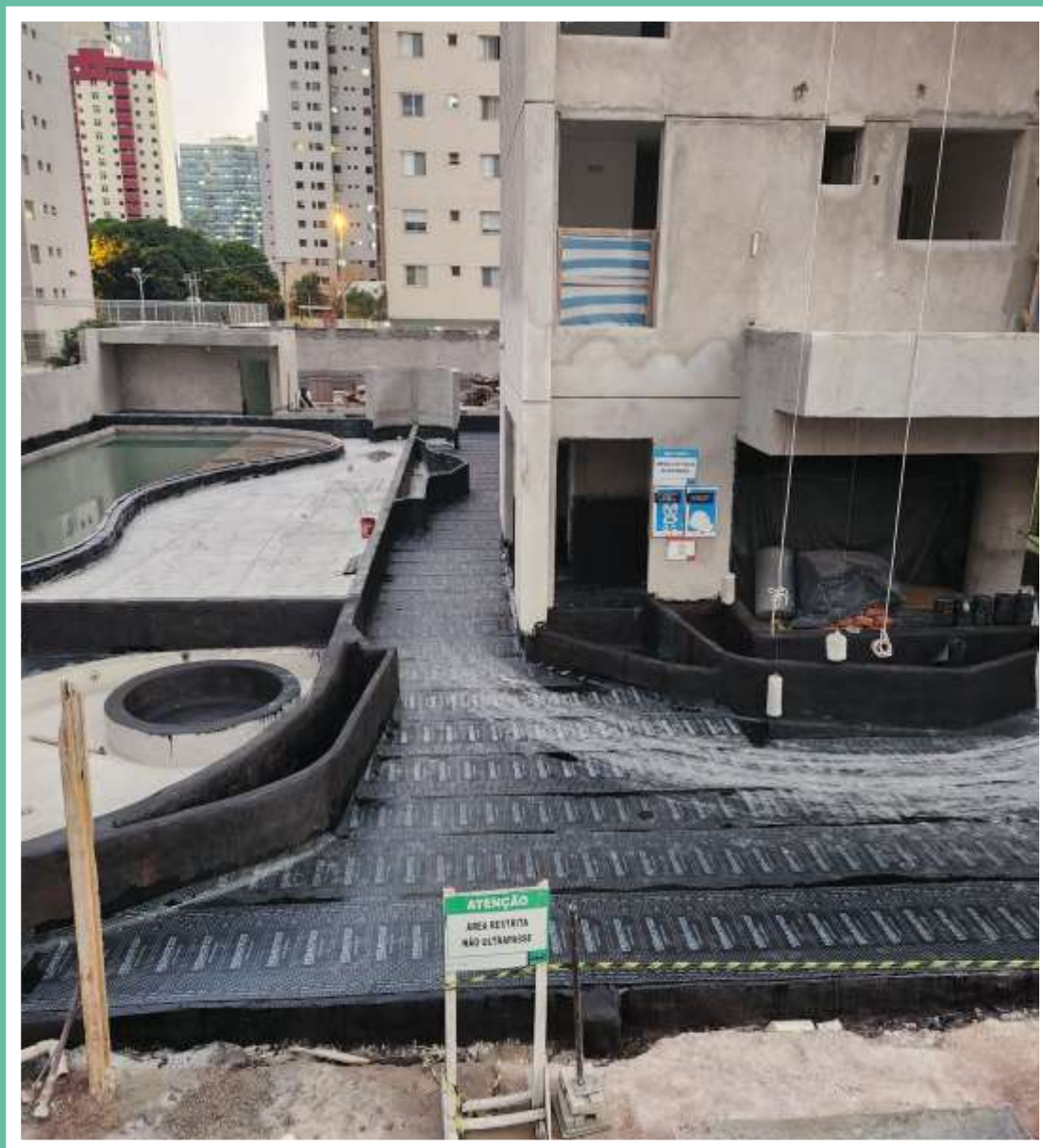
Impermeabilização – Pavimento térreo – Maio 2024
