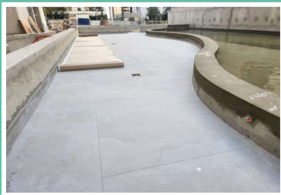
Revestimento da área comum e teste de estanqueidade da piscina adulto – Pavimento térreo – Julho 2024
