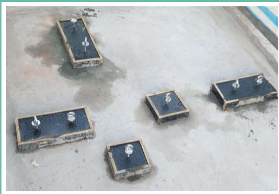
Pontos de ancoragem definitivo – Cobertura / Ático – Maio 2024
