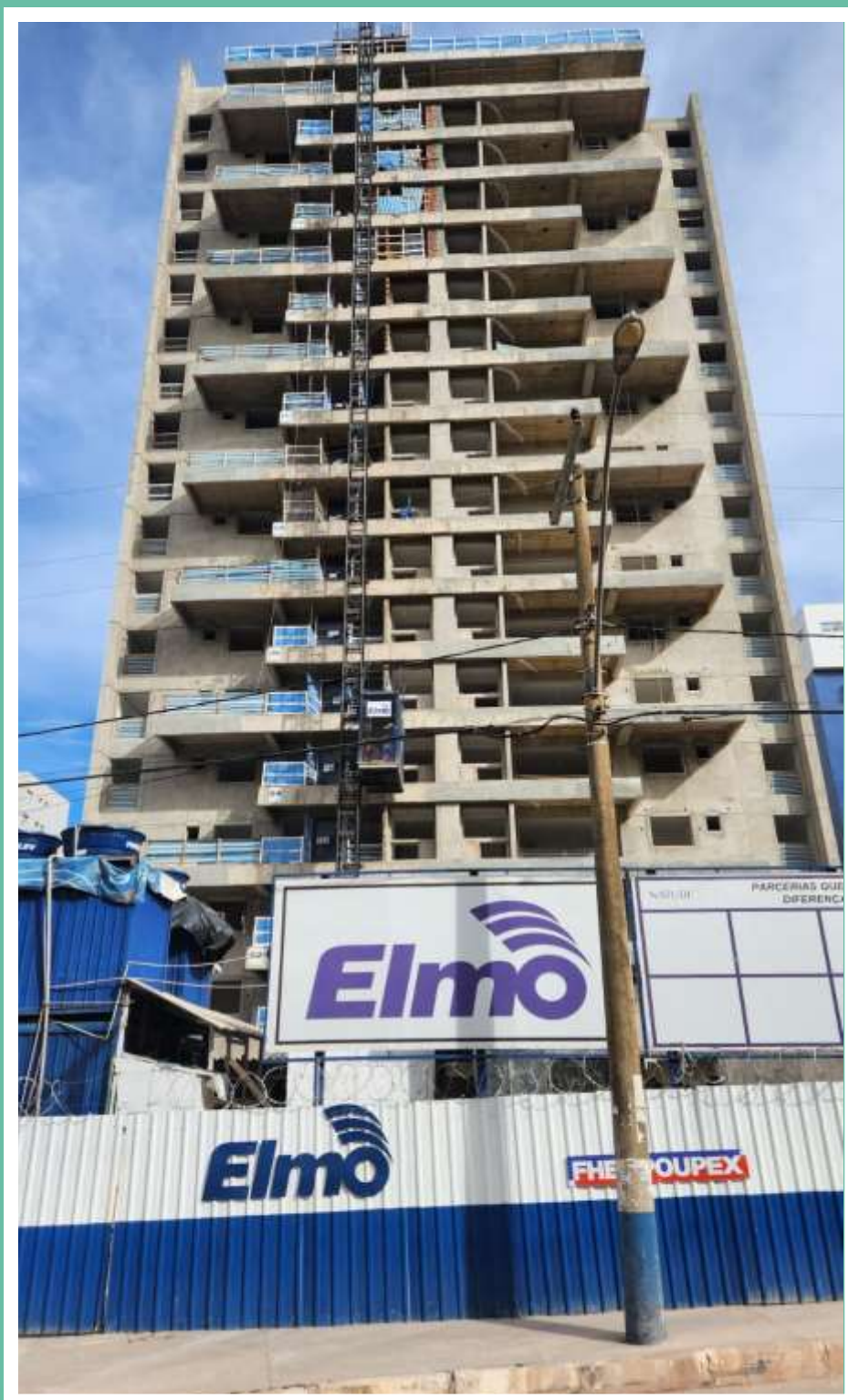
Vista Externa – fachada frontal – Junho 2024
