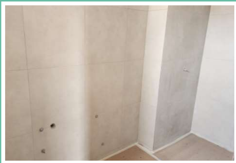
Revestimento de parede do 15º pavimento – Junho 2024
