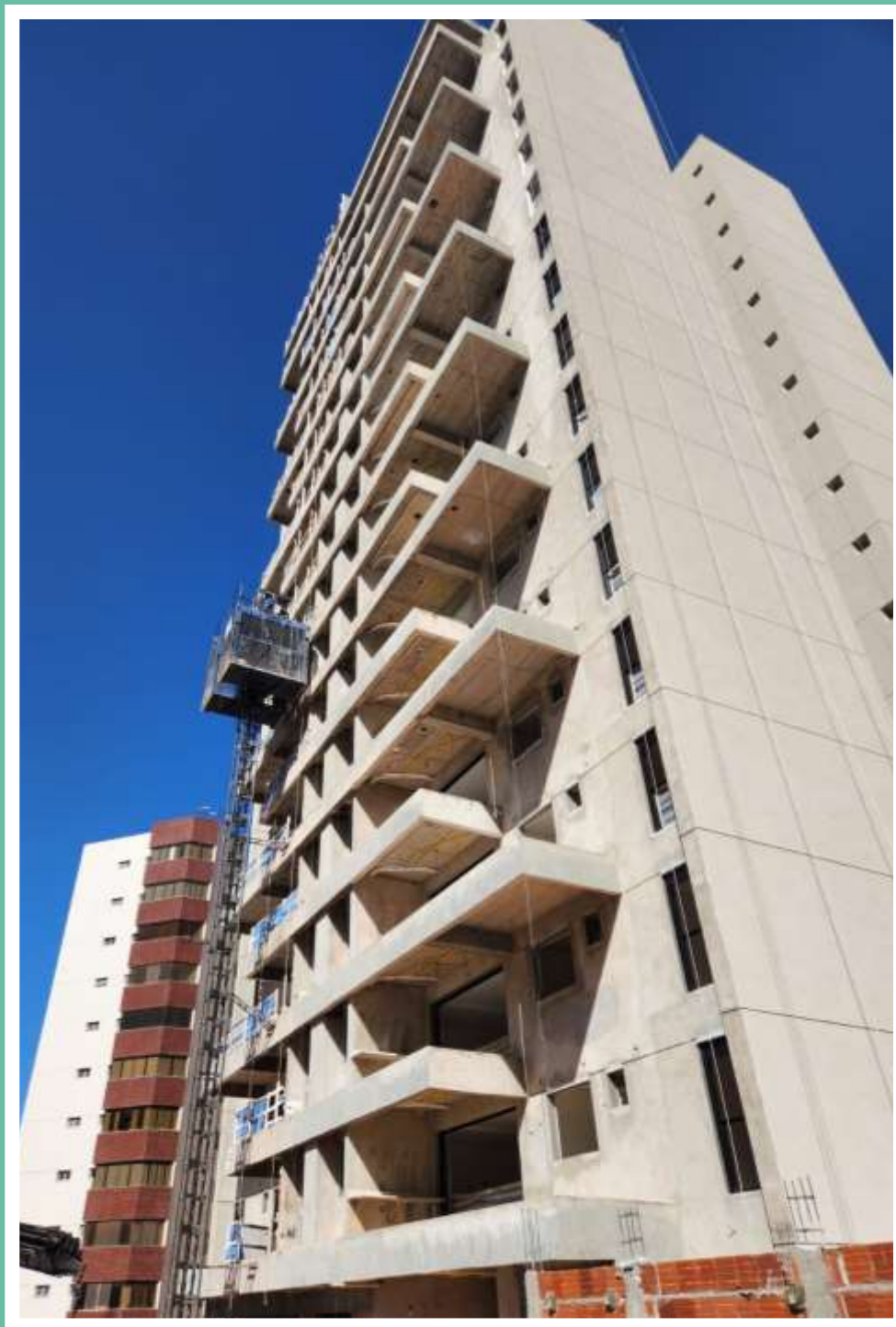
Vista externa – Fachada lateral direita – Julho 2024
