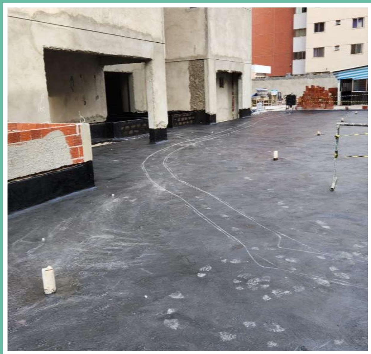
Preparação para impermeabilização – Pavimento térreo – Junho 2024
