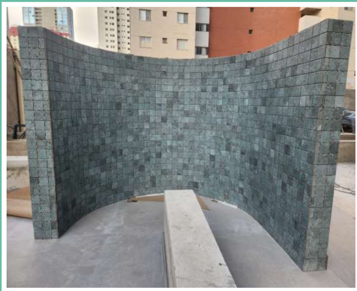
Revestimento da ducha da entrada da piscina adulto – Pavimento térreo – Julho 2024
