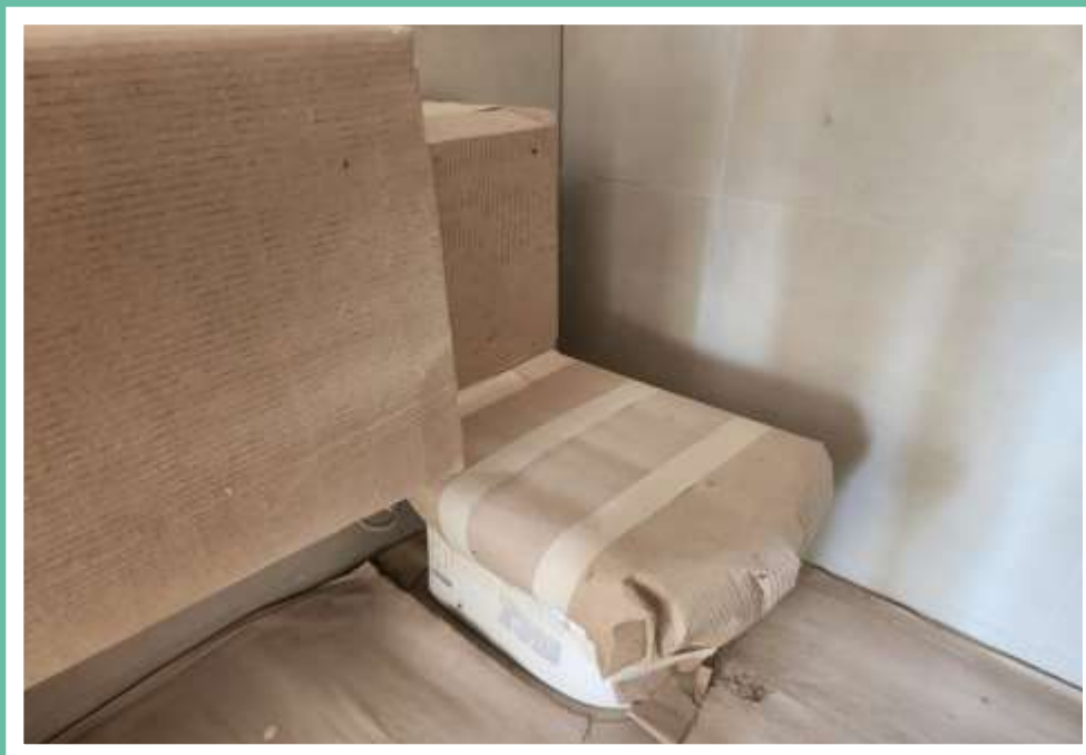
Proteção de louças e bancadas do 5º pavimento – Julho 2024
