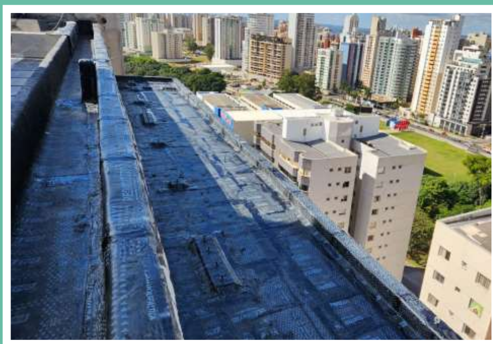
Impermeabilização da manta asfáltica da cobertura – Maio 2024
