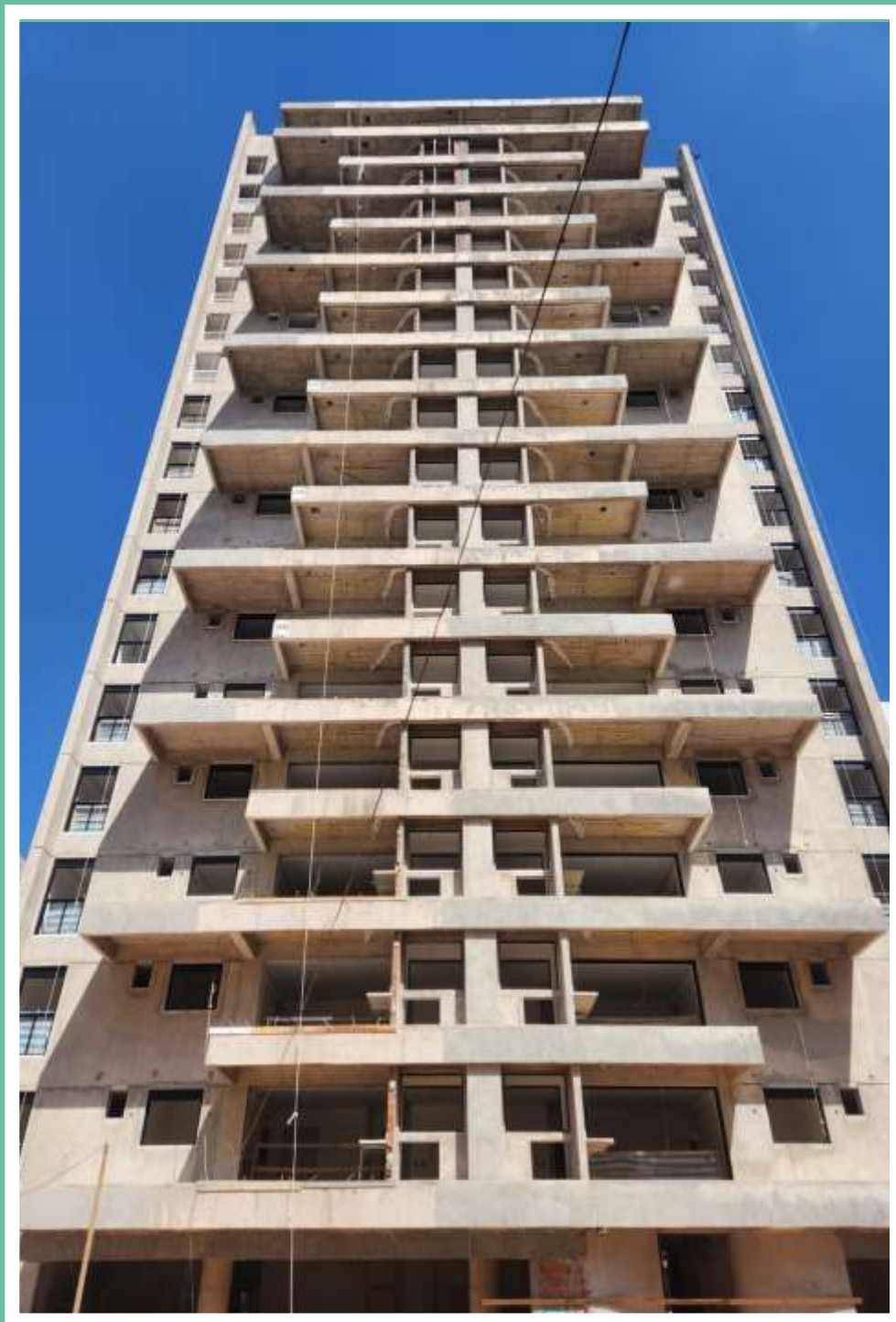
Vista externa – Fachada frontal (principal) – Julho 2024
