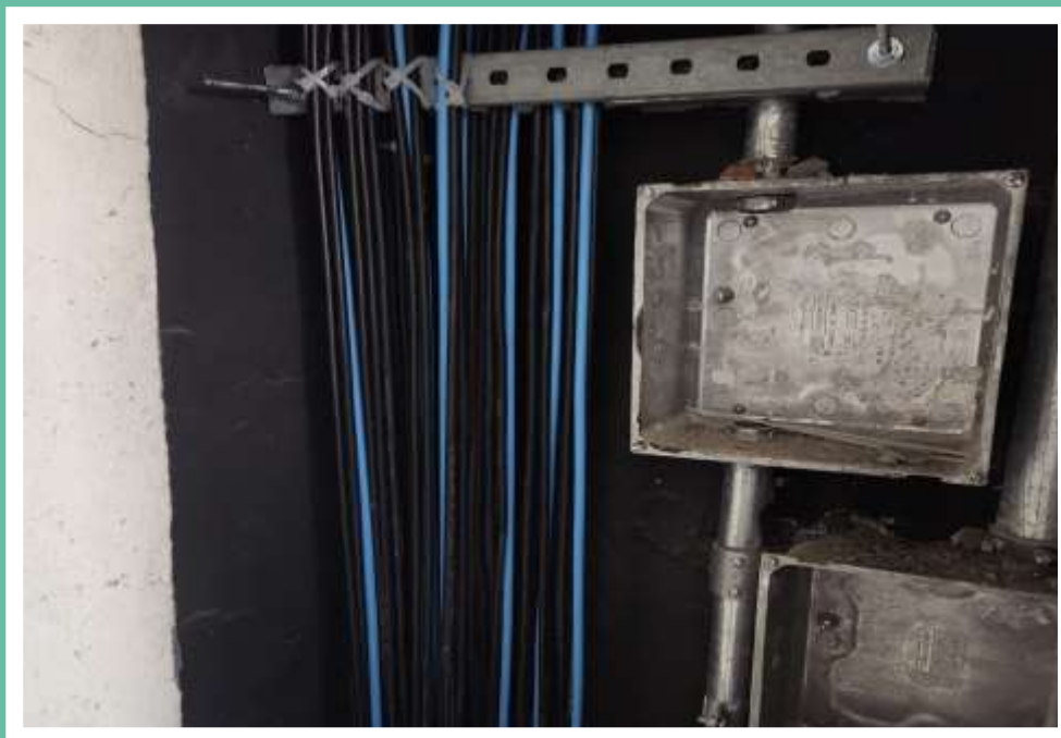
Cabeamento das prumadas elétricas da torre – Maio 2024
