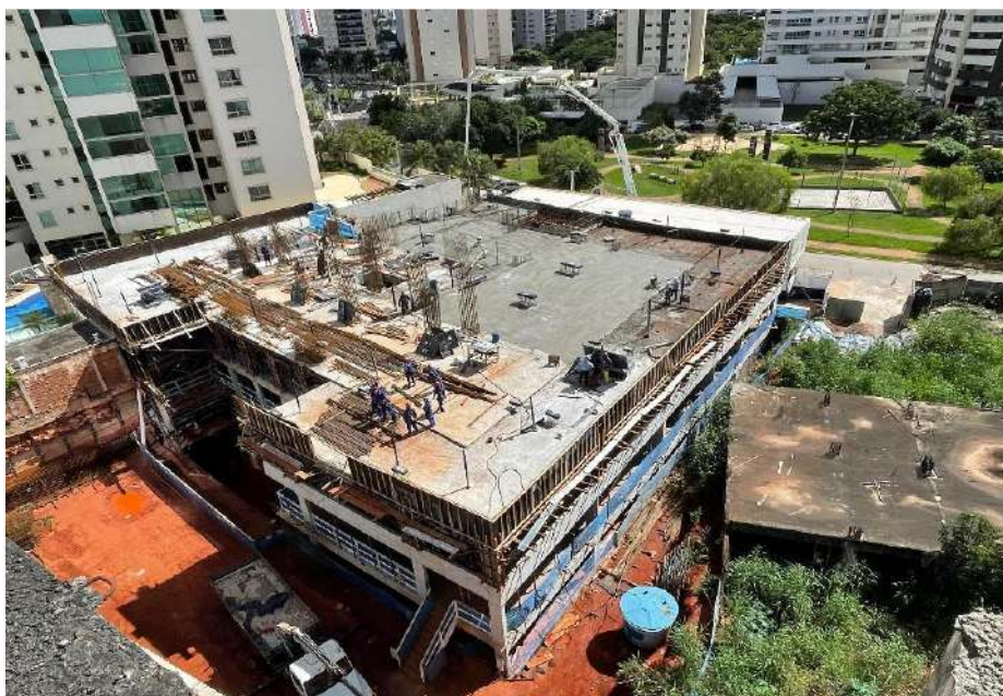
Concretagem do trecho da laje (pavimento garagem 02) – Abril 2024
