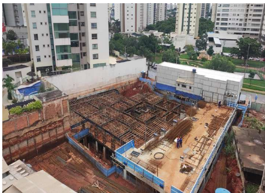
Montagem do trecho da laje (pavimento térreo) – Fevereiro 2024
