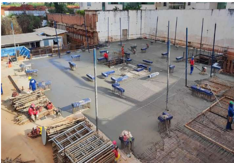
Concretagem do trecho da laje (pavimento térreo) – Fevereiro 2024
