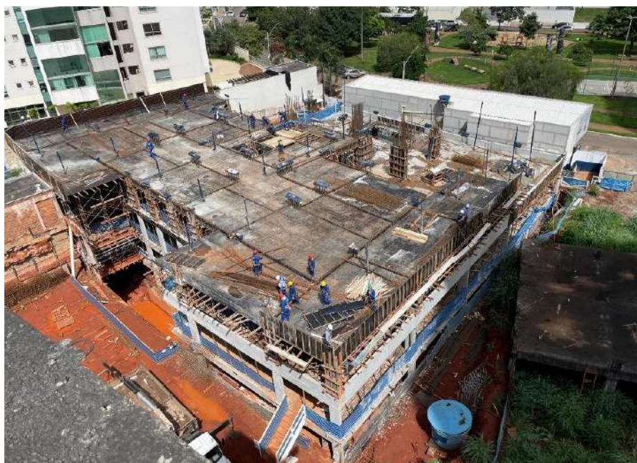
Montagem do trecho da laje (pavimento garagem 02) – Março 2024
