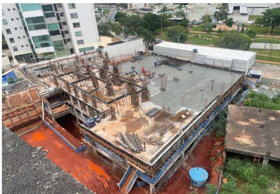
Concretagem do trecho da laje (pavimento garagem 01) – Março 2024
