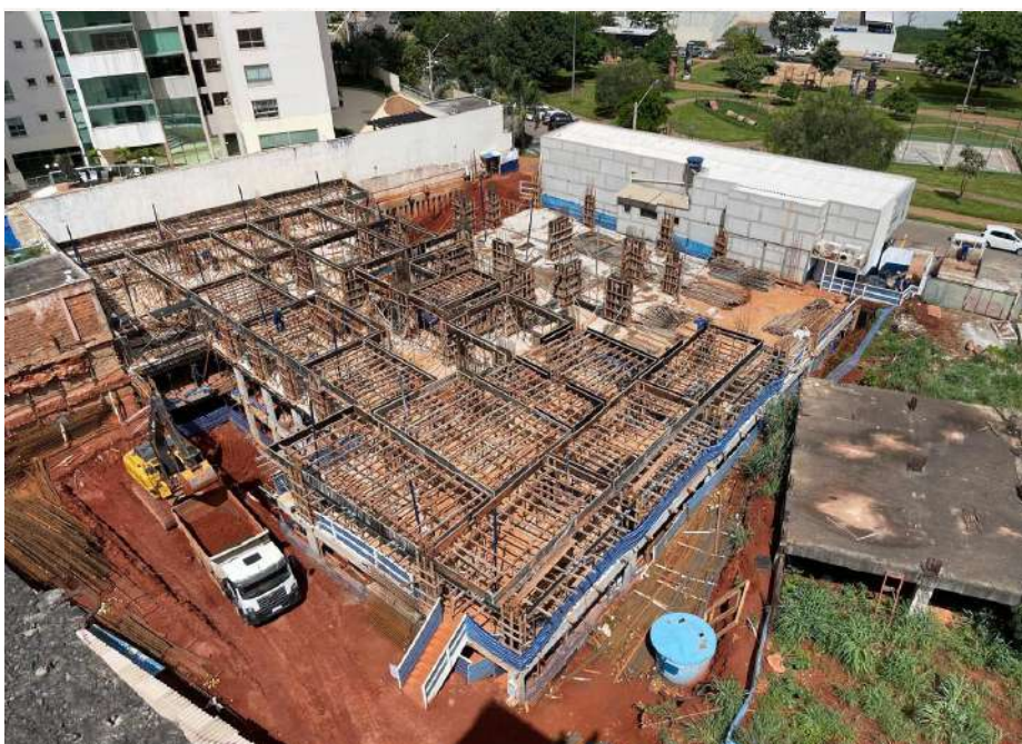
Montagem do trecho da laje (pavimento garagem 01) – Março 2024
