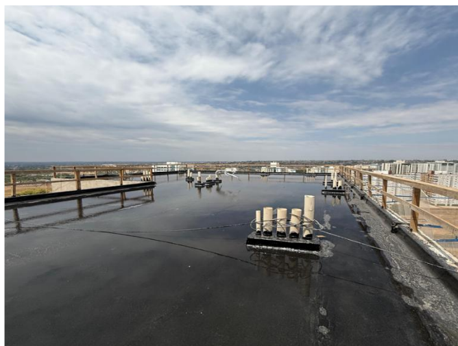
Teste de estanqueidade da cobertura – Setembro 2025
