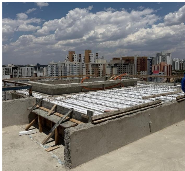
Execução do deck das piscinas das coberturas – Outubro 2025
