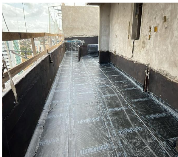
Execução de impermeabilização das unidades do 18º pavimento – Agosto 2025
