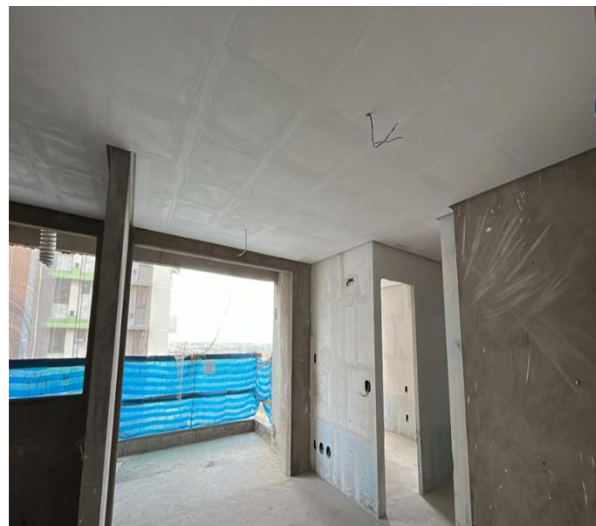
Execução de forro de gesso do 11º pavimento – Agosto 2025
