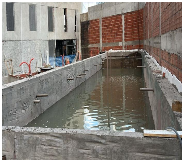
Execução de teste carga/mecânica da piscina adulto antes da aplicação da manta de impermeabilização – Agosto 2025
