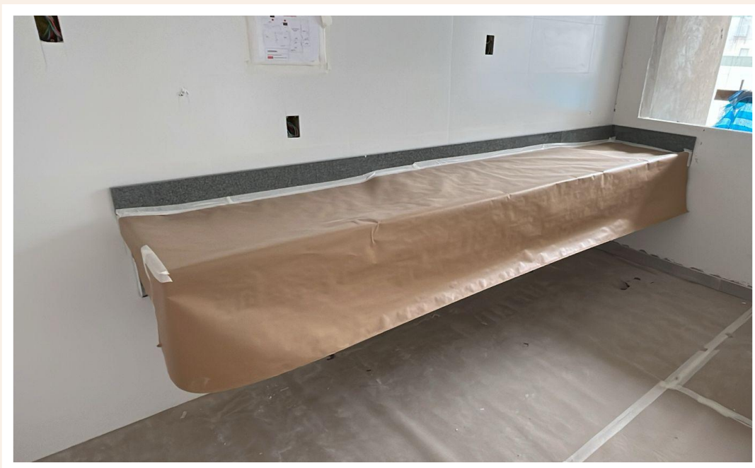
Proteção das bancadas em granito – Outubro 2025
