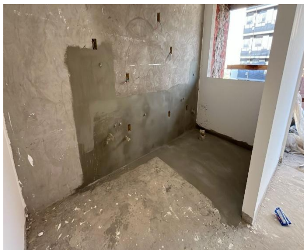
Execução de impermeabilização nos pavimentos 11º e 12º – Setembro 2025
