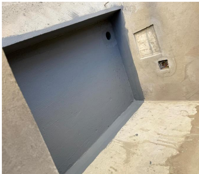
Impermeabilização das varandas e das áreas técnicas – Outubro 2025
