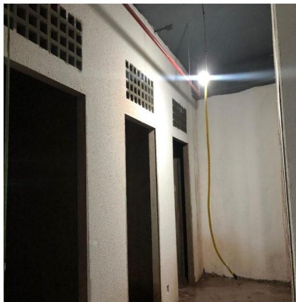
Instalação dos contra marcos e ventilação dos depósitos/escaninhos – Outubro 2025
