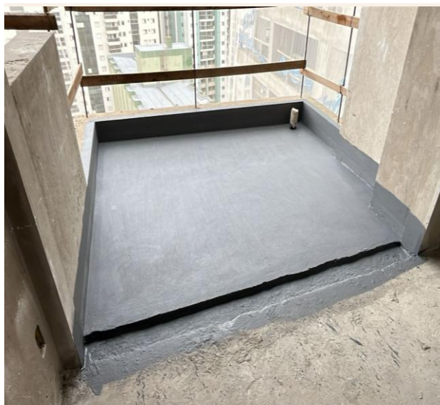
Impermeabilização das varandas e das áreas técnicas – Outubro 2025
