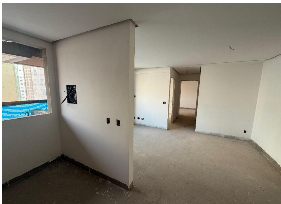
Execução da 1ª demão de pintura dos apartamentos do 1º ao 7º pavimento – Outubro 2025
