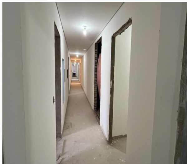
Execução emassamento das paredes do hall – Agosto 2025
