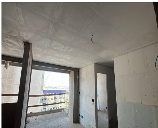
Execução de forro placa nos pavimentos 12º e 13º – Setembro 2025
