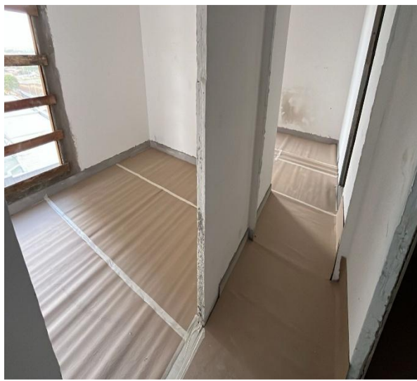
Execução de proteção de piso revestimento cerâmico parede no 4º, 5º e 6º pavimentos – Agosto 2025
