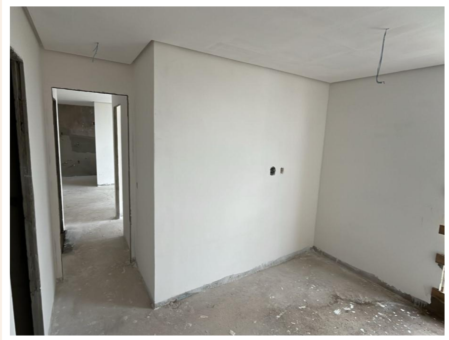
Execução do emassamento dos apartamentos no 15º pavimento – Outubro 2025
