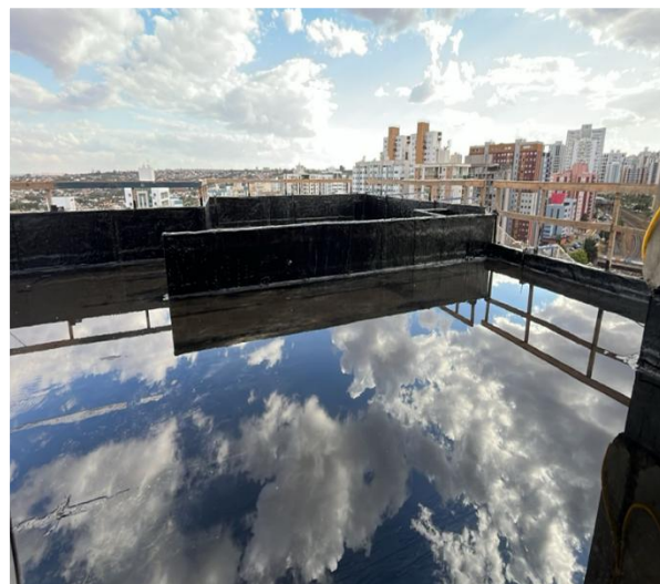
Teste de estanqueidade das unidades do 18º pavimento – Agosto 2025
