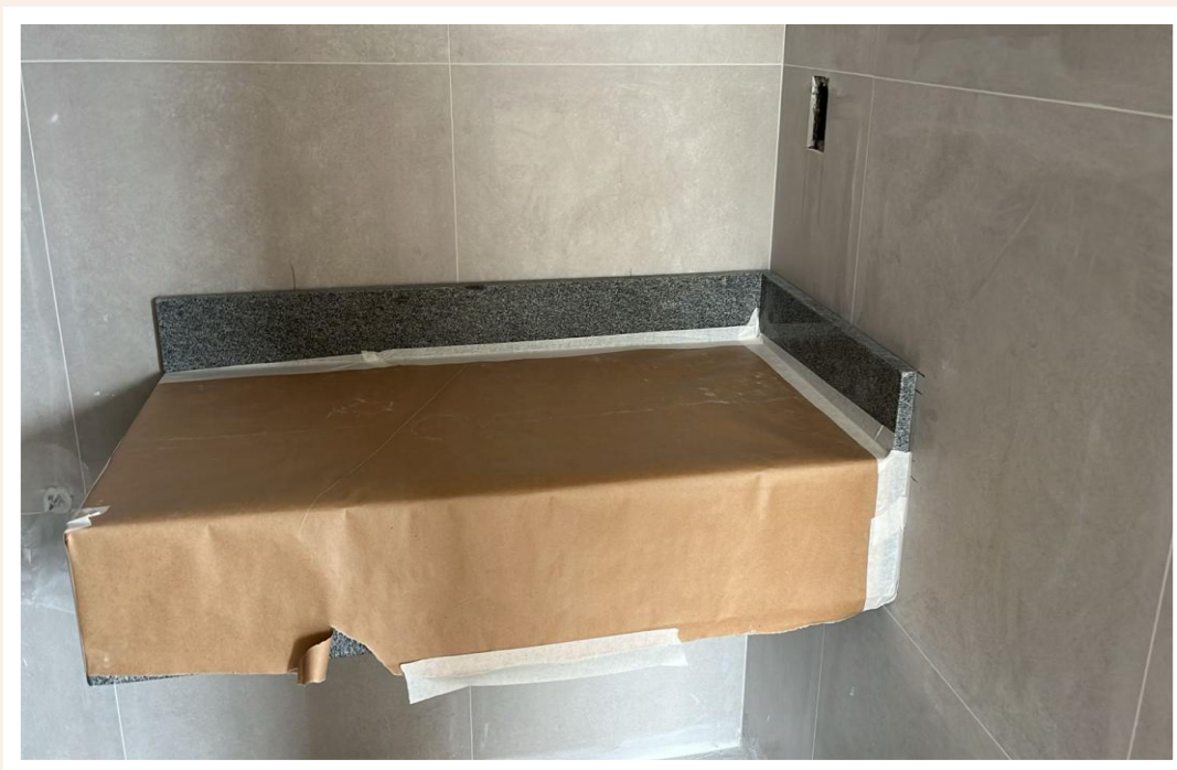
Proteção das bancadas em granito – Outubro 2025
