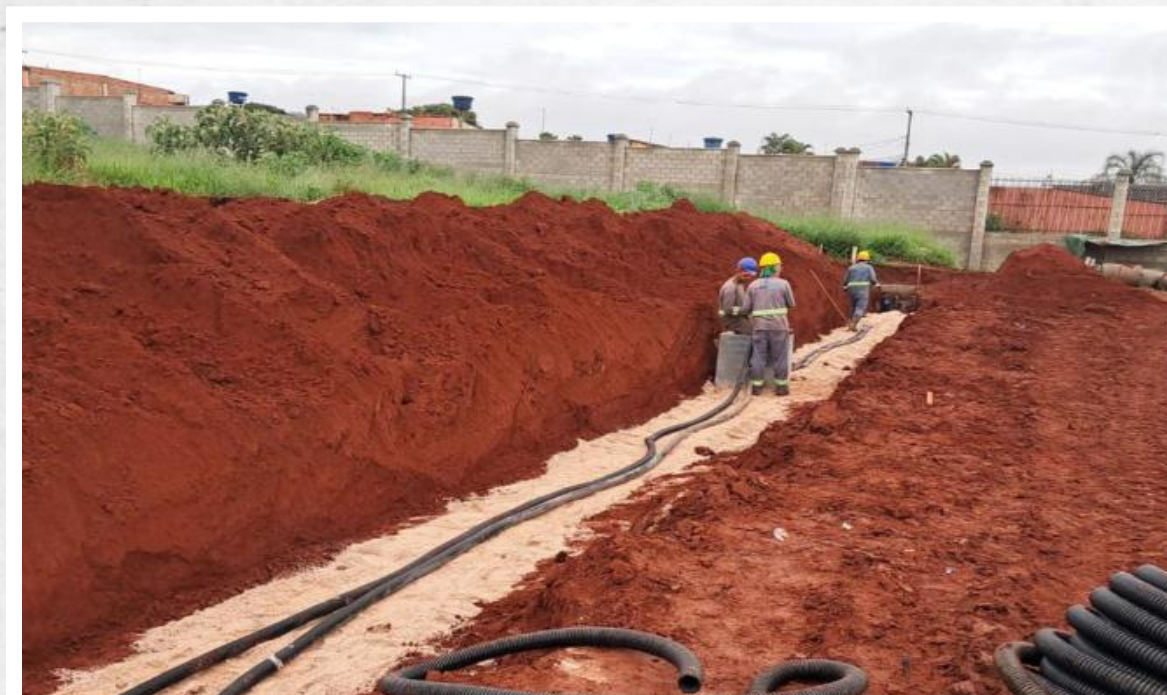
Execução de rede elétrica, iluminação pública e telecomunicação subterrâneo – Dezembro 2025
