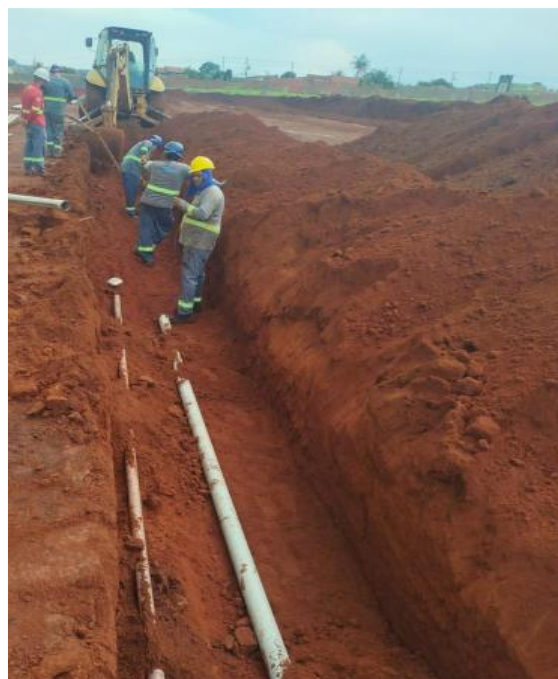
Execução de rede interna de água e esgoto – Dezembro 2025
