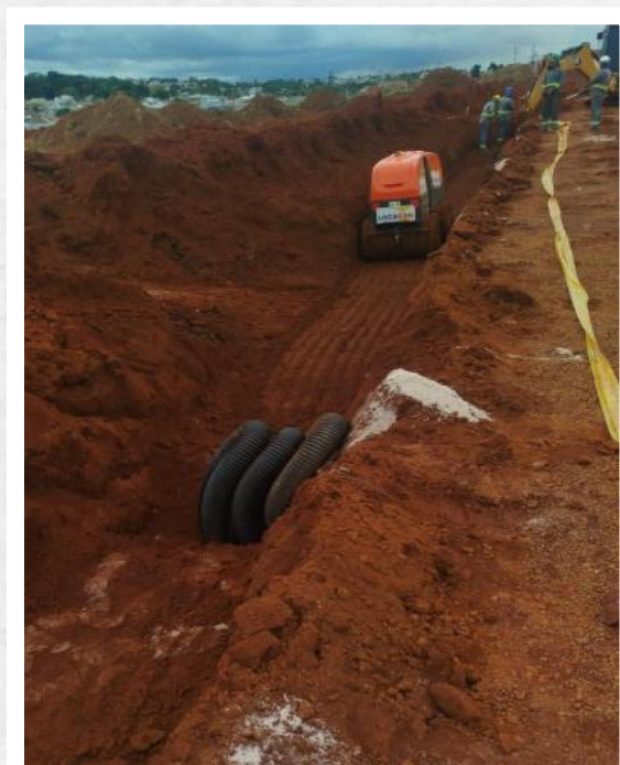
Execução de rede elétrica, iluminação pública e telecomunicação subterrâneo – Dezembro 2025
