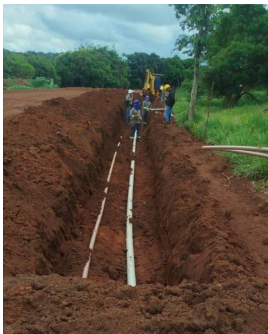
Execução de sistema de abastecimento de água (adutora externa) / execução de rede interna de água e esgoto – Janeiro 2026
