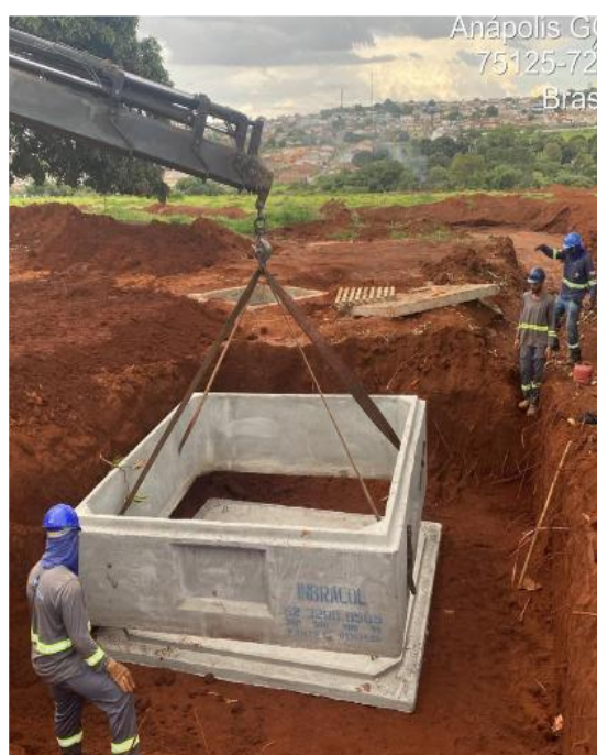
Execução de rede elétrica subterrânea – Assentamento de caixas de passagem – Dezembro 2025
