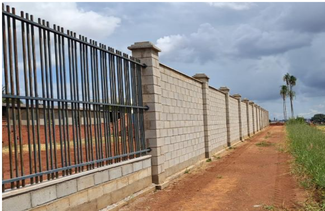
Execução do muro (incluso impermeabilização da fundação do muro, garantindo a qualidade construtiva e prevenindo patologias futuras) – Janeiro 2026
