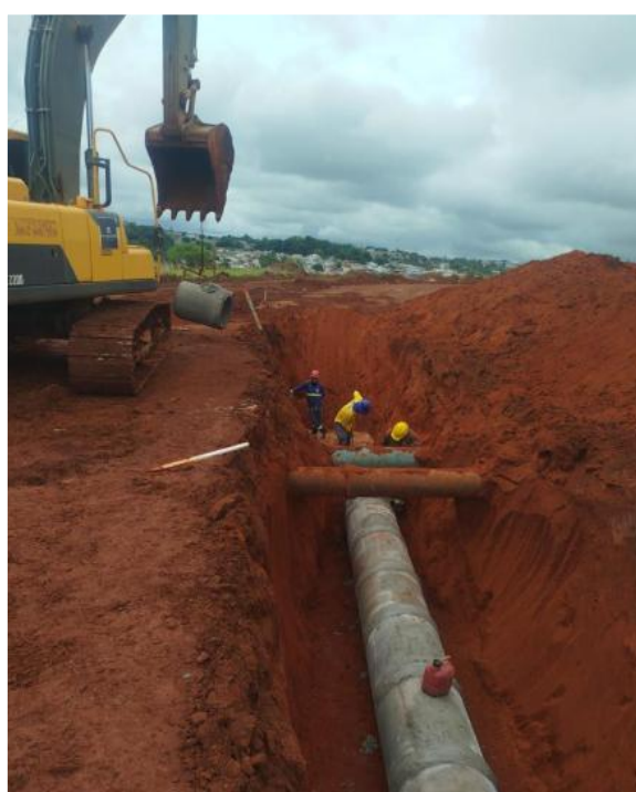
Execução de galeria de águas pluviais – Novembro 2025
