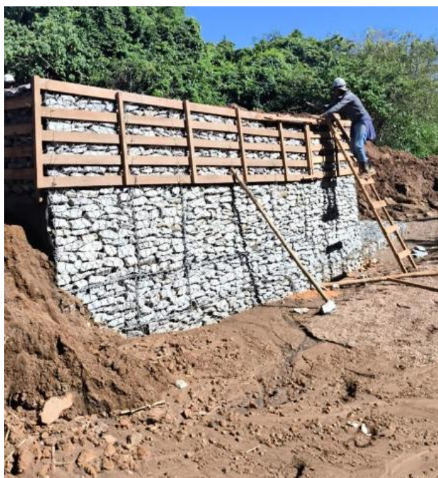
Execução de estrutura de lançamento (dissipadores) – Novembro / Dezembro 2025
