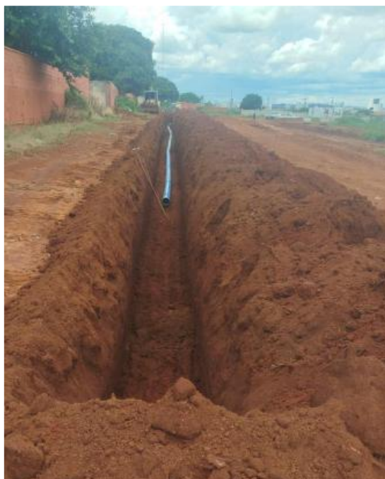
Execução de sistema de abastecimento de água (adutora externa) / execução de rede interna de água e esgoto – Janeiro 2026
