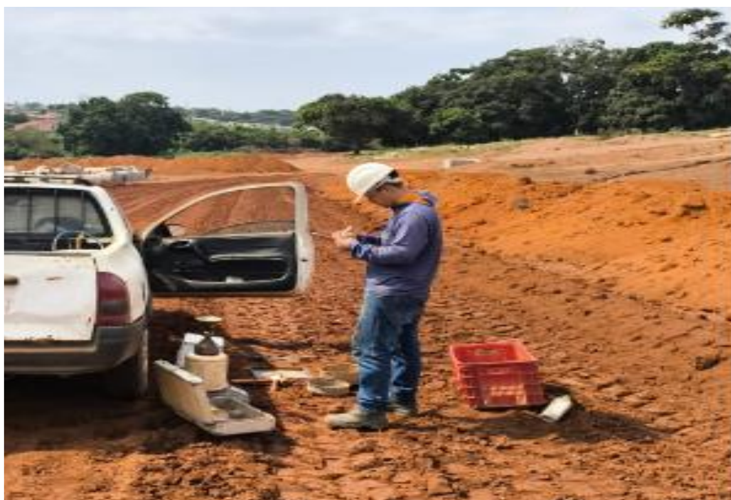
Controle tecnológico (ensaios de compactação) – Novembro 2025
