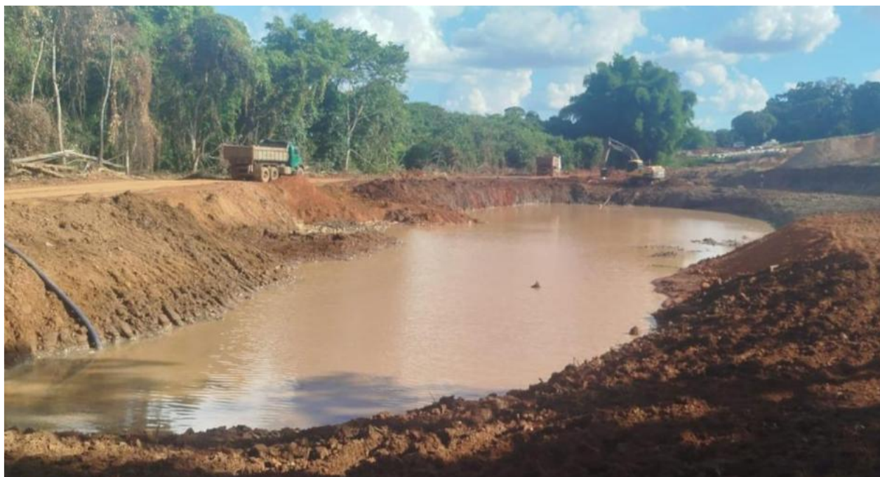
Escavação do lago – Dezembro 2025
