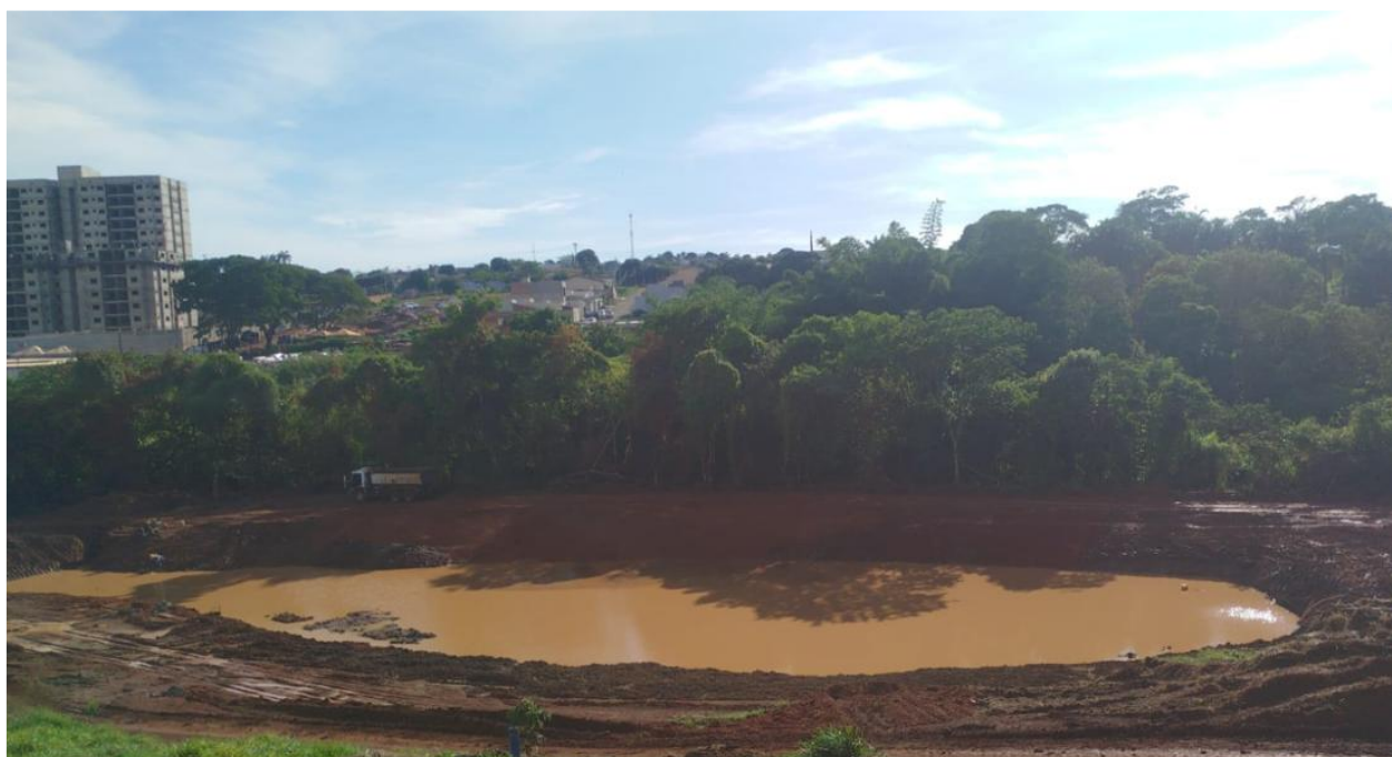
Escavação do Lago – Novembro 2025
