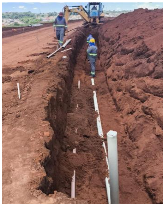
Execução de rede interna de água e esgoto – Dezembro 2025
