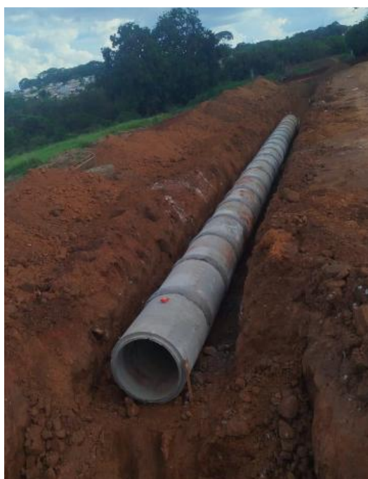
Execução de galeria de águas pluviais – Novembro 2025
