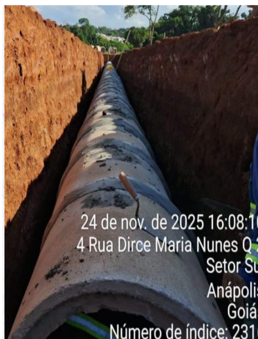
Execução de galeria de águas pluviais – Novembro 2025
