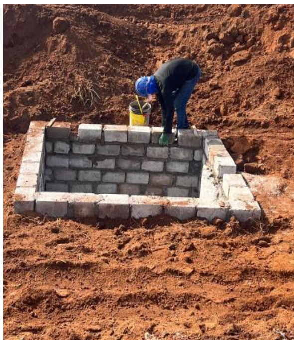
Execução de rede e PVS da galeria pluvial / reaterro e compactação – Dezembro 2025
