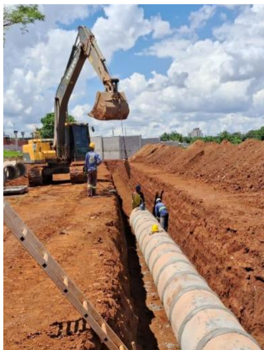
Execução de galeria de águas pluviais – Novembro 2025
