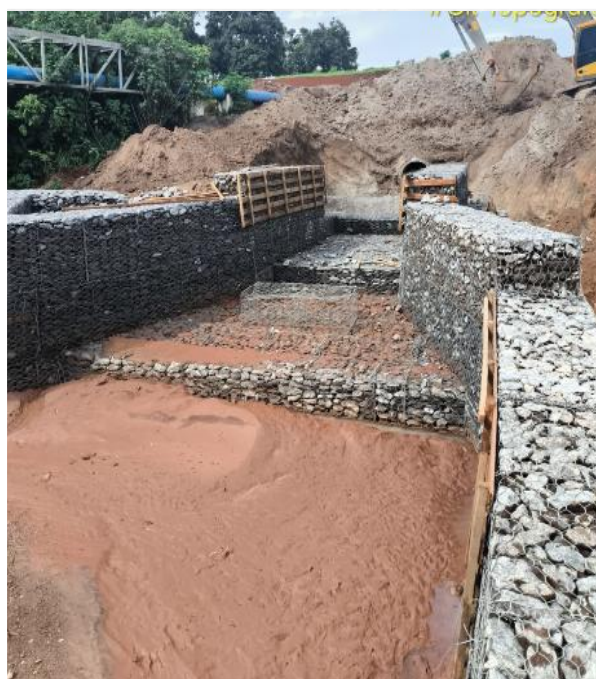
Execução de estrutura de lançamento (dissipadores) – Novembro / Dezembro 2025
