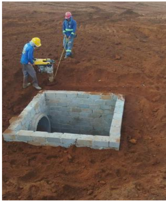
Execução de rede e PVS da galeria pluvial / reaterro e compactação – Dezembro 2025
