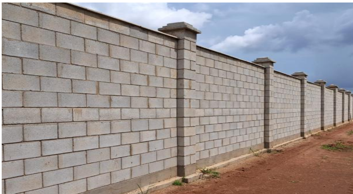
Execução do muro de fechamento – Janeiro 2026
