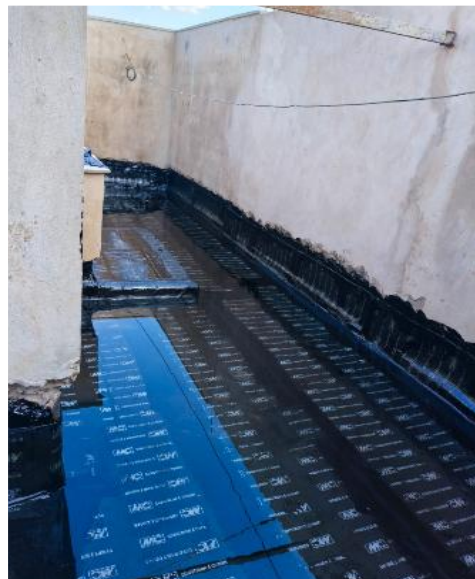
Reboco e impermeabilização da cobertura – Fevereiro 2026
