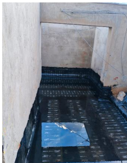
Reboco e impermeabilização da cobertura – Fevereiro 2026
