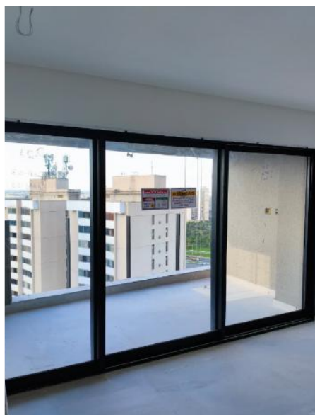
Esquadria de alumínio (janelas e portas) no 27º pavimento – Abril 2026
