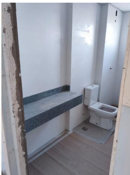
Assentamento de bancada no 33º pavimento – Março 2026
