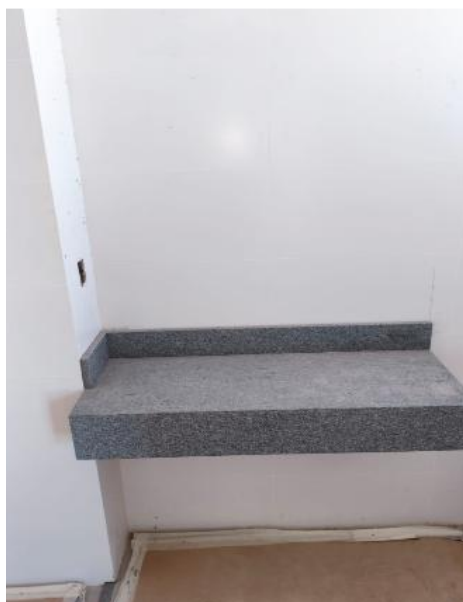
Assentamento de bancada no 33º pavimento – Março 2026
