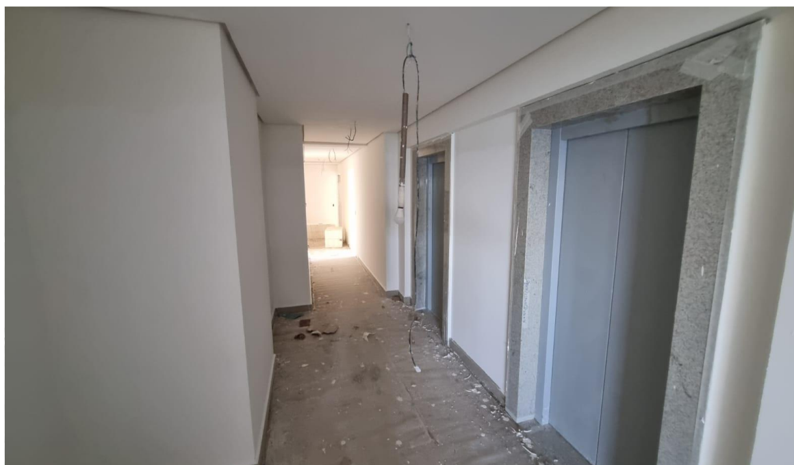
Pintura do hall dos elevadores do 17º pavimento – Junho 2025
