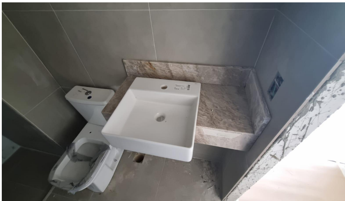
Instalação de bancada de banheiro no 20º pavimento – Maio 2025
