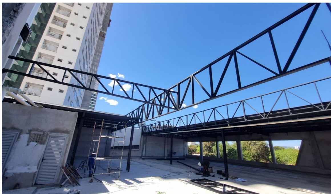
Montagem de estrutura de telhado pavimento garagem G2 – Junho 2025
