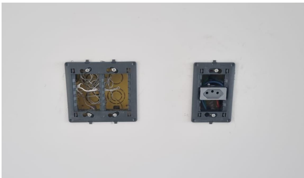
Instalação de tomadas no 18º pavimento – Junho 2025
