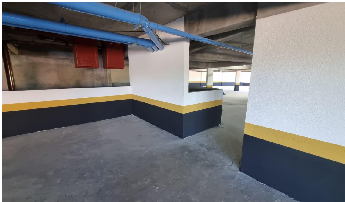
Pintura do pavimento garagem G1 – Maio 2025
