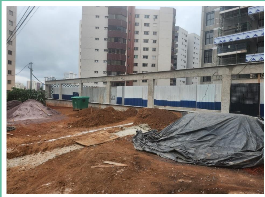
Desmobilização do canteiro – Implantação – Novembro 2024
