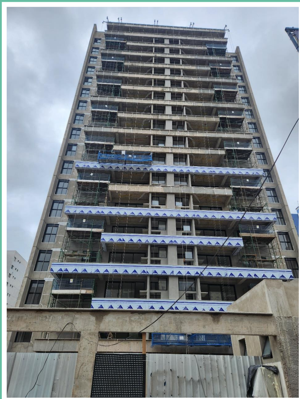
Vista geral da fachada frontal – Novembro 2024
