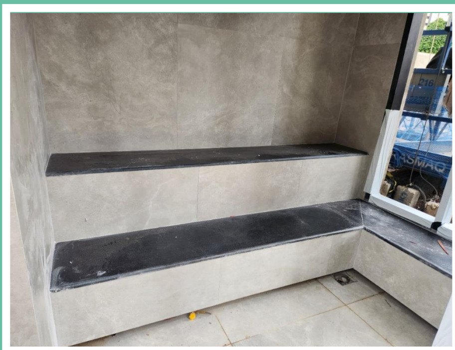
Revestimentos da sauna do pavimento térreo – Novembro 2024
