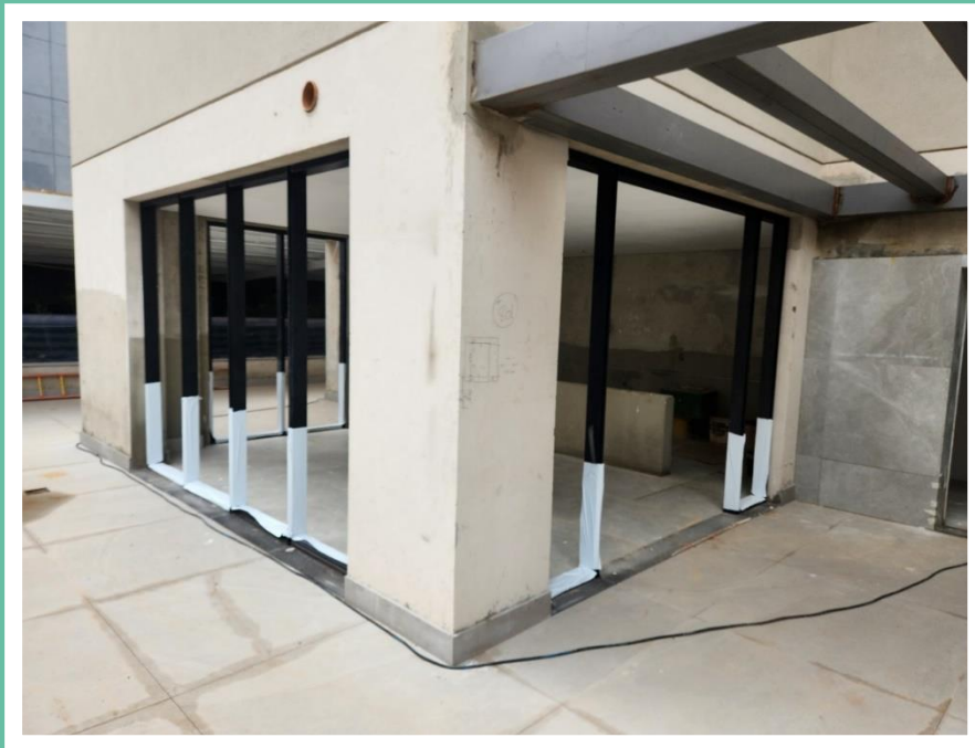
Instalação de esquadrias do pavimento térreo – Novembro 2024
