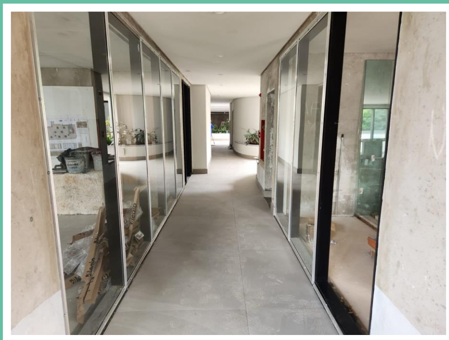
Esquadrias e pintura do pavimento térreo – Dezembro 2024
