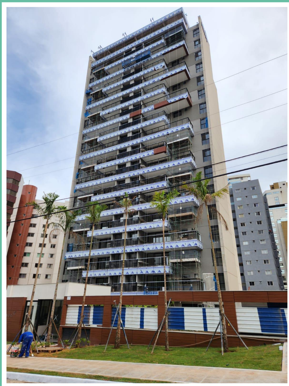
Vista externa da fachada frontal – Dezembro 2024
