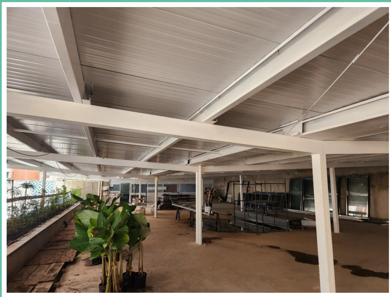
Cobertura metálica das vagas de garagem do pavimento térreo – Novembro 2024
