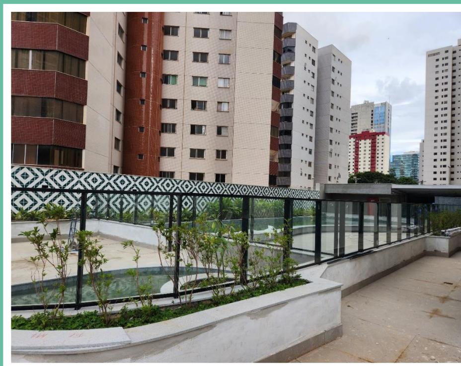
Guarda corpo da região das piscinas do pavimento térreo – Janeiro 2025
