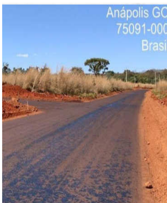
Execução de pavimentação (imprimação) – Julho 2026
