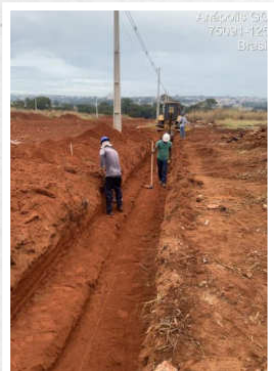
Execução de rede de água e esgoto – Julho 2026
