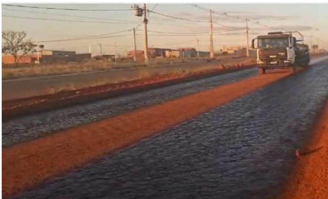
Execução de pavimentação (imprimação) – Julho 2026
