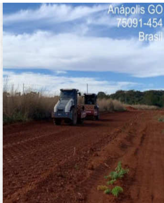
Execução de terraplanagem e pavimentação (base) – Julho 2026
