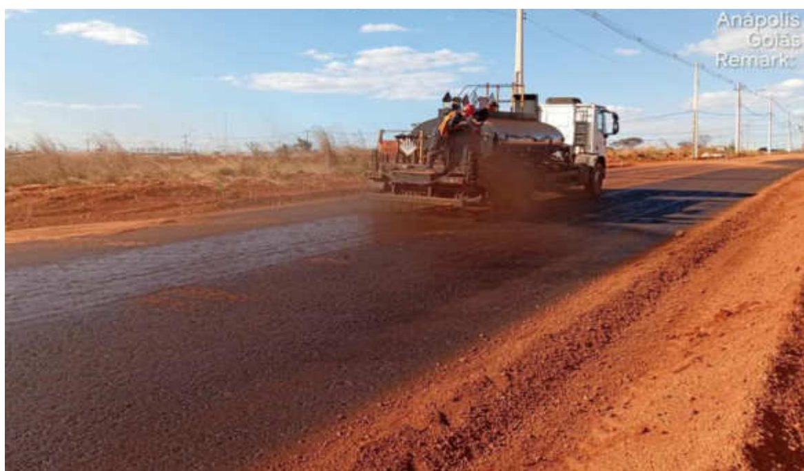
Execução de pavimentação (imprimação) – Julho 2026
