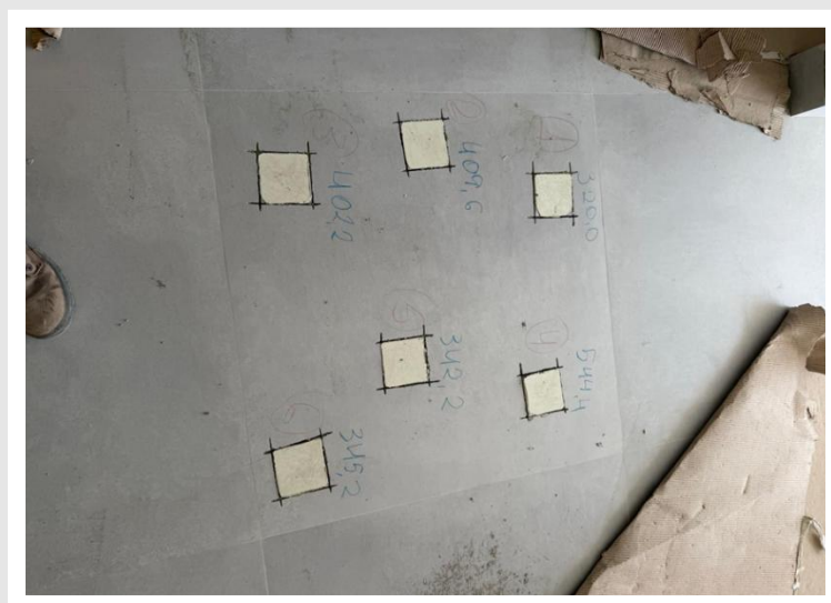
Execução de teste de arrancamento do porcelanato – Fevereiro 2026
