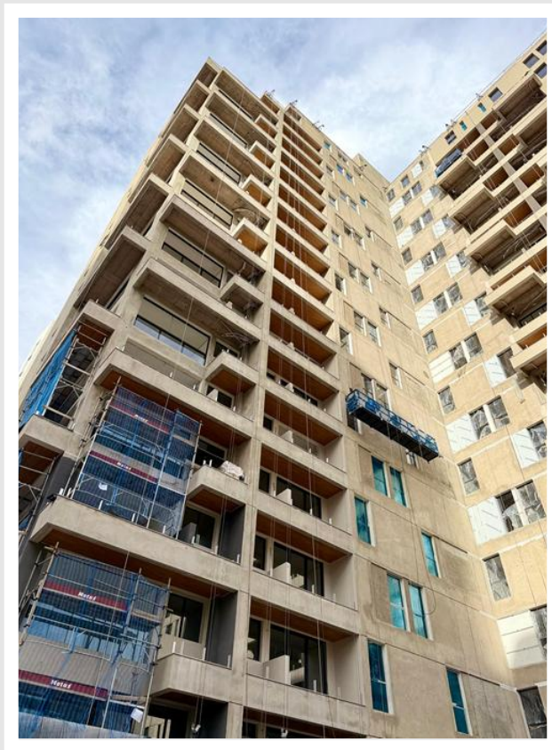
Execução da textura (Cristallini) da fachada e varandas – Fevereiro 2026
