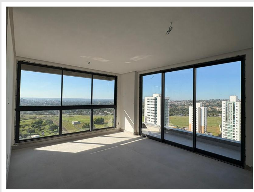
Instalações das esquadrias no 15º pavimento – Março 2026
