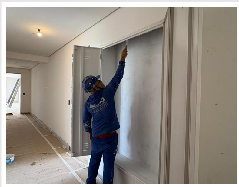
Regularização das caixas de inspeção – Fevereiro 2026
