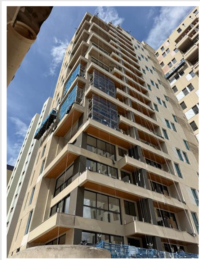
Execução da textura (Cristallini) da fachada varandas – Março 2026
