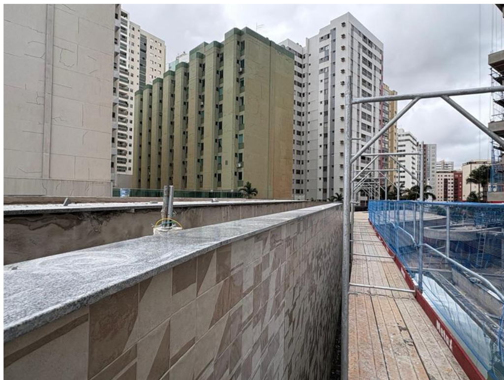
Execução de instalação dos peitoris e do revestimento cerâmico da parede da área de lazer – Fevereiro 2026
