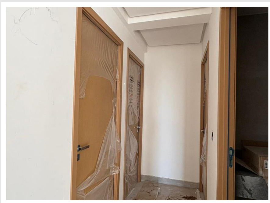
Instalação das portas no 15º pavimento das unidades tipos – Março 2026
