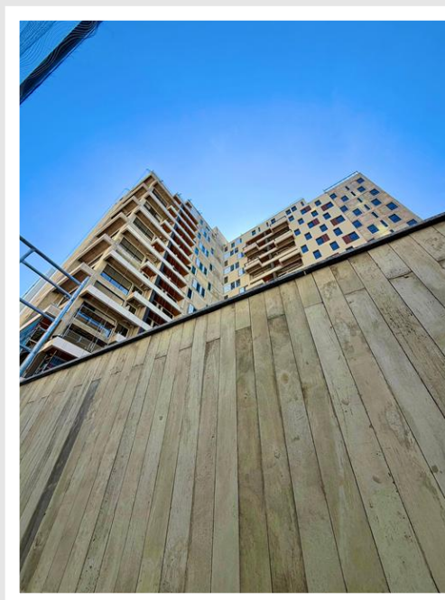
Execução da textura (Cristallini) da fachada, varandas e revestimento da fachada das lojas – Fevereiro 2026
