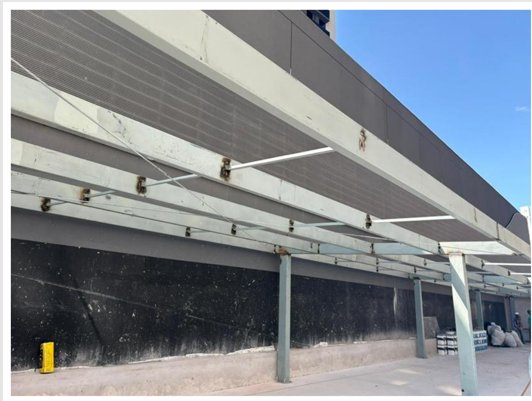
Execução da estrutura da cobertura metálica do estacionamento do térreo – Março 2026
