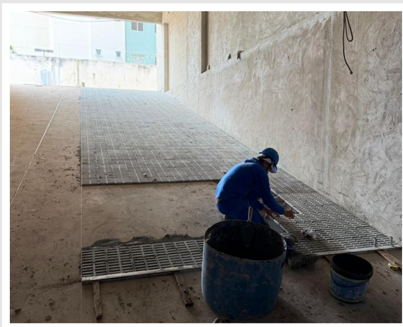
Execução do ladrilho hidráulico (rampa das garagens) – Fevereiro 2026
