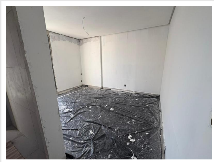
Emassamento do 16º ao 18º pavimento – Fevereiro 2026
