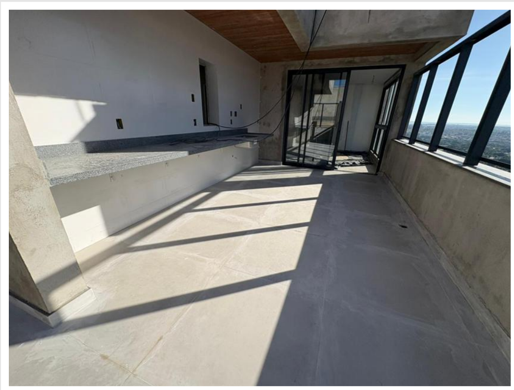
Execução de rejunte nas áreas externas das unidades Penthouse – Março 2026
