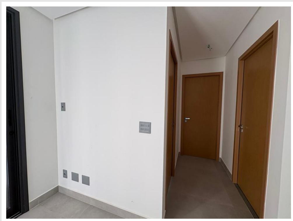
Execução de instalação dos espelhos das tomadas no 4º pavimento – Abril 2026
