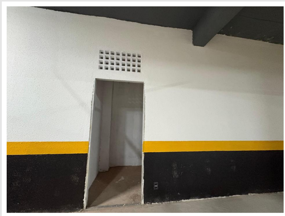
Execução da pintura dos subsolos – Abril 2026
