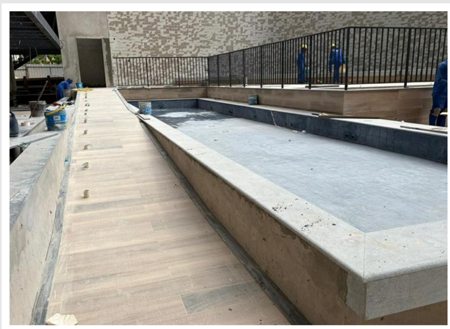
Execução de revestimento cerâmico do térreo – Abril 2026
