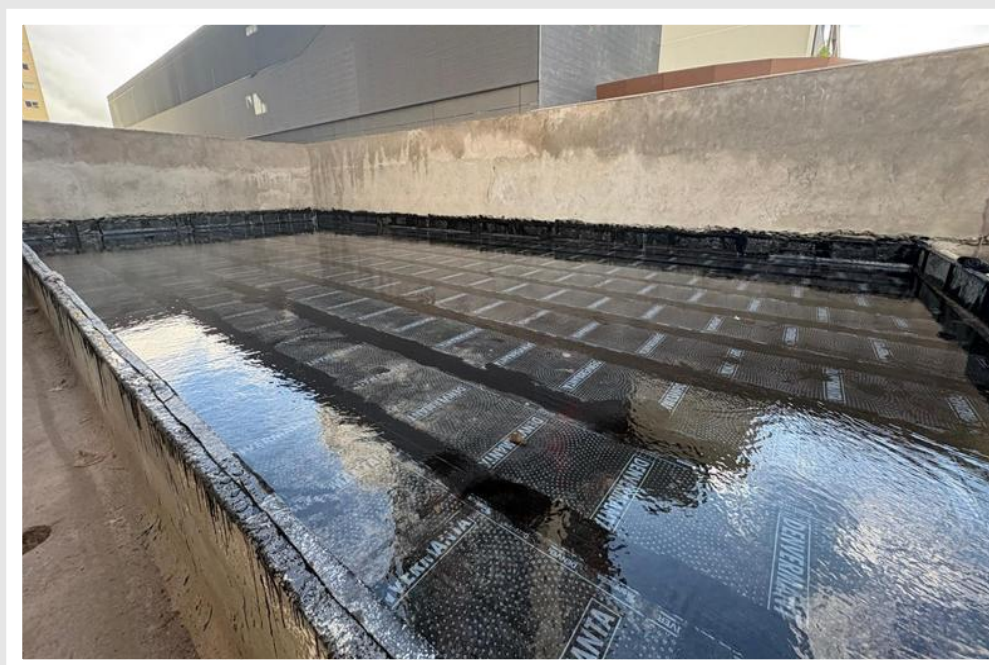
Impermeabilização da quadra de Beach Tennis – Março 2026
