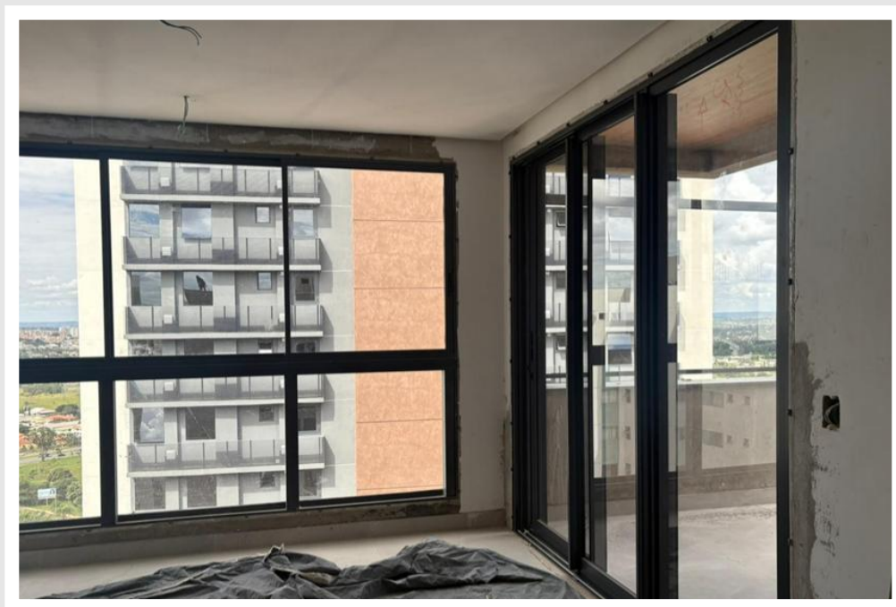
Execução de instalação das esquadrias do 18º pavimento – Abril 2026
