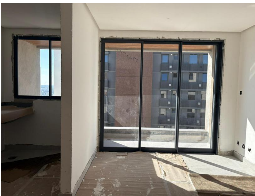
Instalações das esquadrias no 15º pavimento – Março 2026
