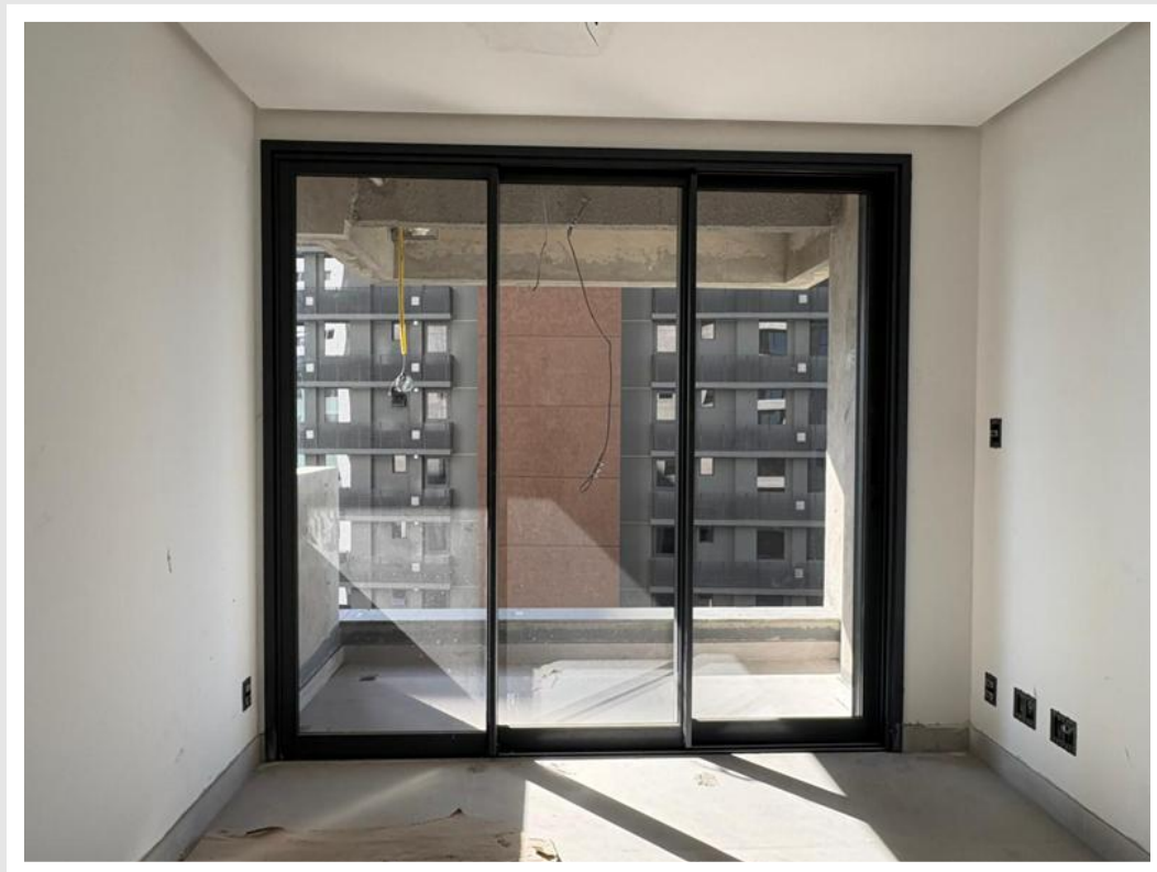
Instalação dos arremates das esquadrias de alumínio do 3º pavimento – Março 2026
