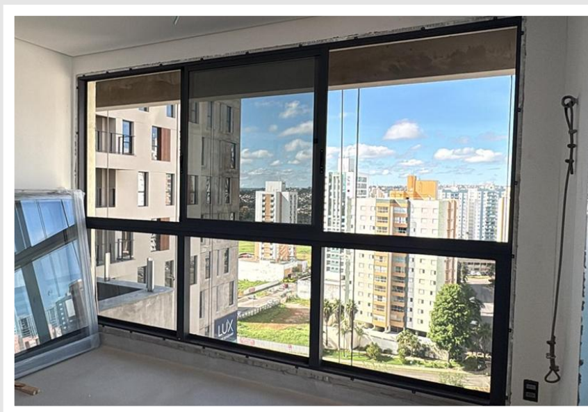
Execução de instalação das esquadrias – Fevereiro 2026
