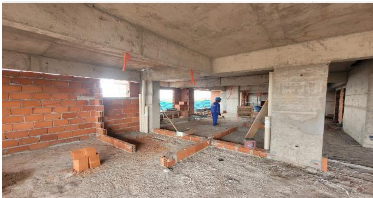
Alvenaria dos pavimentos 6º e 7º da Torre Lago – Outubro 2025
