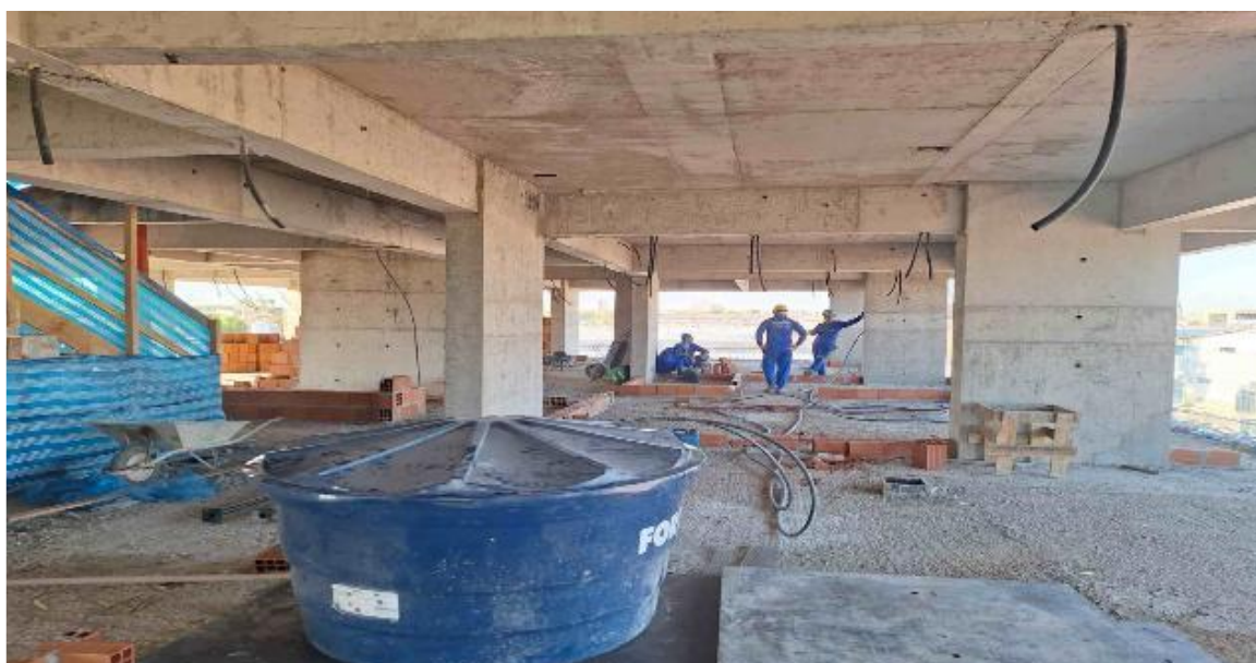
Marcação e elevação de alvenaria do 4º pavimento da Torre Lago – Agosto 2025
