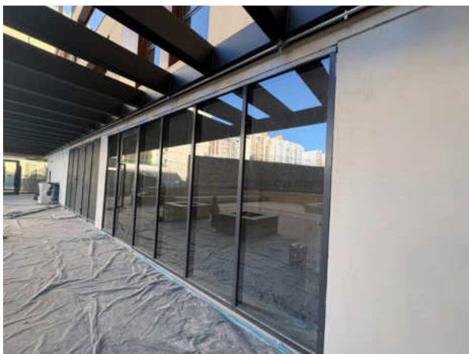
Instalação das esquadrias de alumínio e vidros do térreo – Junho 2026
