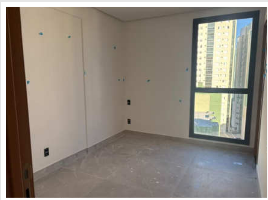
Execução de pintura final nos pavimentos 9º ao 11º – Junho 2026
