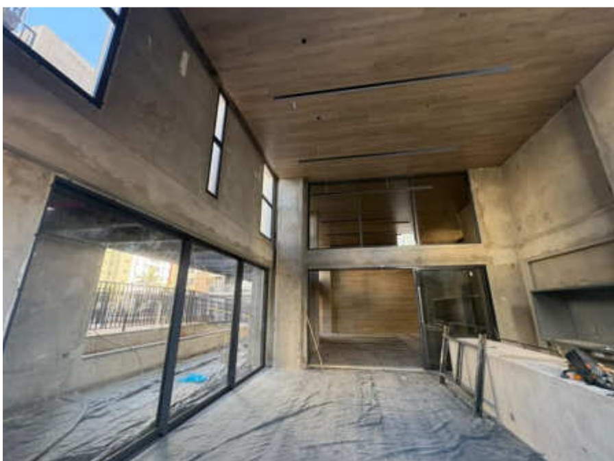
Instalação das esquadrias de alumínio, vidros e do forro vinílico do Gourmet Family – Junho 2026
