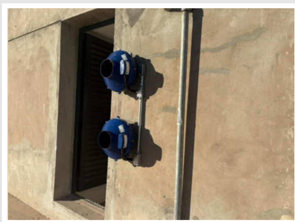
Finalização das instalações da exaustão dos banheiros e lixeiras (cobertura) – Julho 2026
