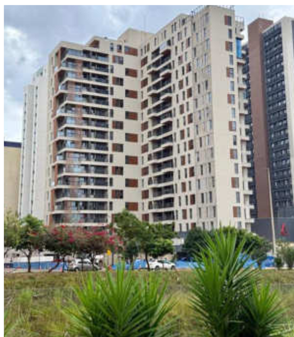
Execução da fachada – Junho 2026
