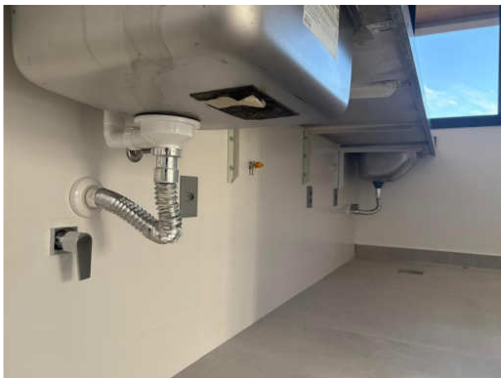
Instalação dos metais no 6º, 7º e 8º pavimento – Maio 2026
