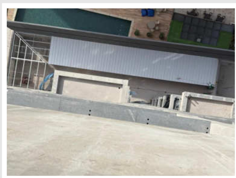
Instalação da telha metálica termoacústica do estacionamento do térreo – Maio 2026
