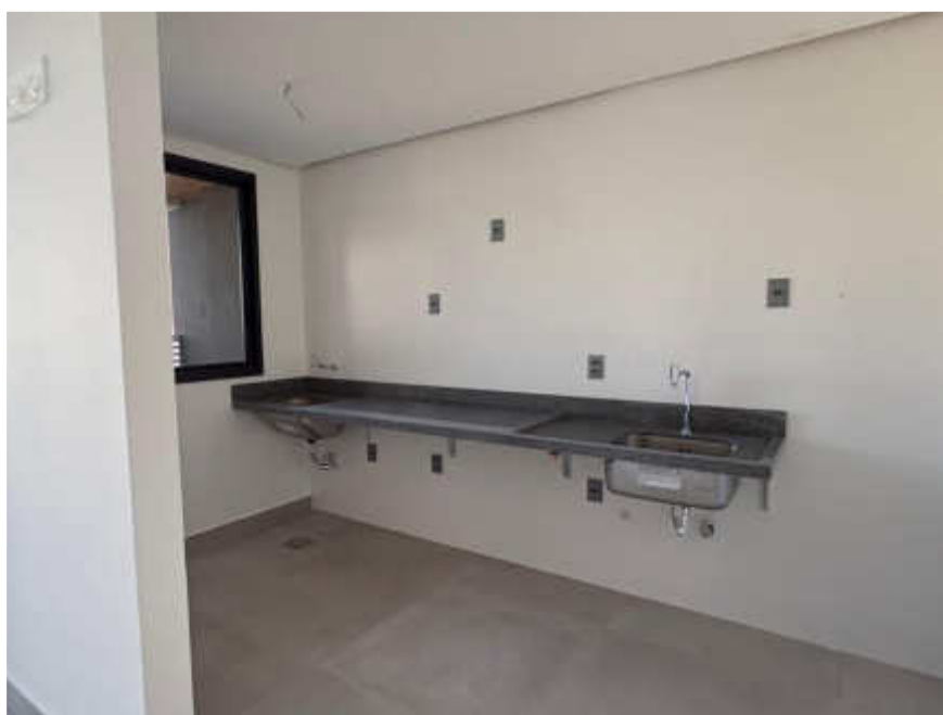
Execução de limpeza dos apartamentos do 5º ao 7º pavimento – Maio 2026
