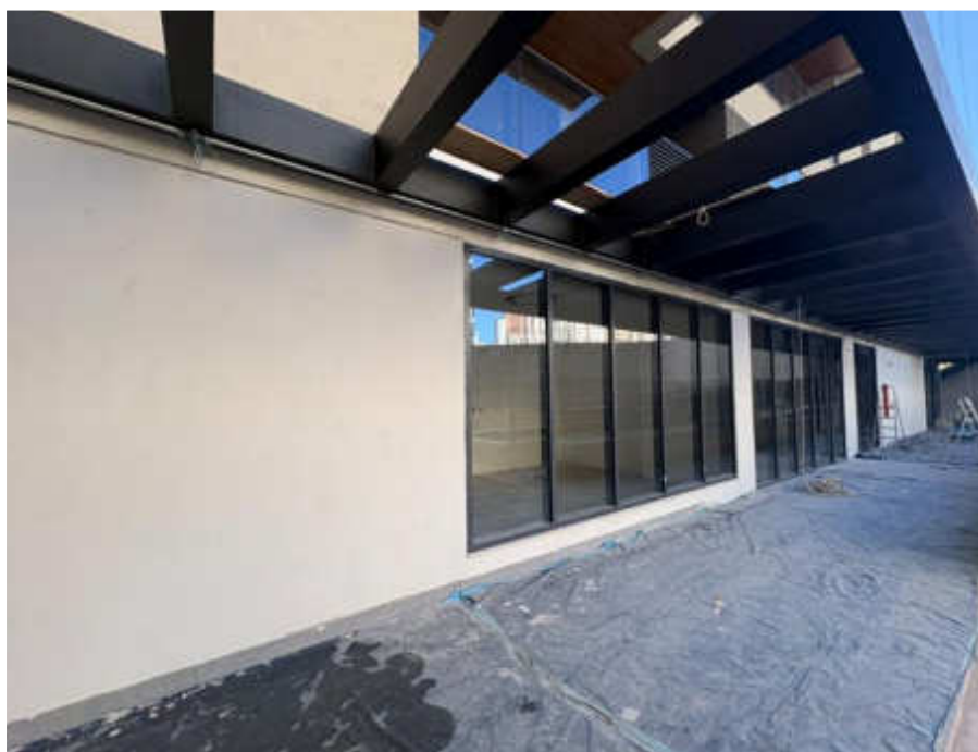
Instalação das esquadrias de alumínio e vidros do térreo – Junho 2026
