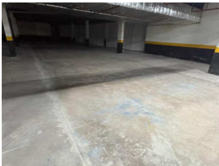
Limpeza e início das demarcações das vagas do subsolo 2 – Julho 2026
