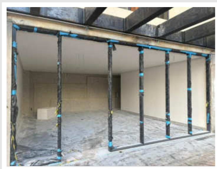
Instalação das esquadrias de alumínio do térreo – Maio 2026
