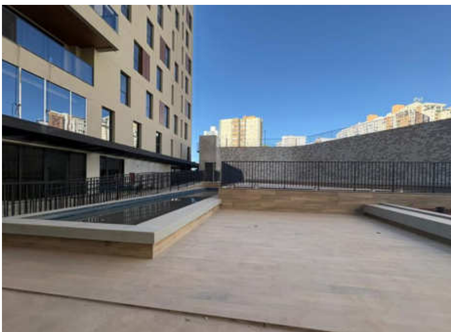
Finalização dos guarda-corpos metálicos do térreo – Junho 2026
