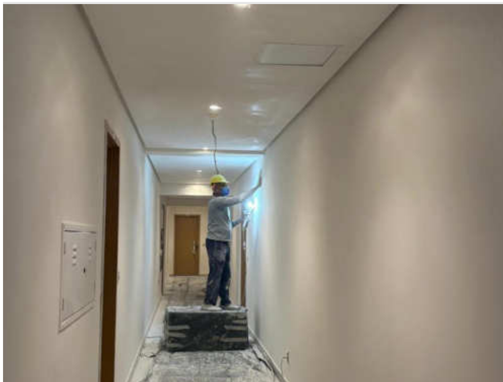
Execução de pintura final do hall do 1º pavimento – Maio 2026
