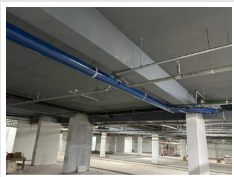
Pintura das tubulações do 2º Subsolo – Maio 2026
