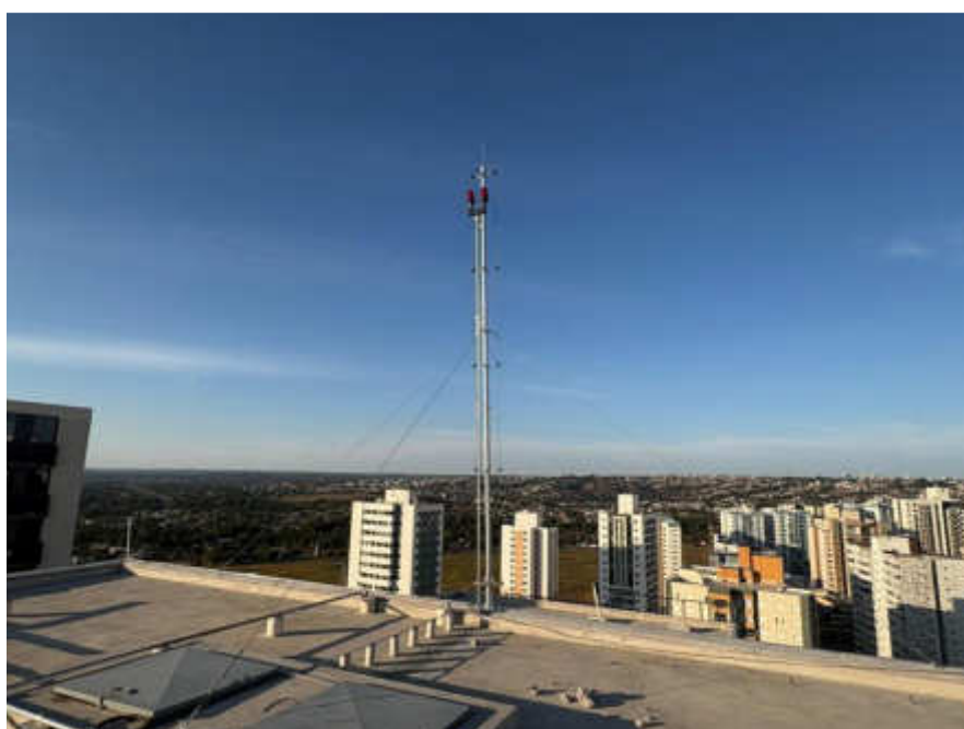
Instalação da luz piloto e haste Franklin (sistema de proteção contra descarga atmosférica) na cobertura – Maio 2026
