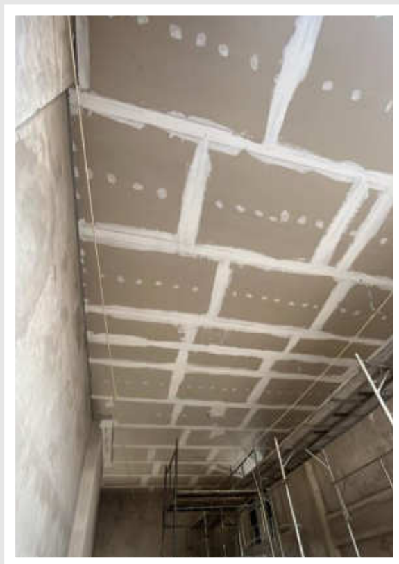
Execução do forro do Fitness Indoor – Maio 2026
