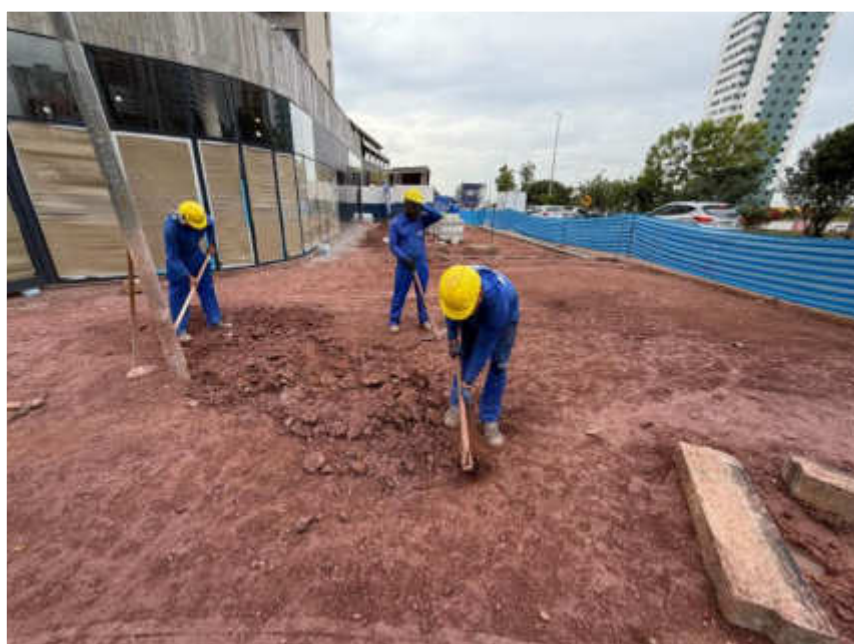
Execução de regularização terraplanagem para receber calçada e estacionamento externos – Junho 2026
