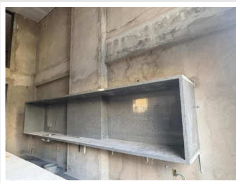
Execução da instalação de peças em granito do Gourmet Family – Maio 2026
