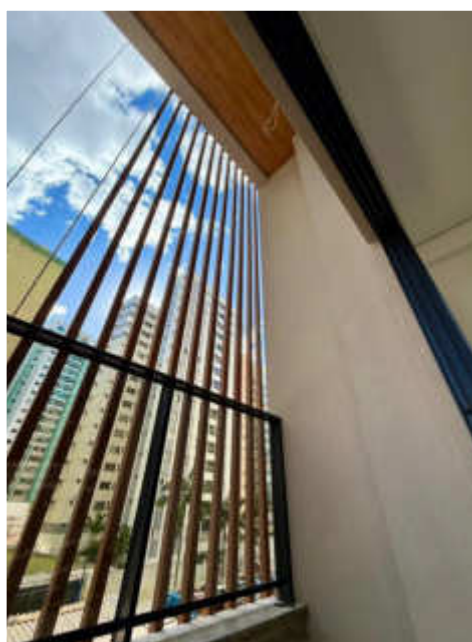
Instalações dos Brises da fachada – Maio 2026
