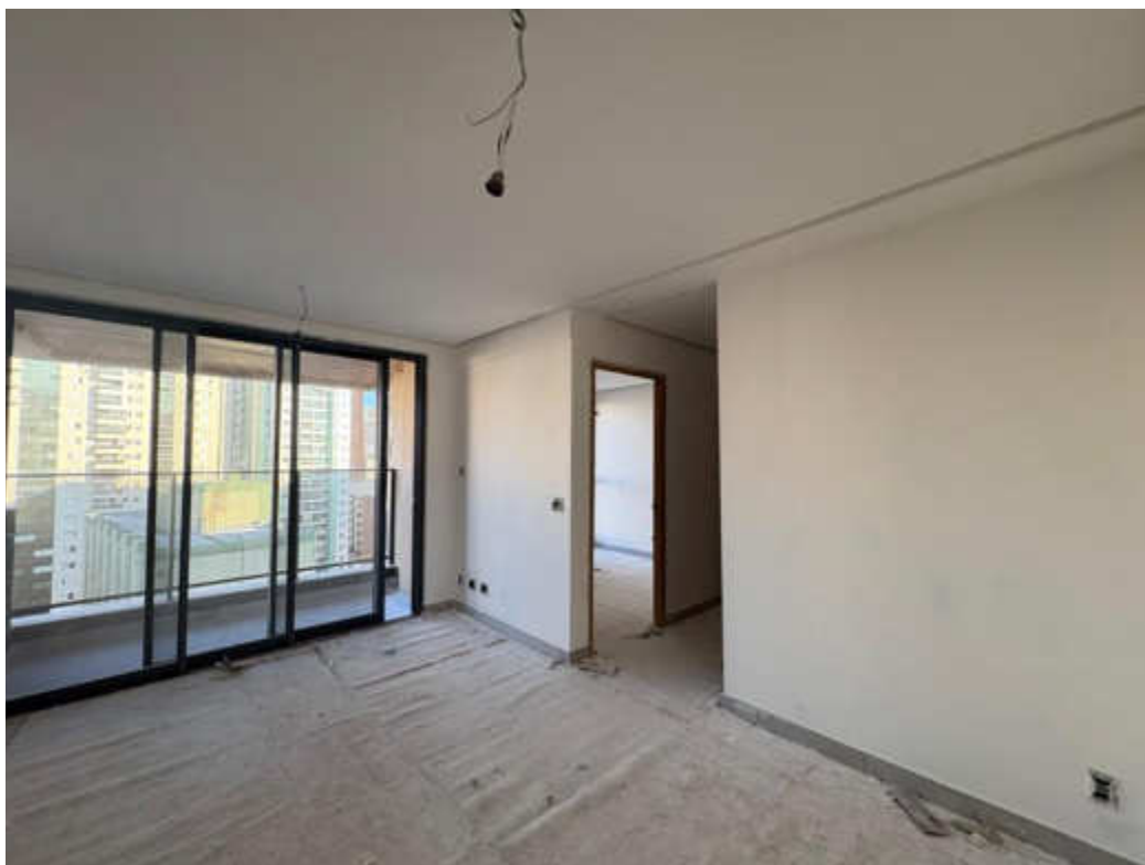
Execução de pintura final do 8º pavimento – Maio 2026
