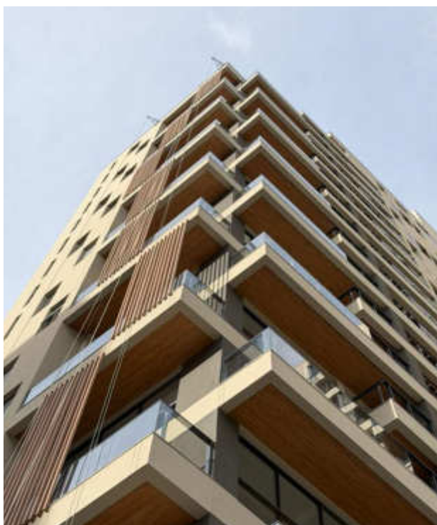
Execução do forro vinílico – Maio 2026
