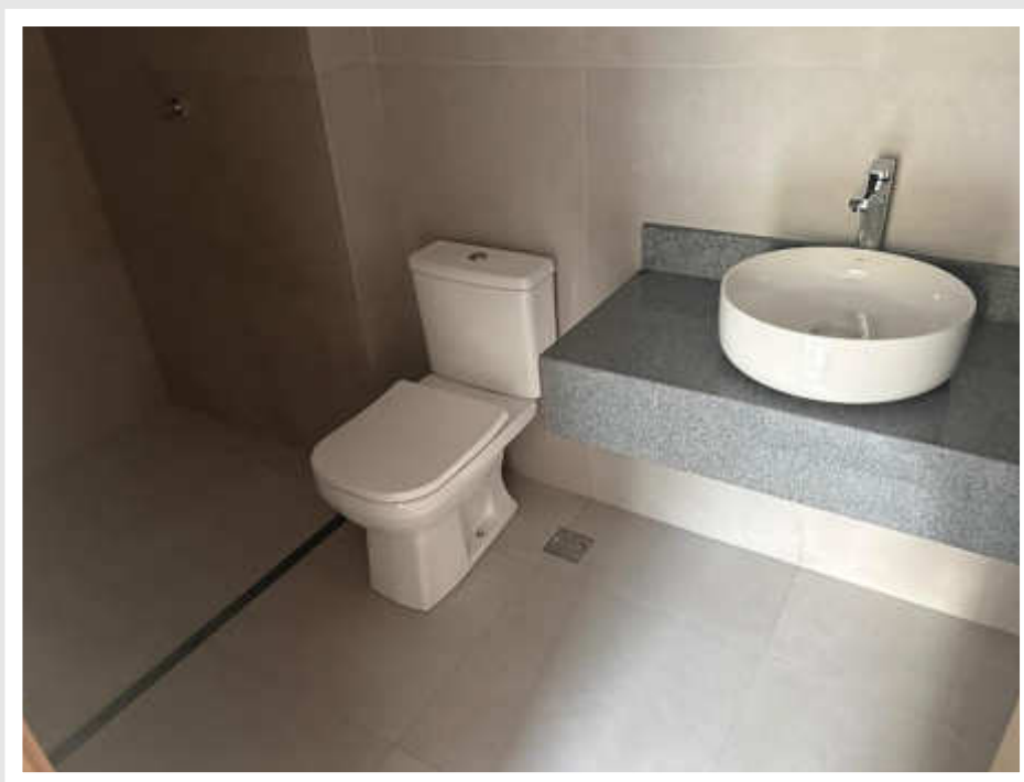
Limpeza dos apartamentos 5º ao 11º pavimento – Junho 2026
