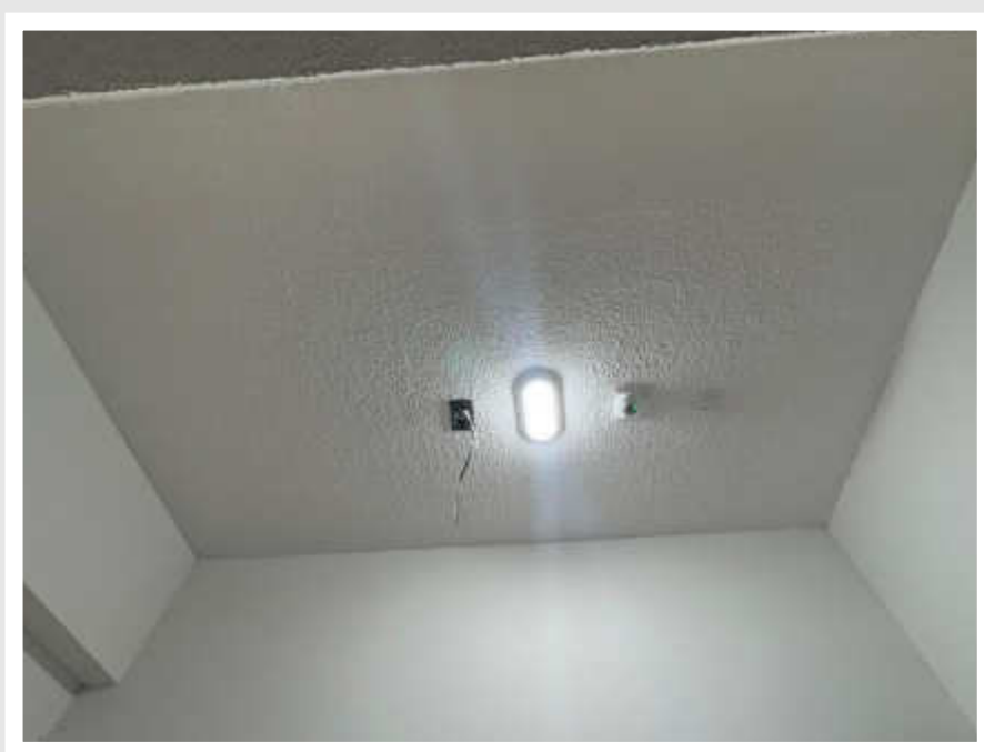
Execução das luminárias das escadas – Maio 2026
