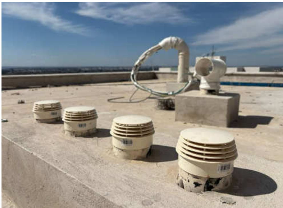
Instalação dos acabamentos das prumadas de ventilação – Maio 2026
