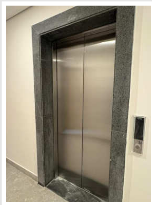
Execução de limpeza do elevador social 01 – Junho 2026
