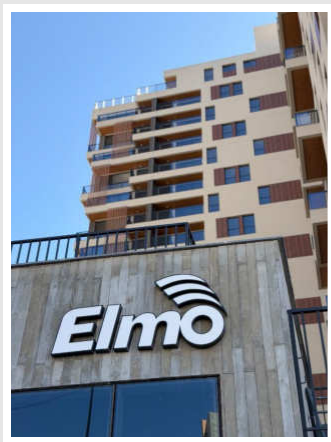
Execução da fachada (lojas e torre) – Julho 2026
