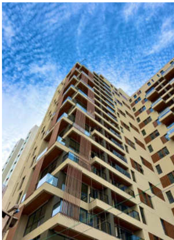
Instalações dos Brises da fachada – Maio 2026
