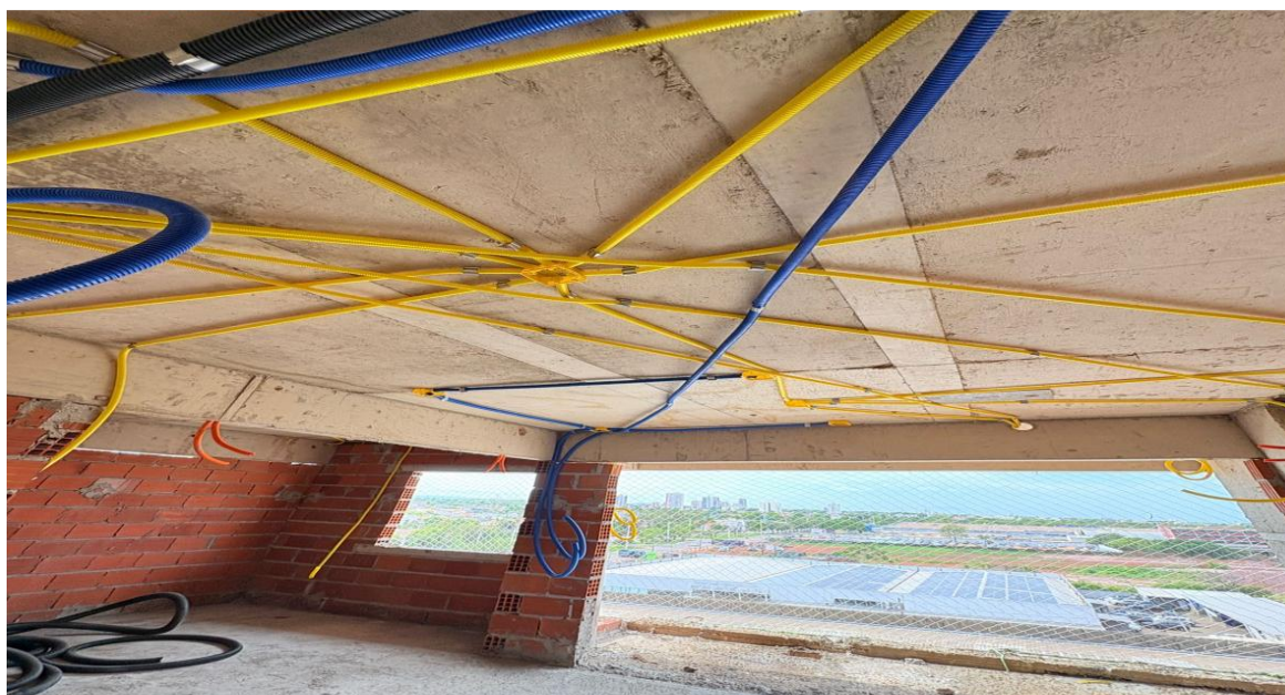
Instalações elétricas de teto e parede do 5º, 6º e 7º pavimento da Torre Lago – Novembro 2025
