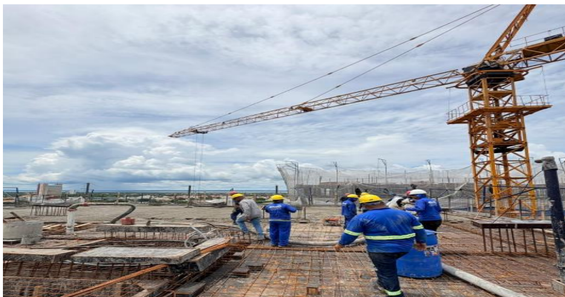
Estrutura do 14º pavimento da Torre Parque – Dezembro 2025
