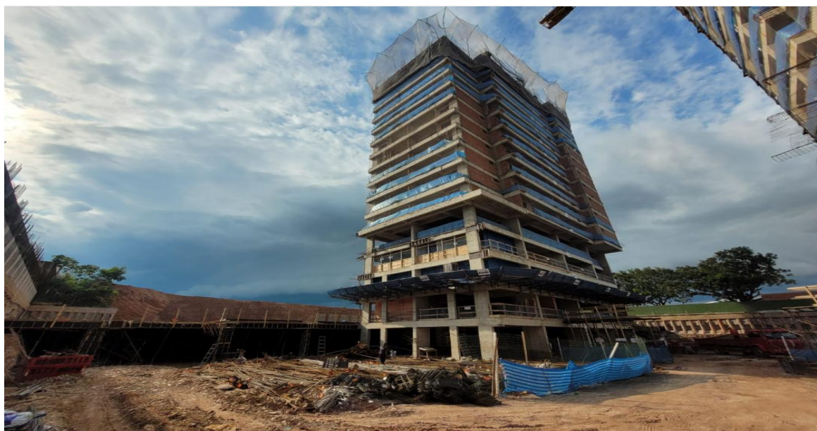
Estrutura do 15º pavimento da Torre Lago – Novembro 2025
