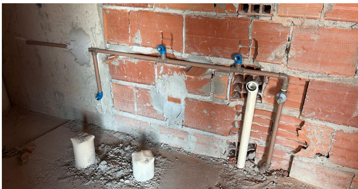
Instalações hidráulicas do 5º e 6º pavimento da Torre Lago – Novembro 2025
