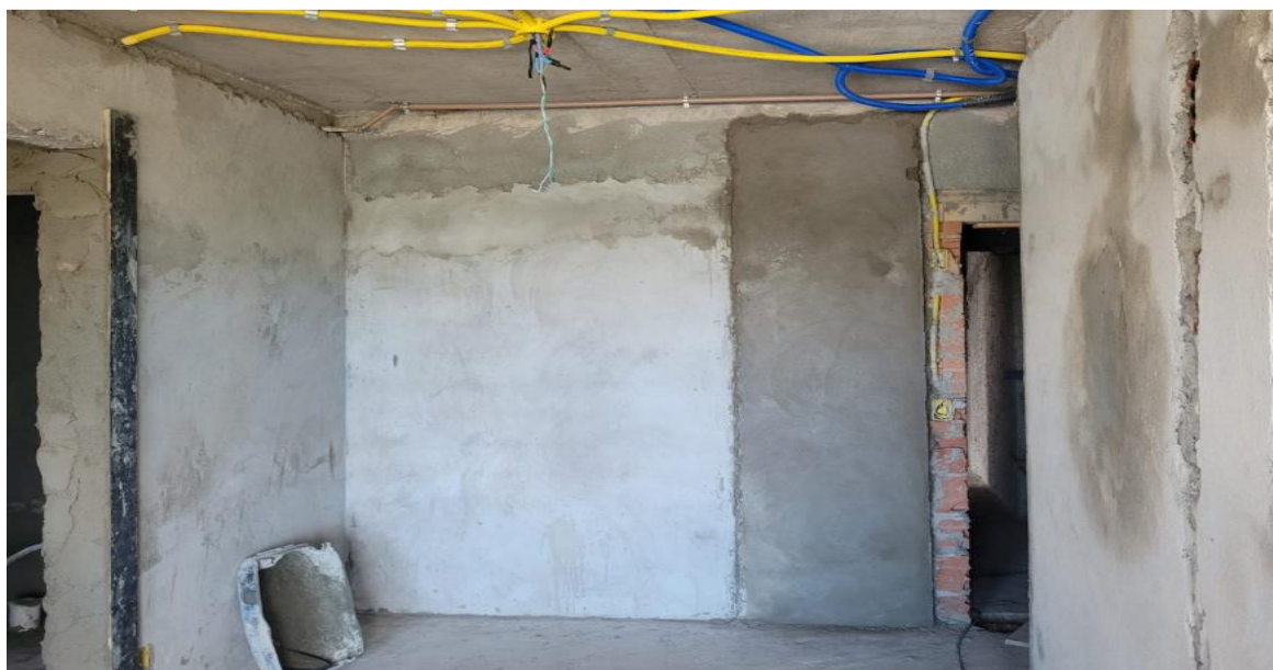
Reboco 4º, 5º e 6º pavimento da Torre Lago – Janeiro 2026
