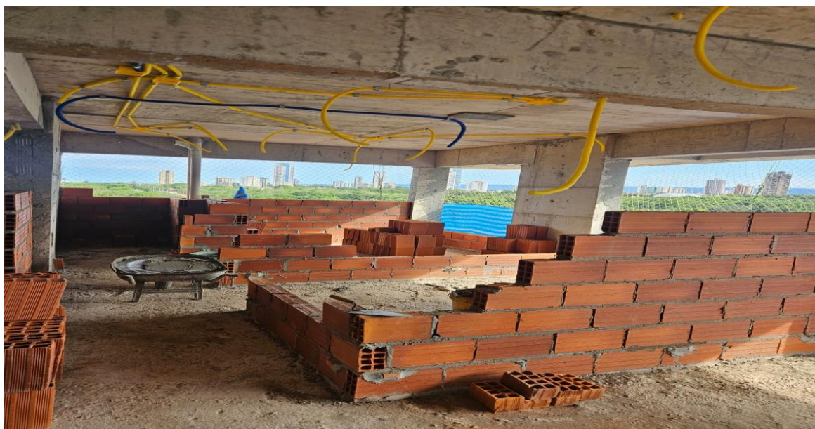
Alvenaria do 5° pavimento da Torre Parque – Dezembro 2025
