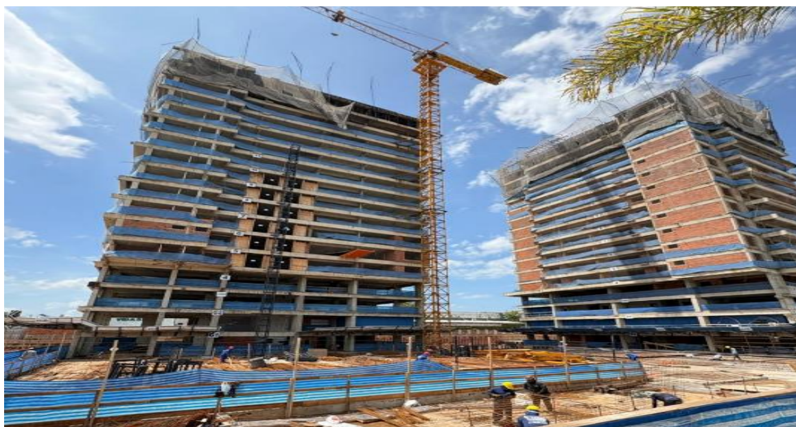
Estrutura do 17º pavimento da Torre Parque – Janeiro 2026
