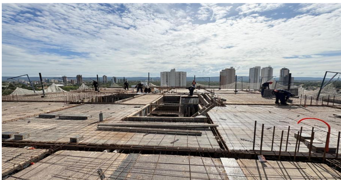
Estrutura do 16º pavimento da Torre Lago – Dezembro 2025
