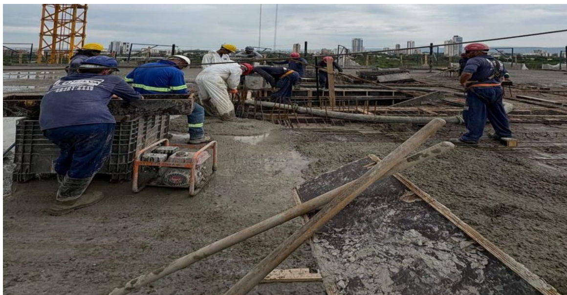
Estrutura do 10º pavimento da Torre Parque – Novembro 2025
