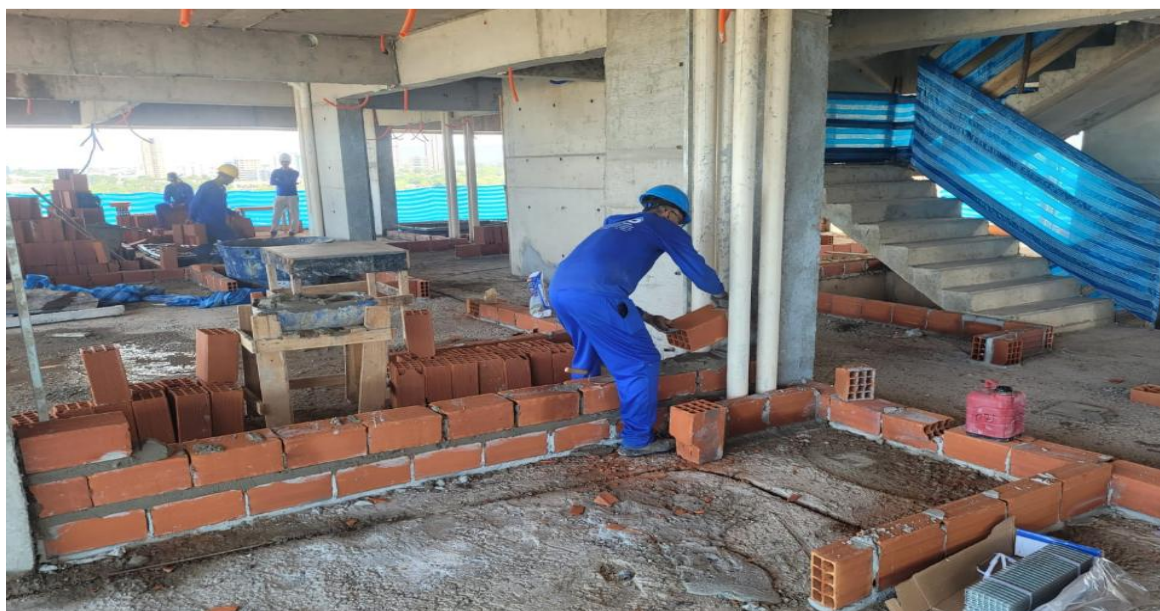
Alvenaria 12º e 13º pavimento da Torre Lago – Janeiro 2026
