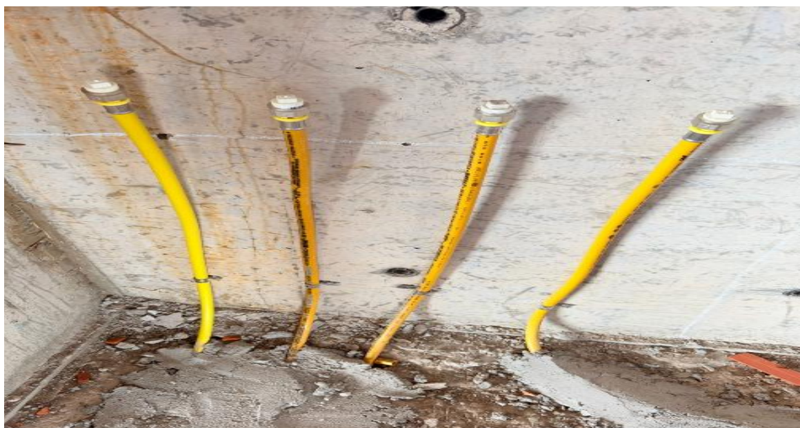
Instalações especiais até o 11º pavimento da Torre Lago – Dezembro 2025
