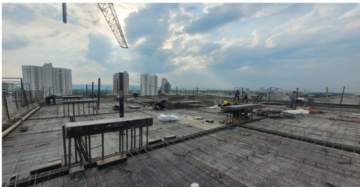
Estrutura do 11º pavimento – Torre Parque – Novembro 2025
