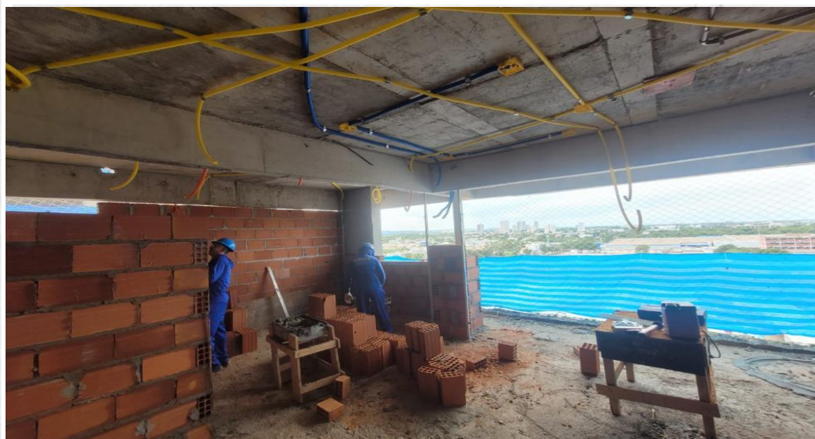
Contrapiso até o 12° pavimento da Torre Lago – Janeiro 2026
