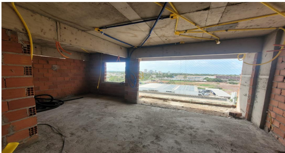
Alvenaria do 8º e 9º pavimento da Torre Lago – Novembro 2025
