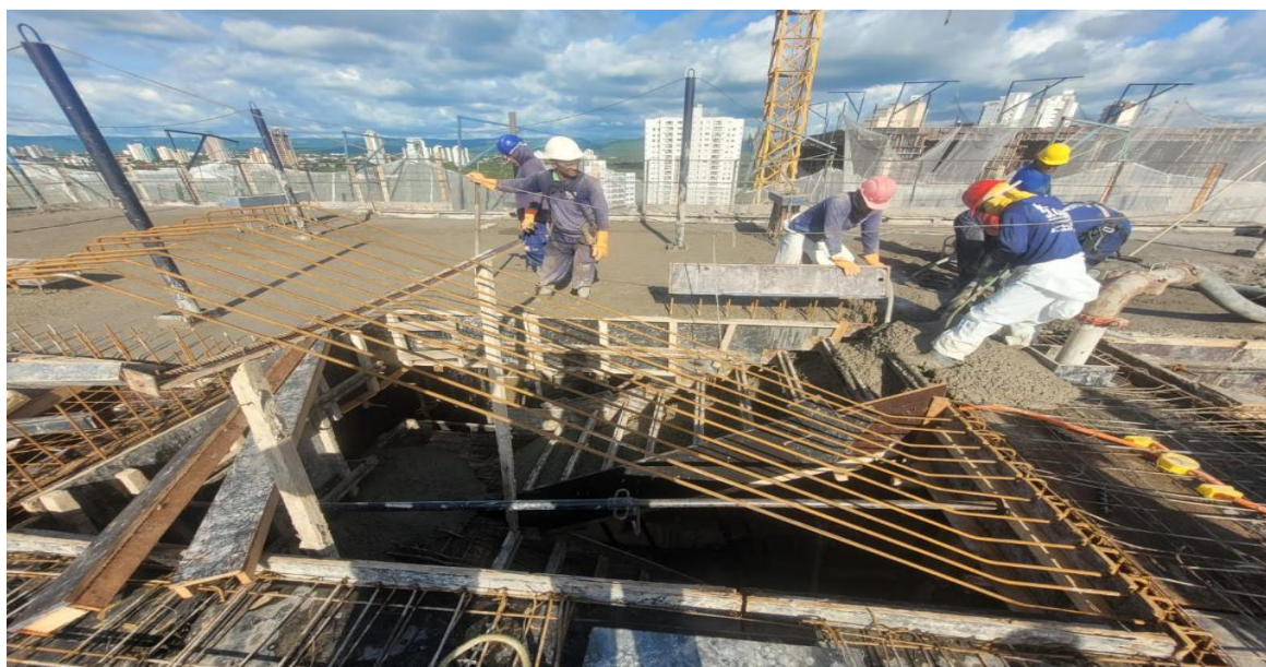
Estrutura do 17° pavimento da Torre Lago – Janeiro 2026
