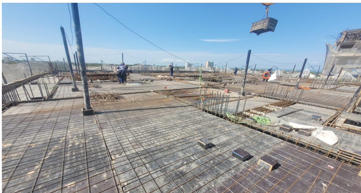
Estrutura do 12º pavimento da Torre Parque – Novembro 2025
