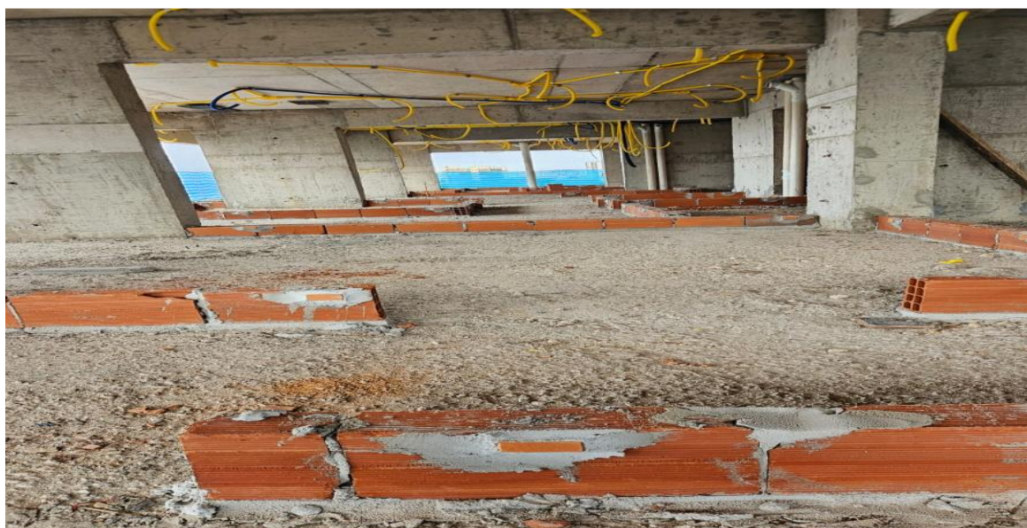
Marcação de alvenaria do 4º e 5º pavimento da Torre Parque - Novembro 2025
