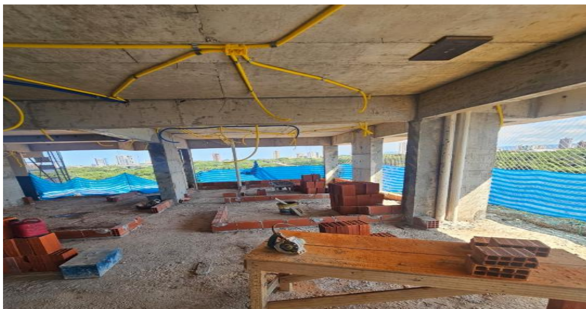
Instalações elétricas de teto e parede 8º e 9º pavimento da Torre Lago – Dezembro 2025
