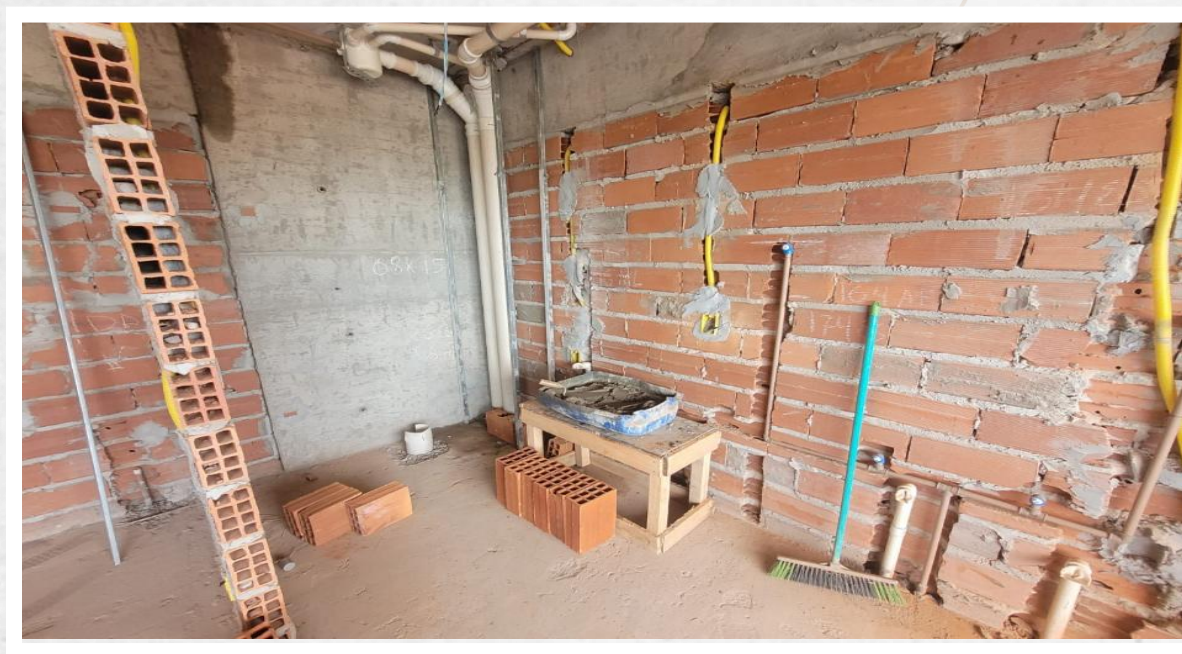
Instalações hidráulicas de teto e parede 4, 5 e 6 pavimento da Torre Lago – Janeiro 2026
