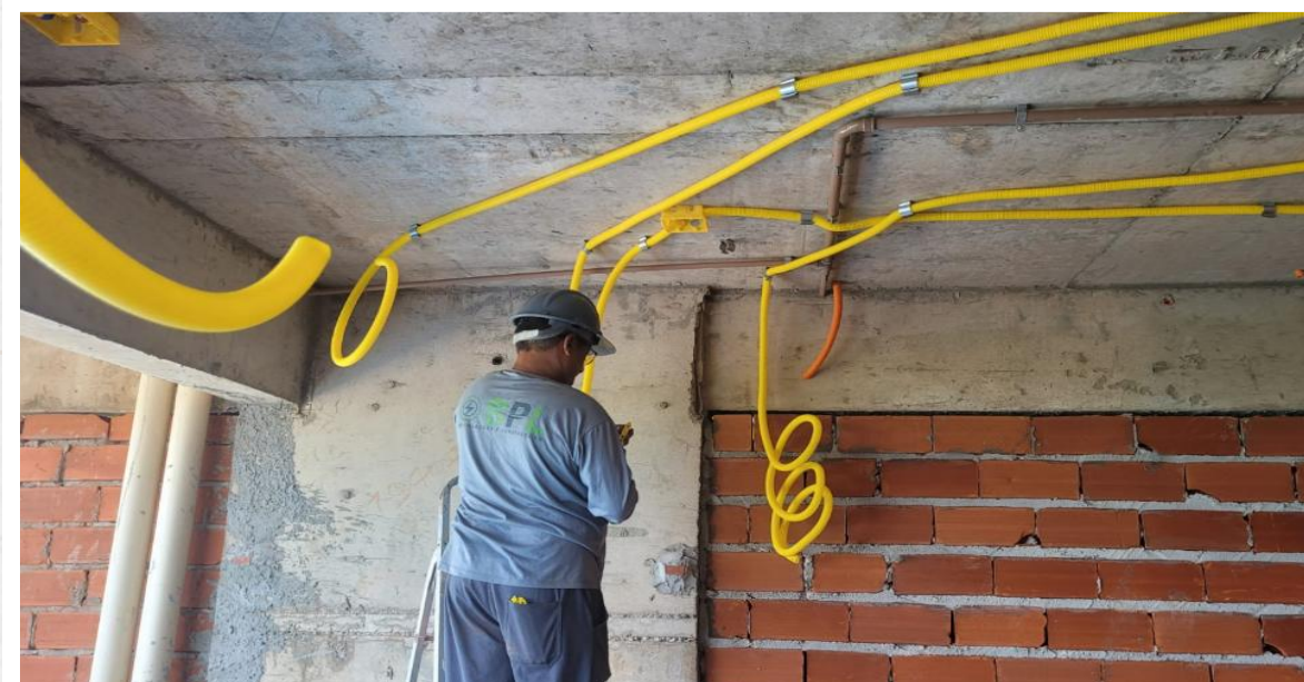
Reboco 4°, 5° e 6° pavimento da Torre Lago – Janeiro 2026
