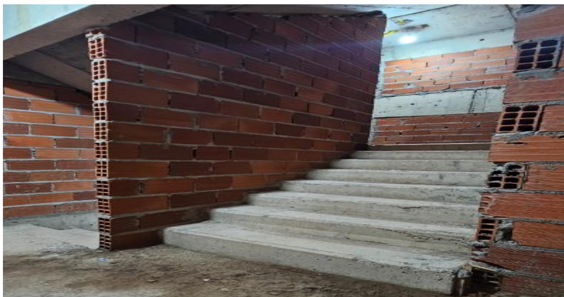
Alvenaria do 10º e 11º pavimento da Torre Lago – Dezembro 2025
