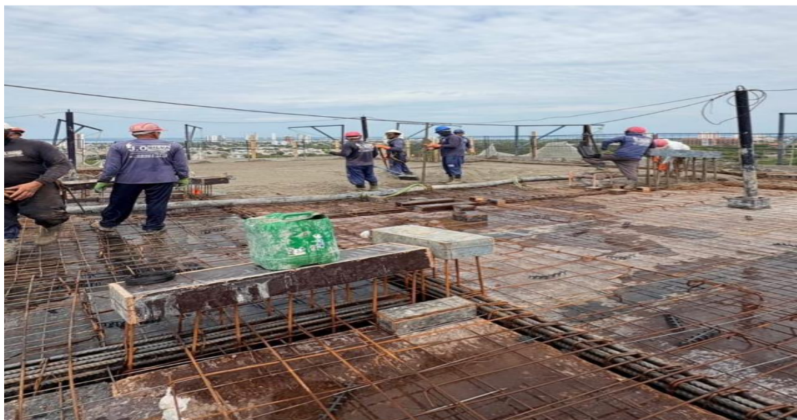
Estrutura do 14º pavimento da Torre Lago – Novembro 2025
