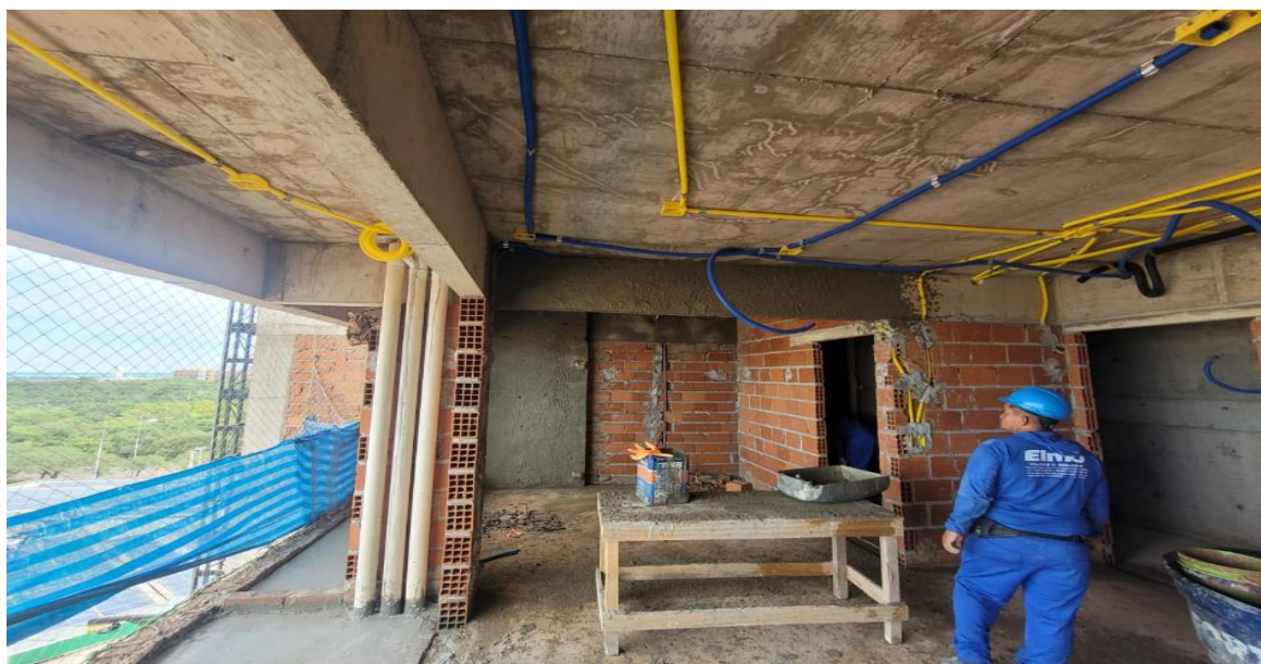
Instalações elétricas de teto e parede do 10º, 11º e 12º pavimento da Torre Lago – Janeiro 2026
