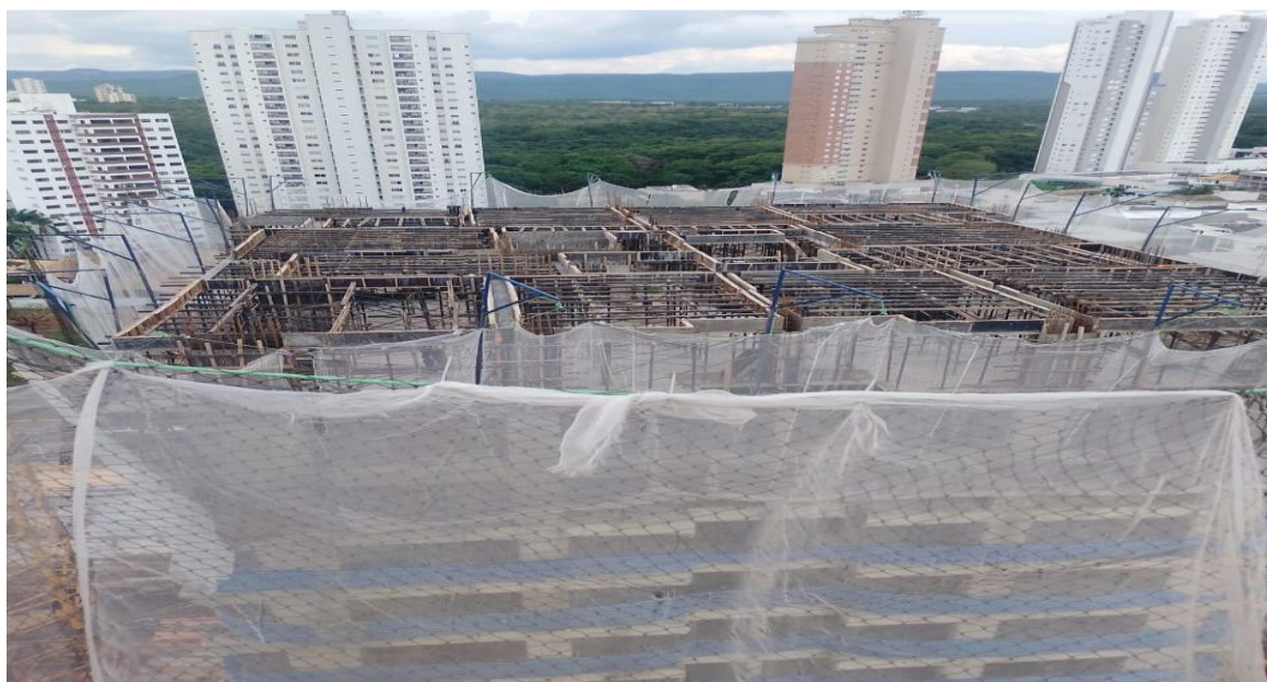
Estrutura do 13º pavimento da Torre Parque – Dezembro 2025
