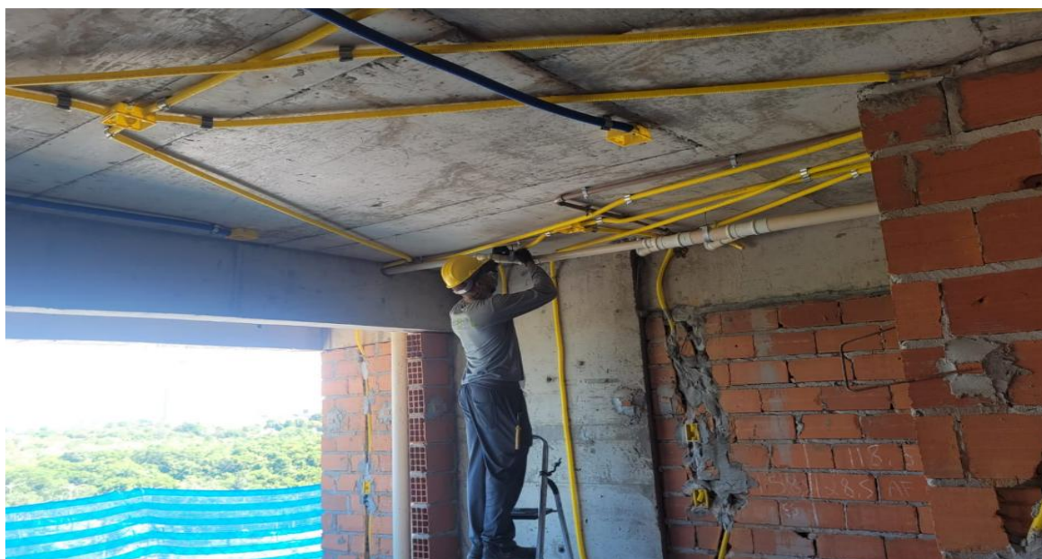
Instalações hidráulicas de teto e parede 6°, 7° e 8° pavimento da Torre Lago – Dezembro 2025
