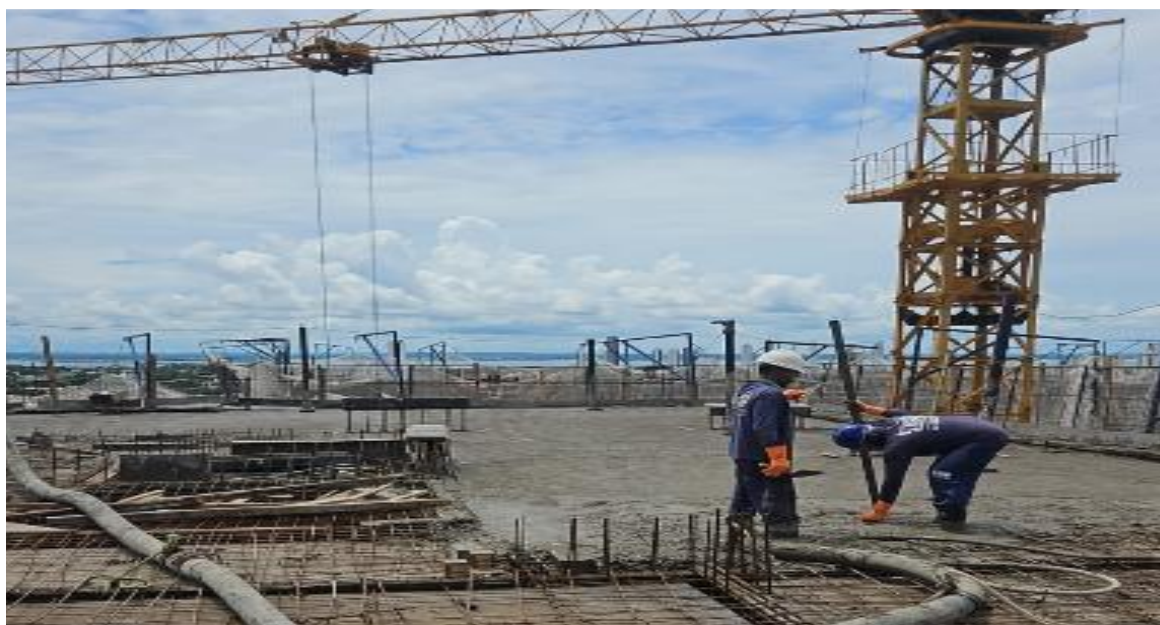
Estrutura do 15° pavimento da Torre Parque – Janeiro 2026
