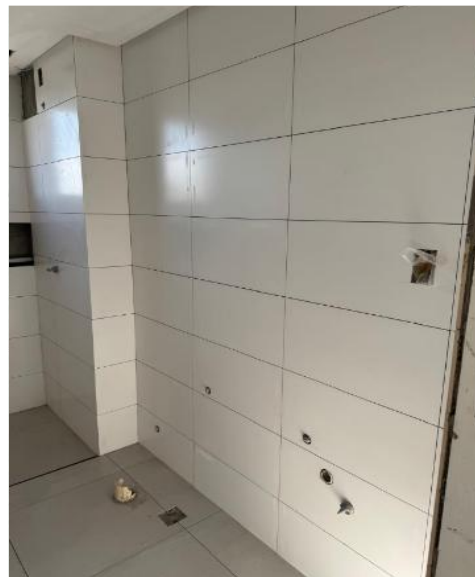
Assentamento de revestimento cerâmico do 32º Pavimento – Janeiro 2026
