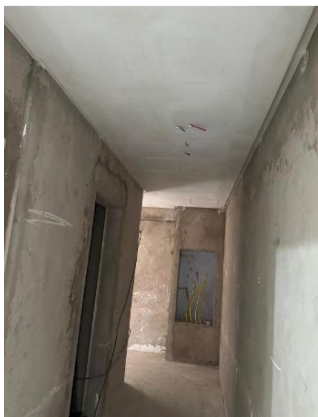
Execução do forro de gesso do 36° pavimento – Dezembro 2025
