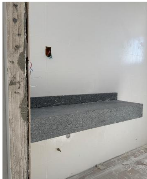
Assentamento de bancada do 16° pavimento – Dezembro 2025
