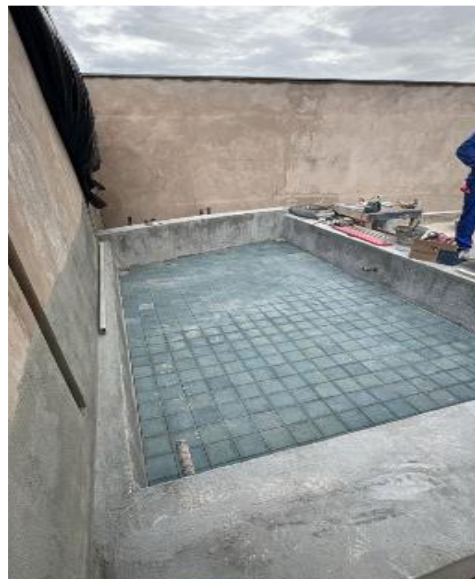
Revestimento e impermeabilização das piscinas do pavimento lazer – Novembro 2025
