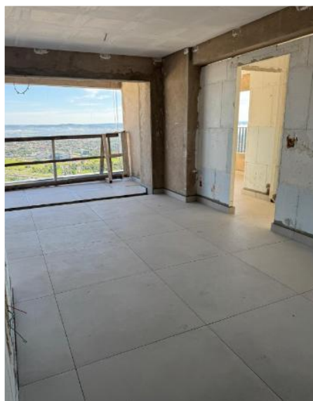
Assentamento de revestimento cerâmico do 32º Pavimento – Janeiro 2026
