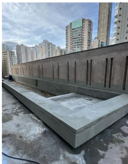
Revestimento e impermeabilização das piscinas do pavimento lazer – Novembro 2025
