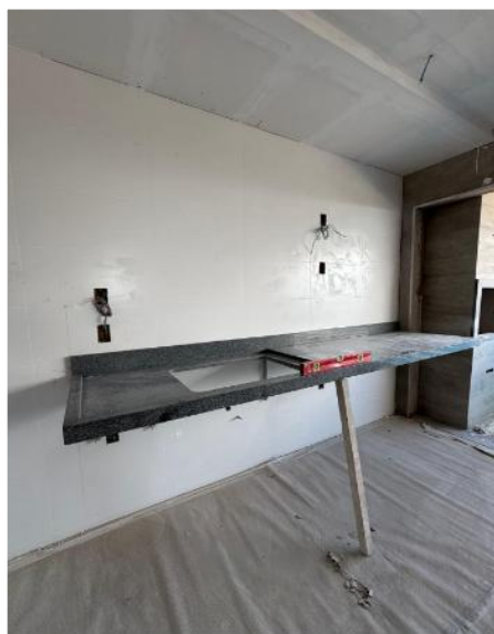
Assentamento de bancada do 16° pavimento – Dezembro 2025
