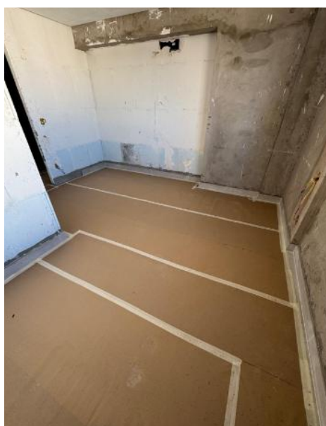
Rejunte e proteção dos revestimentos cerâmicos do 28º pavimento – Janeiro 2026
