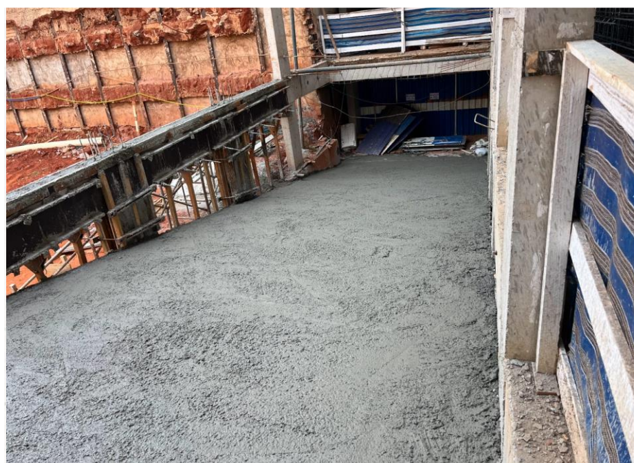
Rampa de acesso (térreo/G1) – Setembro 2024
