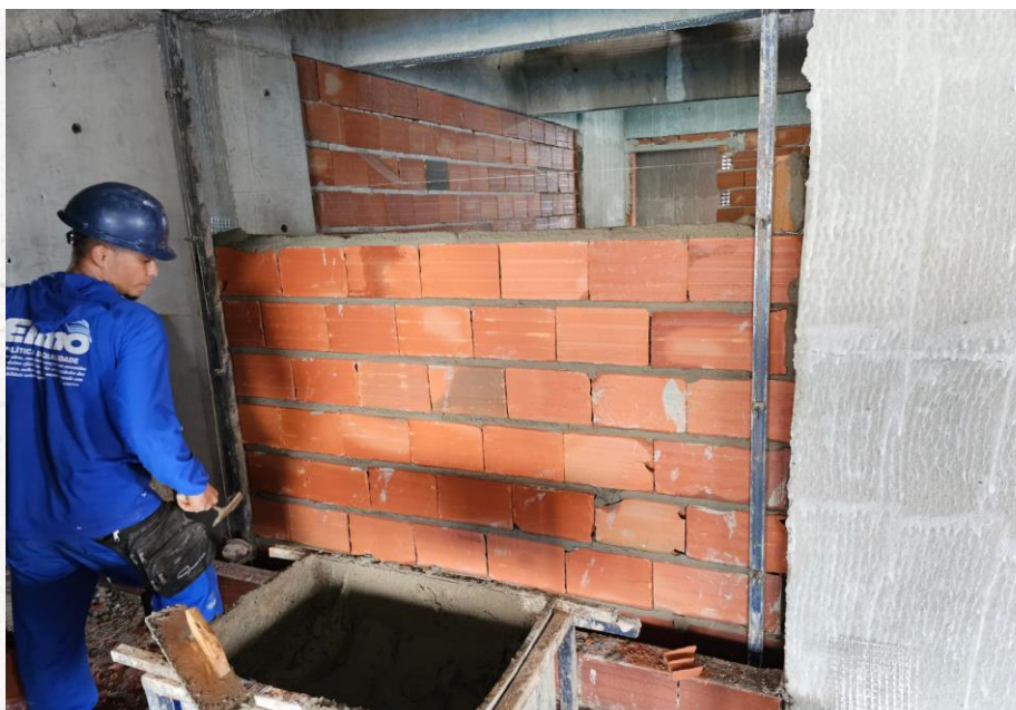
Alvenaria interna e externa do 22º pavimento – Outubro 2024
