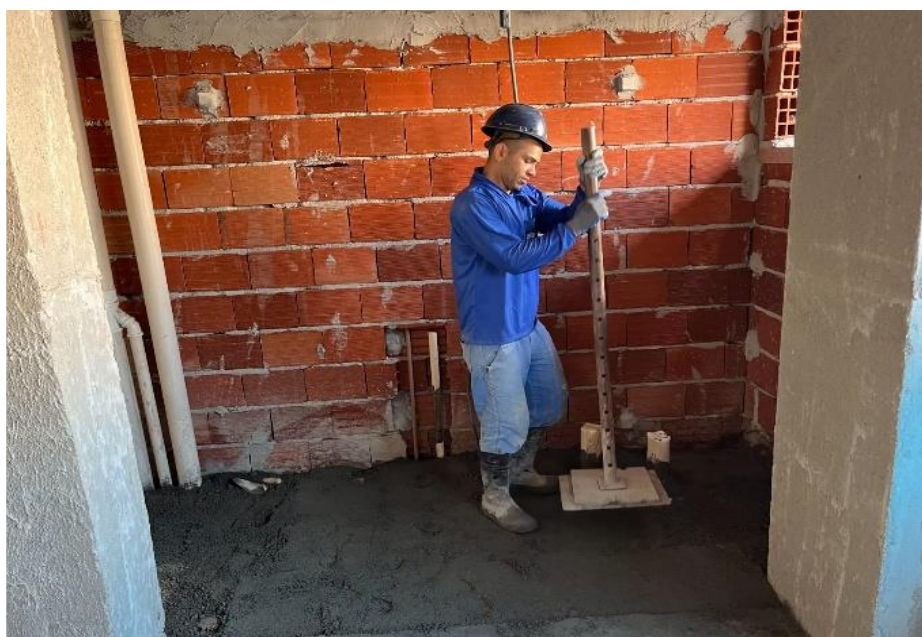
Execução do contrapiso do 6º pavimento – Agosto 2024
