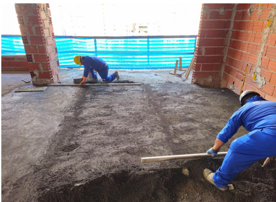
Execução do contrapiso do 14º pavimento – Outubro 2024
