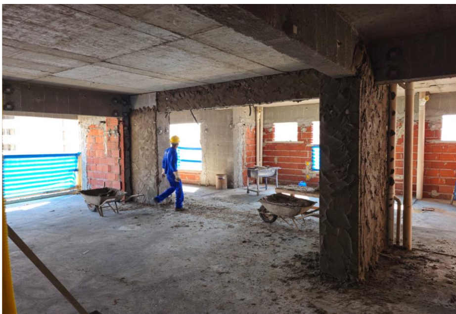
Execução do reboco interno do 11º pavimento – Outubro 2024
