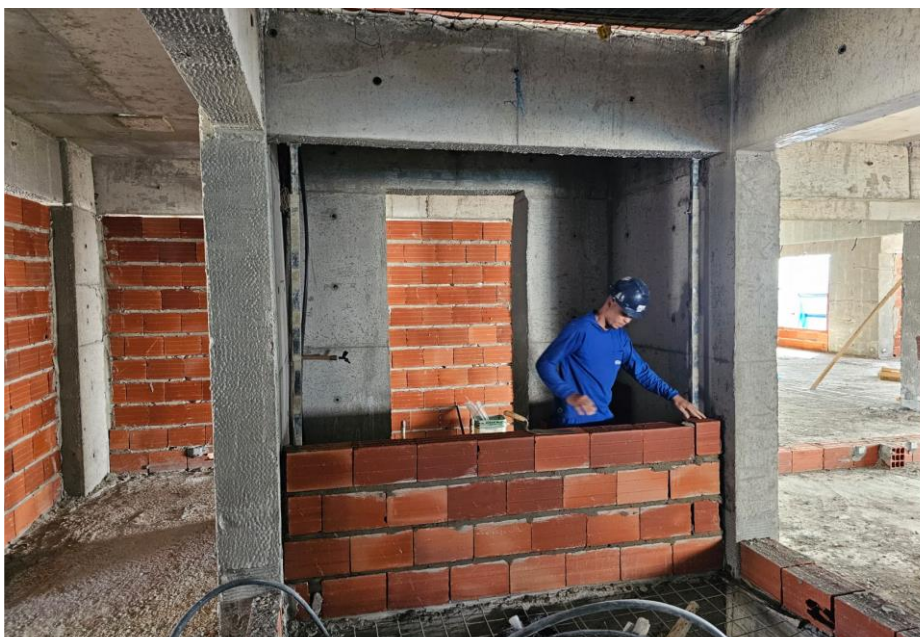
Alvenaria externa e interna do 19º pavimento – Setembro 2024
