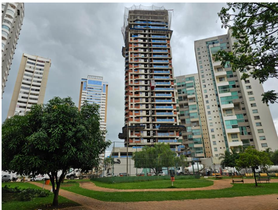
Concretagem da laje do 29º pavimento – Outubro 2024
