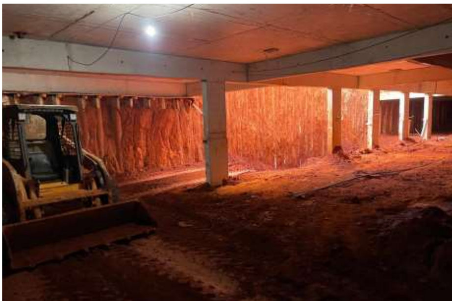
Conclusão da escavação e regularização do piso do subsolo 2 – Julho 2024
