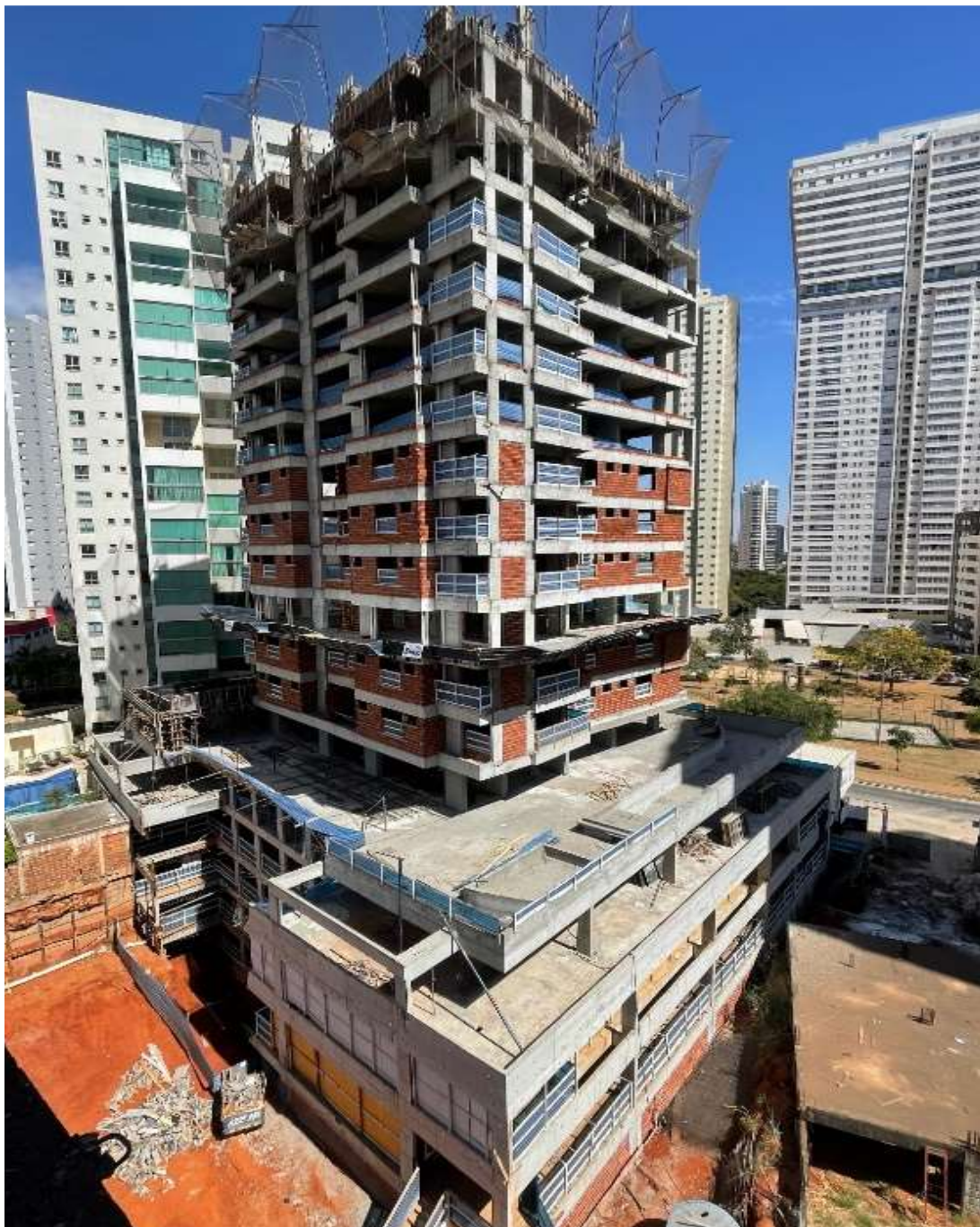
Concretagem da laje estrutural do tipo (16º pavimento) – Julho 2024
