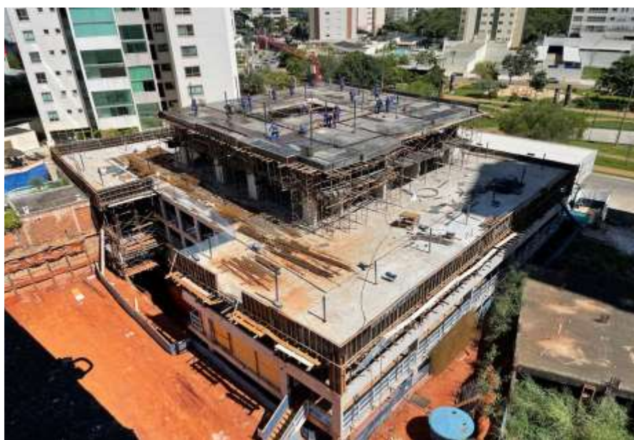
Concretagem do 1º pavimento tipo – Maio 2024
