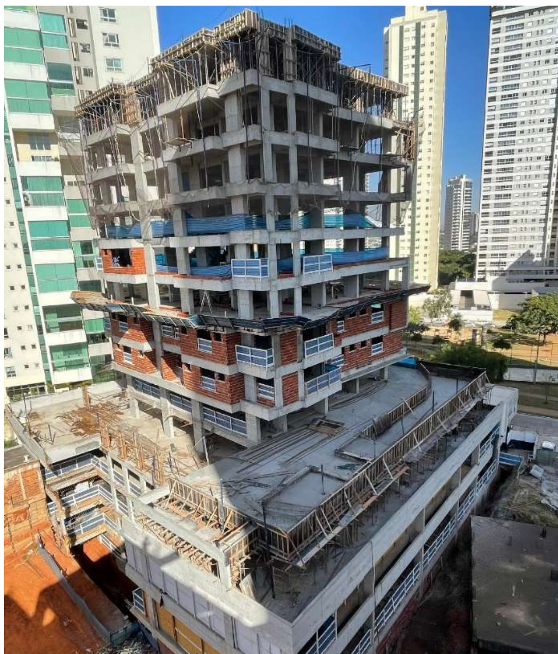
Concretagem da laje estrutural do tipo (11° pavimento) – Junho 2024
