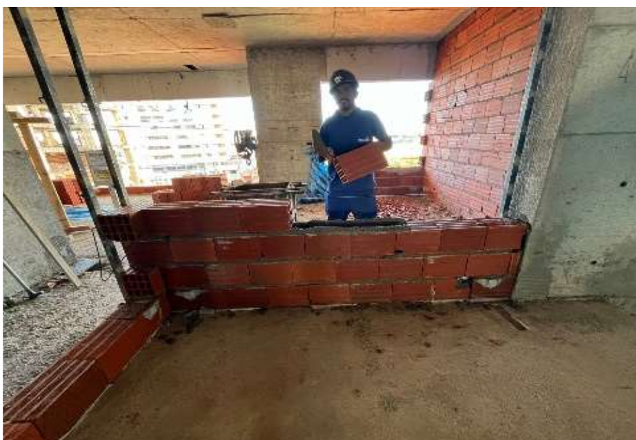
Execução de alvenaria interna de vedação – Maio 2024
