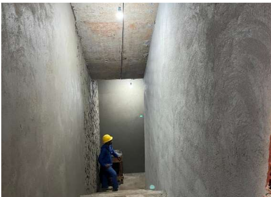
Reboco interno (escadas) – Junho 2024
