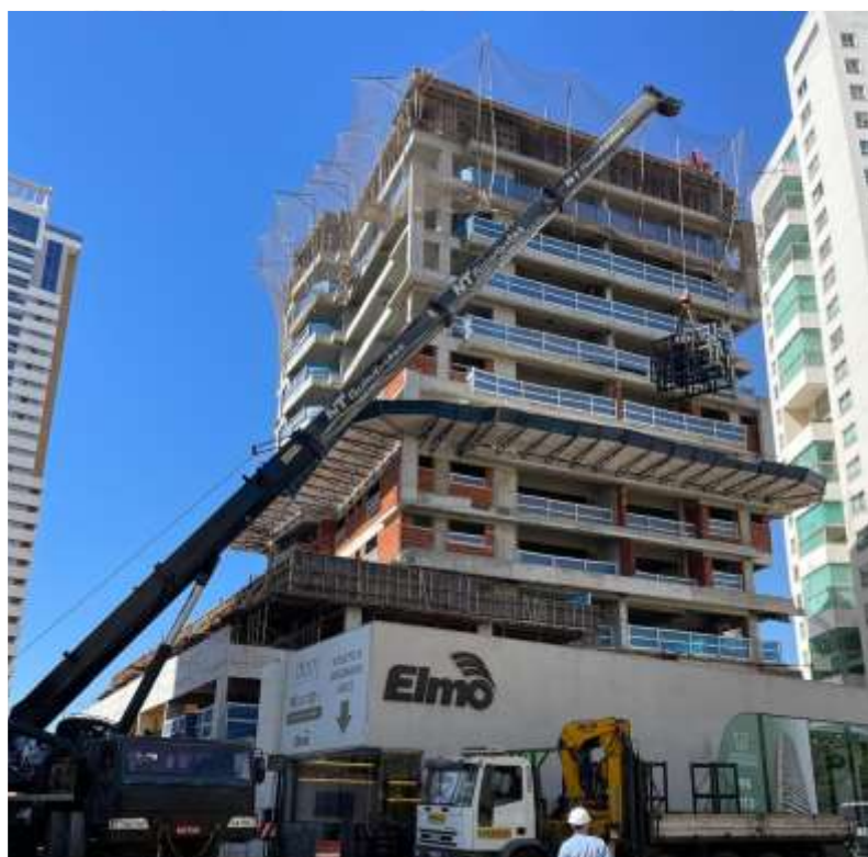
Montagem do elevador cremalheira – Julho 2024
