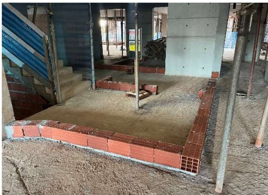
Marcação de alvenaria interna (pavimento térreo) – Maio 2024
