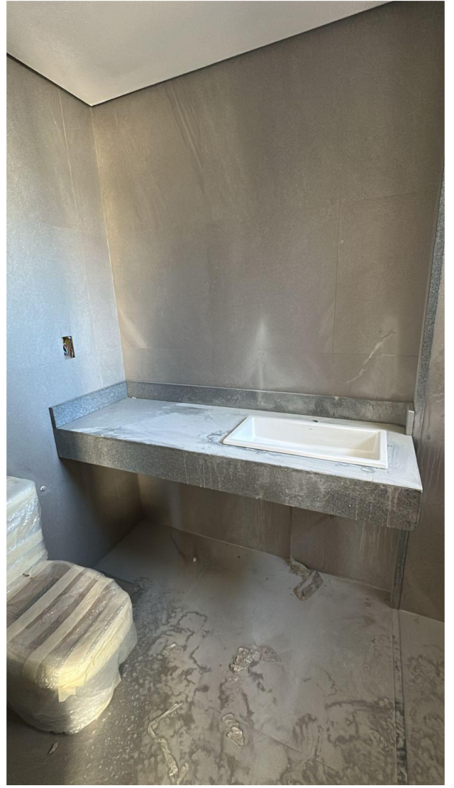
Instalação de cubas brancas no 10º pavimento da Torre Sol – Maio 2025
