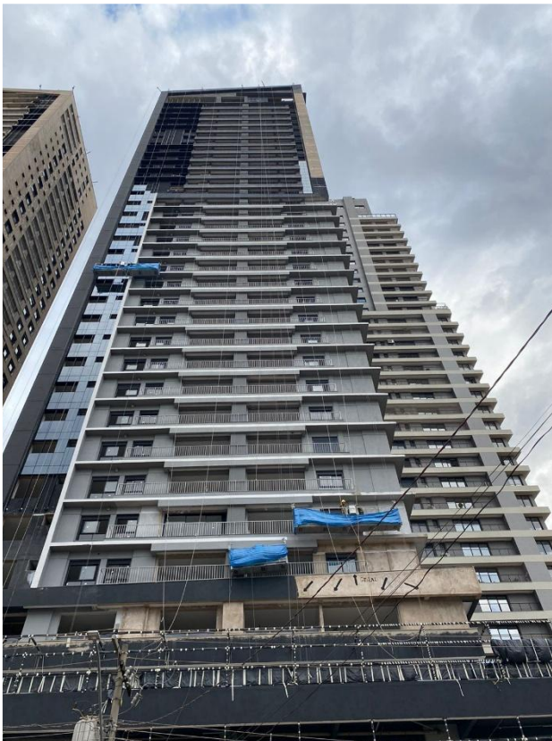
Instalação de pele de vidro e pintura de fachada frontal da Torre Sol – Maio 2025
