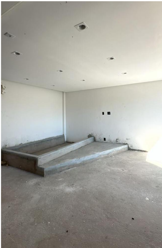
Instalação de luminárias no pavimento lazer da Torre Sol – Julho 2025
