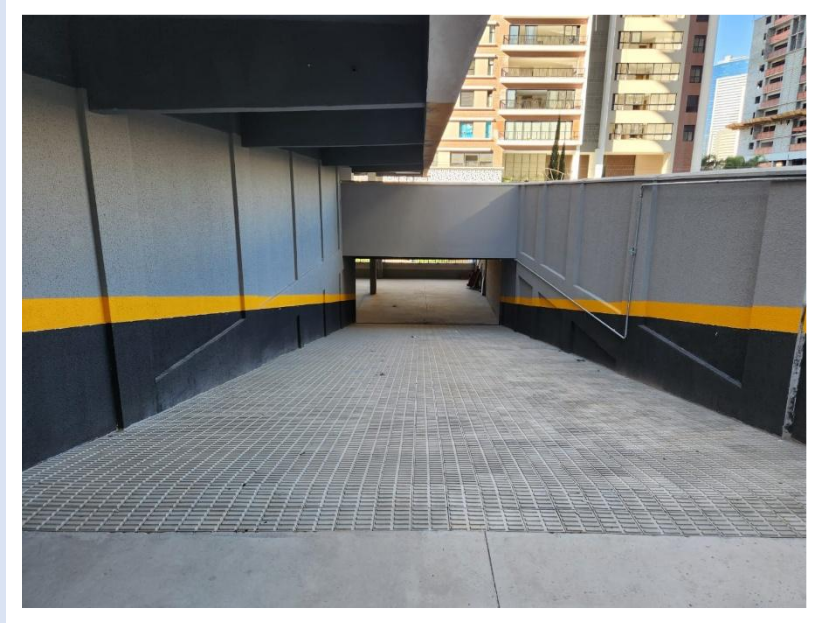
Pintura de parede e teto do pavimento garagem 2 – Maio 2025
