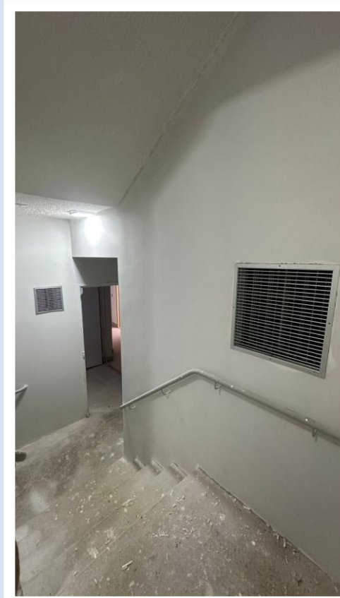
Instalação de sistema de pressurização de escadas de emergência na Torre Sol – Julho 2025
