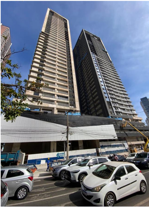
Instalação de brise em fachada na Rua 9 – Junho 2025
