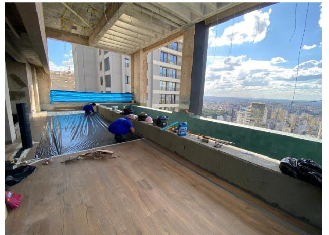
Rejuntamento e proteção de revestimento de piso do deck do rooftop – Maio 2025
