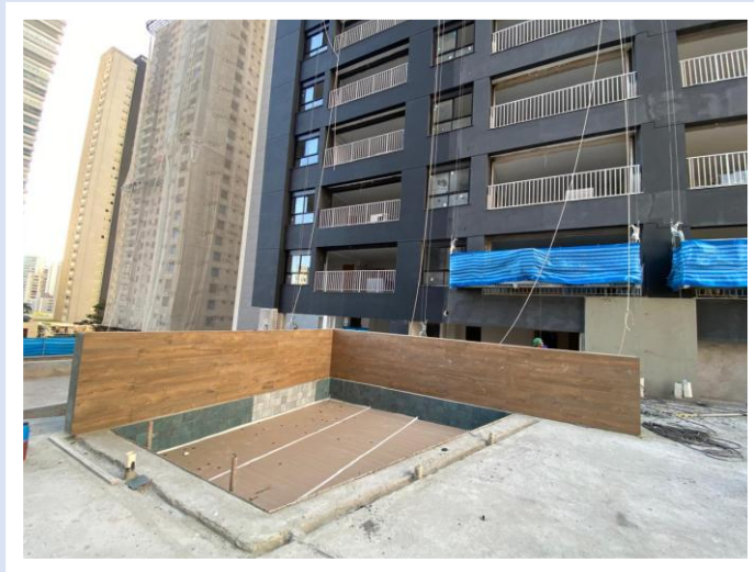
Assentamento de revestimento de parede na piscina infantil no pavimento lazer – Junho 2025
