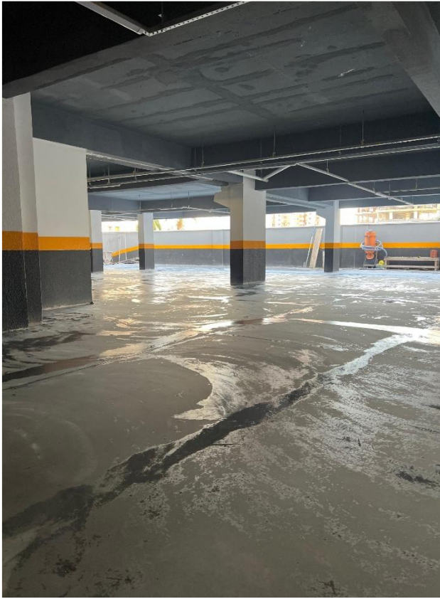
Início de tratamento de piso para aplicação de pintura epóxi na garagem – Julho 2025
