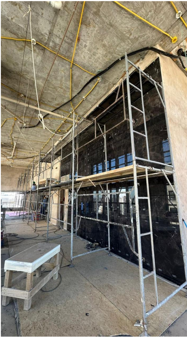
Aplicação de revestimento de parede no rooftop da Torre Sol – Junho 2025
