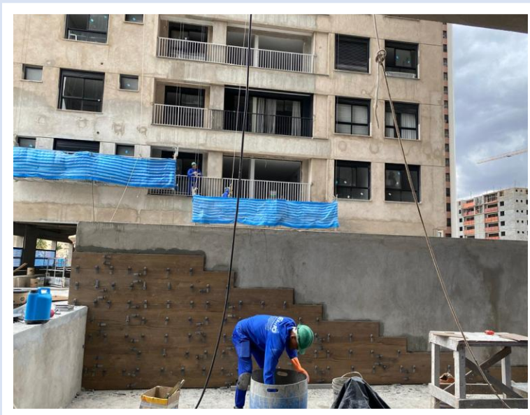
Assentamento de revestimento de parede na piscina infantil no pavimento lazer – Junho 2025
