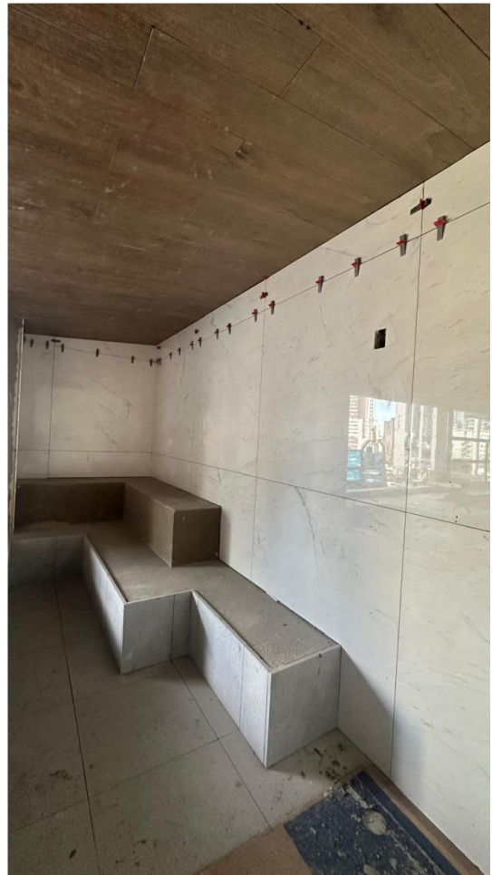
Revestimento de piso, parede e teto da sauna no pavimento lazer – Julho 2025
