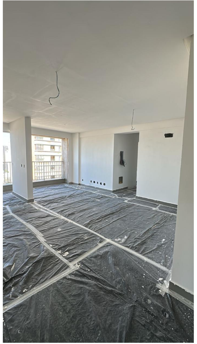
Emassamento e 1º demão de pintura no 33º pavimento da Torre Lua – Maio 2025
