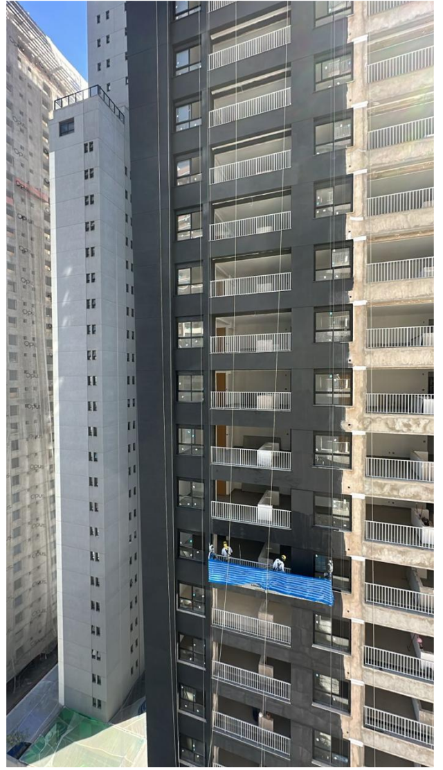
Aplicação de ecogranito em fachada na Torre Sol – Maio 2025
