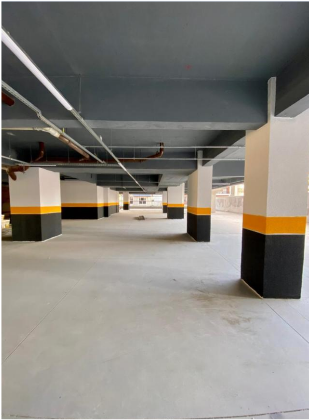
Pintura de parede e teto do pavimento Garagem 3 – Maio 2025
