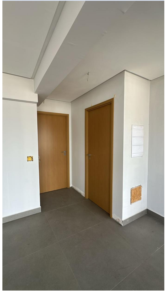
Instalação de esquadrias de madeira no 19º pavimento da Torre Lua – Junho 2025
