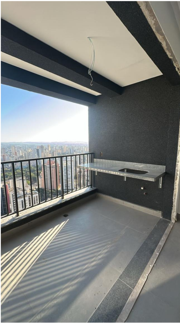
Pintura em ecogranito e instalação de bancadas no 23° pavimento da Torre Sol – Maio 2025
