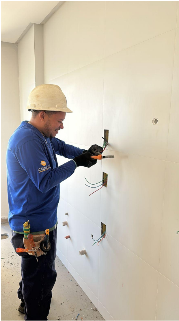
Instalação de módulos e tomadas no 14º pavimento da Torre Sol – Maio 2025
