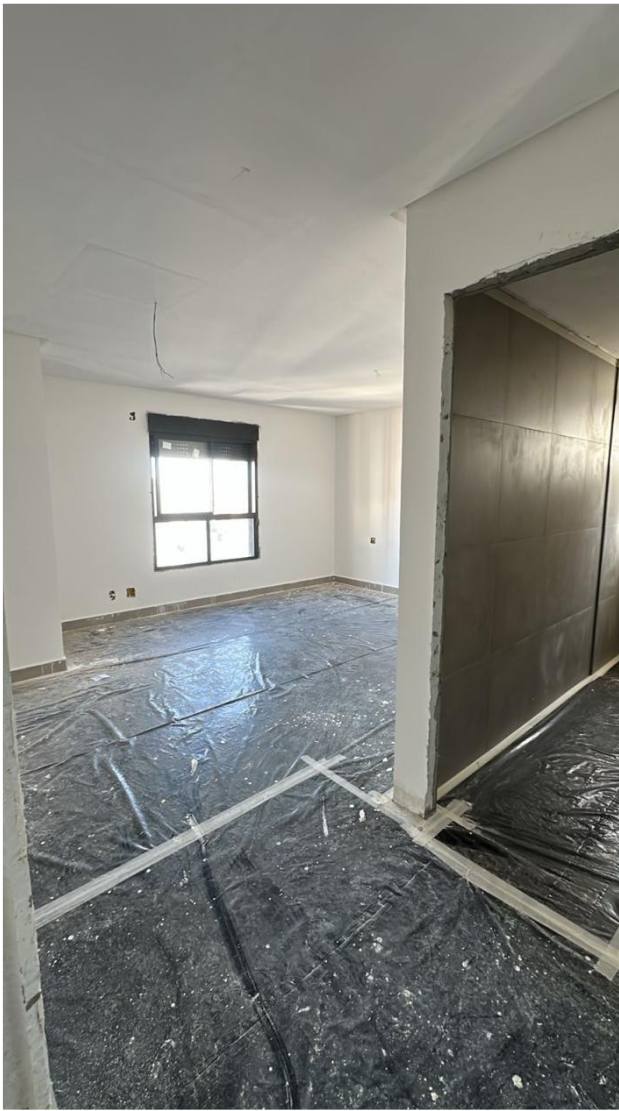
Emassamento e 1º demão de pintura no 34º pavimento da Torre Lua – Maio 2025
