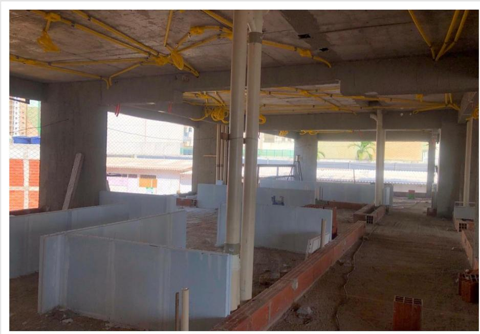
Execução de marcação de alvenaria de bloco cerâmico e bloco de gesso no 2º pavimento – Outubro 2024
