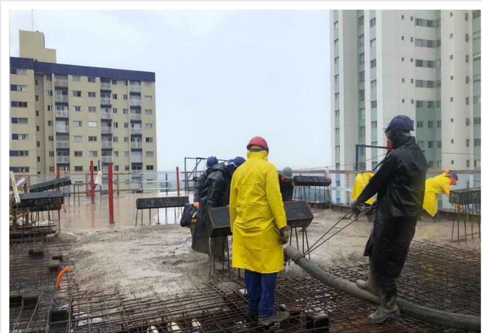
Execução da concretagem da laje do 4º pavimento – Setembro 2024
