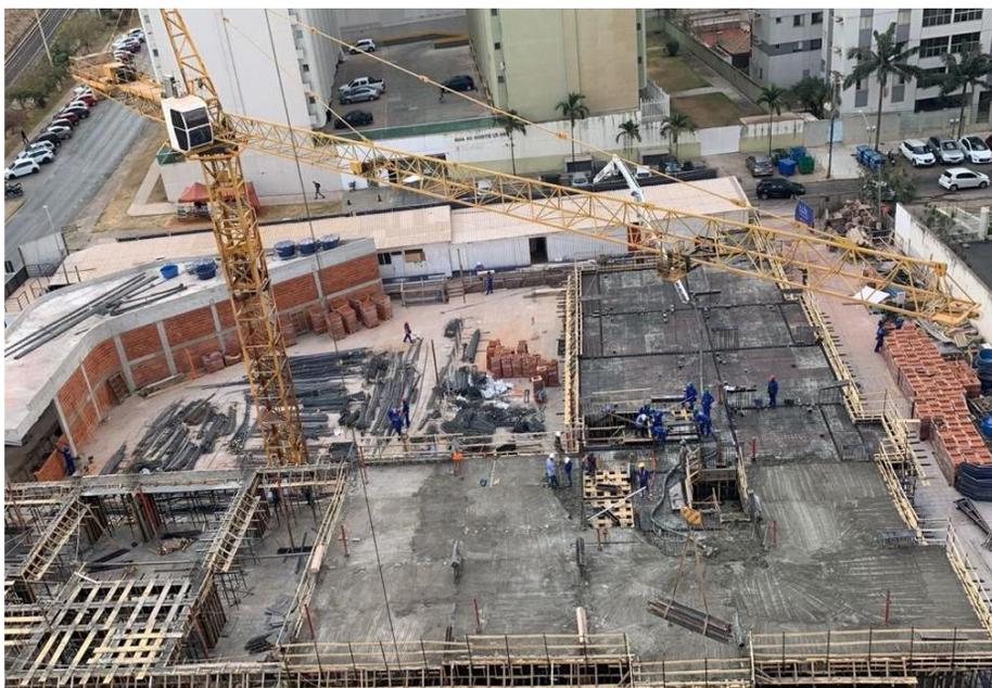
Execução de concretagem da laje do 1º pavimento – Agosto 2024
