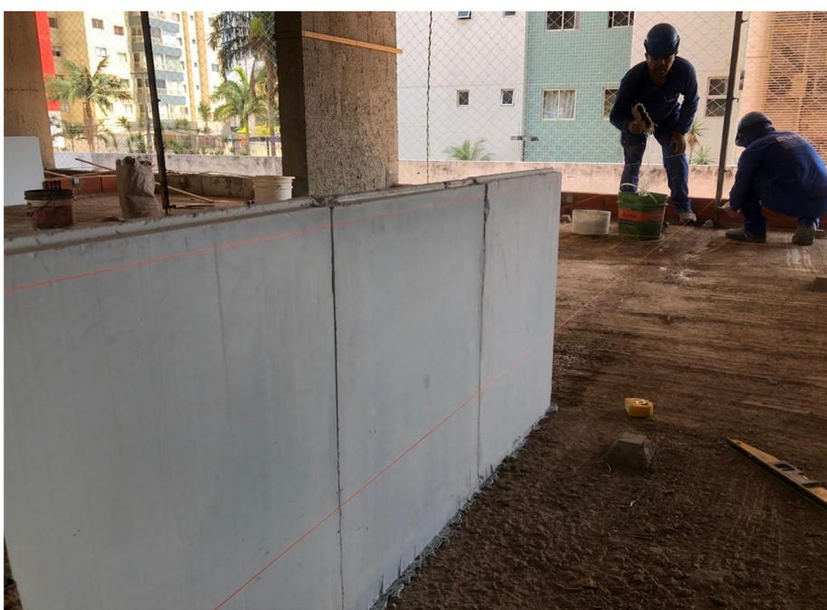
Execução da marcação de alvenaria de bloco de gesso do 1º pavimento –
