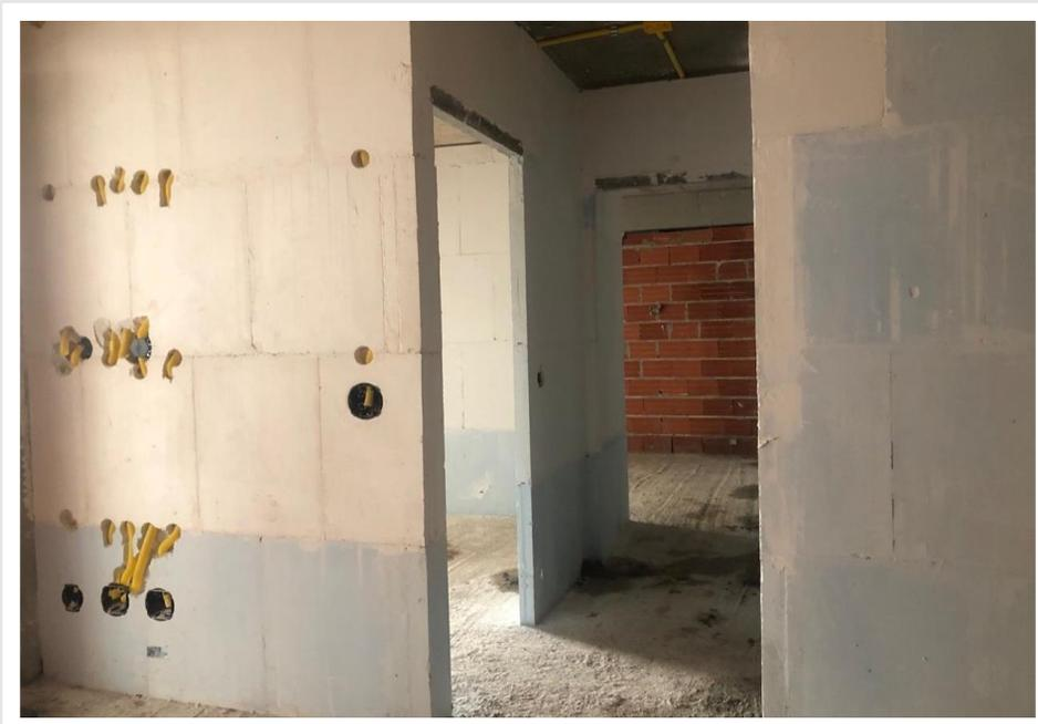
Execução de elevação de alvenaria de bloco de gesso do 1º pavimento – Outubro 2024
