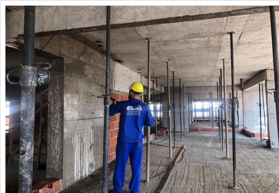
Execução de limpeza e preparação da estrutura para receber alvenaria no 1º pavimento – Setembro 2024
