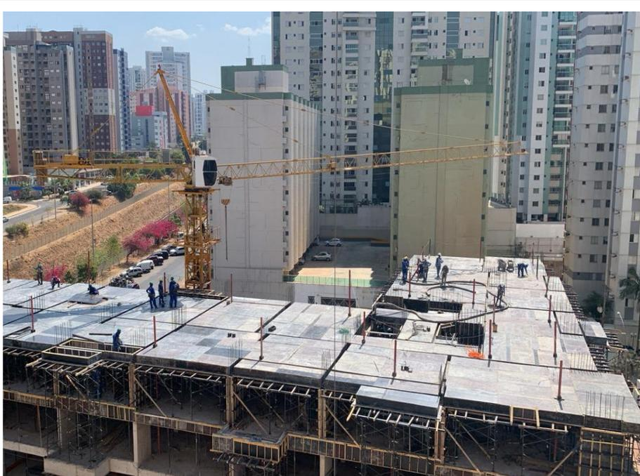
Execução de concretagem dos pilares do 4º pavimento – Setembro 2024
