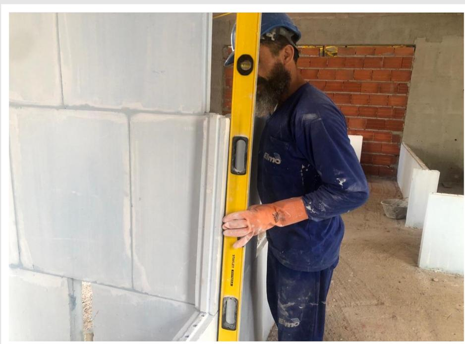
Execução de alvenaria de bloco de gesso do 2º pavimento – Outubro 2024
