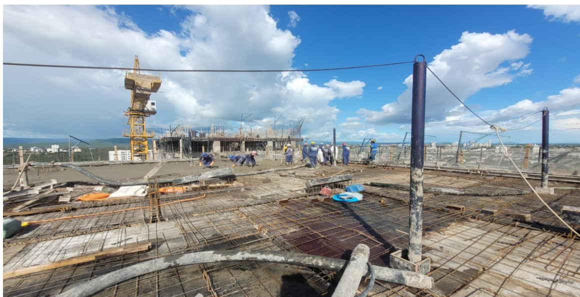
Estrutura do 25° pavimento da Torre Lago – Abril 2026
