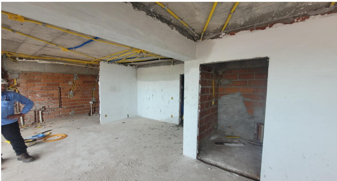
Gesso corrido até o 9º pavimento da Torre Lago – Fevereiro 2026
