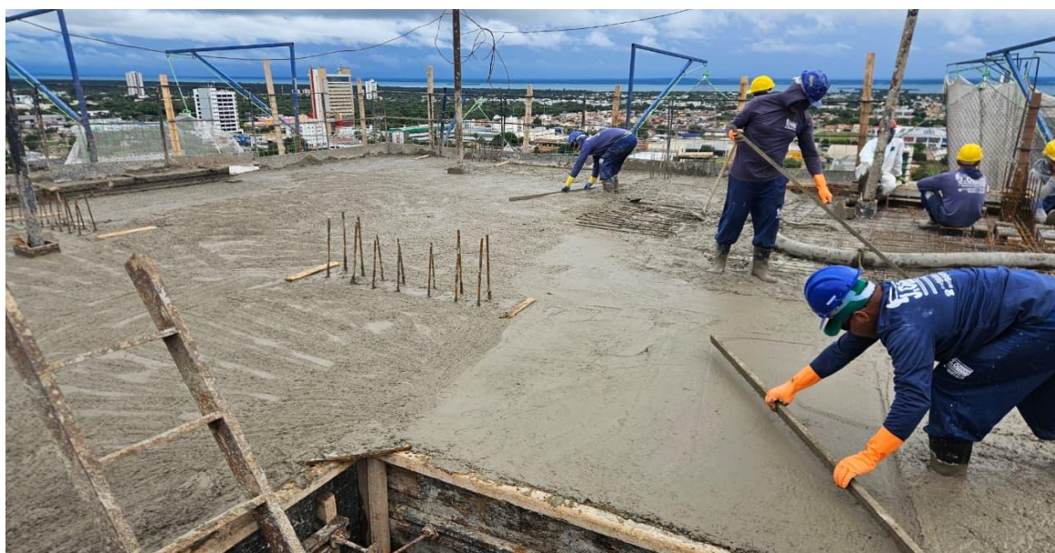
Estrutura do 20º pavimento da Torre Parque – Fevereiro 2026
