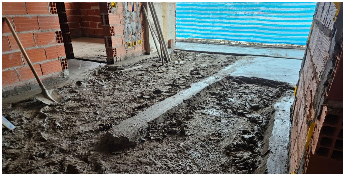
Contrapiso no 6º pavimento da Torre PARQUE – Março 2026
