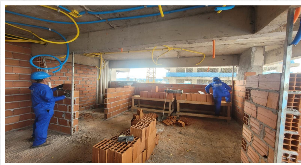
Alvenaria até o 15° pavimento da Torre Lago – Março 2026
