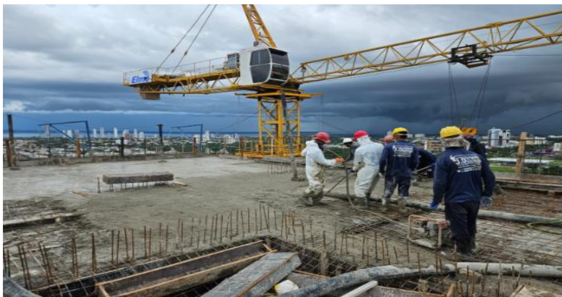
Estrutura do 25º pavimento da Torre Parque – Abril 2026
