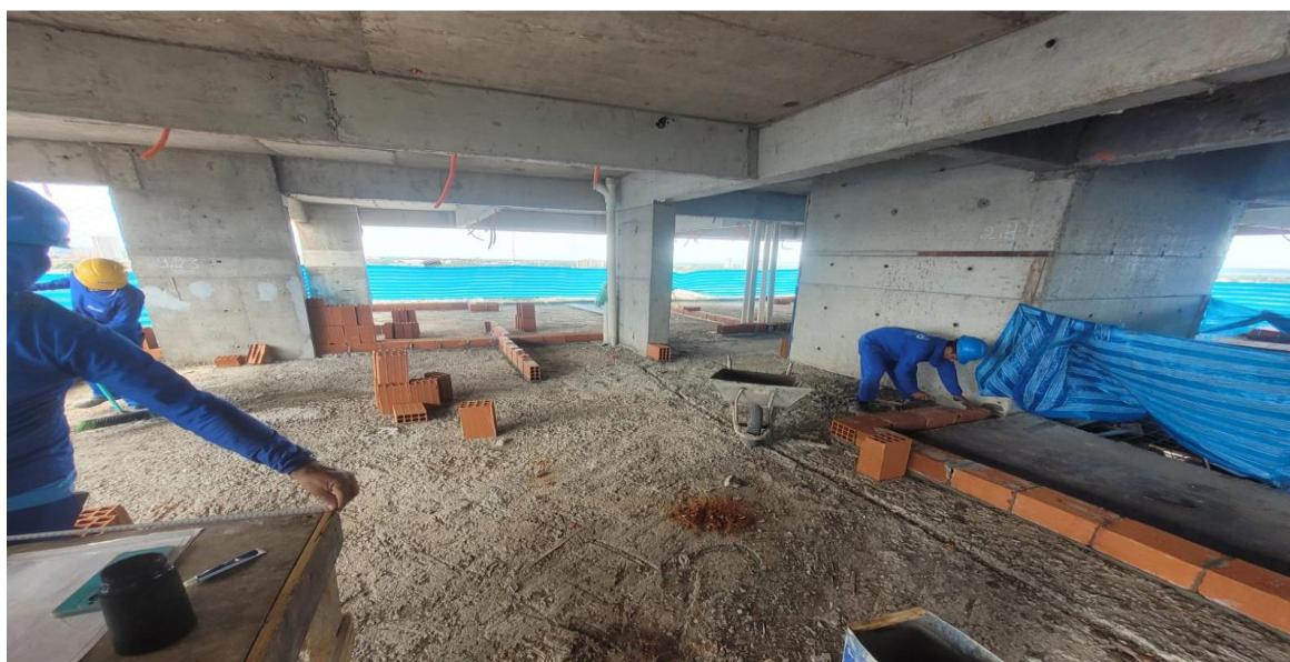
Marcação de alvenaria do 13º pavimento da Torre Lago – Fevereiro 2026
