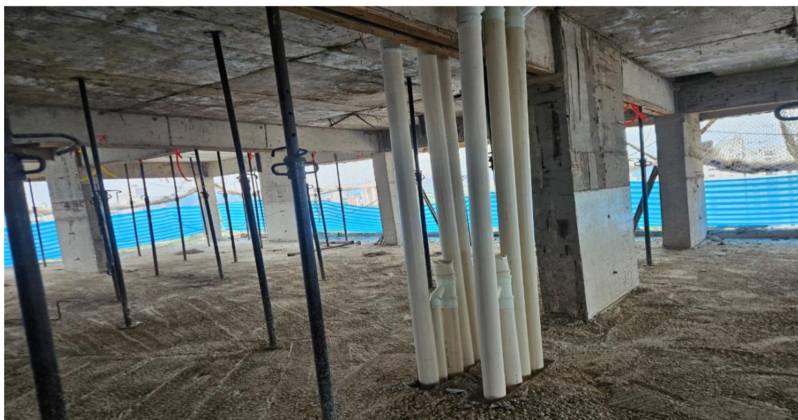
Instalações Prumadas até o 20° pavimento da Torre Parque – Março 2026
