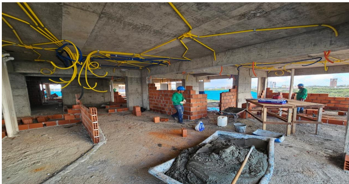
Alvenaria interna no 7° pavimento da Torre Parque – Fevereiro 2026
