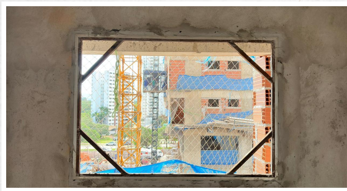
Contramarco no 4º pavimento da Torre Lago – Março 2026
