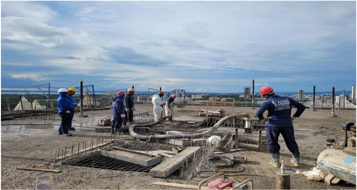
Estrutura do 21° pavimento da Torre Lago – Março 2026
