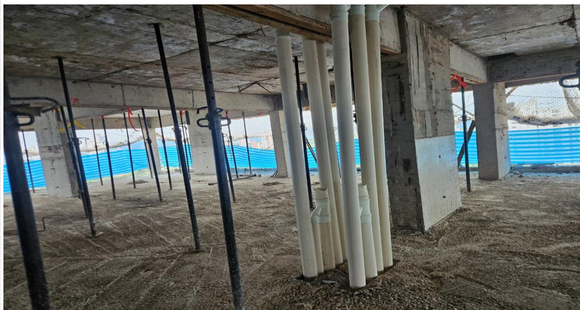
Instalações das prumadas até o 20º pavimento da Torre Parque – Março 2026
