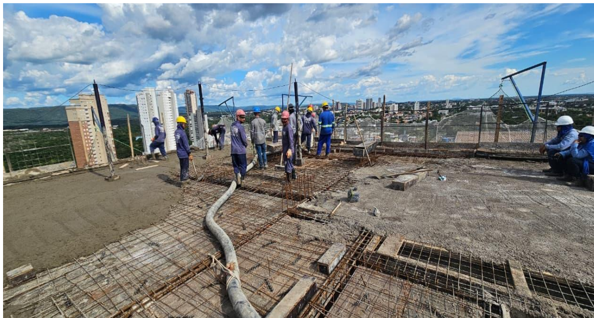
Estrutura do 21º pavimento da Torre Parque – Março 2026
