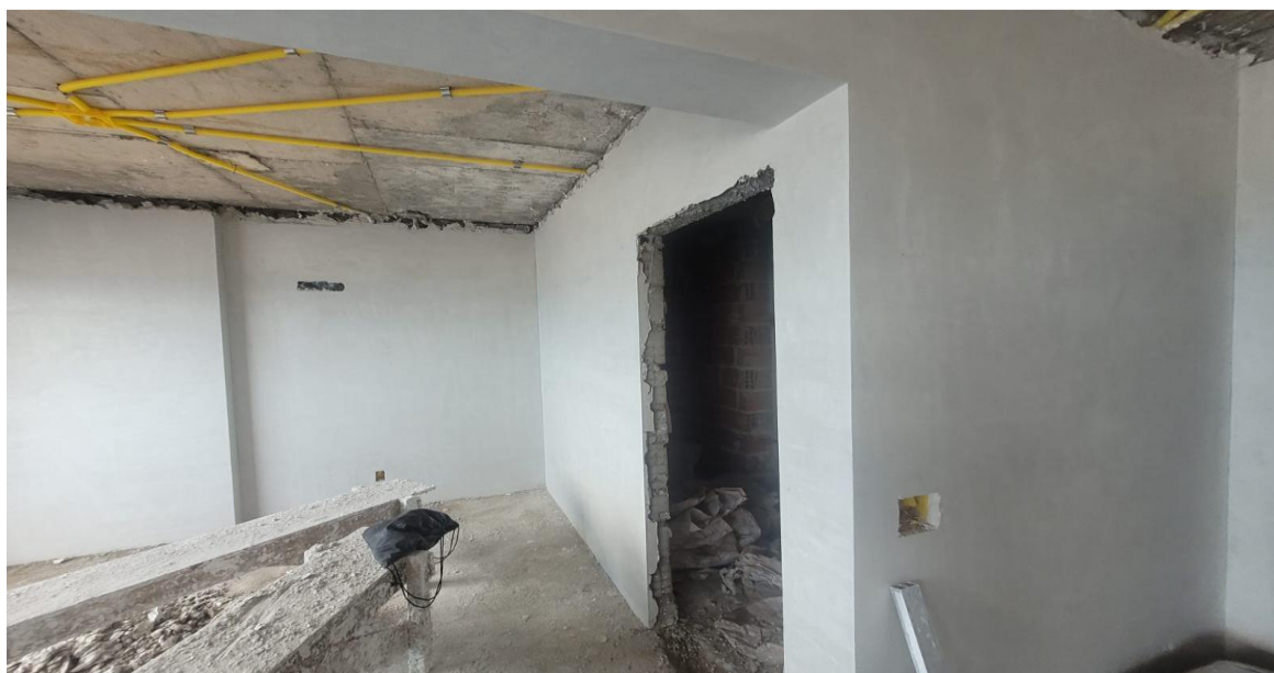
Gesso corrido até o 11º pavimento da Torre Lago – Março 2026
