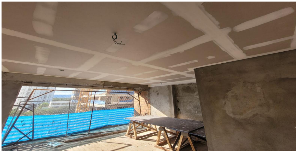
Forro de Gesso no 4º pavimento da Torre Lago – Abril 2026
