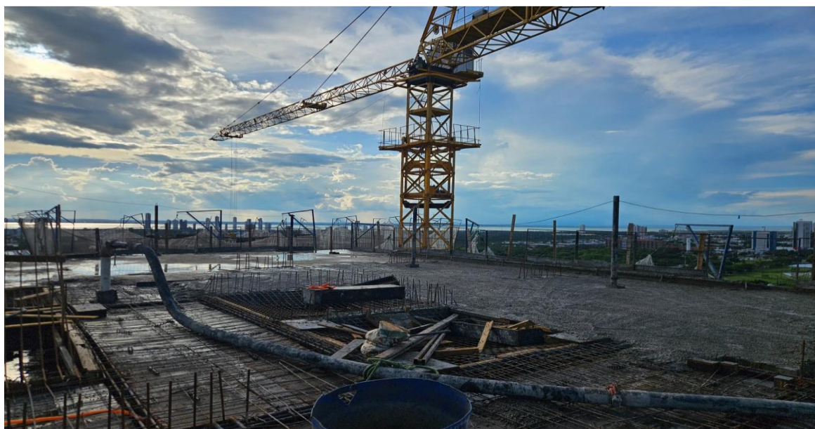
Estrutura do 22º pavimento da Torre Parque – Março 2026
