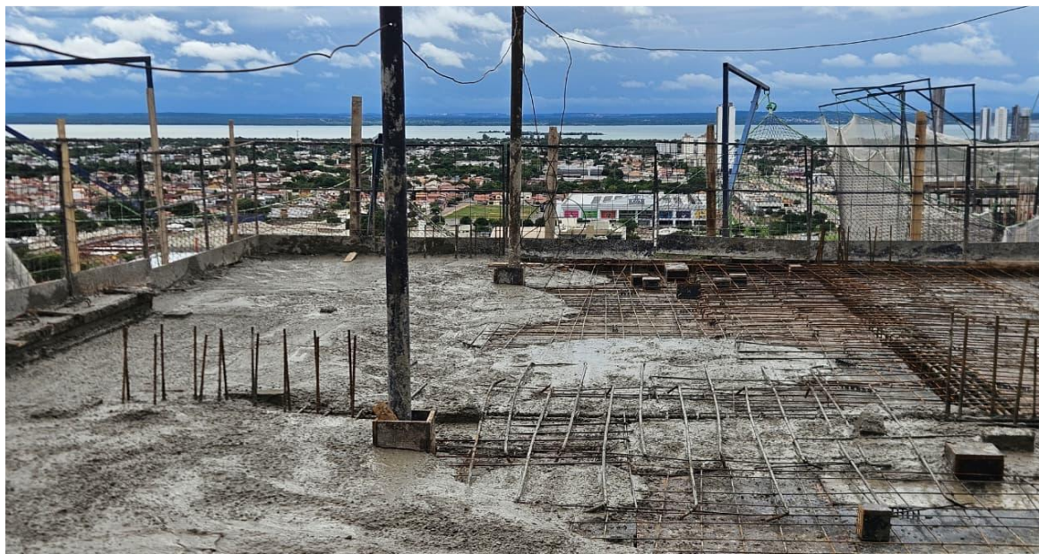
Estrutura do 19º pavimento da Torre Parque – Fevereiro 2026
