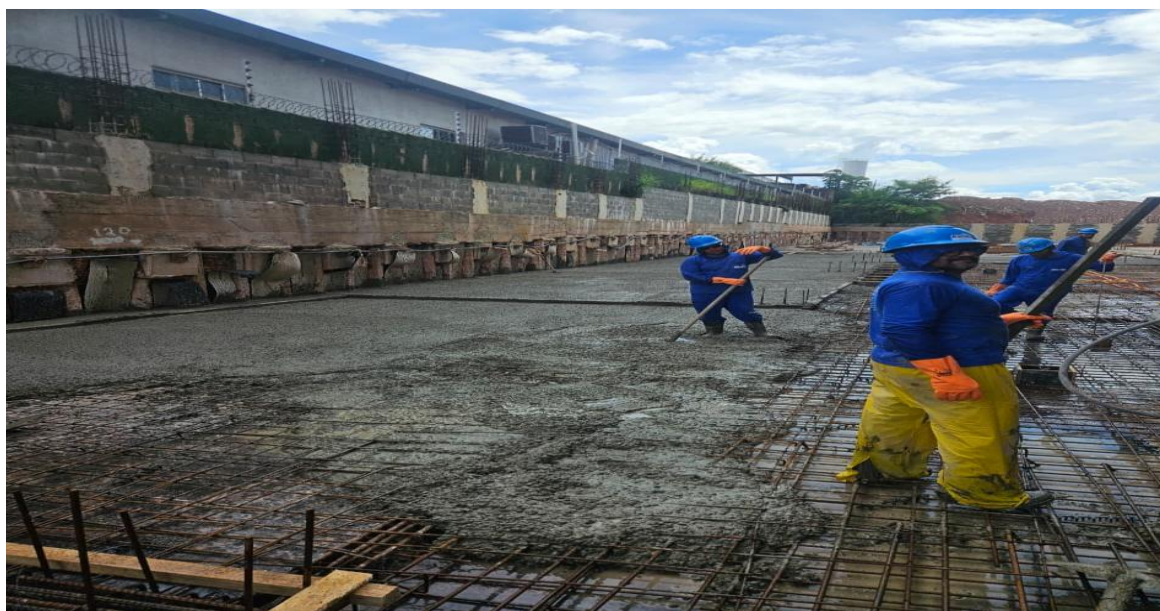
Concretagem da periferia do térreo da Torre Parque – Março 2026
