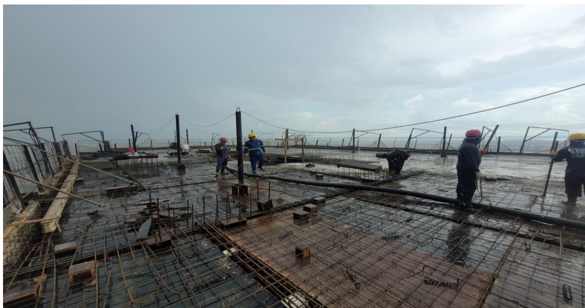
Estrutura do 20° pavimento da Torre Lago – Março 2026
