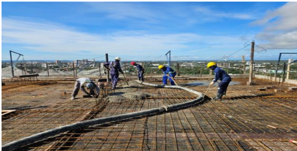
Estrutura do 24º pavimento da Torre Parque – Abril 2026
