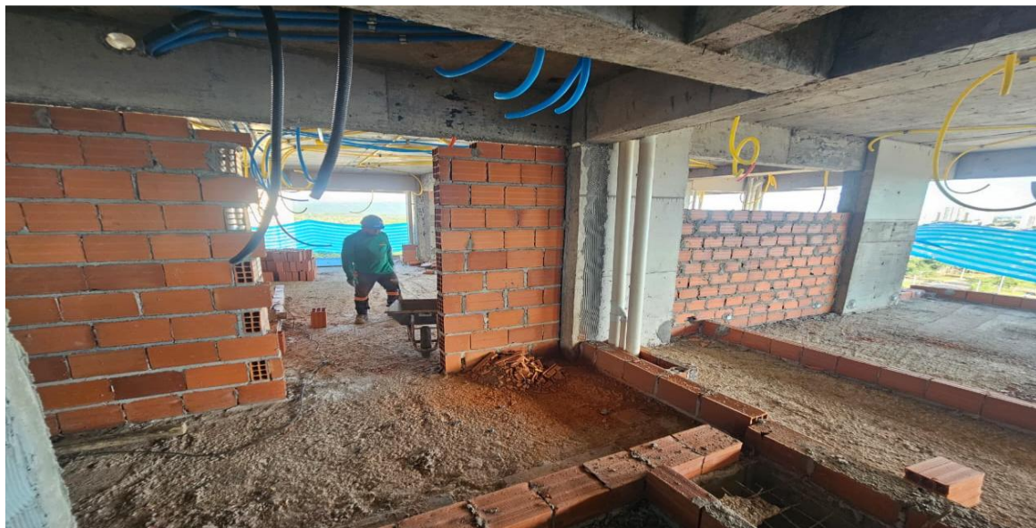
Alvenaria do 13º pavimento da Torre Parque – Abril 2026
