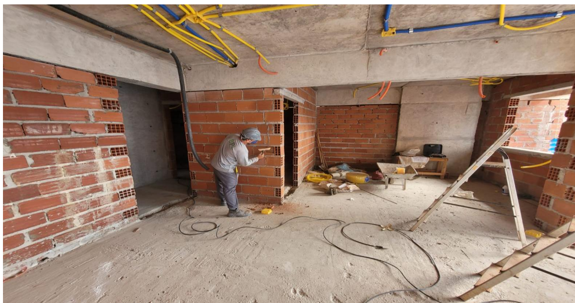
Infra elétrica de parede até o 12º pavimento da Torre Lago – Março 2026
