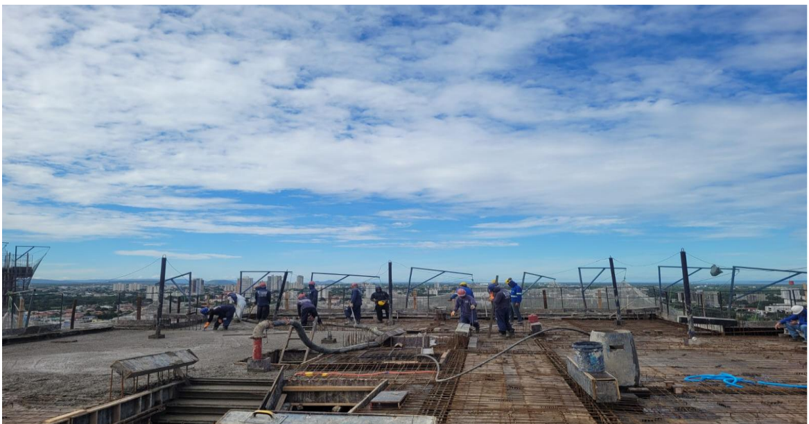
Estrutura do 22° pavimento da Torre Lago – Março 2026
