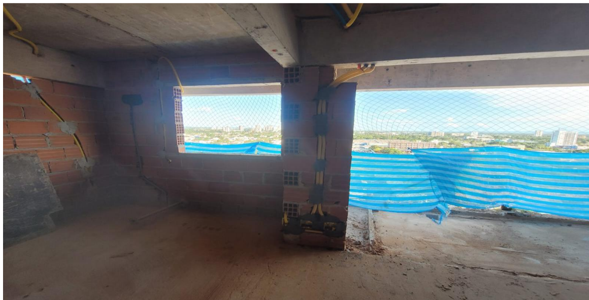
Instalações elétricas de parede no 15º pavimento da Torre Lago – Abril 2026
