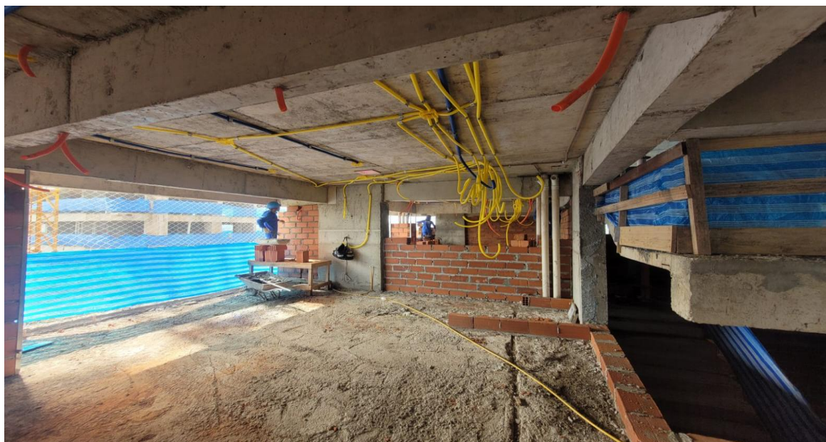
Alvenaria do 12º pavimento da Torre Lago – Fevereiro 2026
