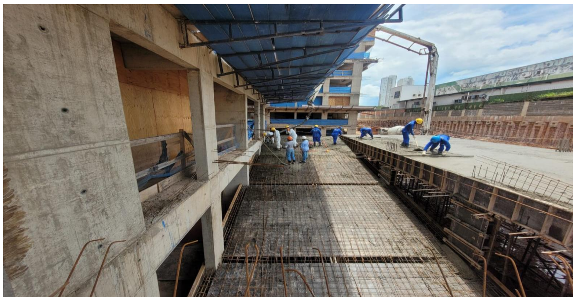
Estrutura da periferia do térreo e rampa do subsolo da Torre Lago - Fevereiro 2026
