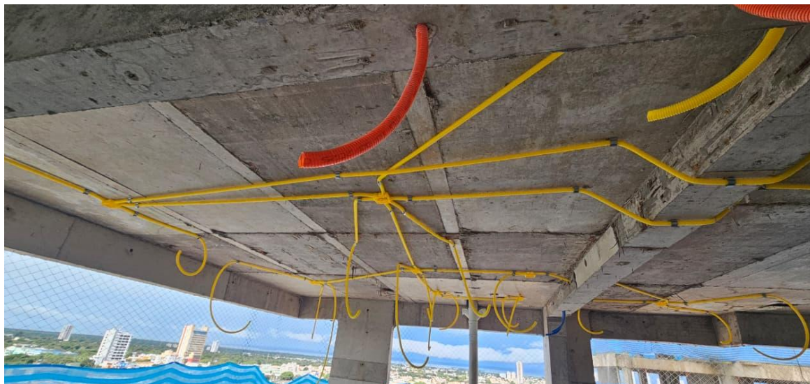
Instalações elétricas de teto até o 16° pavimento da Torre Parque – Março 2026
