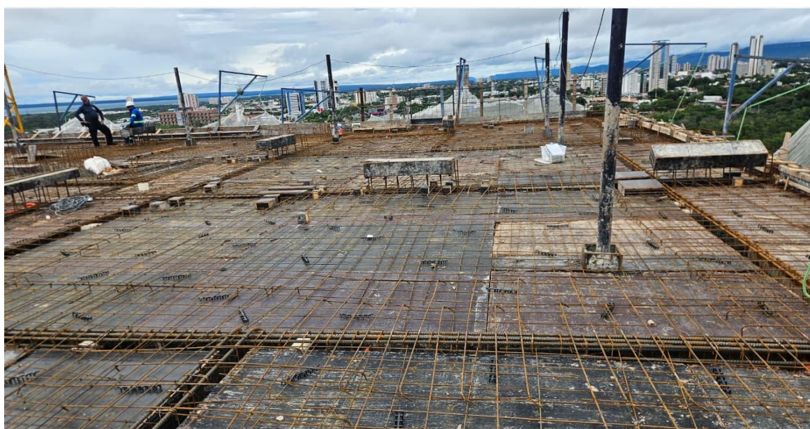
Estrutura do 19º pavimento da Torre Lago – Fevereiro 2026
