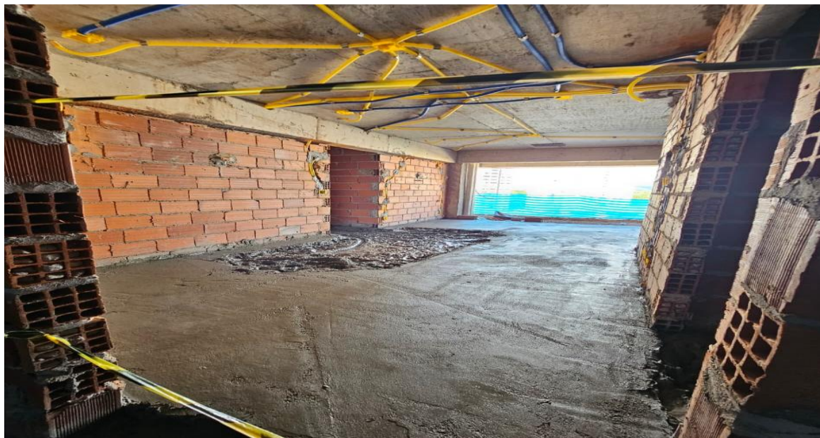
Contrapiso até o 5° pavimento da Torre Parque – Fevereiro 2026
