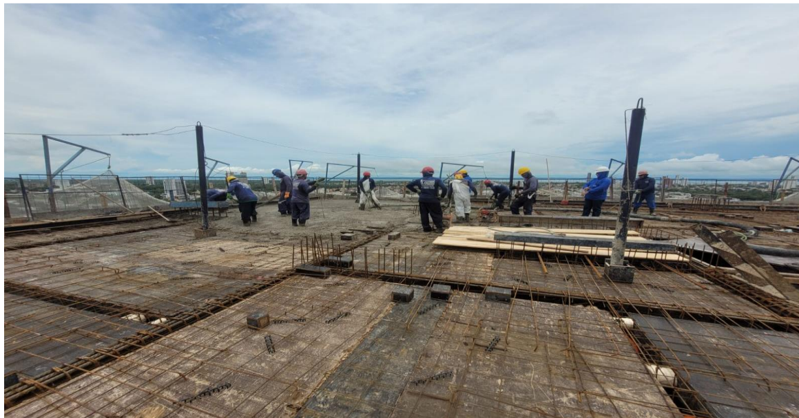
Estrutura do 18º pavimento da Torre Lago – Fevereiro 2026
