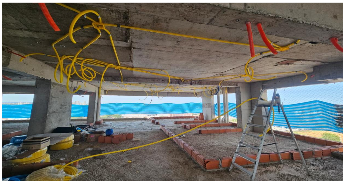
Instalações elétricas de teto até o 17º pavimento da Torre Parque – Abril 2026
