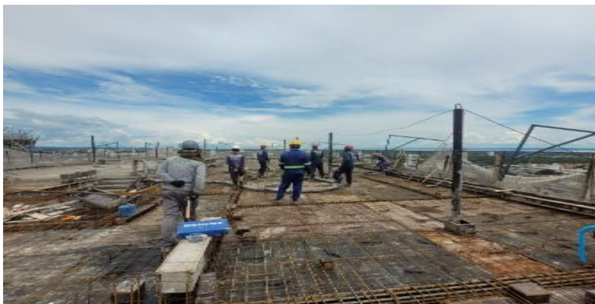
Estrutura do 23° pavimento da Torre Lago – Abril 2026
