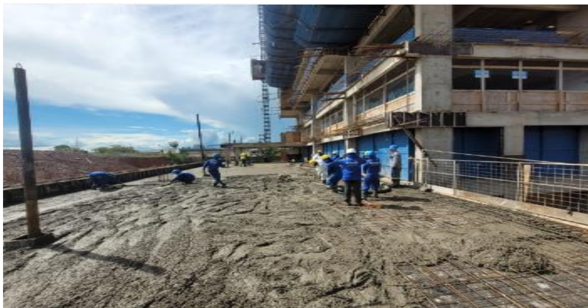
Concretagem da periferia do pavimento garagem 1 da Torre Lago – Abril 2026
