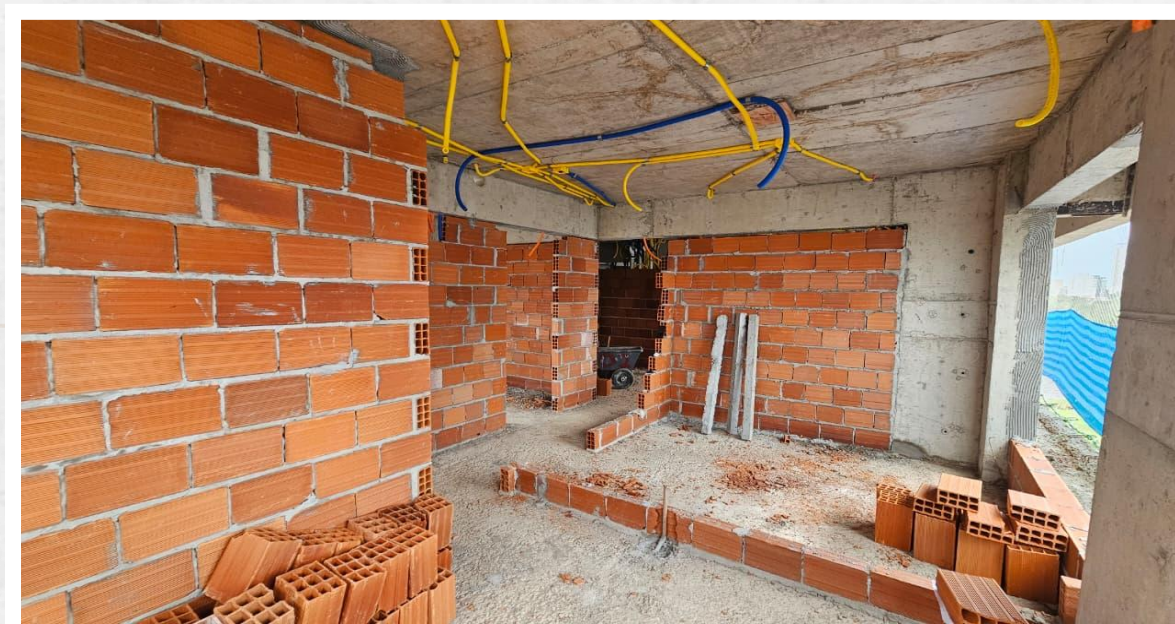
Alvenaria interna do 8º ao 12º pavimento da Torre Parque – Março 2026
