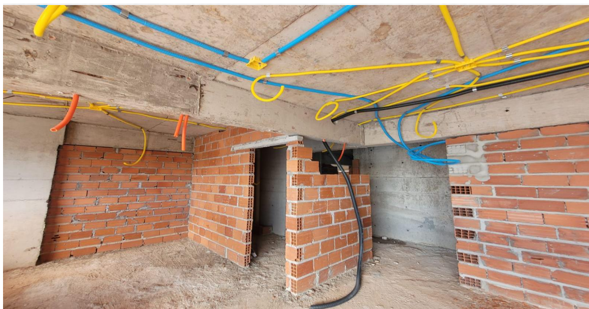
Instalações elétricas de teto até o 17º pavimento da Torre Lago – Abril 2026
