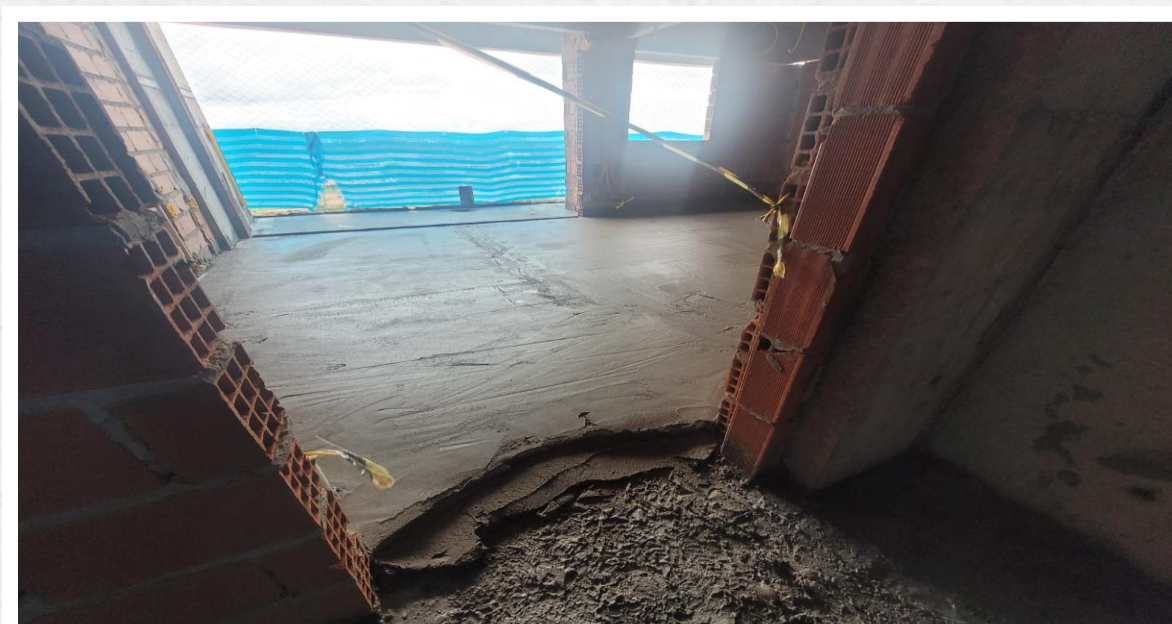
Contrapiso no 13º pavimento da Torre Lago – Março 2026
