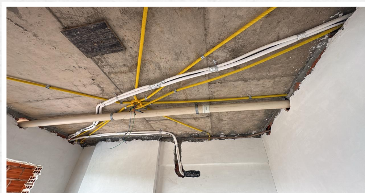
Instalações da rede frigorígena até o 9° pavimento da Torre Lago – Março 2026
