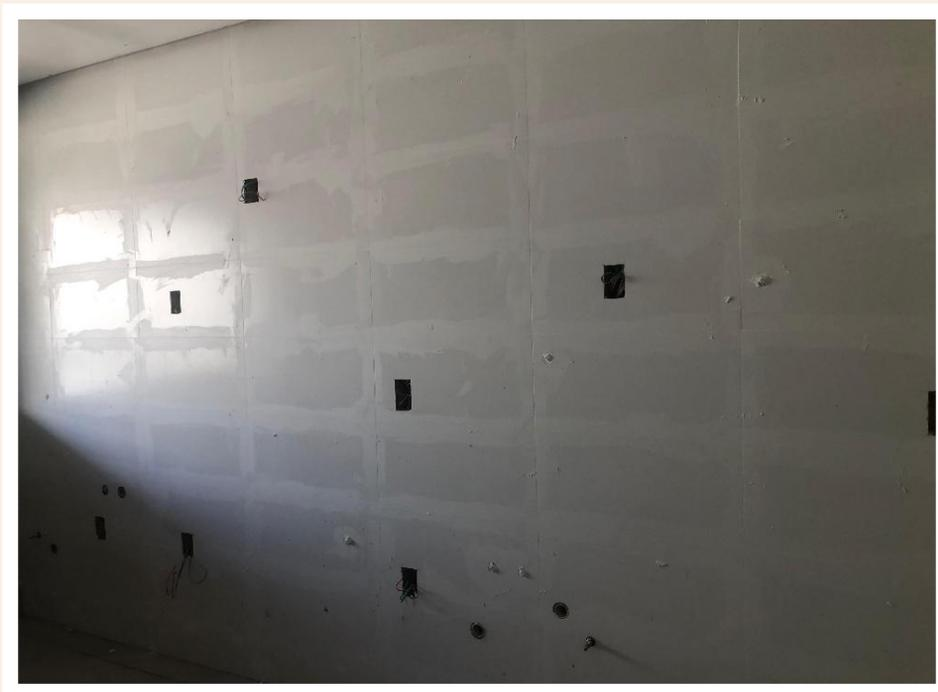
Execução de revestimento e rejunte de parede do 3º pavimento – Junho 2025
