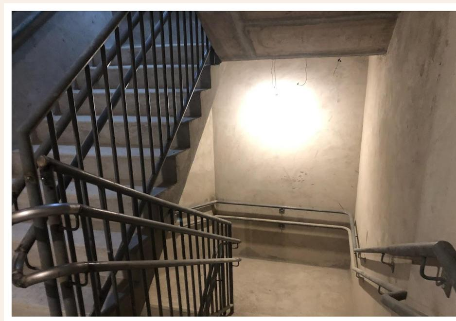
Execução da instalação do corrimão e tratamento do piso e teto das escadas – Maio 2025
