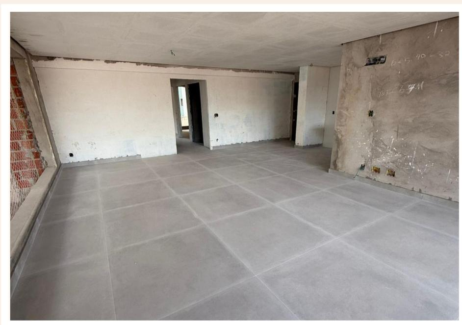
Execução do revestimento cerâmico do 2º pavimento – Maio 2025
