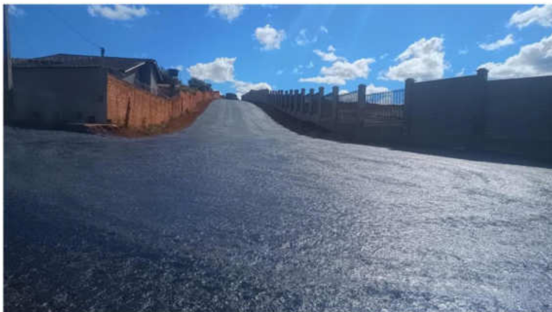
Execução de imprimação na Alameda dos Lisiantos – Junho 2026
