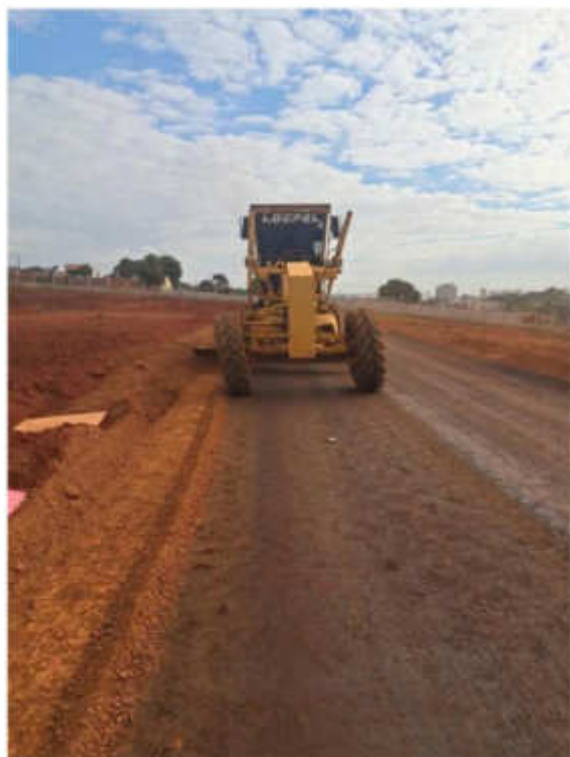
Preparo da base para execução do meio-fio modelo americano – Julho 2026
