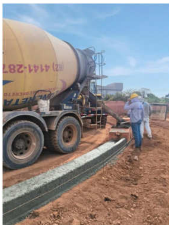
Execução do meio-fio modelo americano – Julho 2026
