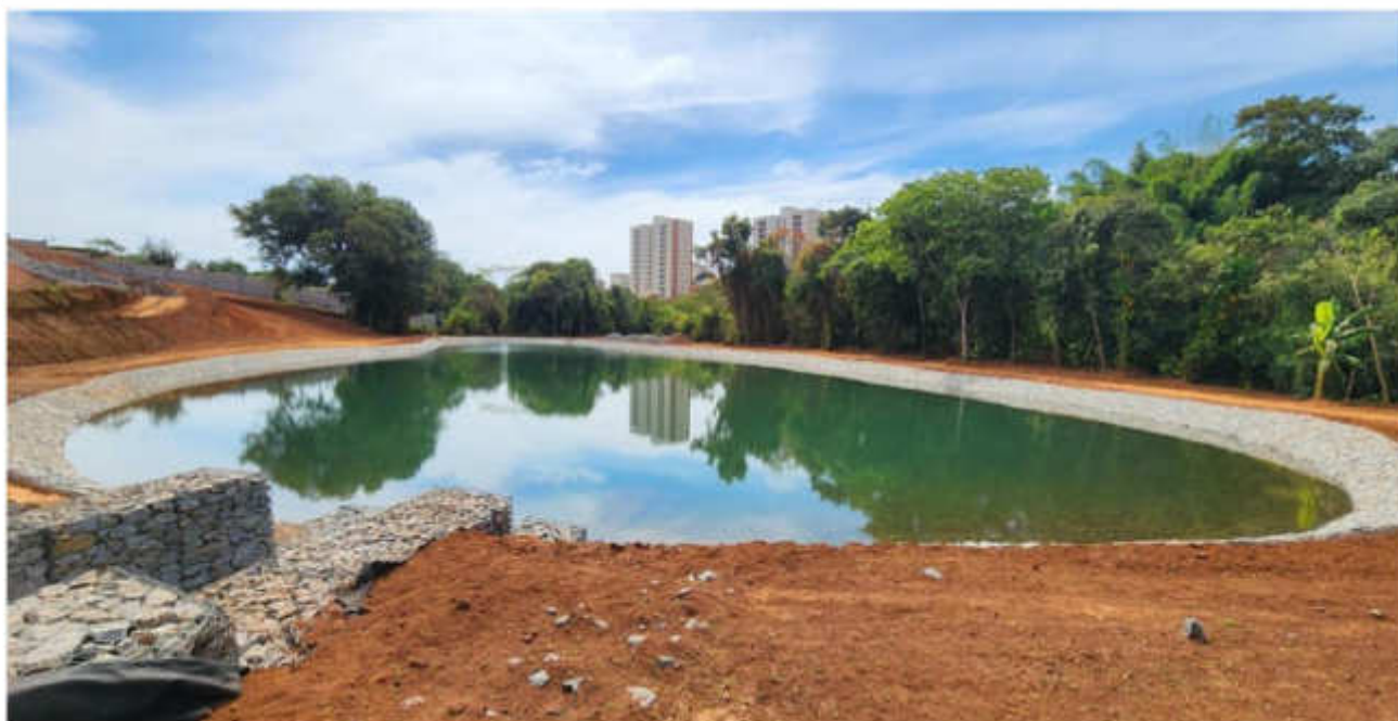
Lago / Bacia de retenção em nível permanente. Superfície aproximada de 3.000,00m 2 – Junho 2026
