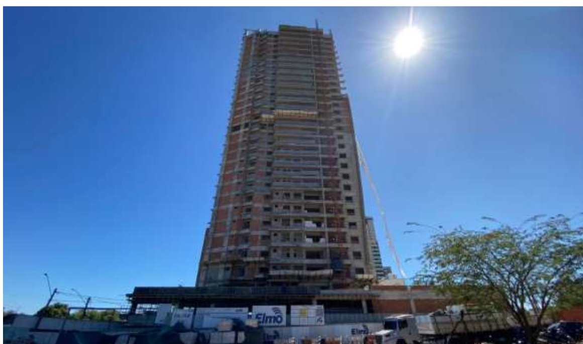
Foto externa do empreendimento (vista lateral) – Julho 2024
