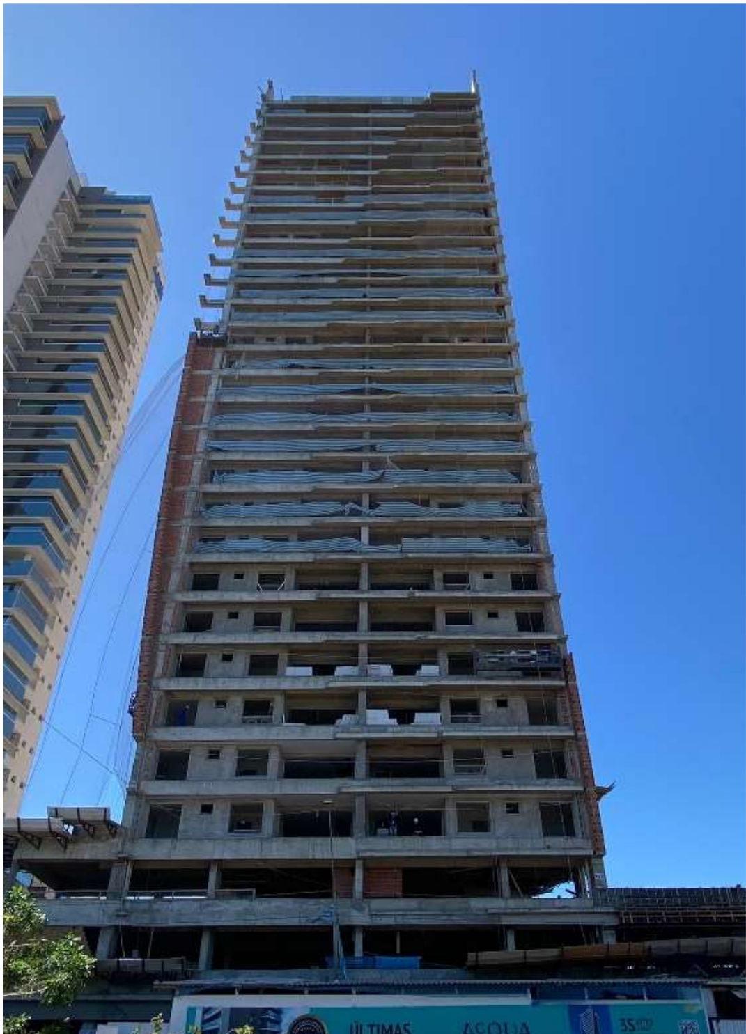
Foto externa do empreendimento (vista frontal) – Julho 2024
