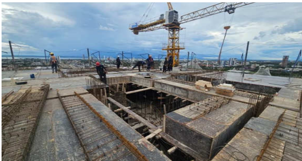
Estrutura do 28º pavimento da Torre Parque – Maio 2026
