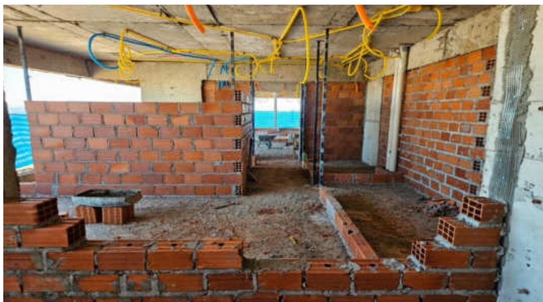
Alvenaria até o 26° pavimento da Torre Parque – Julho 2026
