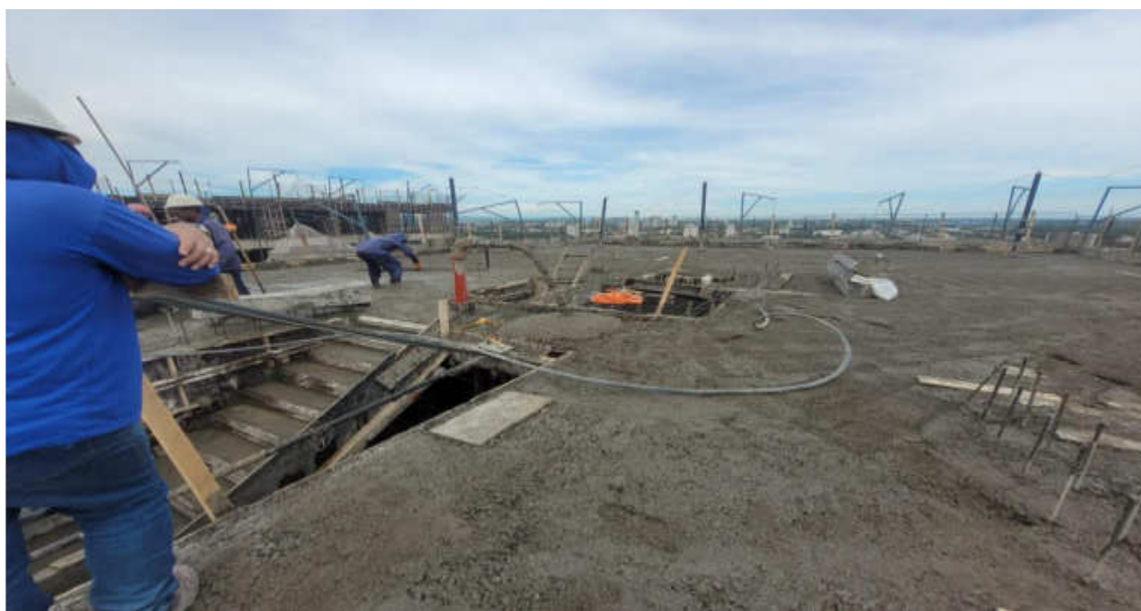
Estrutura do 28º pavimento Torre Lago – Maio 2026
