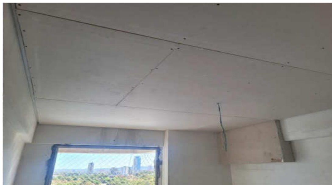
Forro no 10° pavimento da Torre Lago – Junho 2026
