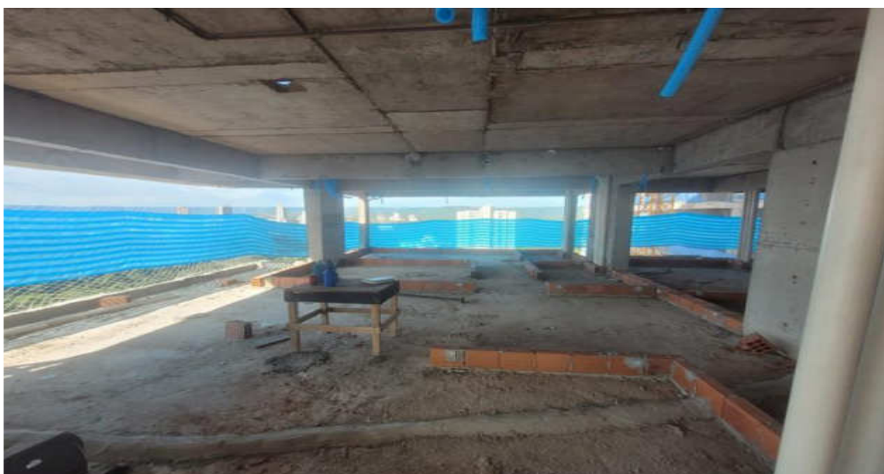
Marcação de alvenaria do 21º pavimento da Torre Lago – Maio 2026
