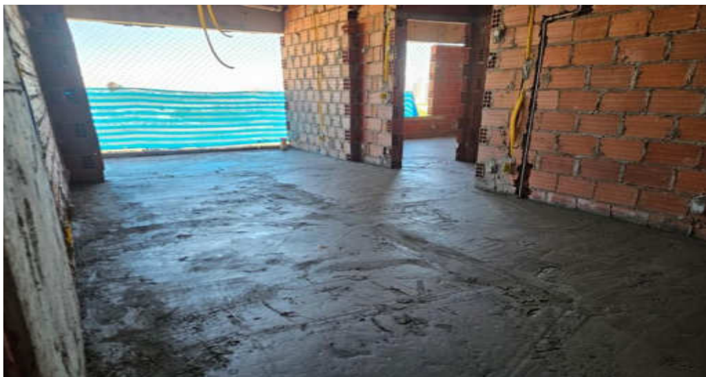
Contrapiso no 10º pavimento da Torre Parque – Junho 2026
