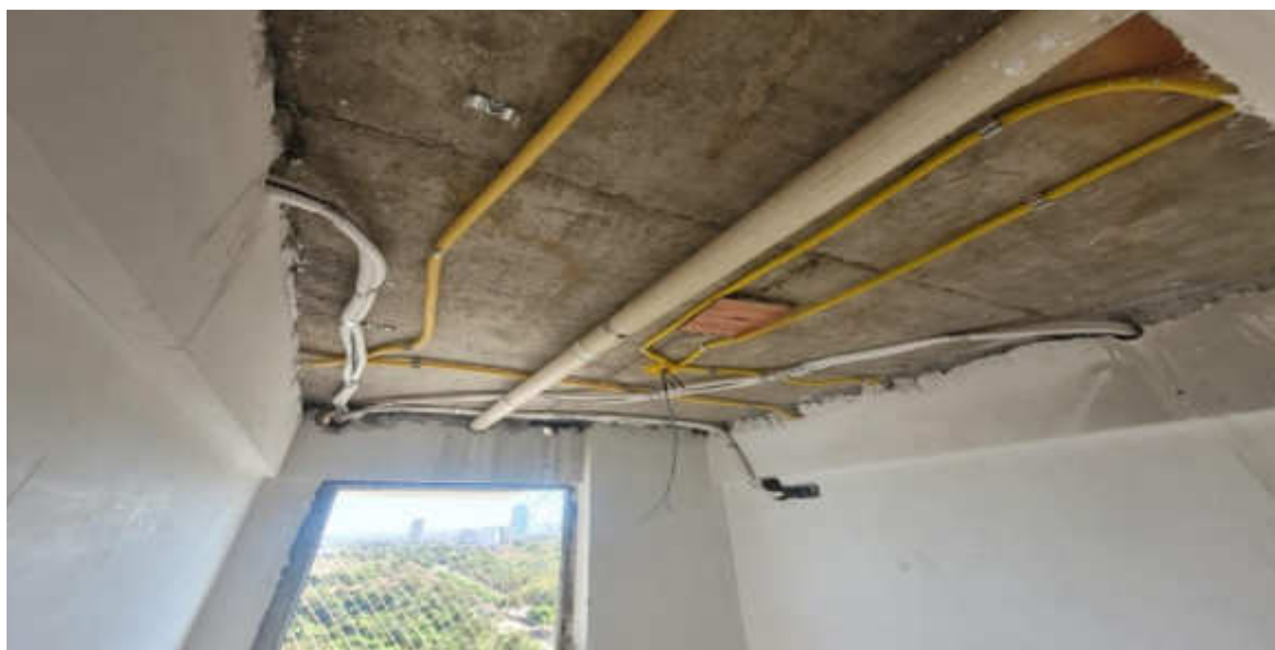
Instalações de rede frigorígena do ar condicionado até 16º pavimento da Torre Lago – Julho 2026
