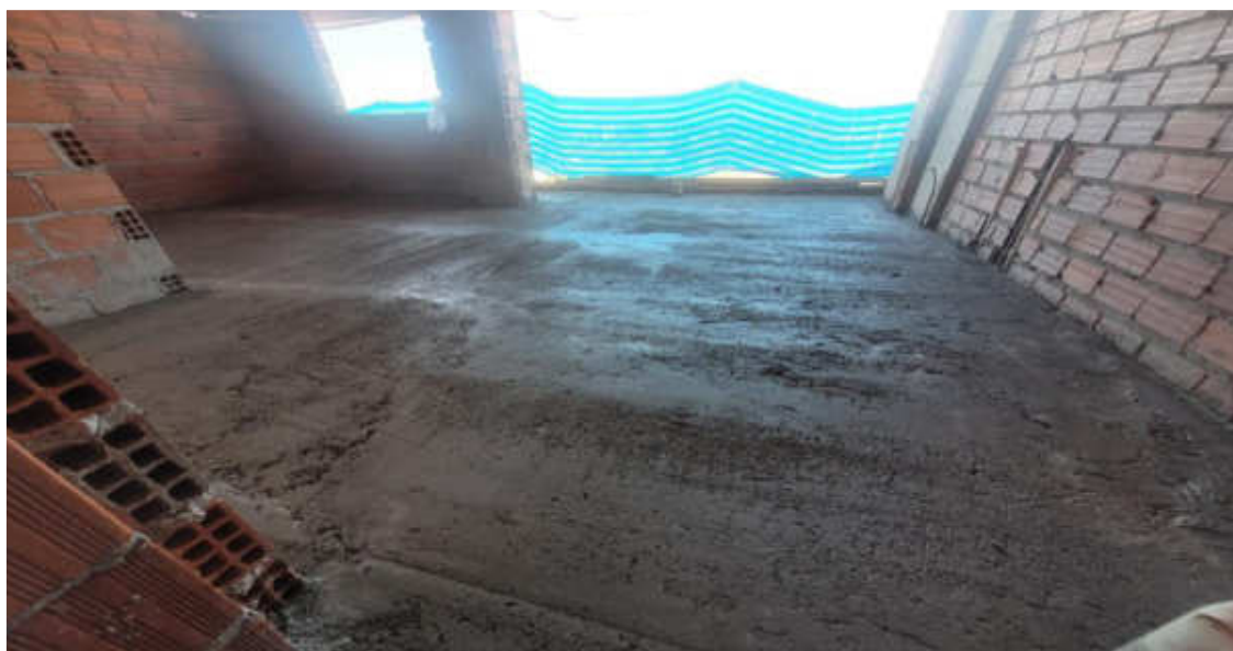
Contrapiso até 22° pavimento da Torre Lago – Julho 2026
