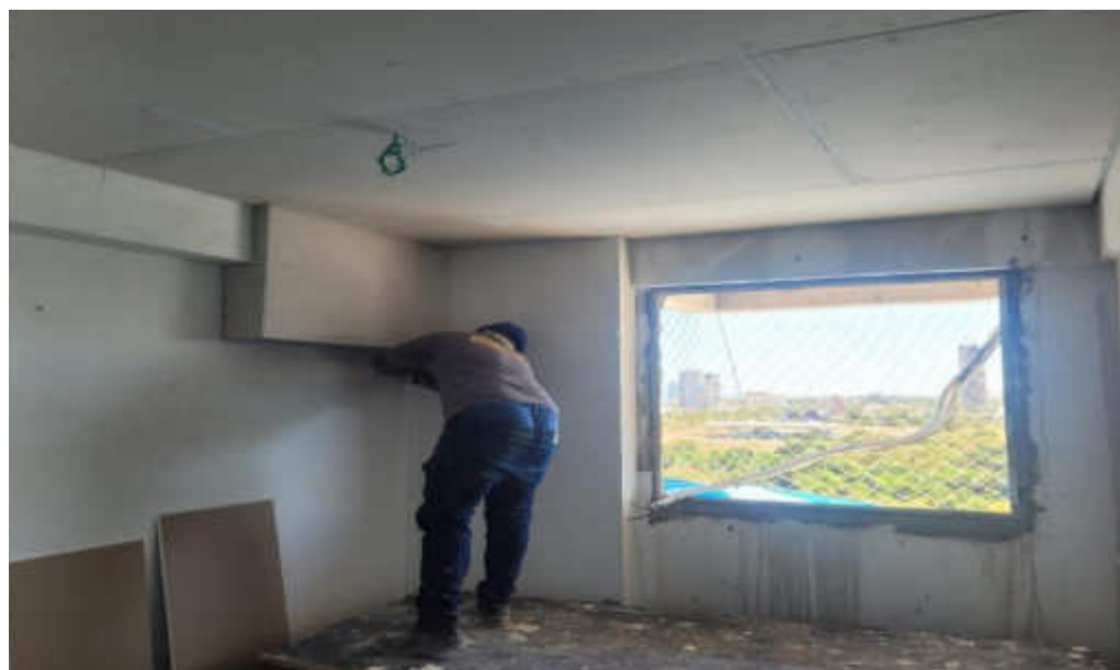
Forro de Gesso no 14º pavimento da Torre Lago – Julho 2026
