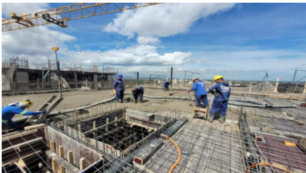
Estrutura do 32º pavimento da Torre Lago – Julho 2026
