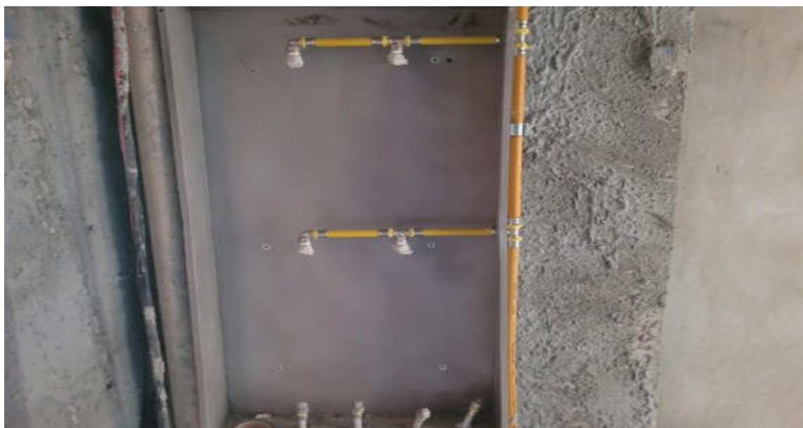
Prumadas de gás até o 12° pavimento da Torre Lago – Junho 2026
