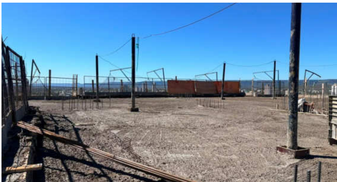
Estrutura do pavimento Penthouse da Torre Parque – Julho 2026
