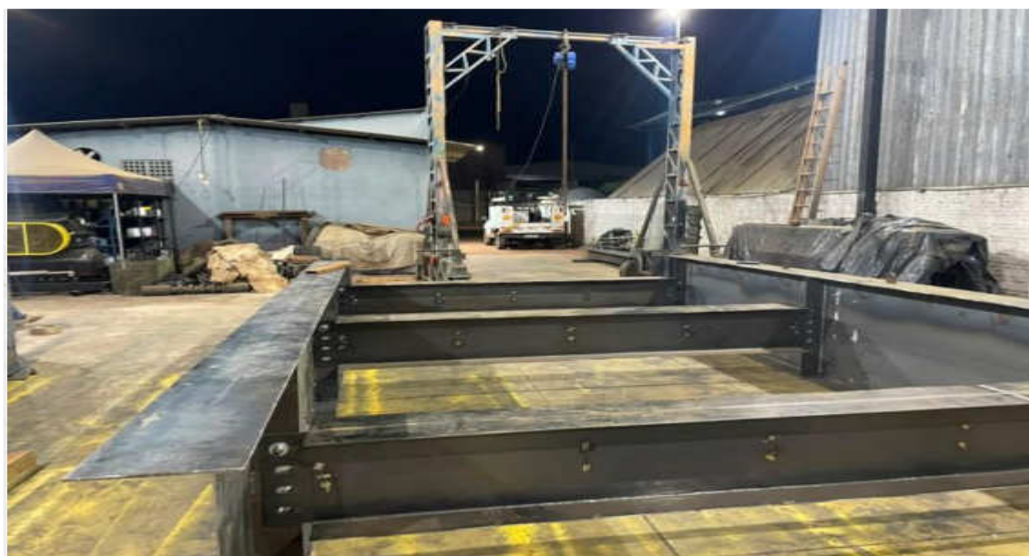
Confecção da passarela metálica – Junho 2026
