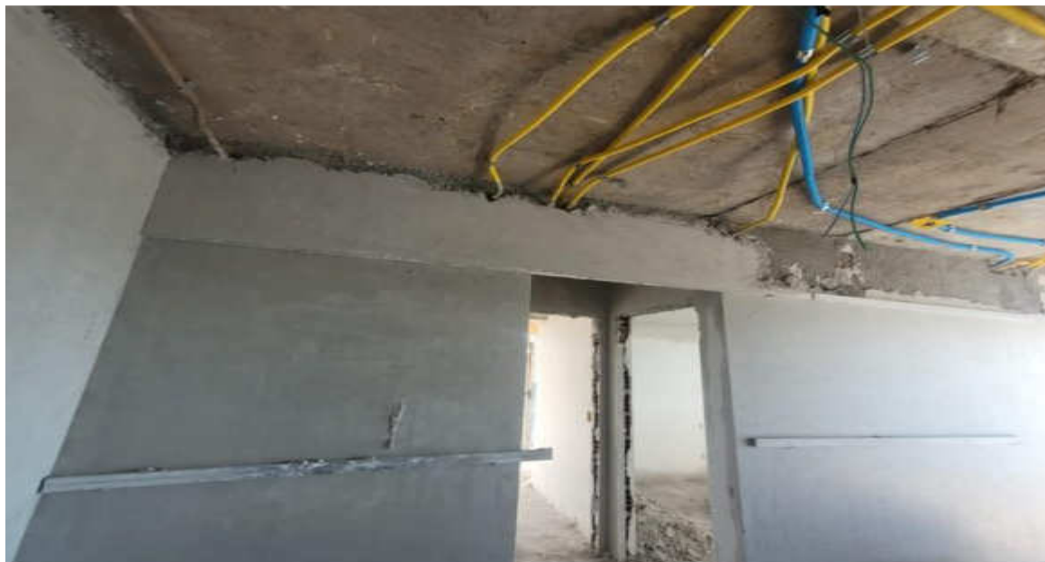
Gesso corrido até o 14° pavimento da Torre Lago – Maio 2026
