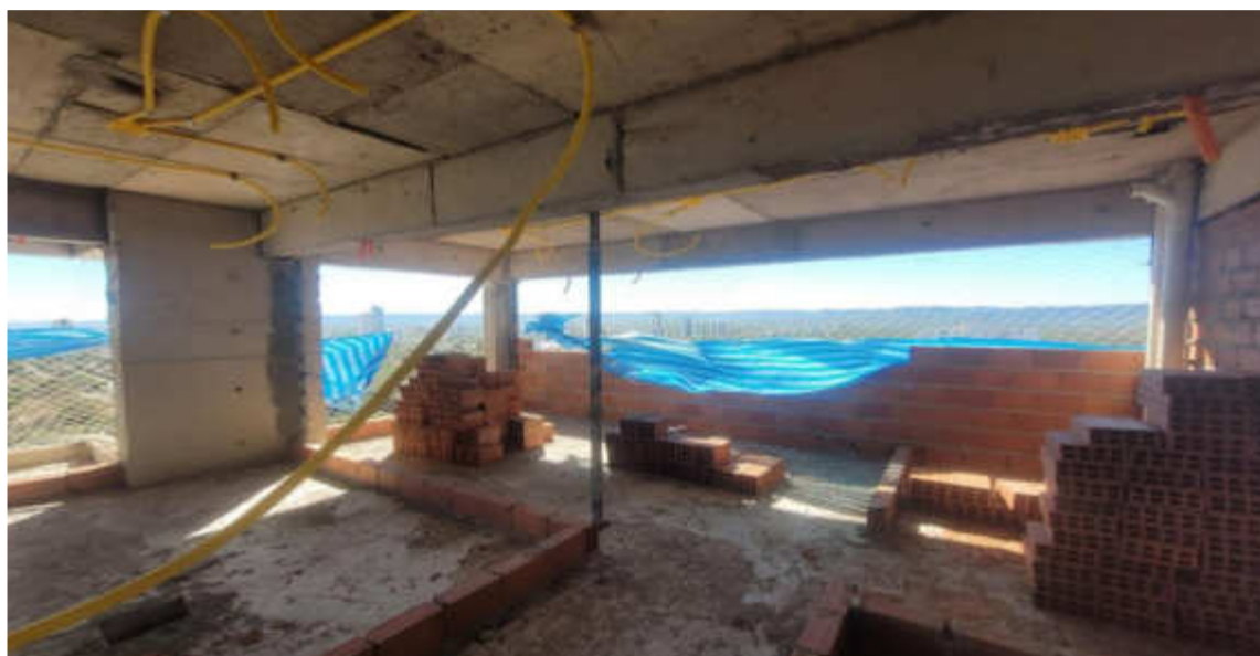
Alvenaria até o 26º pavimento da Torre Lago – Julho 2026
