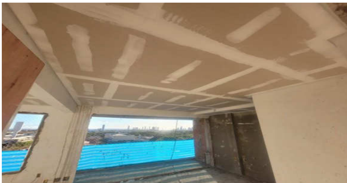
Forro até o 6° pavimento da Torre Lago – Maio 2026
