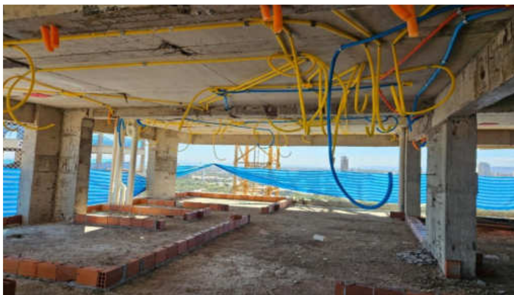
Instalações elétricas de teto até o 26º pavimento da Torre Parque – Julho 2026
