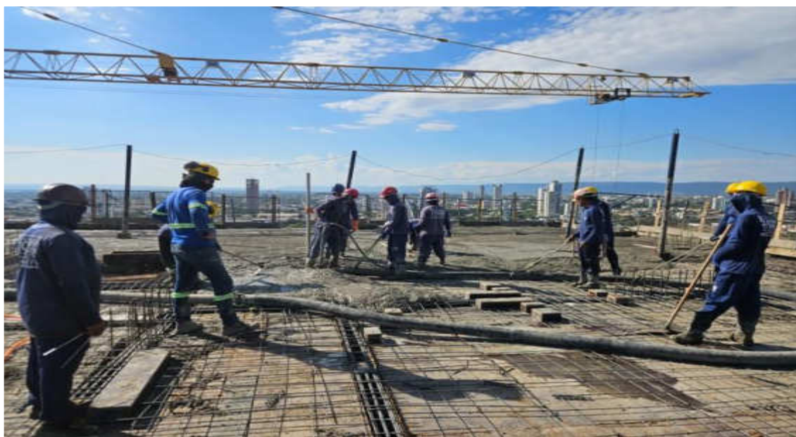
Estrutura do 32º pavimento da Torre Parque – Junho 2026
