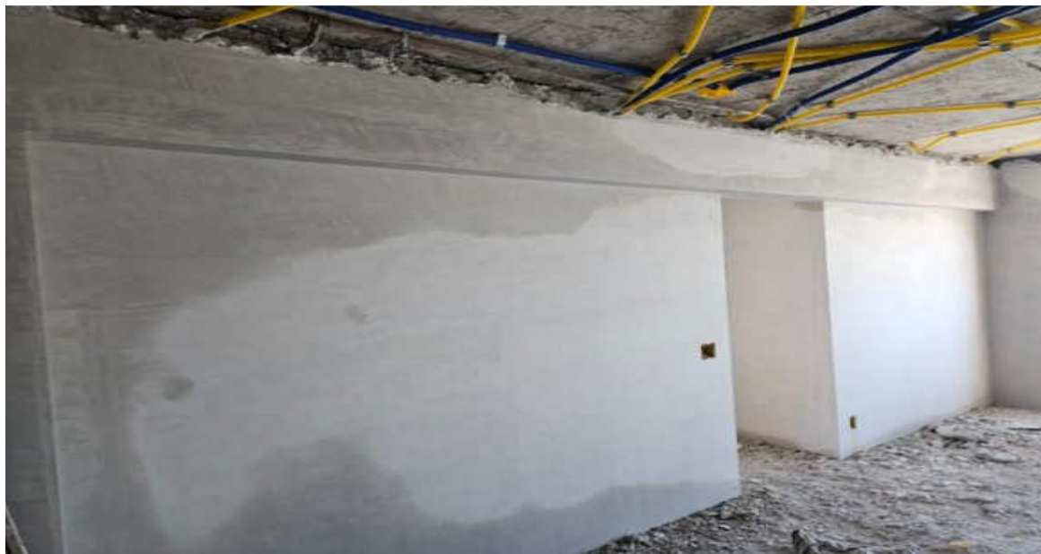
Gesso até o 6º pavimento da Torre Parque – Maio 2026
