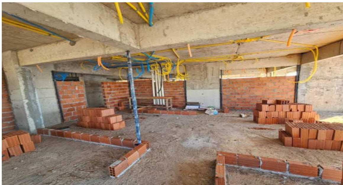
Alvenaria interna do 21º pavimento da Torre Parque – Junho 2026
