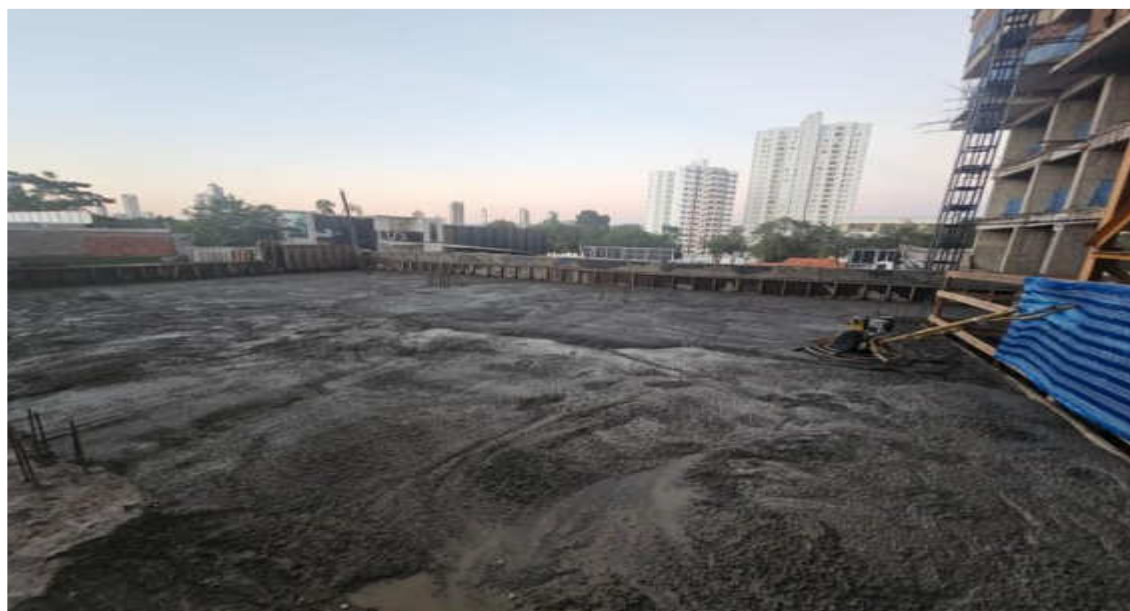
Concretagem da periferia do pavimento Garagem 2 da Torre Parque – Junho 2026
