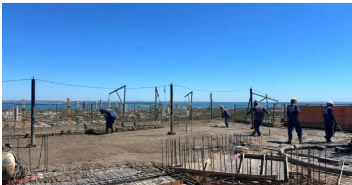
Estrutura do 33º pavimento da Torre Lago – Julho 2026
