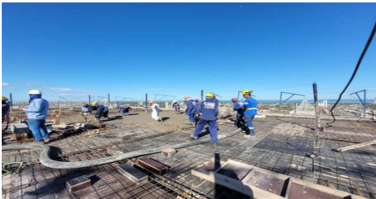
Estrutura do 26º pavimento – Torre Lago – Maio 2026
