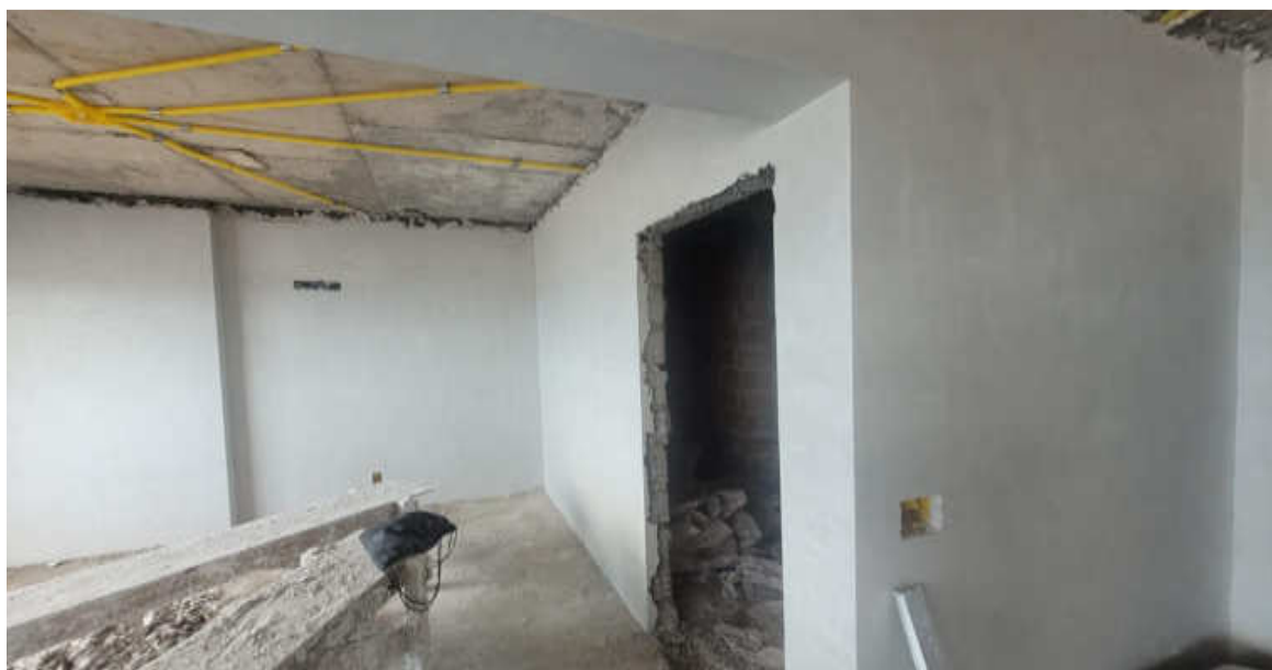
Gesso corrido nas paredes no 8º pavimento da Torre Parque – Julho 2026
