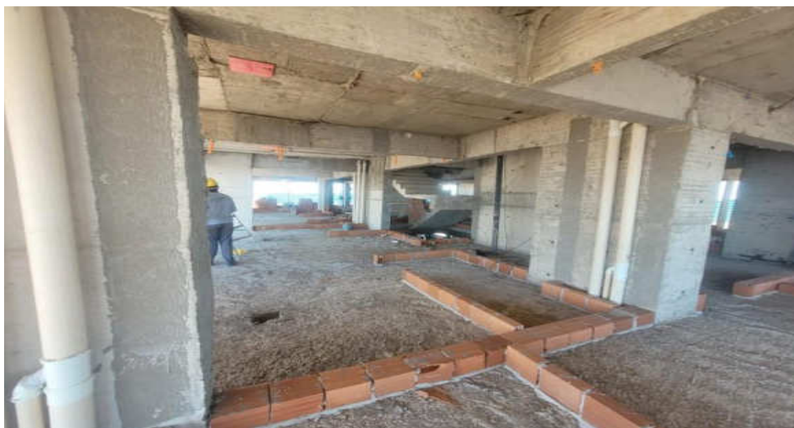
Marcação de Alvenaria até o 24° pavimento da Torre Lago – Junho 2026
