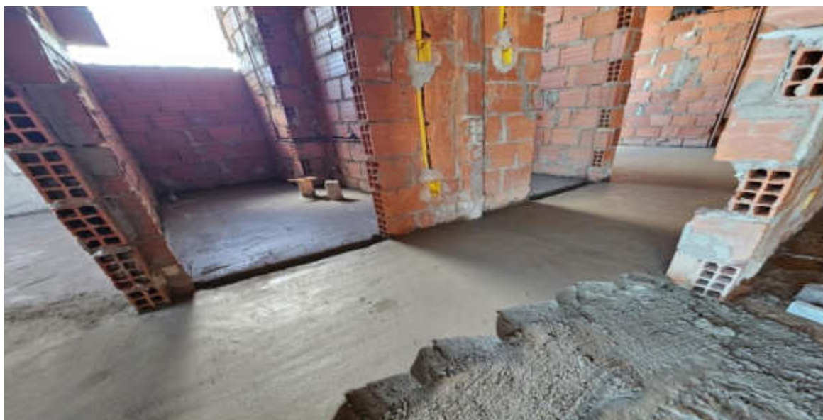
Contrapiso até o 15° pavimento da Torre Parque – Julho 2026
