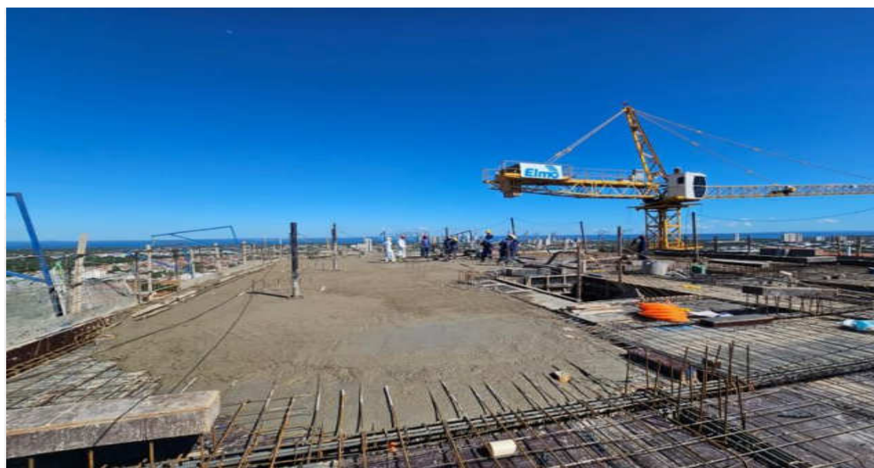
Estrutura do 27º pavimento da Torre Parque – Maio 2026
