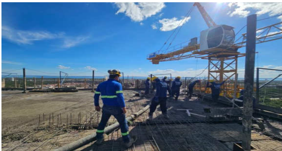
Estrutura do 30º pavimento da Torre Parque – Junho 2026
