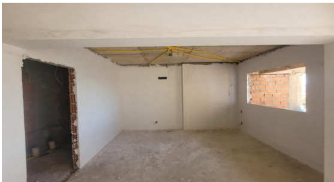
Gesso corrido até o 18° pavimento da Torre Lago – Julho 2026
