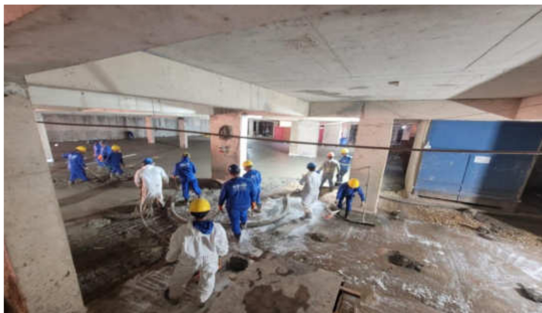
Estrutura do piso do subsolo da Torre Lago – Julho 2026
