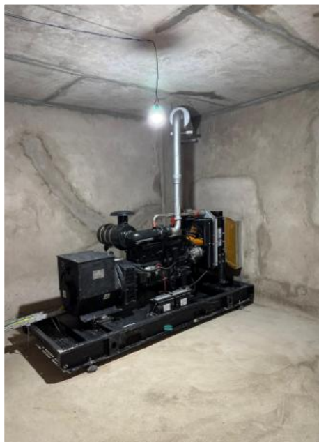
Instalação do gerador e motores da pressurização – Outubro 2025
