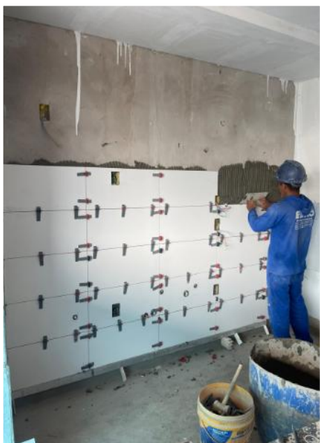
Assentamento de revestimento cerâmico (20° Pavimento) – Outubro de 2025
