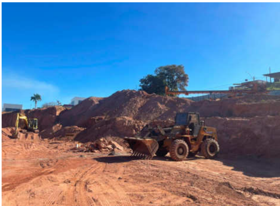
Escavação do terreno – Maio 2026
