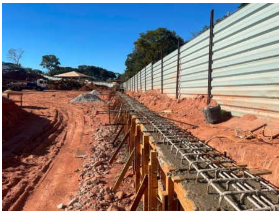
Concretagem da viga de coroamento da Rua Ituiutaba – Junho 2026
