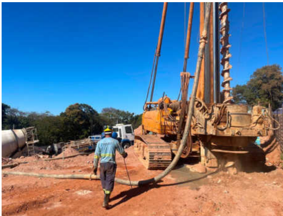
Execução de estaca hélice contínua (contenção - Rua Araxá) – Julho 2026
