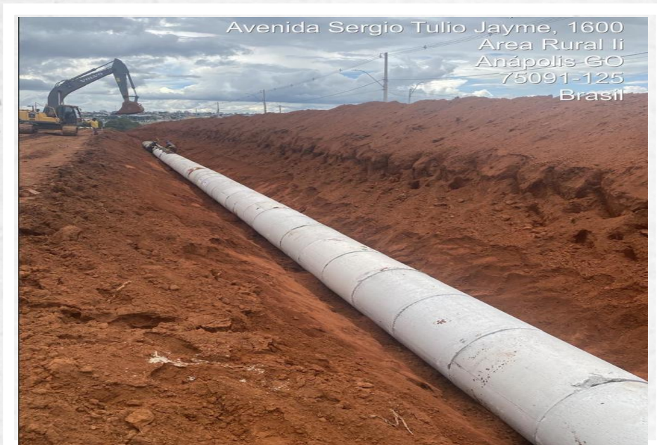
Montagem das Tubulações – Março 2026
