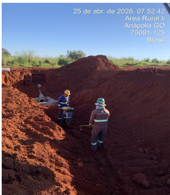
Reaterro e compactação dos ramais – Abril 2026
