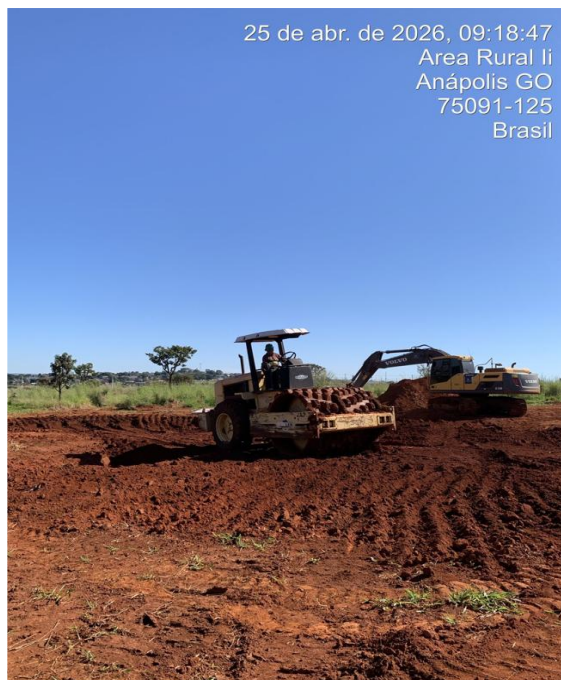
Reaterro e compactação dos ramais – Abril 2026
