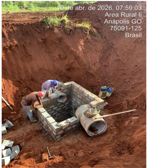
Execução da alvenaria dos poços de visita – Abril 2026
