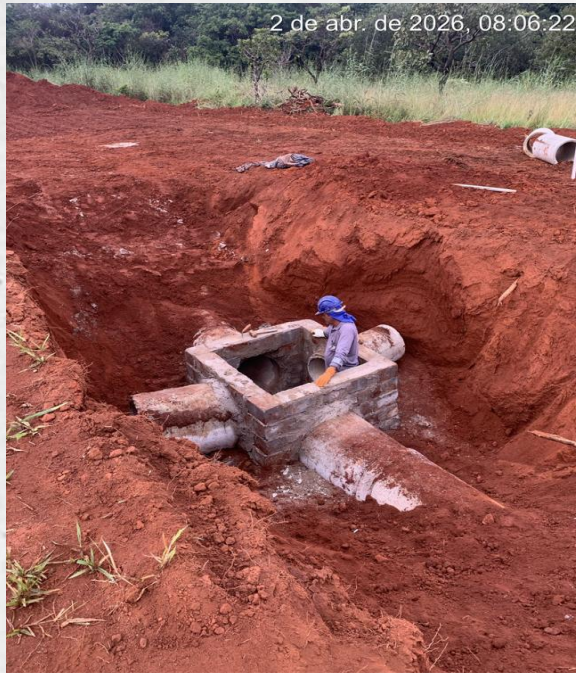
Execução da alvenaria dos poços de visita – Abril 2026
