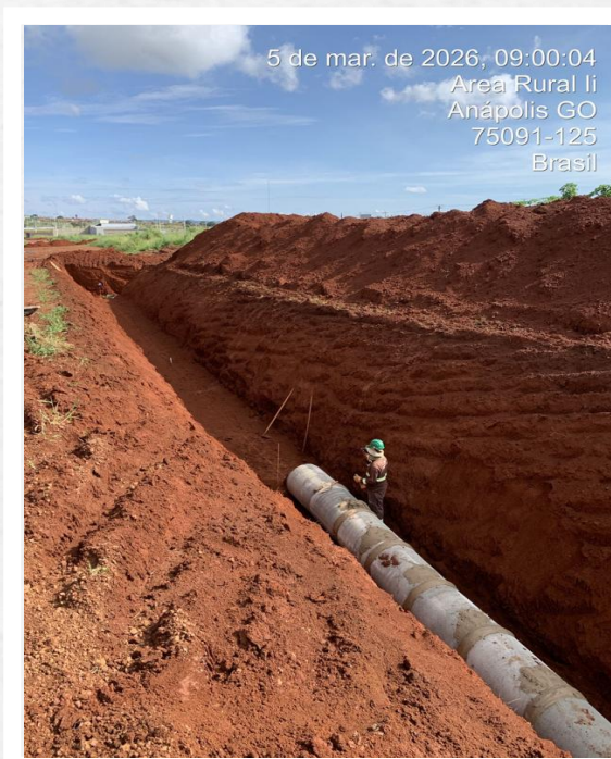
Montagem das tubulações e execução de poços de visitas – Março 2026
