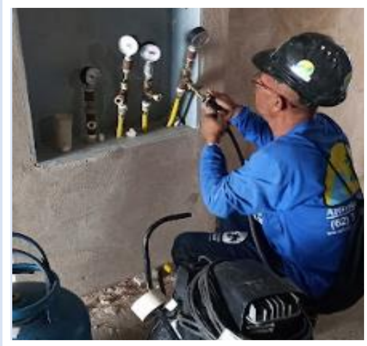
Teste de estanqueidade das instalações de gás do 21º pavimento da Torre Lua – Novembro 2024
