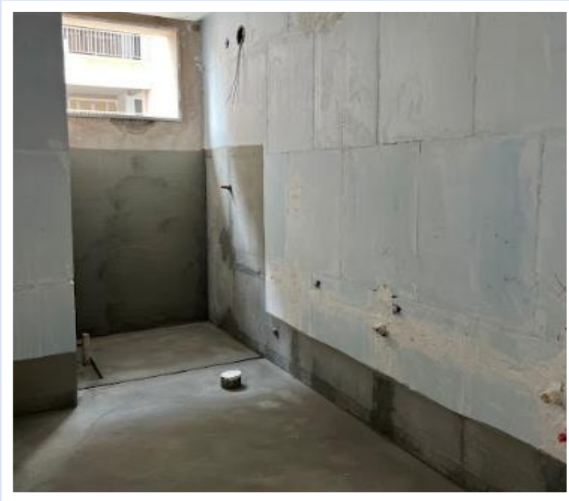
Impermeabilização do 30º pavimento da Torre Lua – Novembro 2024
