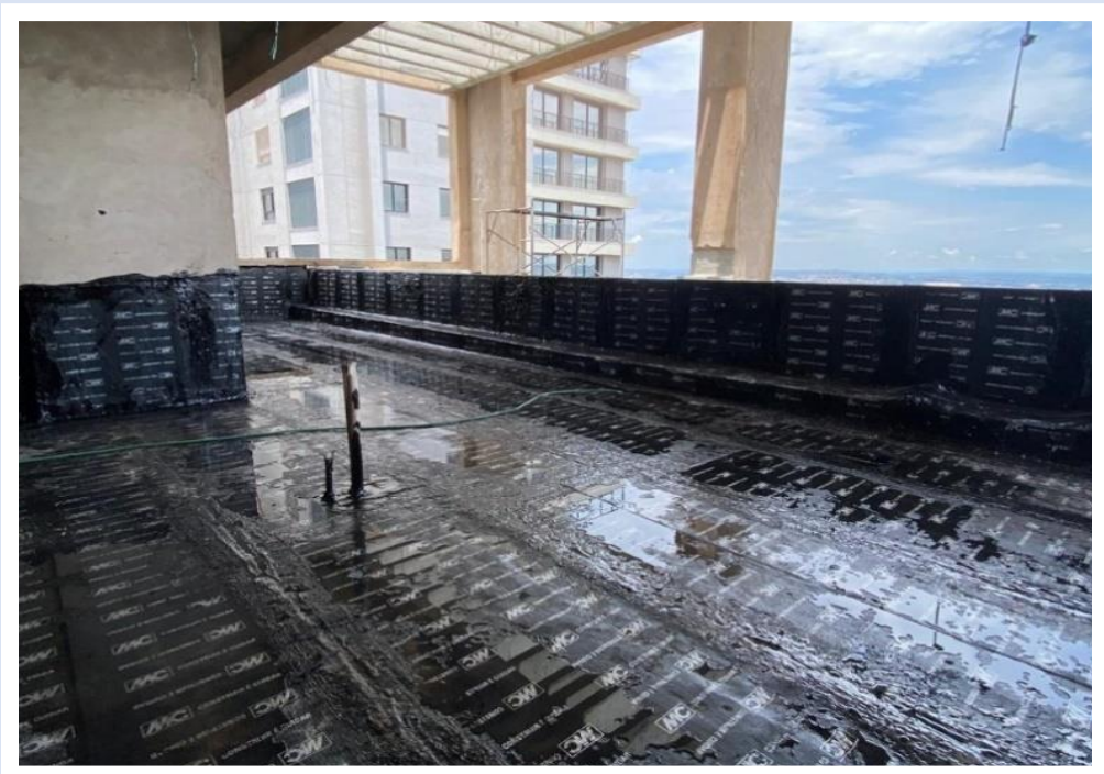
Impermeabilização do deck do rooftop da Torre Sol – Novembro 2024
