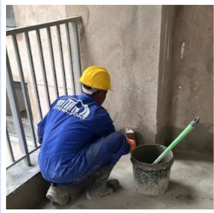
Impermeabilização do 26º pavimento da Torre Sol – Novembro 2024
