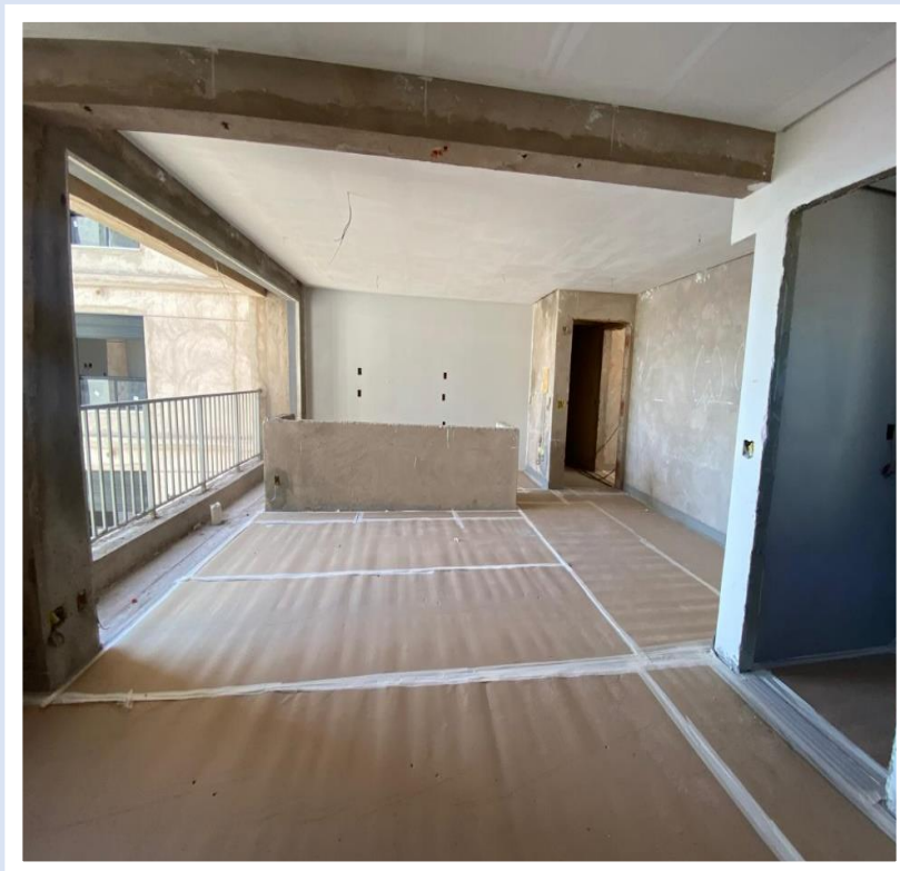
Rejuntamento e proteção de piso do 32º pavimento da Torre sol – Novembro 2024
