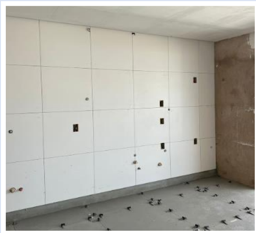
Revestimento cêramico do piso 32º pavimento da Torre Lua – Dezembro 2024
