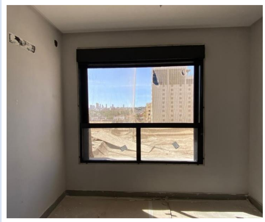
Instalação de esquadria do 21º pavimento da Torre Lua – Janeiro 2025
