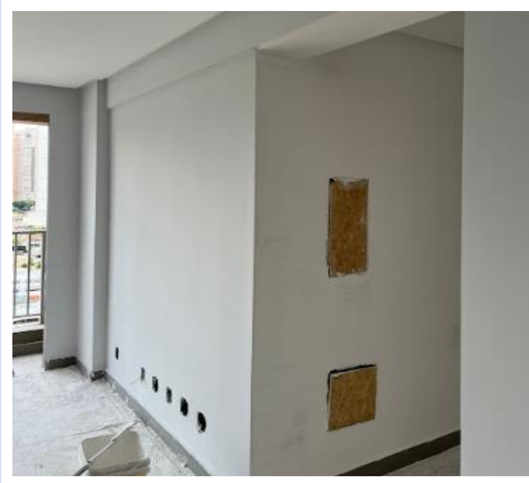
Emassamento e primeira demão de pintura do 16º pavimento da Torre Lua – Novembro 2024
