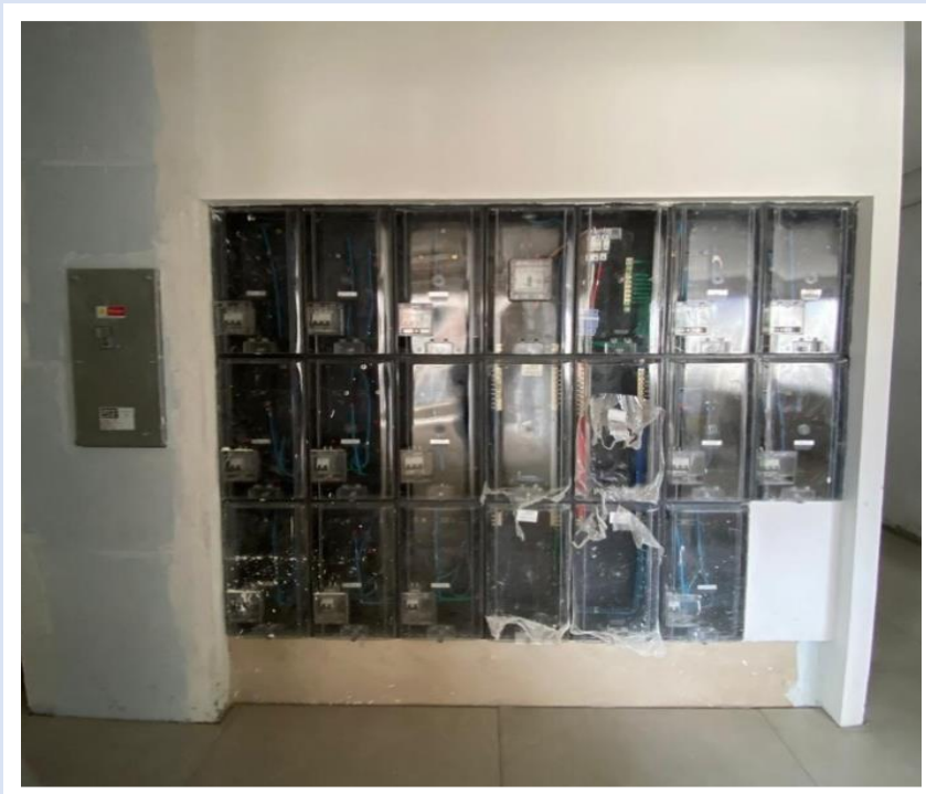
Montagem do centro de medição do 13º pavimento da Torre Sol – Janeiro 2025
