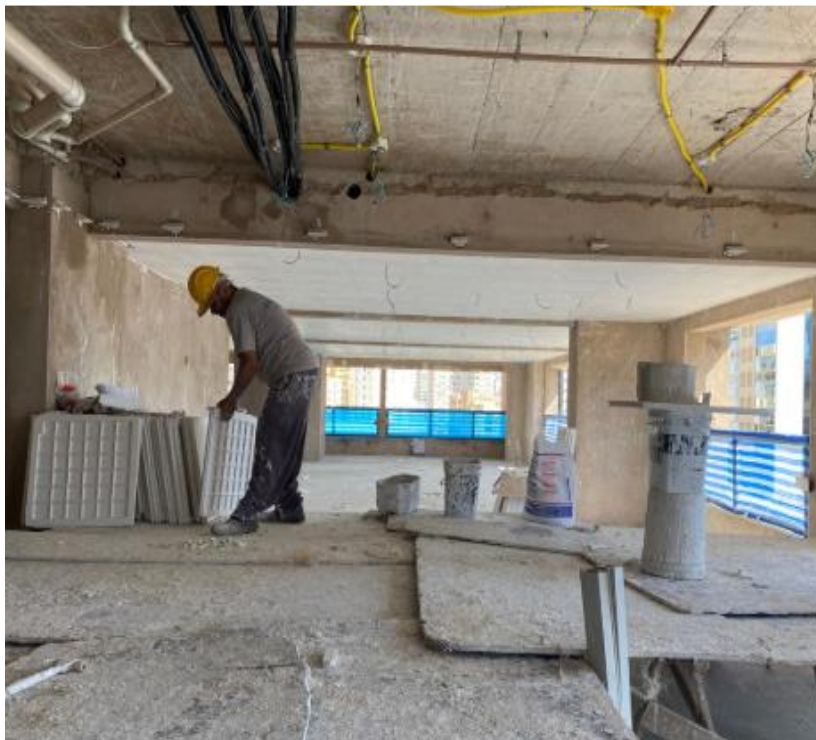
Execução de forro de gesso do pavimento lazer – Janeiro 2025
