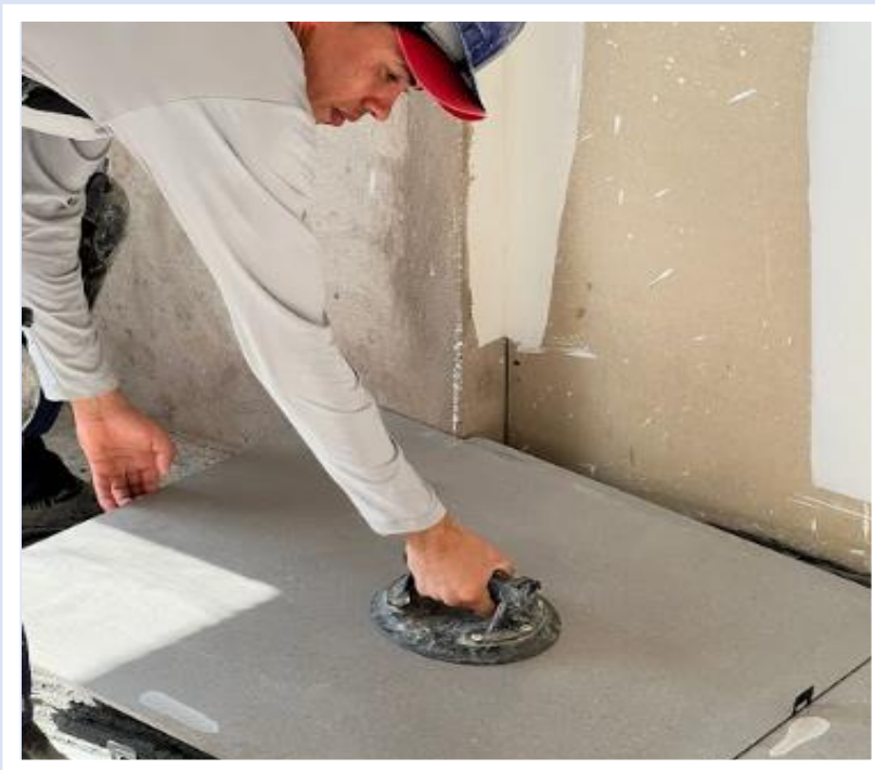
Revestimento cerâmico do 27º pavimento da Torre Lua – Novembro 2024
