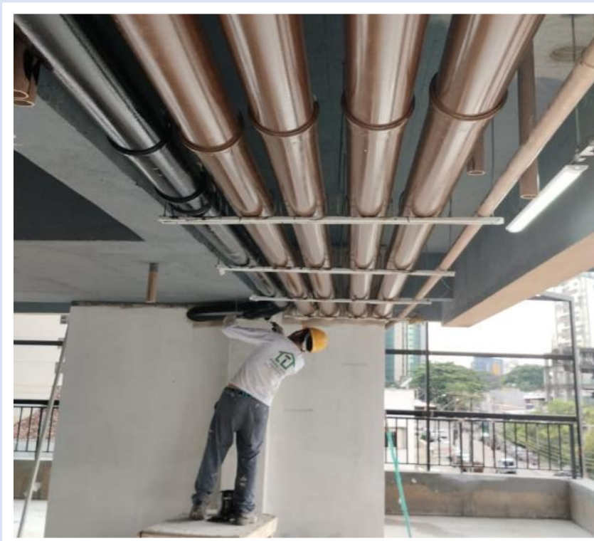
Pintura de teto e tubulações do pavimento de garagem 3 – Janeiro 2025
