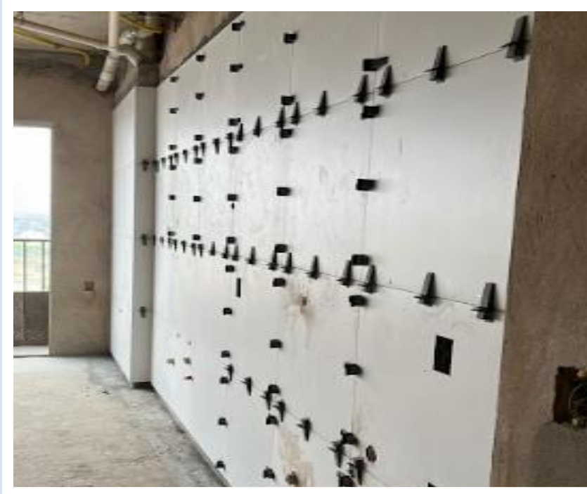
Revestimento cêramico de piso do 34º pavimento da Torre Sol – Dezembro 2024
