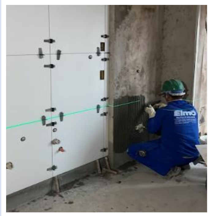
Revestimento cêramico do 29º pavimento da Torre Sol – Novembro 2024
