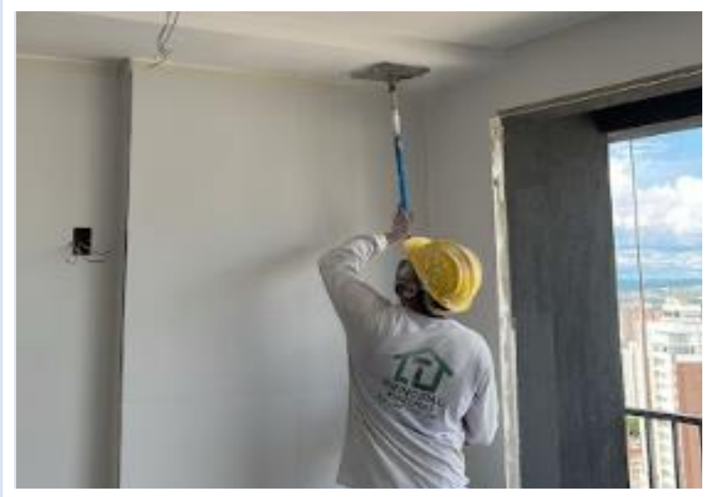
Emassamento do 25º pavimento da Torre Sol – Novembro 2024
