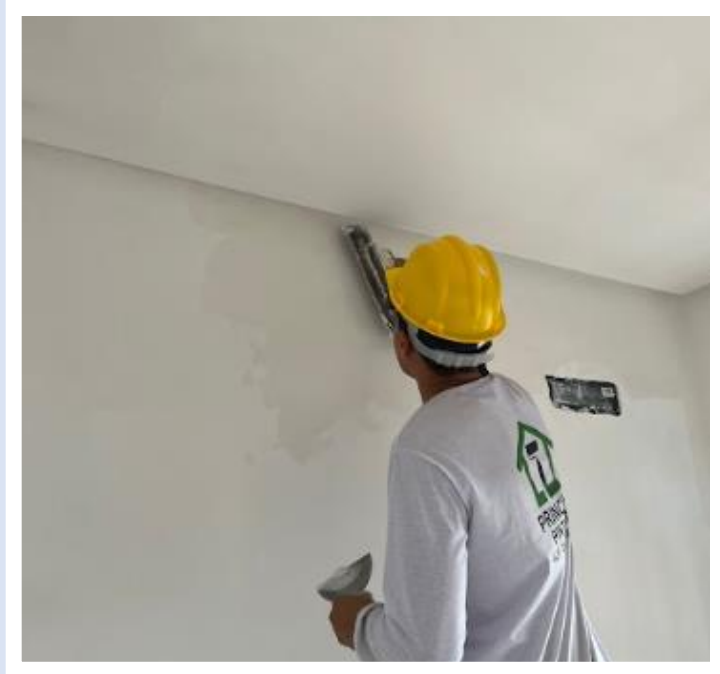
Emassamento do 15º pavimento da Torre Lua – Novembro 2024
