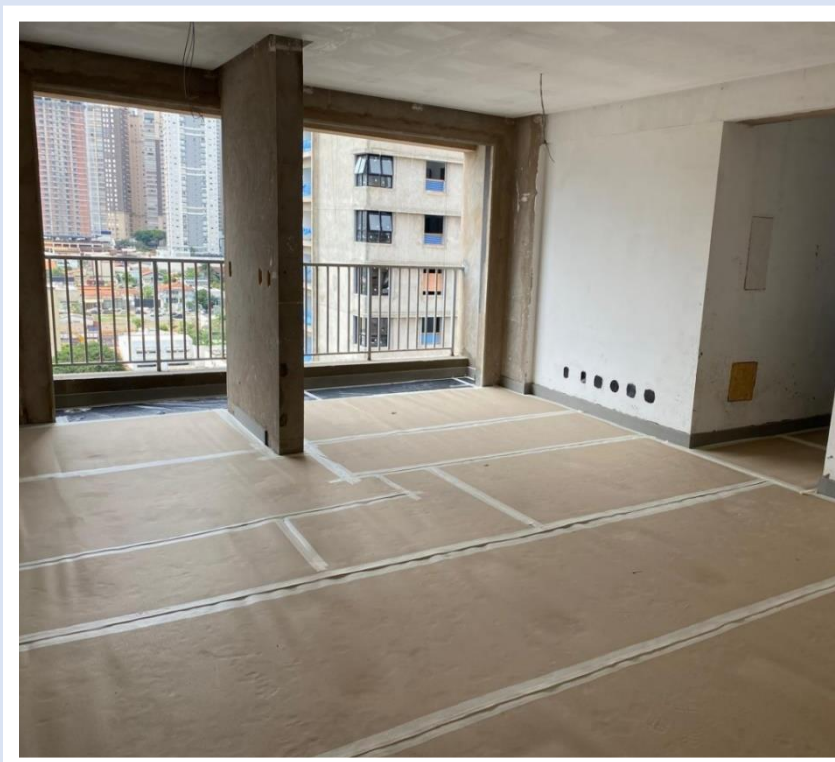
Proteção do piso do 20º pavimento da Torre Lua – Janeiro 2025
