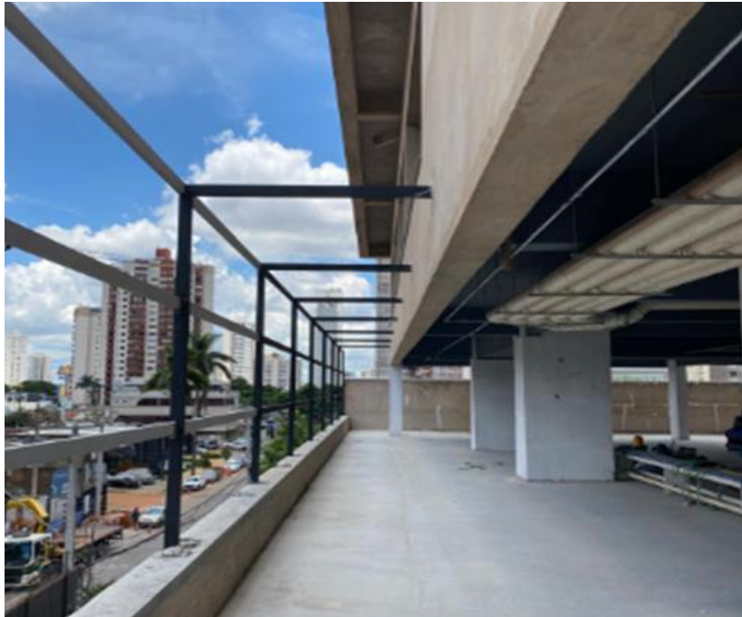
Estrutura metálica para o brise da fachada – Janeiro 2025
