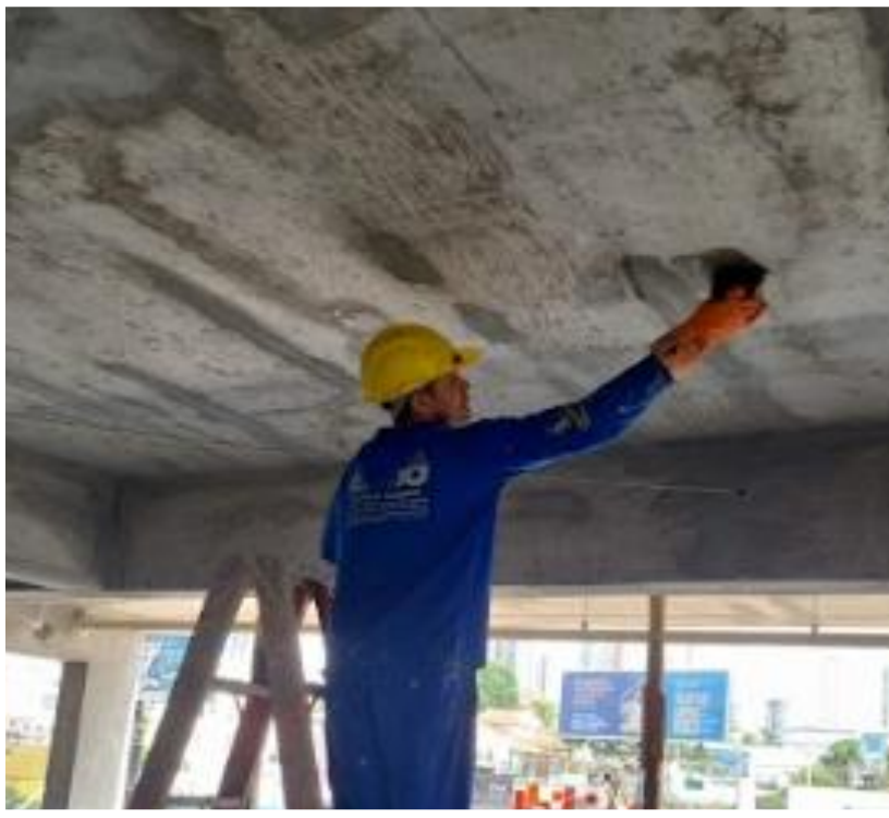
Tratamento de teto no pavimento garagem 2 – Novembro 2024
