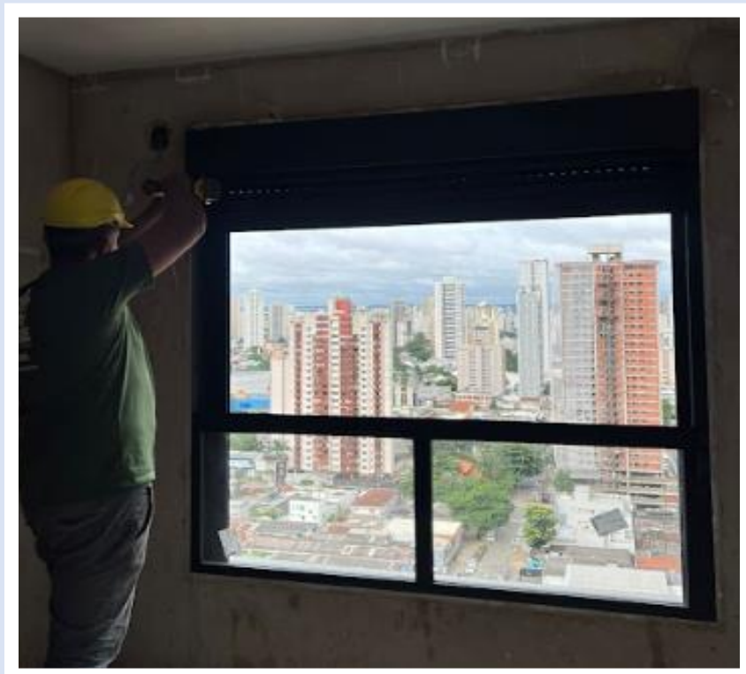
Instalação de esquadria do 23º pavimento da Torre Lua – Janeiro 2025
