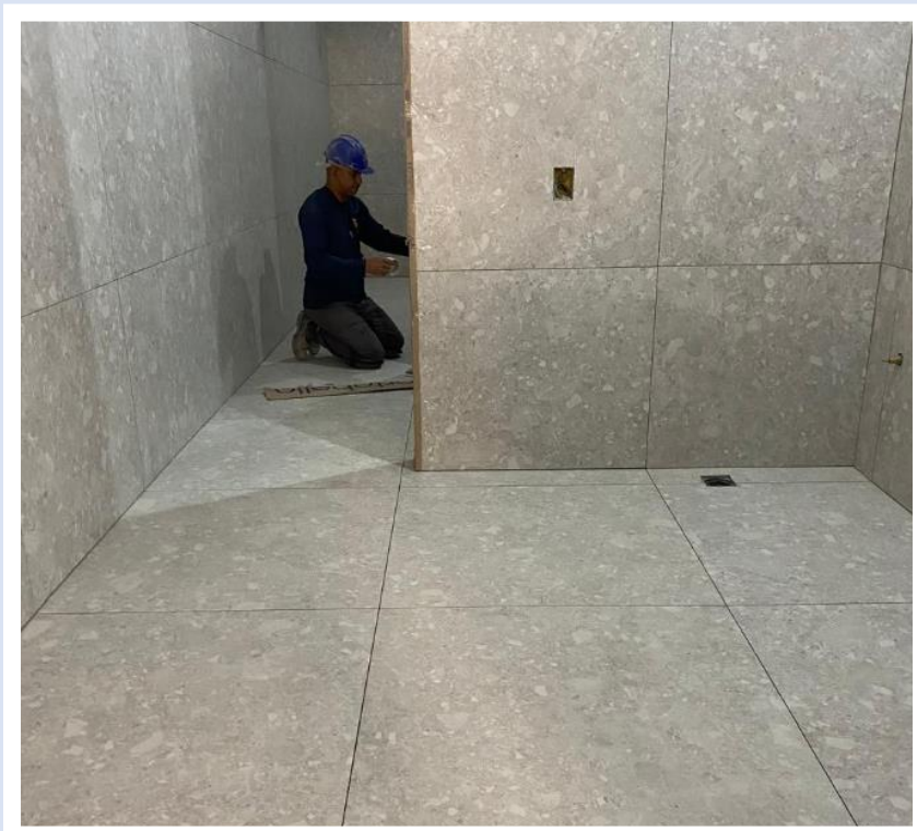
Revestimento ceramico do salão de festas do pavimento lazer – Janeiro 2025
