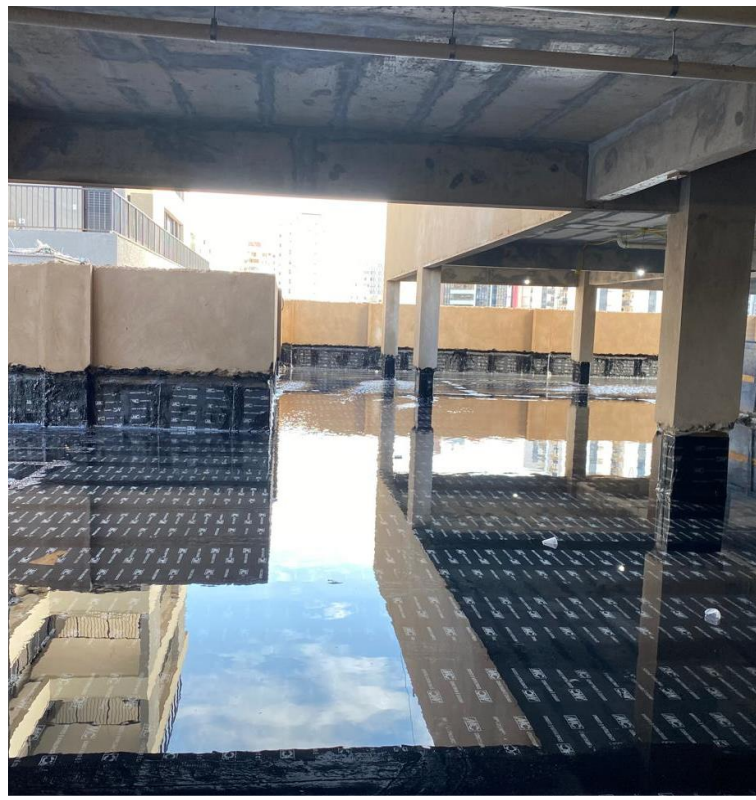
Teste de estanqueidade do pavimento garagem 2 – Novembro 2024
