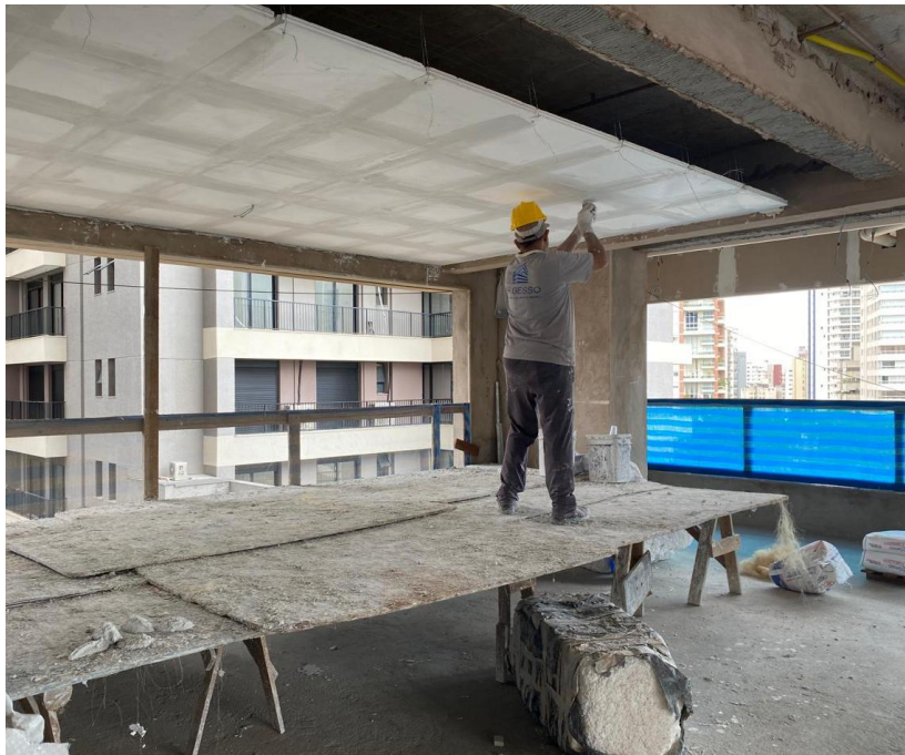
Execução de forro de gesso do pavimento lazer – Janeiro 2025
