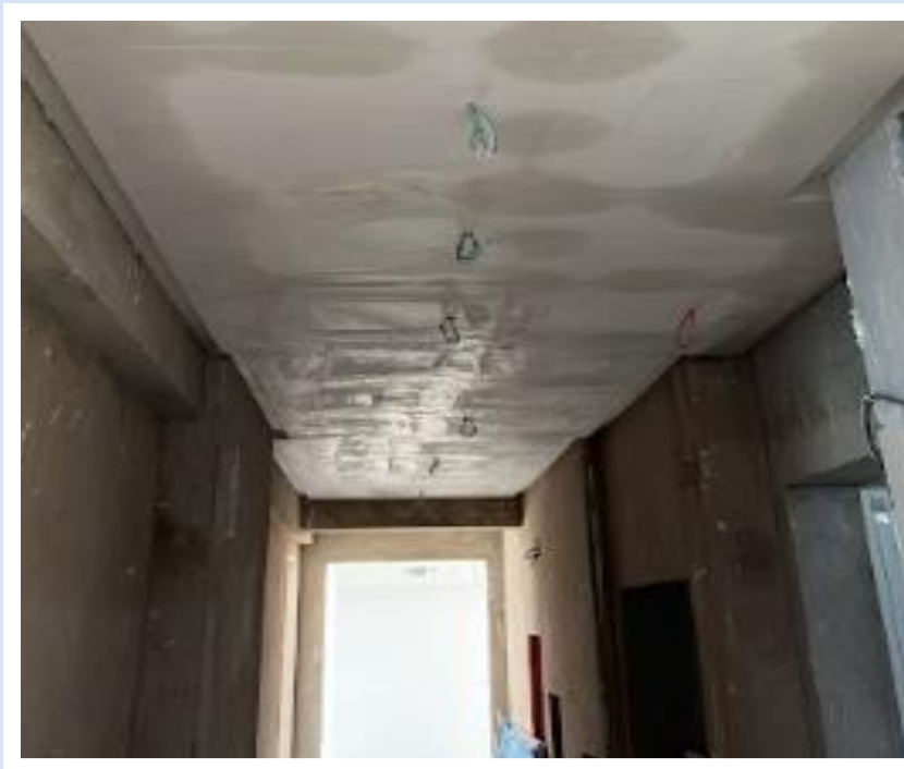
Forro de gesso do hall do 26º pavimento da Torre Sol – Janeiro 2025
