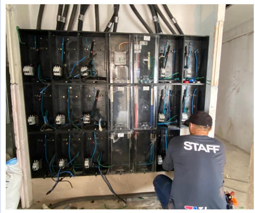
Montagem do centro de medição do 9º pavimento da Torre Sol – Janeiro 2025
