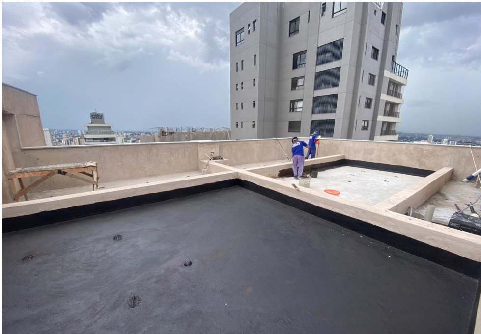
Aplicação de pintura anti-raiz na cobertura da Torre Sol – Novembro 2024
