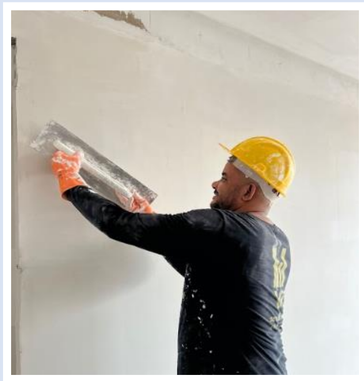
Acabamento de gesso do 30º pavimento da Torre Lua – Novembro 2024
