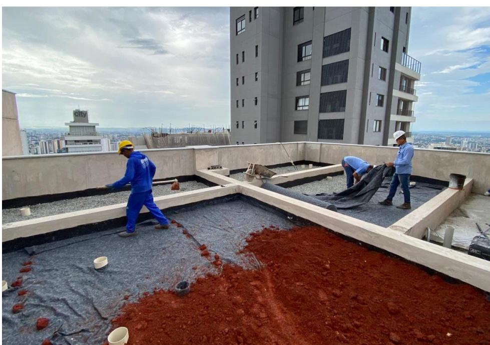
Execução de drenagem para cobertura vegetal da Torre Sol – Novembro 2024
