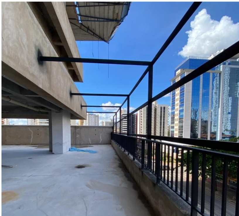
Estrutura metálica para o brise da fachada – Janeiro 2025
