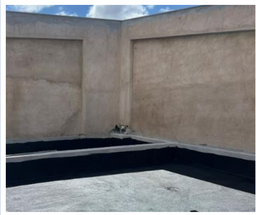
Aplicação de pintura anti-raiz na cobertura da Torre Lua – Janeiro 2025
