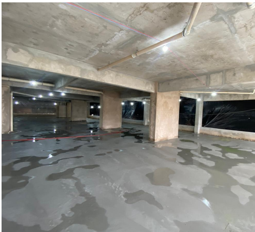
Polimento do piso da garagem 2 da área comum – Novembro 2024
