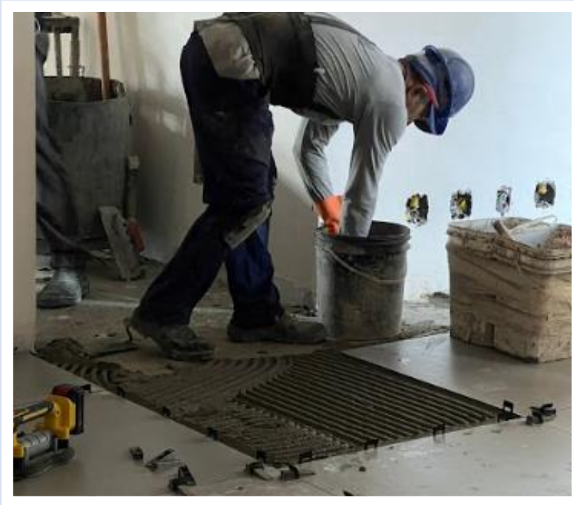
Revestimento cerâmico do 26º pavimento da Torre Lua – Novembro 2024
