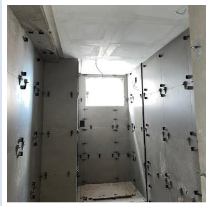
Revestimento cerâmico do 29º pavimento da Torre Lua – Novembro 2024
