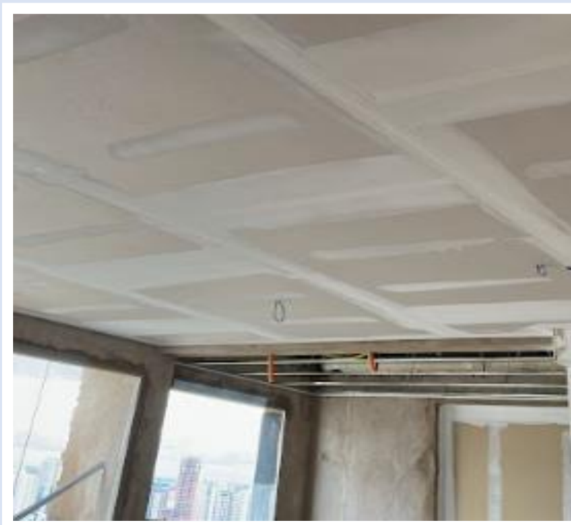
Forro acústico do 34º pavimento da Torre Sol – Janeiro 2025
