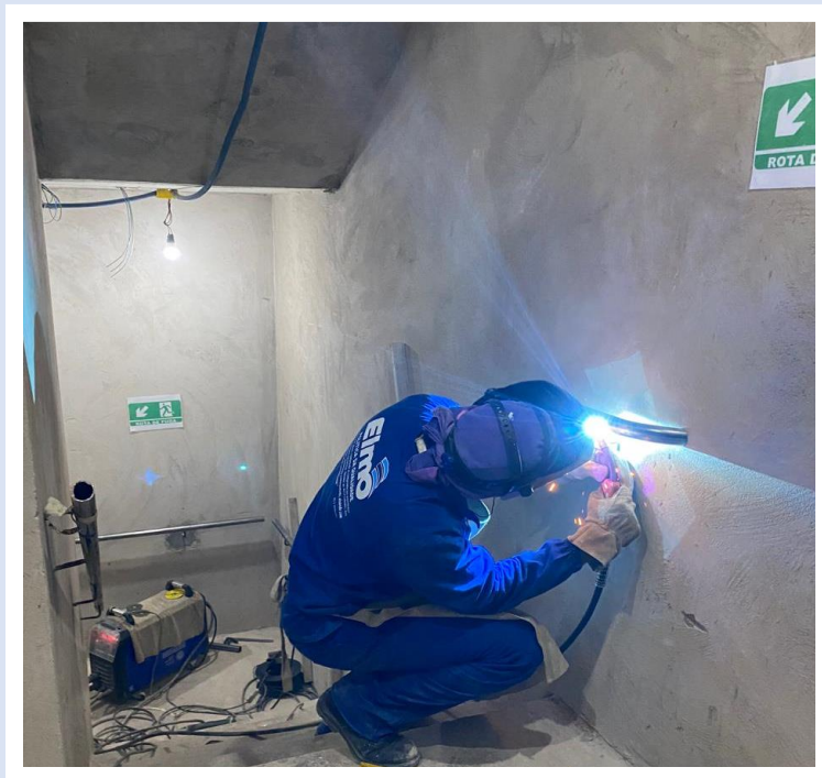
Instalação dos corrimãos do 31º pavimento da Torre Lua – Novembro 2024
