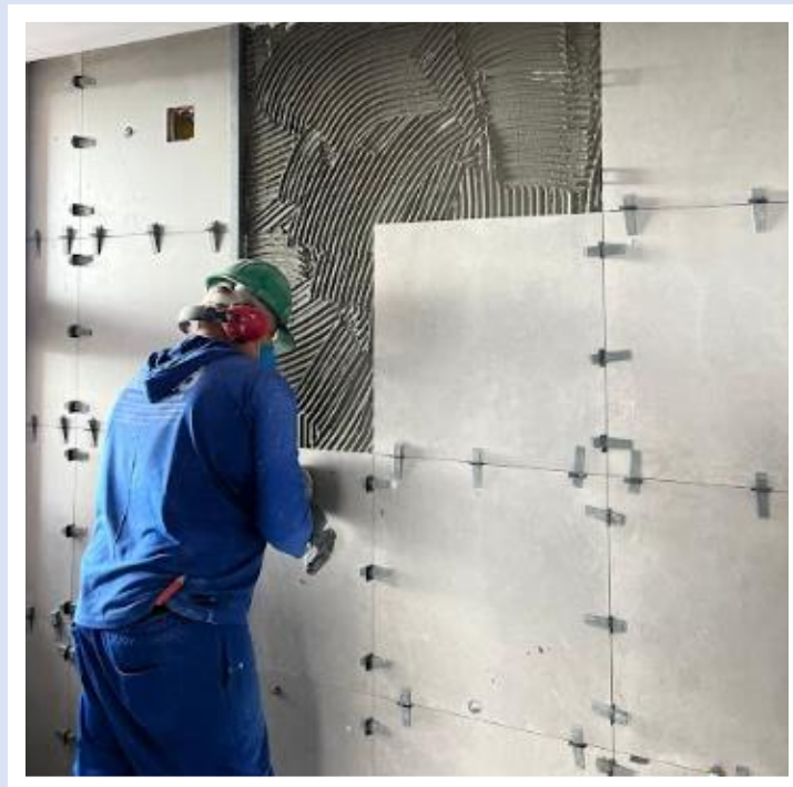
Revestimento cerâmico do 32º pavimento da Torre Lua – Novembro 2024
