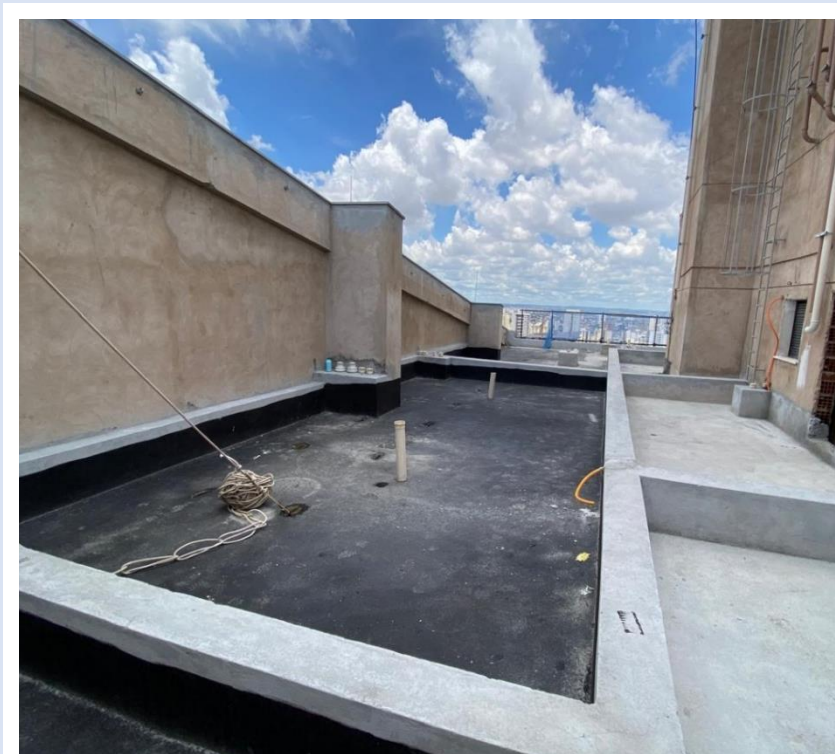
Aplicação de pintura anti-raiz na cobertura da Torre Lua – Janeiro 2025
