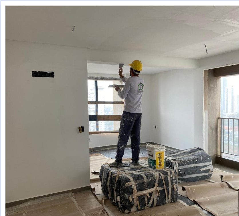
Emassamento do 26º pavimento da Torre Sol – Dezembro 2024
