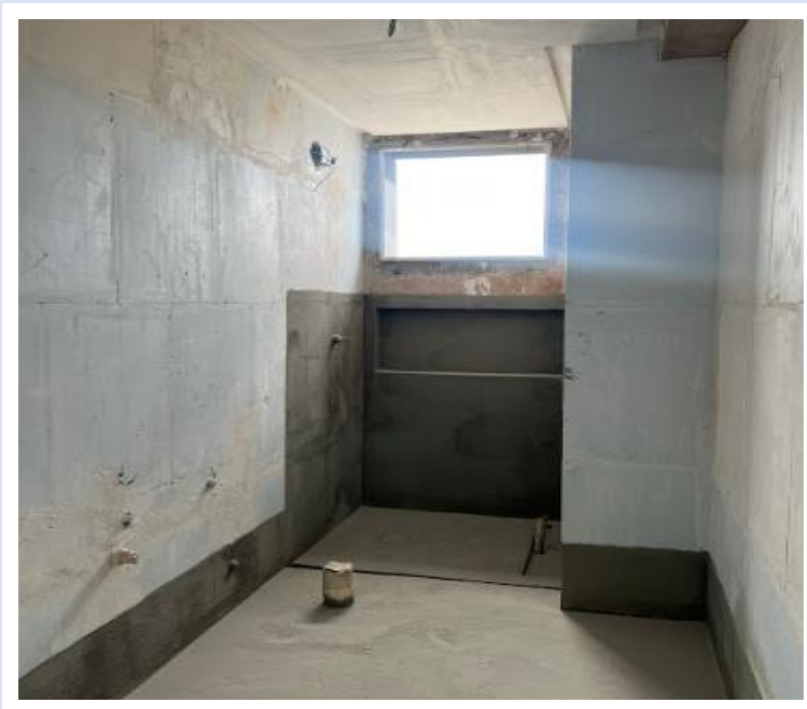
Impermeabilização do 32º pavimento da Torre Lua – Novembro 2024
