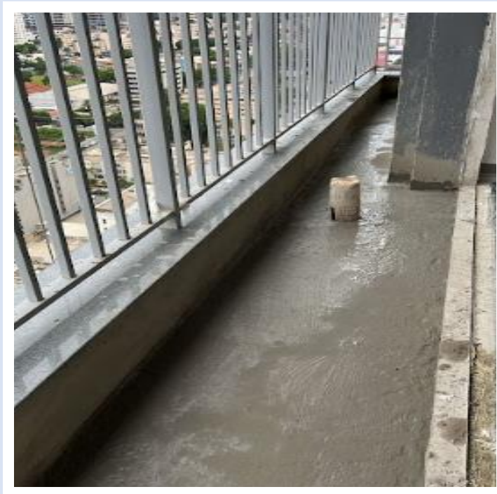
Impermeabilização do 27º pavimento da Torre Sol – Novembro 2024
