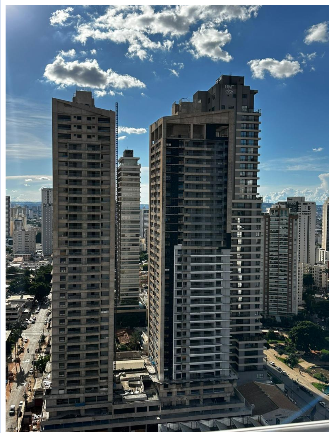
Fachada da Torre Lua e Torre Sol – Janeiro 2025
