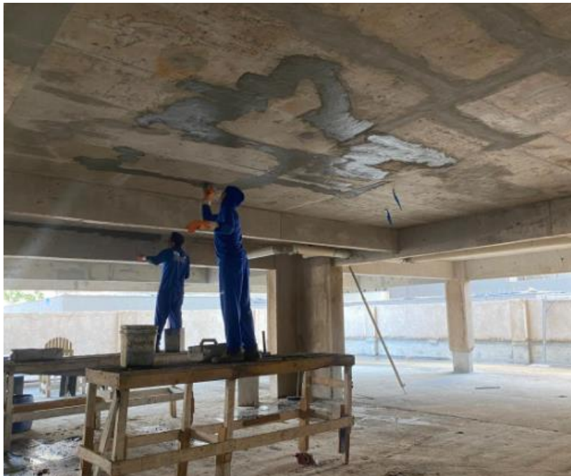
Tratamento de teto no pavimento garagem 2 – Novembro 2024
