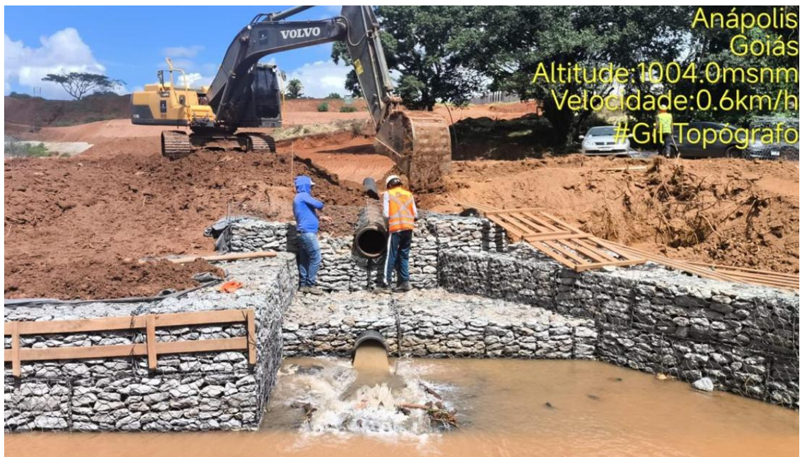
Execução de estrutura de lançamento (Dissipadores) – Fevereiro / Março 2026
