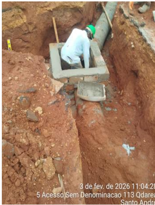
Execução de PVs da galeria pluvial / Instalação das tampas dos PV's da galeria pluvial – Fevereiro 2026
