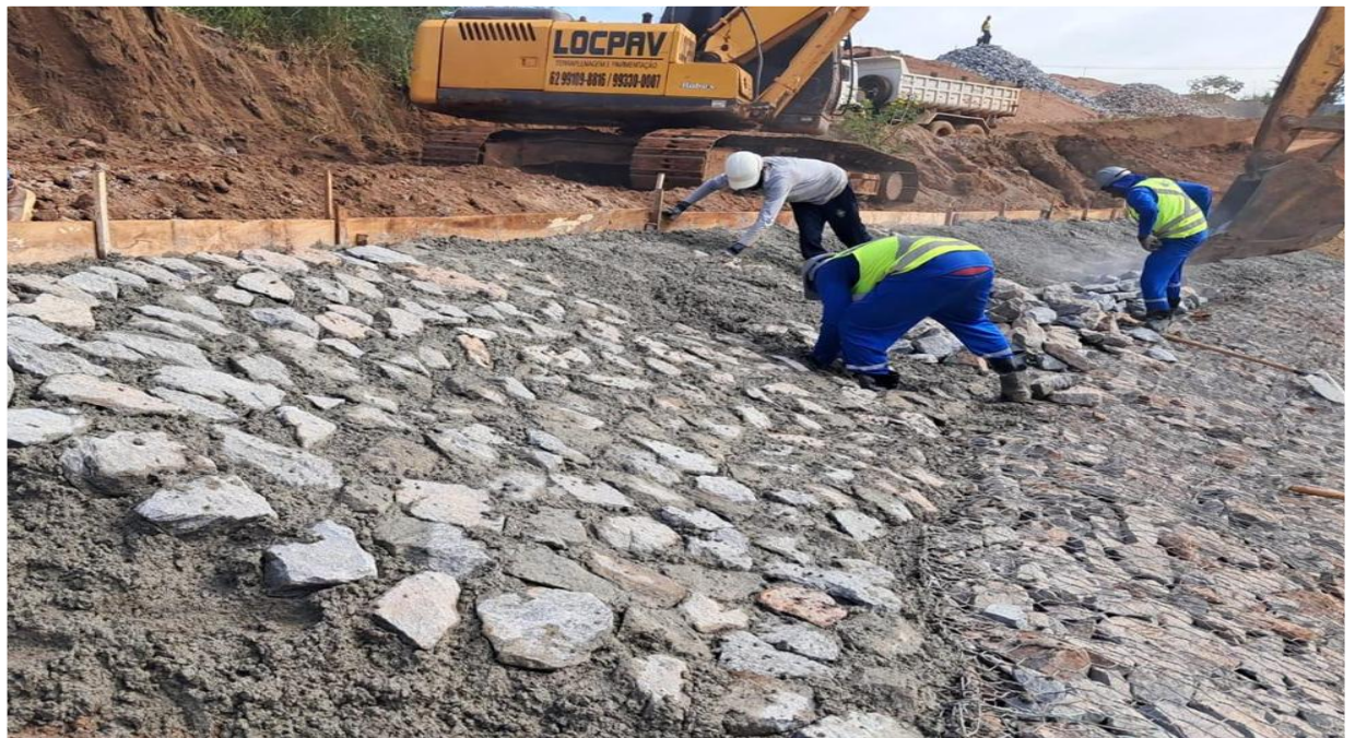
Execução pedra argamassada do lago – Abril 2026
