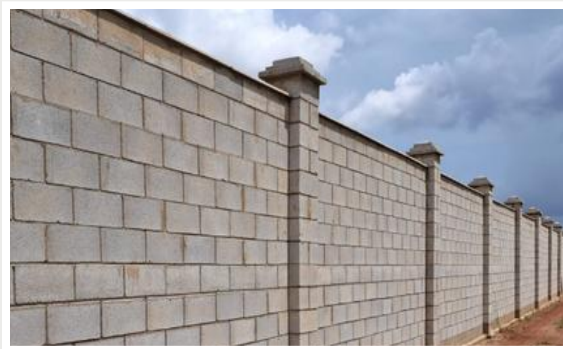
Execução do muro de fechamento com gradil – Fevereiro 2026
