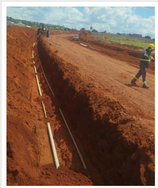
Execução de rede interna de água e esgoto – Março 2026
