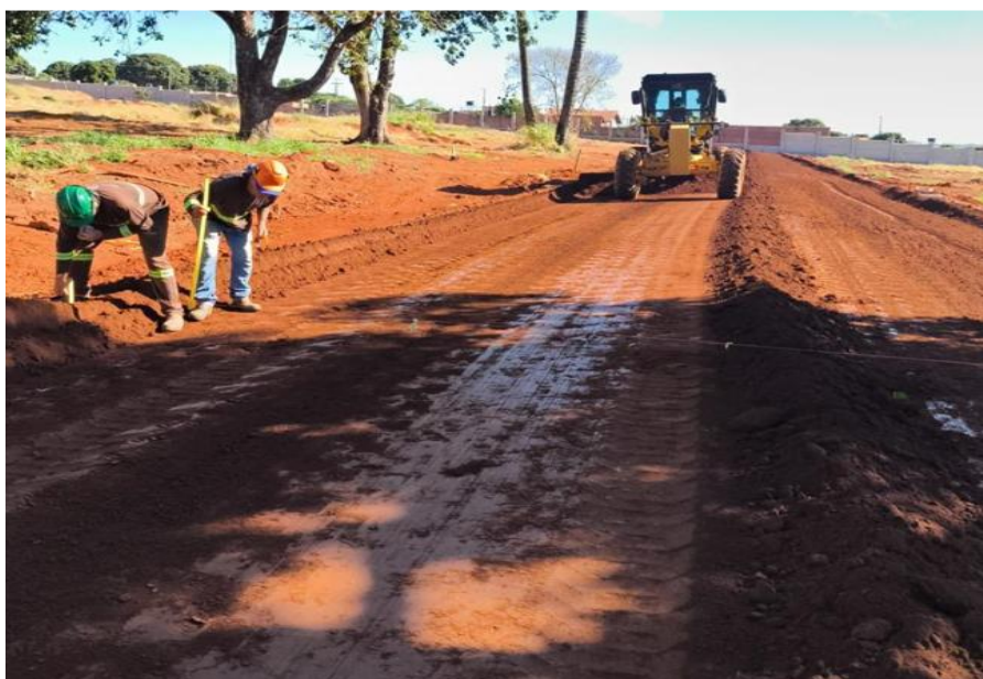
Pavimentação - Regularização e compactação do subleito – Março 2026
