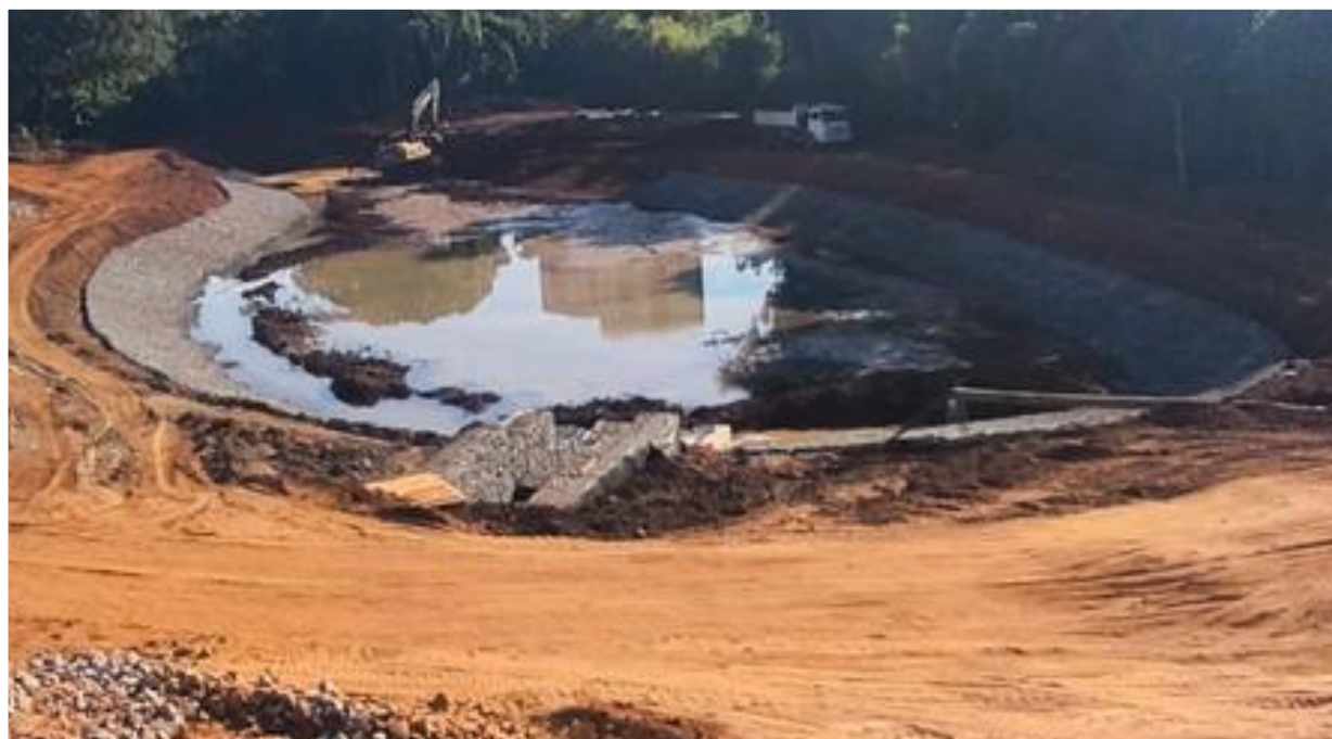
Escavações e acabamento do lago – Abril 2026
