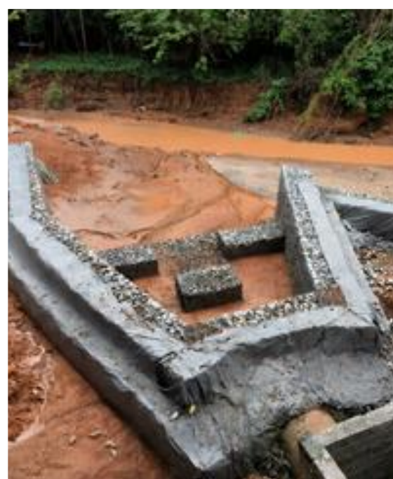
Execução de estruturas de lançamentos - Março 2026
