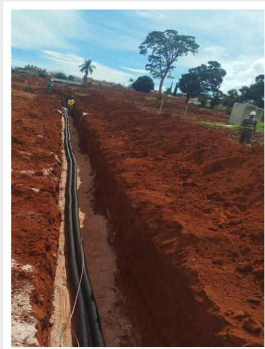
Execução de rede elétrica, iluminação pública e telecomunicação subterrâneo – Fevereiro 2026
