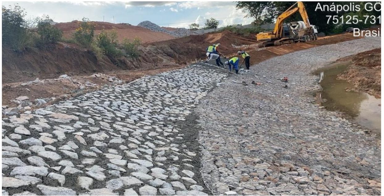
Instalação do colchão reno do lago – Abril 2026
