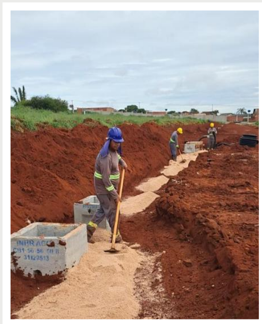
Execução de rede elétrica subterrânea – Assentamento de caixas de passagem – Março 2026
