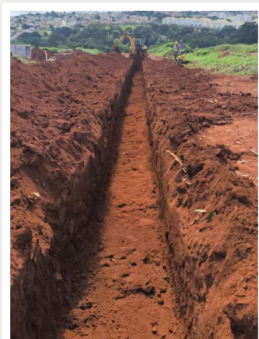
Execução de rede elétrica, iluminação pública e telecomunicação subterrâneo – Fevereiro 2026
