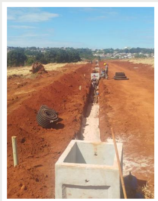
Execução de rede elétrica subterrânea – Assentamento de caixas de passagem – Março 2026
