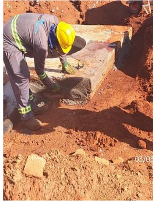
Execução de PVs da galeria pluvial / Instalação das tampas dos PV's da galeria pluvial – Fevereiro 2026
