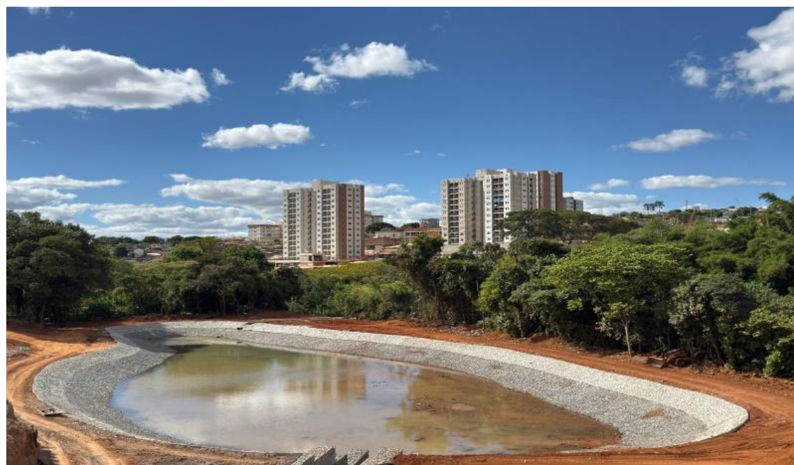
Execução pedra argamassada do Lago – Abril 2026
