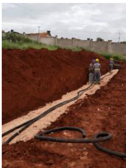
Execução de rede elétrica, iluminação pública e telecomunicação subterrâneo – Fevereiro 2026
