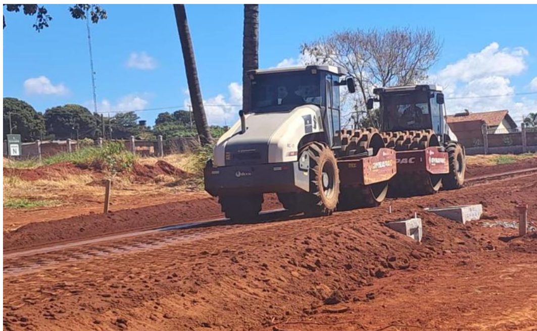
Compactação do subleito – Março 2026
