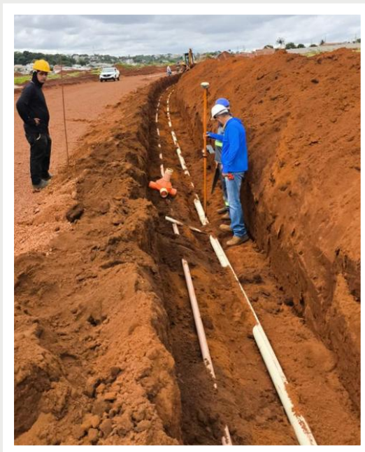
Execução de rede interna de água e esgoto – Março 2026
