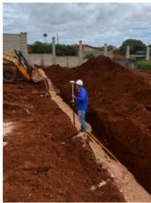
Execução de rede elétrica, iluminação pública e telecomunicação subterrâneo – Fevereiro 2026
