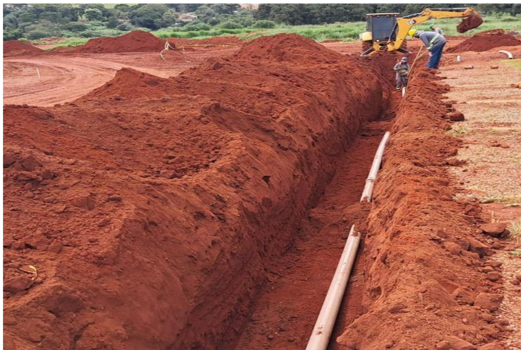
Execução de rede interna de água e esgoto – Fevereiro 2026
