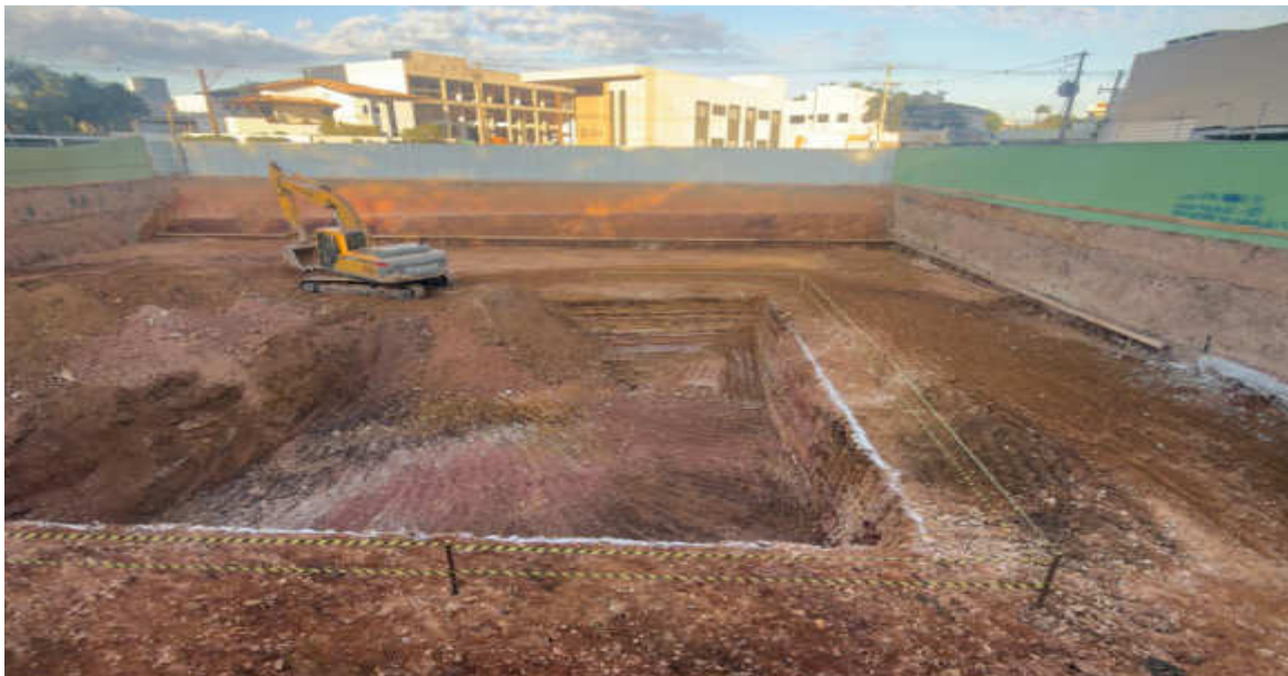
Escavação das sapatas na projeção da torre – Julho 2026
