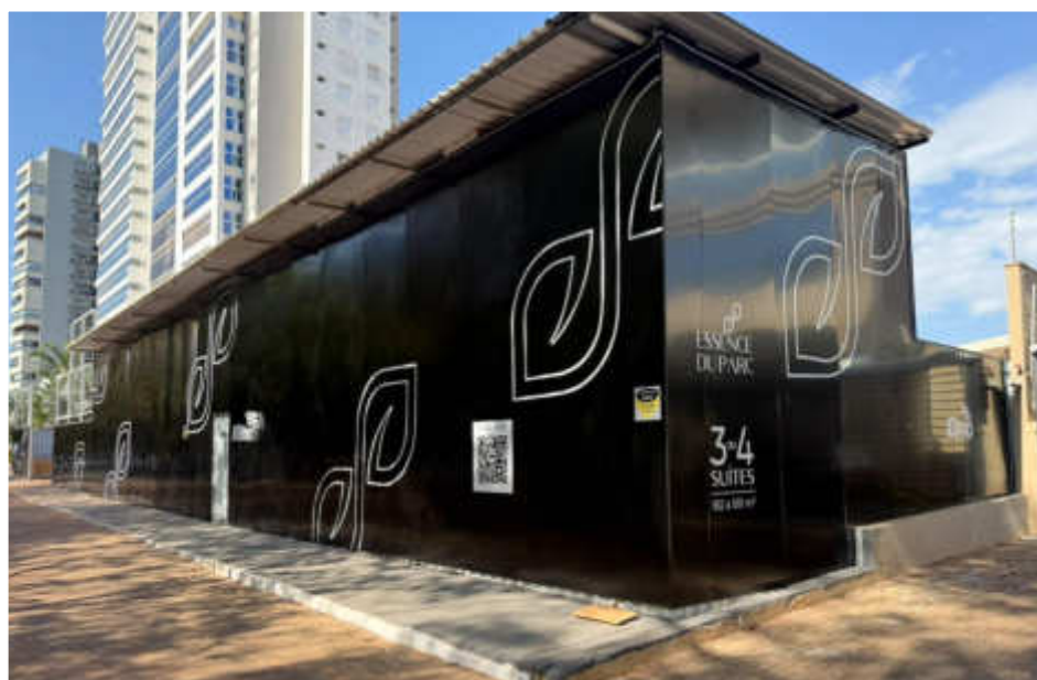
Tapume da obra – Agosto 2026
