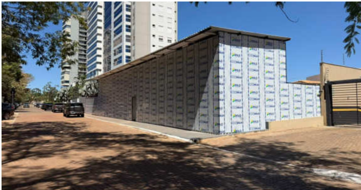
Tapume do térreo e canteiro de obra – Junho 2026
