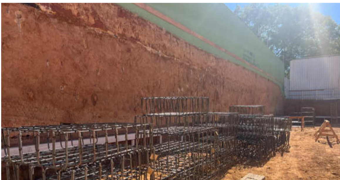
Montagem da armação das sapatas – Julho 2026
