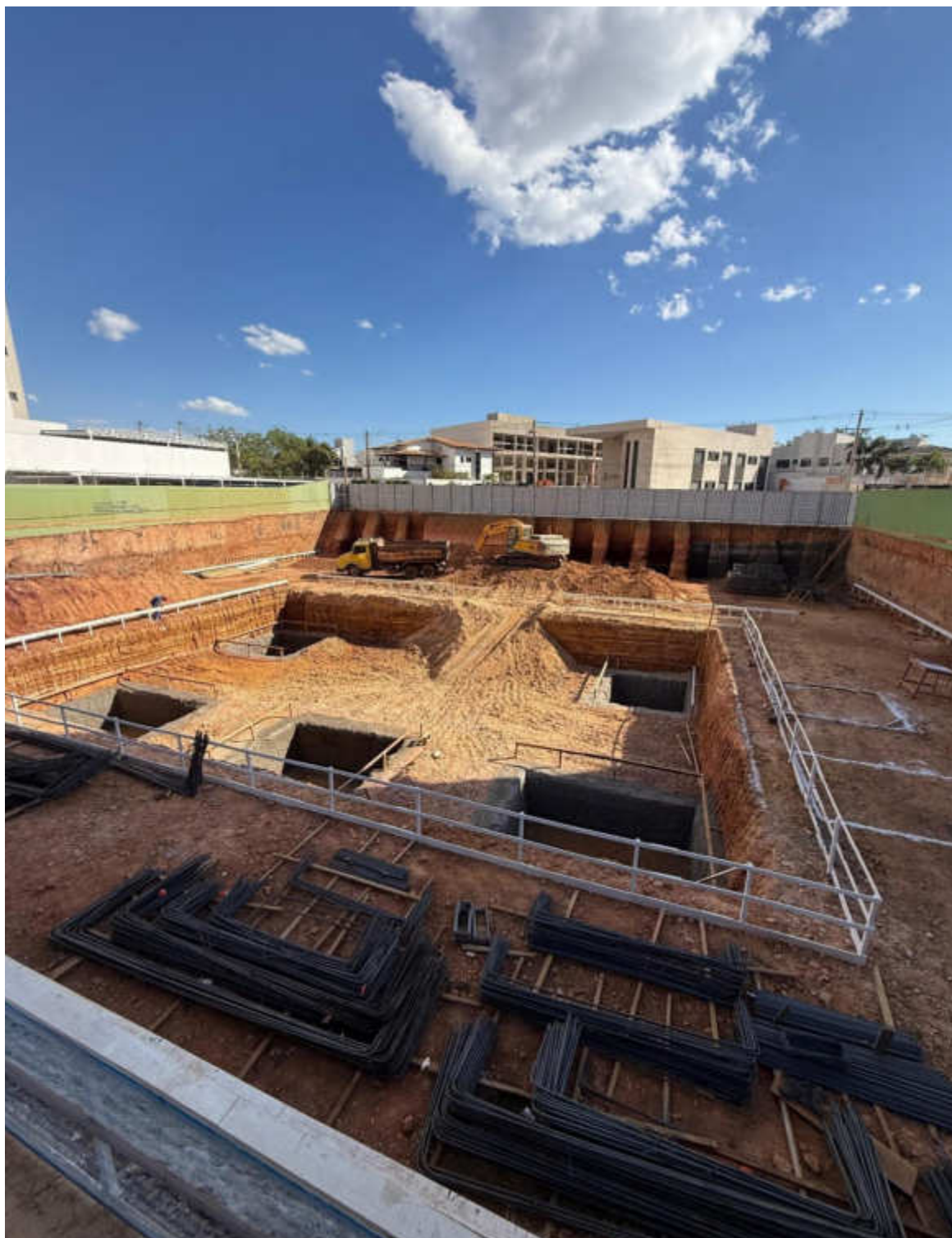
Escavação das sapatas da projeção da torre – Julho 2026
