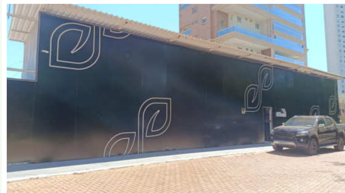
Tapume da obra – Agosto 2026
