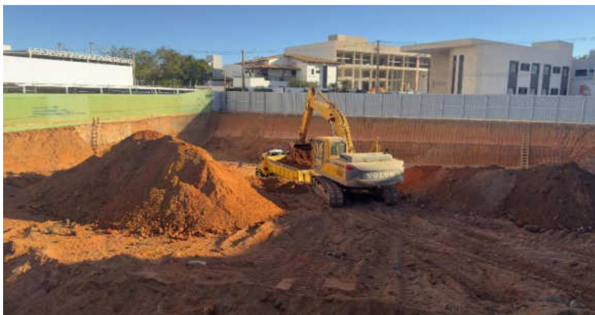
Escavação mecanizada do terreno – Junho 2026
