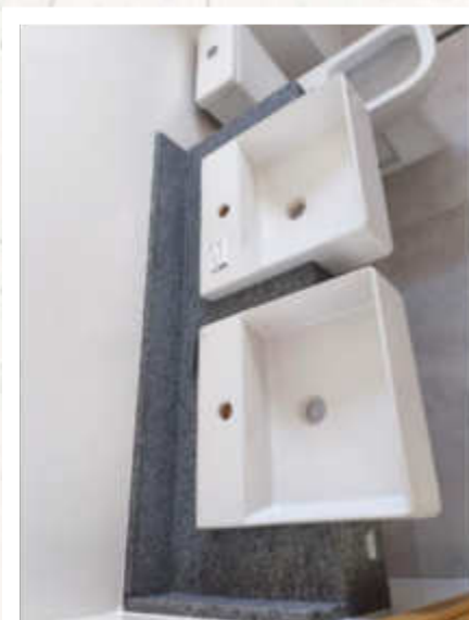
Instalação de louças e bancadas 35º pavimento – Maio 2026
