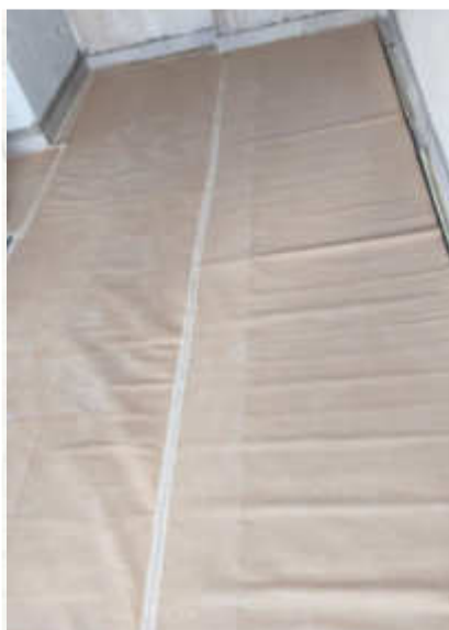
Limpeza grossa e proteção de piso do 33º pavimento – Maio 2026
