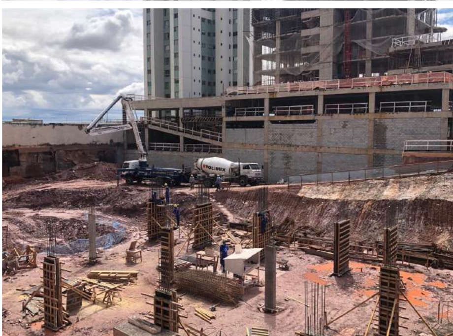
Concretagem dos pilares do 2º subsolo – Março 2024
