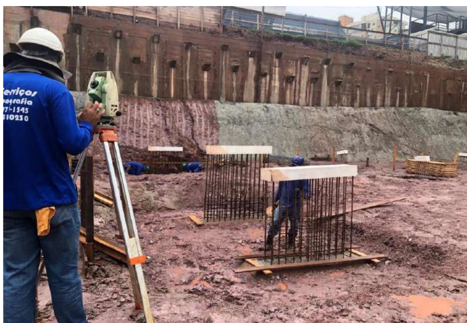
Locação dos pilares do 2º subsolo – Fevereiro 2024
