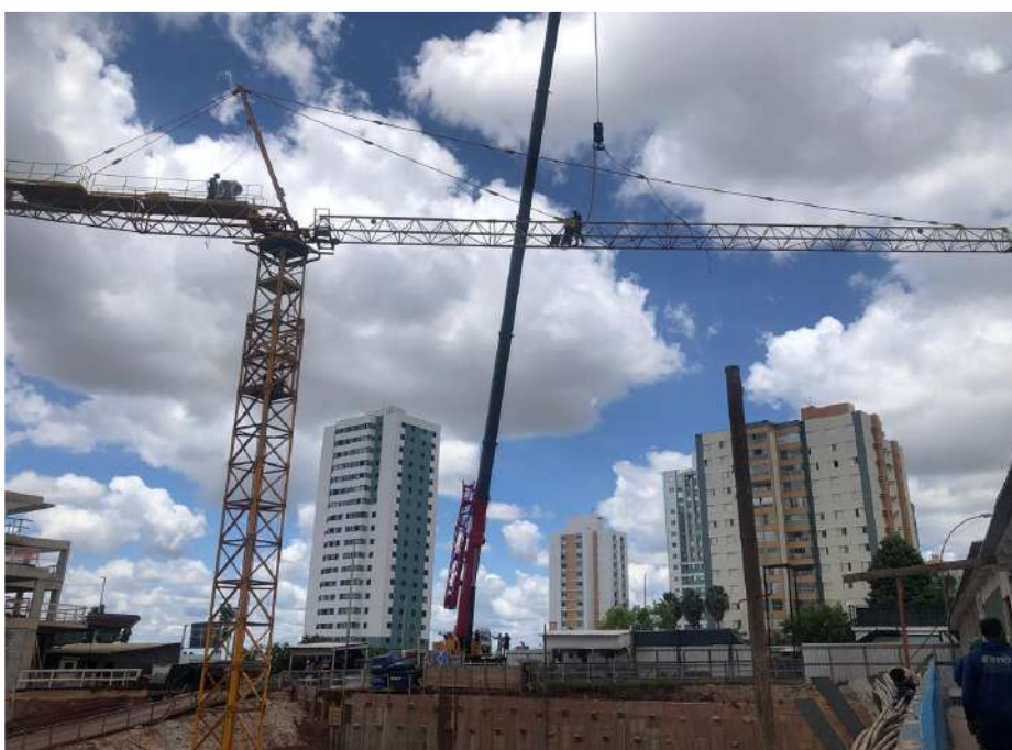
Montagem da grua – Março 2024
