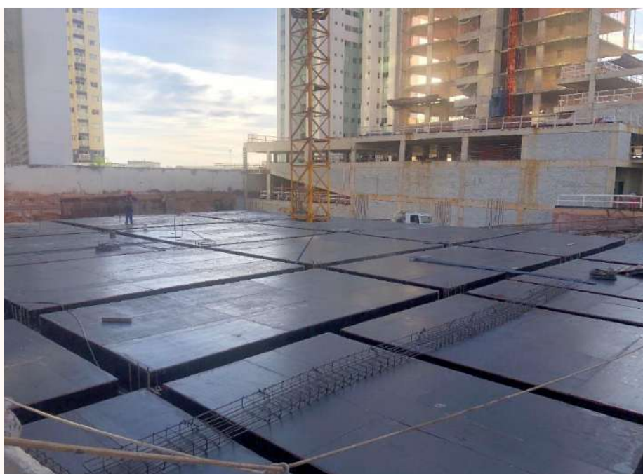
Montagem da forma da 1ª etapa da laje do térreo – Abril 2024
