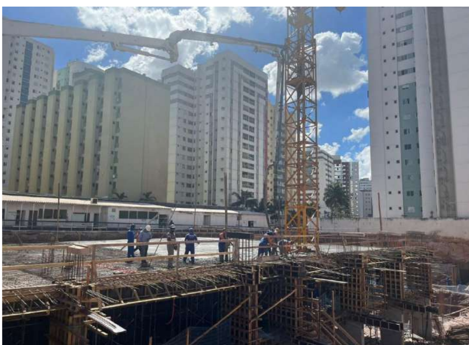
Concretagem da 1ª etapa da laje do térreo – Abril 2024
