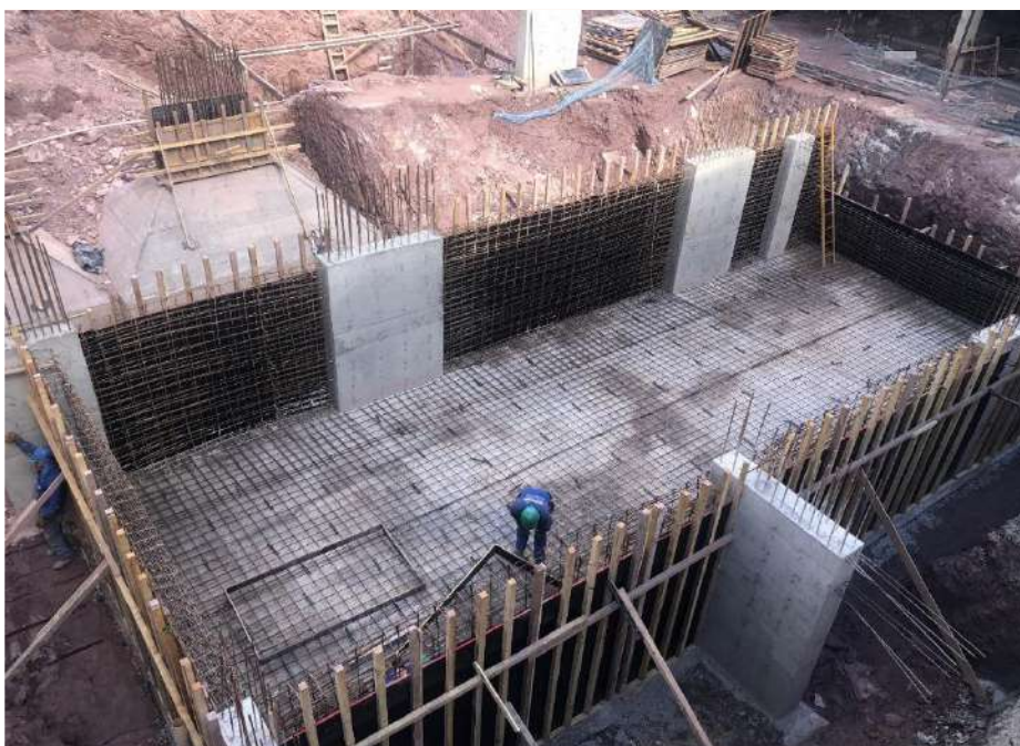
Estrutura do abrigo para reservatórios de água potável – Abril 2024
