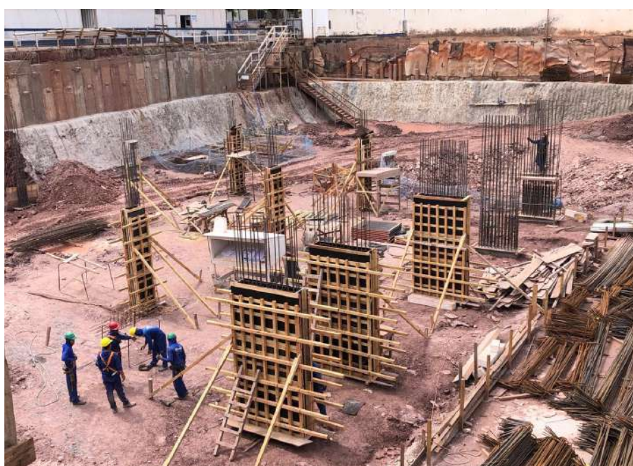
Montagem das formas dos pilares do 2º subsolo – Fevereiro 2024
