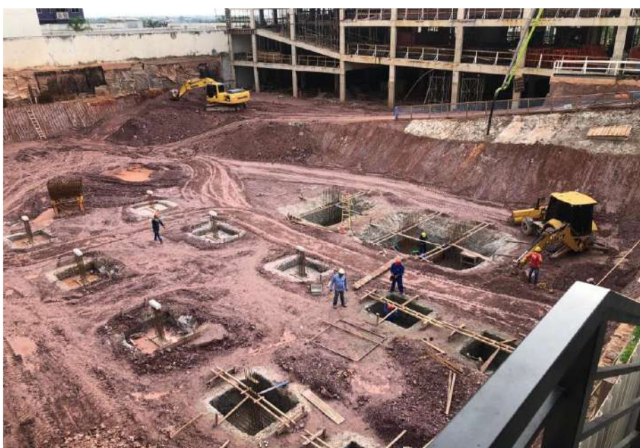
Escavação do terreno e abertura das sapatas – Fevereiro 2024
