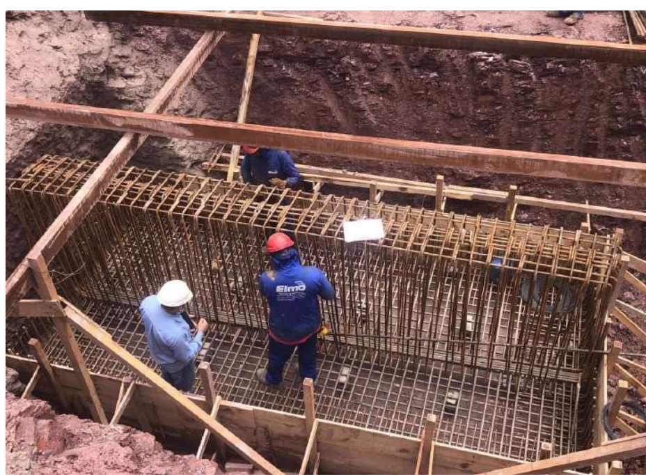
Execução de sapatas de fundação – Março 2024
