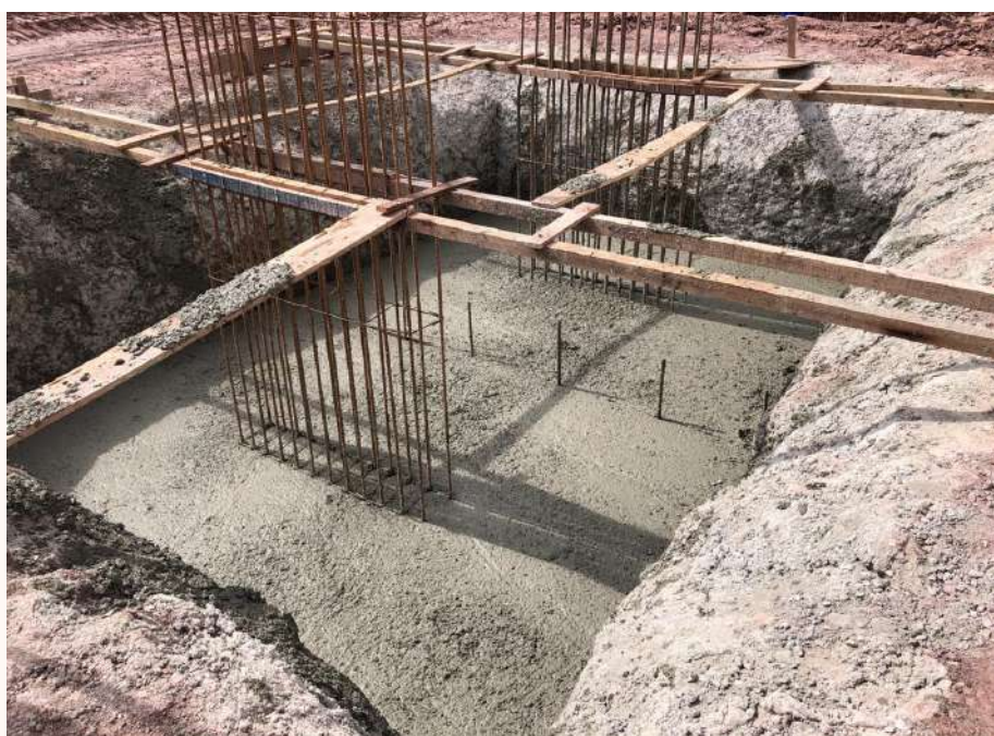
Execução de sapatas de fundação – Fevereiro 2024
