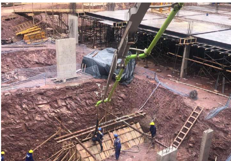
Concretagem das sapatas de fundação – Março 2024
