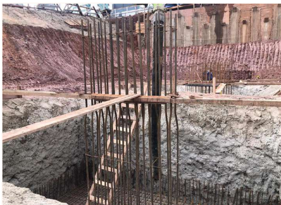
Execução de sapatas de fundação – Fevereiro 2024
