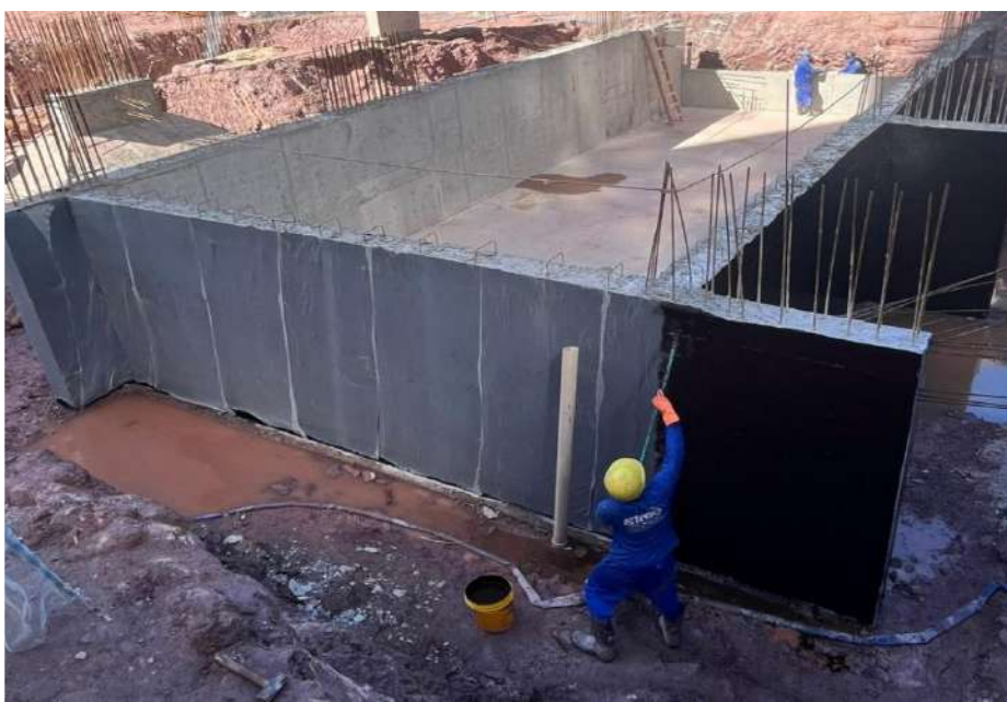
Impermeabilização do abrigo para reservatórios de água potável – Abril 2024
