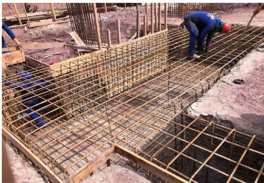
Execução de base para grua – Fevereiro 2024
