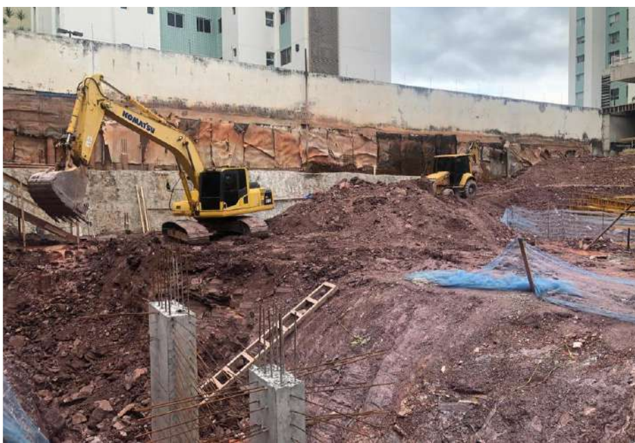
Escavação do terreno – Março 2024
