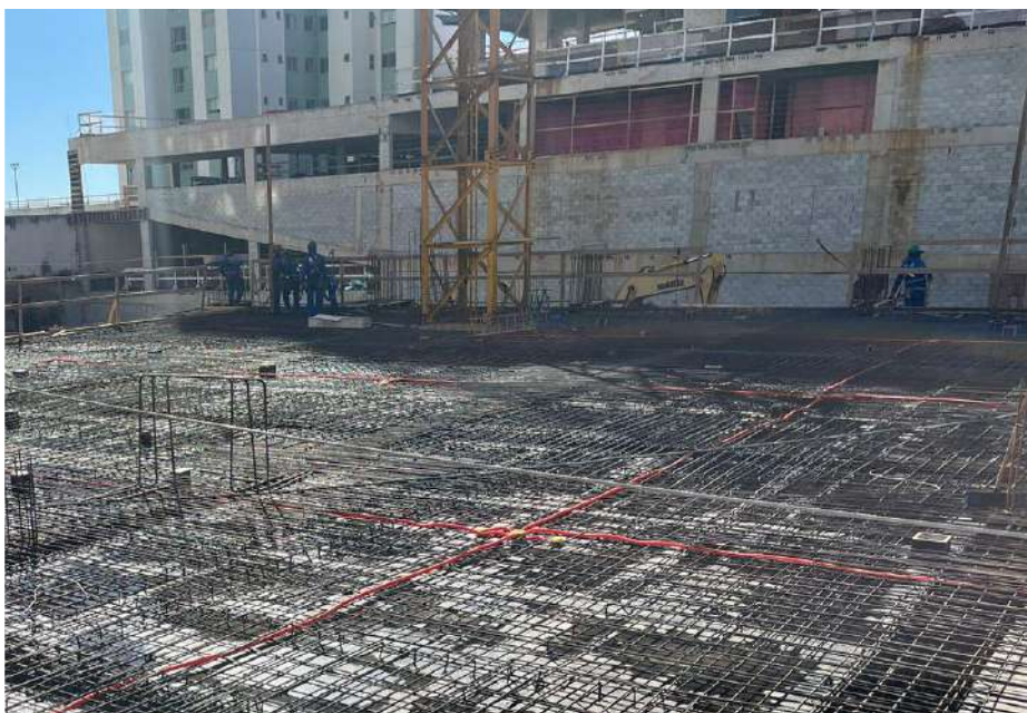
Armação da 1ª etapa da laje do térreo – Abril 2024
